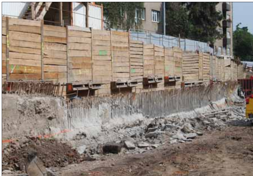
Stavební jáma v Patočkově ulici pažená záporovým pažením; koruna podzemních stěn byla vzhledem k podélnému spádu tunelů nadbetonována asi o 50 cm a následně upravena „odšramotáním“.
