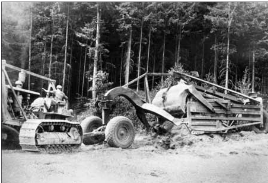
Ze zásob anglo-amerických spojeneckých armád pocházely některé stavební stroje používané na našich stavbách těsně po válce. Buldozer Caterpillar D8 a scraper D 80 též firmy používala v létě 1947 firma Kruliš na stavbě železnice u Tišnova. (Foto Ing. P. Havránek)
