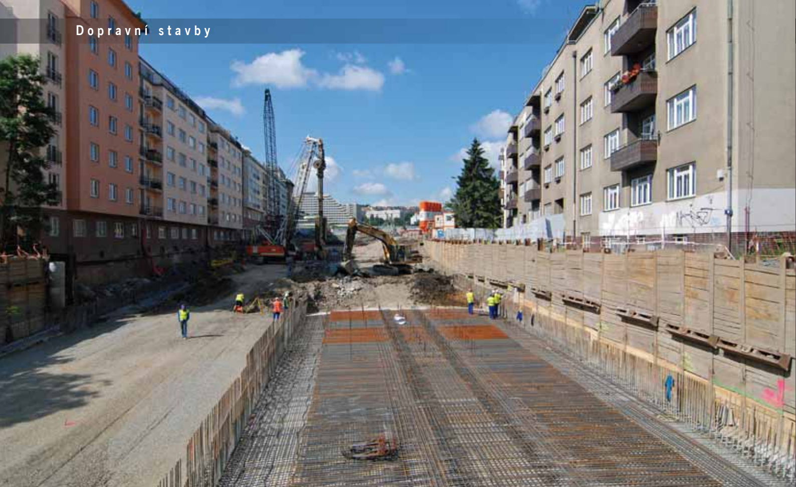
Příprava pro betonáž stropní desky uložené na podzemních stěnách, Patočkova ulice, pohled směrem k MÚK Malovanka
