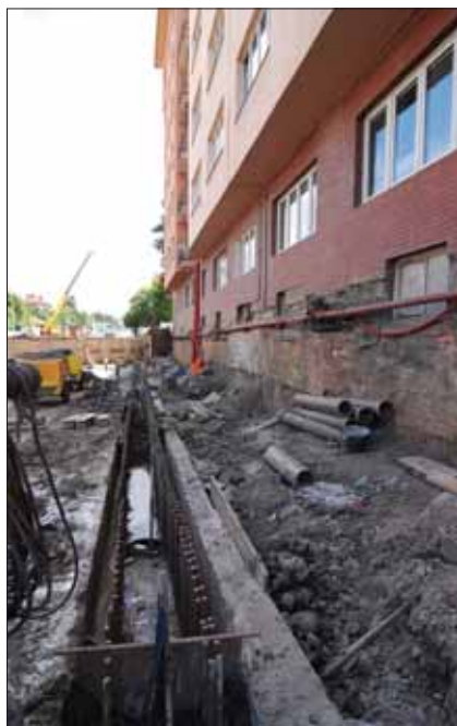
Budování podzemních stěn probíhalo v těsné blízkosti domů v Patočkově ulici.
