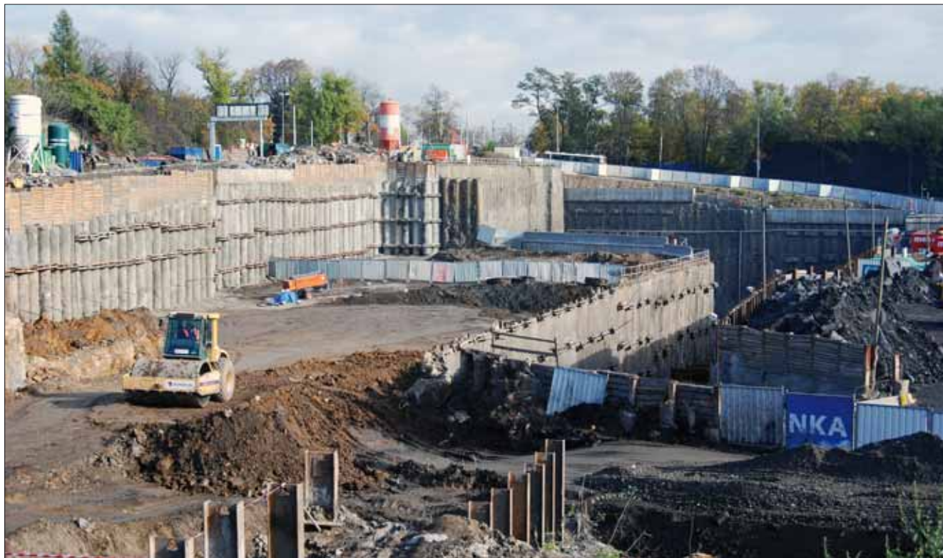
Pohled na 3. fázi výstavby stavební jámy SAT 2. B, která zde navazuje na stavební jámu Myslbekova; vpravo je sjezdová rampa do této stavební jámy, z níž se pro účely pažení této 3. fáze ponechá jižní (zde pravá) část pažení.
