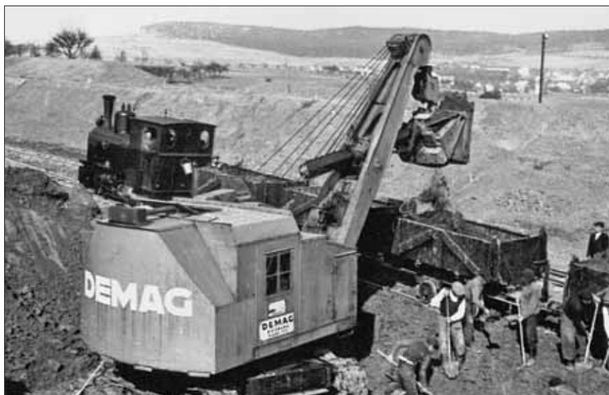
Německé motorové rypadlo Demag ve službách vídeňsko-pražské firmy Pittel & Brausewetter na stavbě tzv. německé dálnice Vídeň–Vratislav u Skalice nad Svitavou na počátku 40. let; za ním parní lokomotiva Orenstein & Koppel
