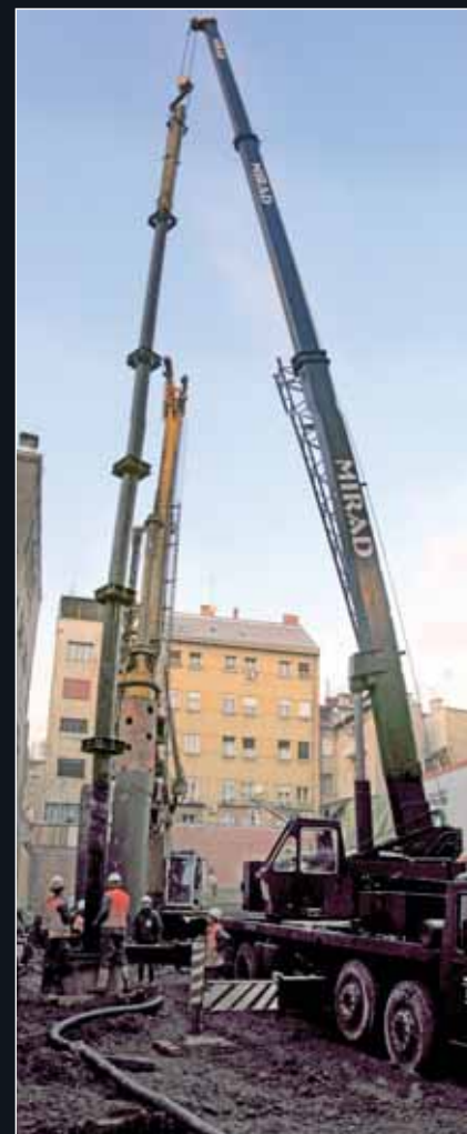
Vkládání sloupu do vrtu pomocí jeřábu
