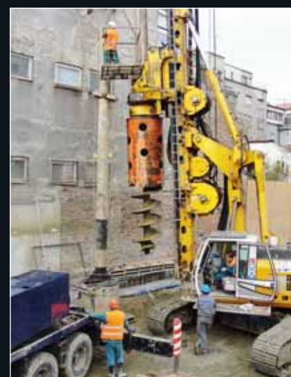
Konečná fáze vkládání sloupu do vrtu
