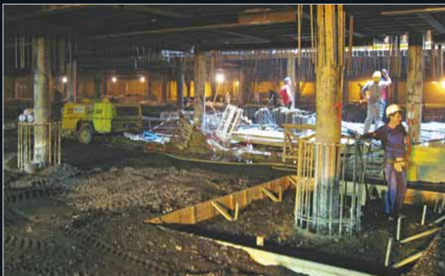
Sloupy pilot v úrovni základové desky
