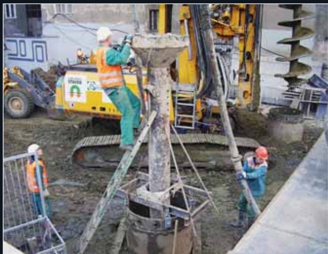
Betonáž piloty středem sloupu
