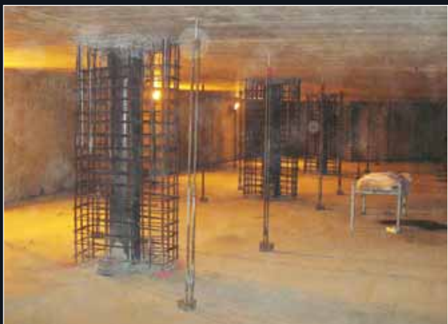
Podzemní podlaží s ocelovými sloupy a zavěšenými stropy
