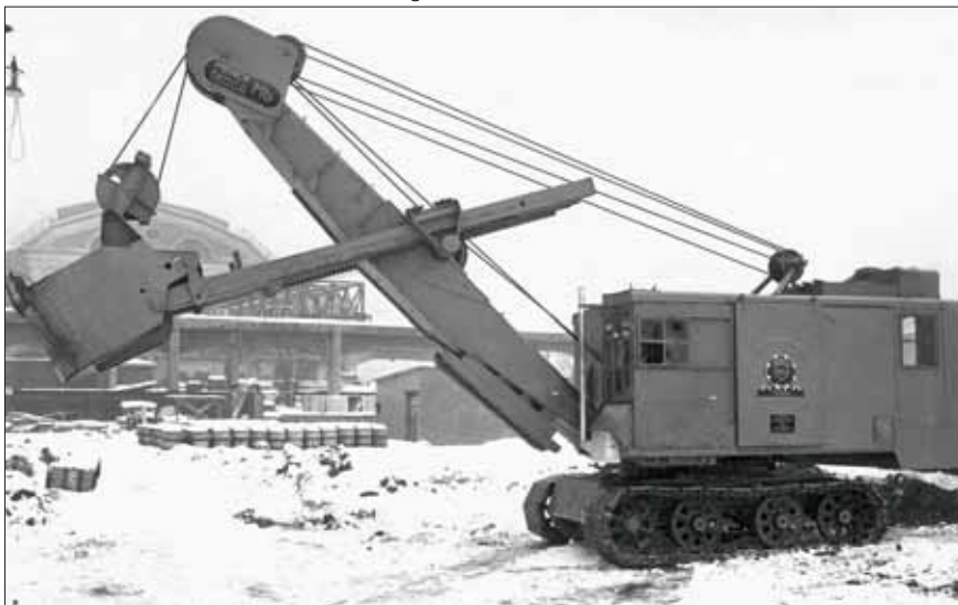
Tovární fotografie licenčního provedení rypadla Škoda-Menck typu Mb ze 40. let, jehož lopata měla obsah 1 m 3
