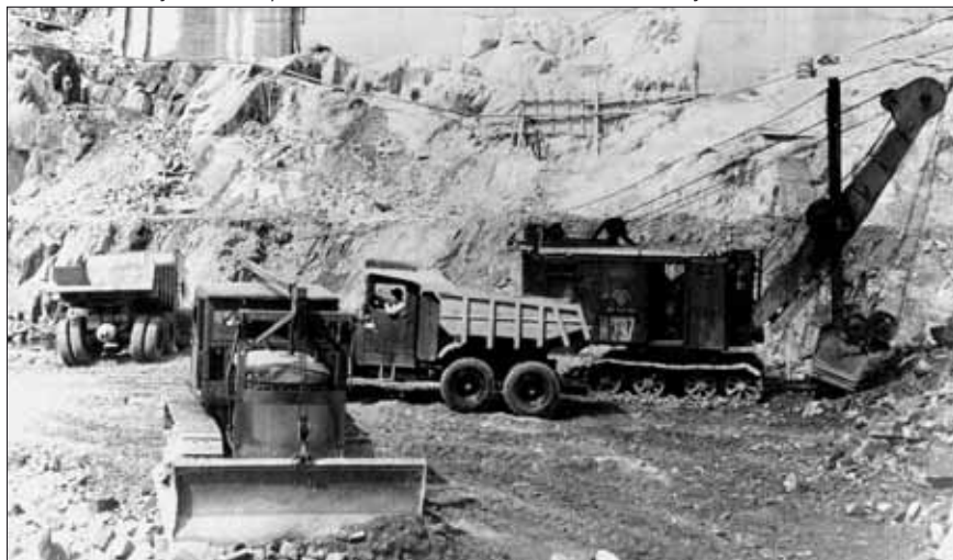
Na stavbě přehrady Orlík už vévodila nákladní auta Tatra, vedle nichž na obrázku vidíme ještě originální rypadlo Mb2 od výrobce Menck & Hambrock a v popředí sovětský traktor Stalincec s přimontovanou radlicí.
