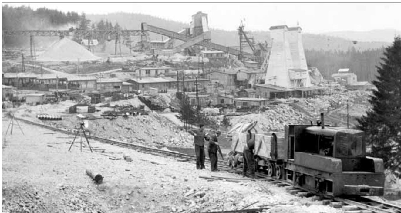
Fotografii ze staveniště lipenské přehrady přikrášlila v květnu 1955 motorová lokomotiva typu BNE 50 z radotínské Ferrovie, nesoucí kromě provozního čísla 7 také štětcem namalované jméno Jitůška.
