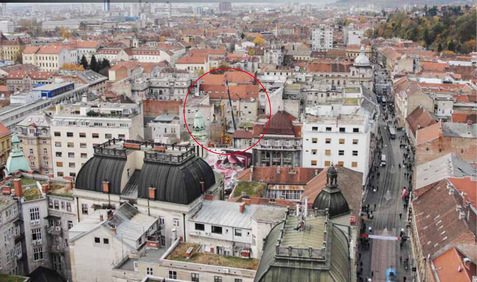
Celkový pohled na staveniště objektu „Cvjetni“
