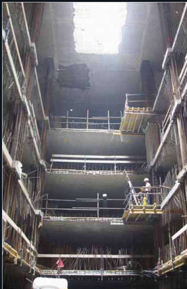
Průhled do podzemních podlaží z úrovně základové desky
