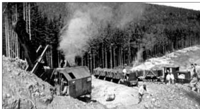
Dálnici Praha–Brno v úseku Šternov–Psáře stavěla na počátku 40. let firma Jelínek a synové. Kouřící rypadlo Menck & Hambrock má ve skutečnosti spalovací motor, sekundují mu dvě naftové lokomotivy Montania MD2 a MD3.
