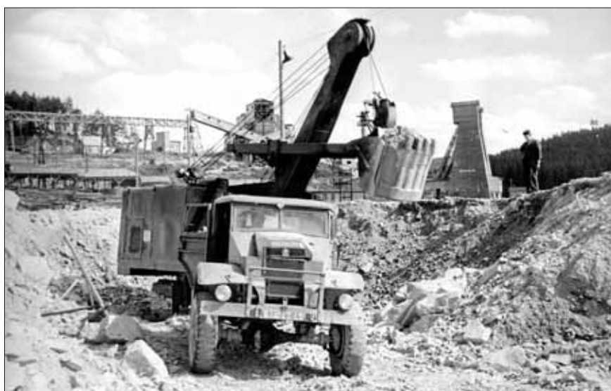
V roce 1954 na Lipně nakládalo rypadlo Orenstein & Koppel do bývalého vojenského automobilu CMP (Canadian Military Pattern) z produkce Ford nebo Chevrolet o nosnosti 3 tuny.
