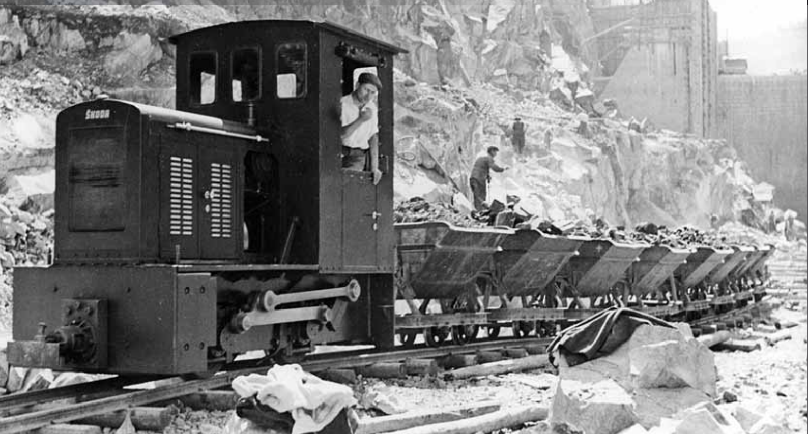
Při stavbě plavebních komor štěchovické přehrady firmou Domanský – Kress se uplatnily nově dodané motorové lokomotivy Škoda NL-9 o výkonu 40 k.
