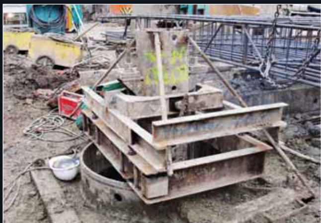
Uložení sloupu na konstrukci závěsu
