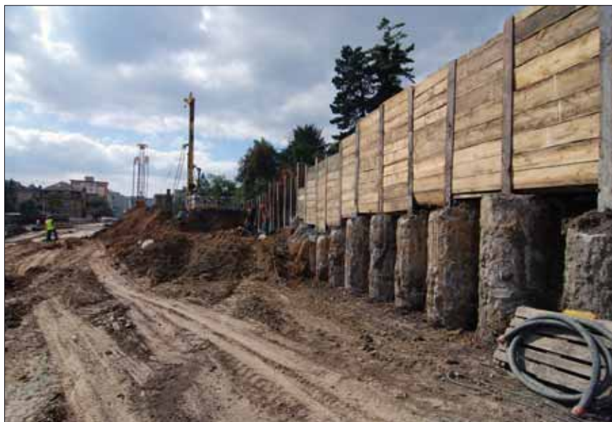
3. fáze výstavby SAT 2. B; ocelové zápor y jsou osazeny do zhlaví pilot
