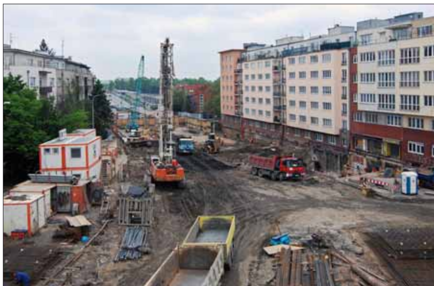
Pohled na staveniště v Patočkově ulici od MÚK Malovanka (od západu)
