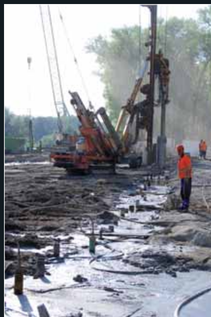
Provádění obvodové těsnicí clony
