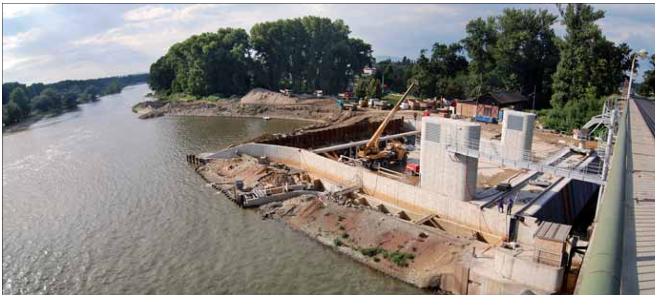
Elektrárna po dokončení stropních konstrukcí
