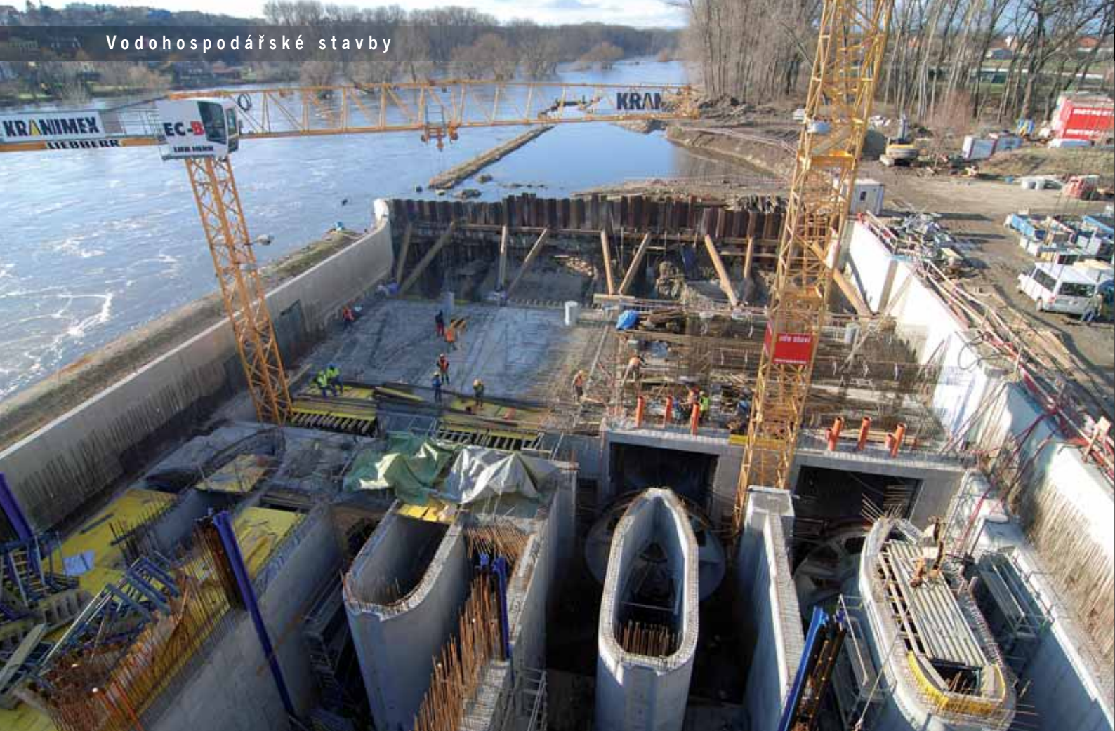
Výstavba elektrárny ve stavební jámě před osazením technologie
