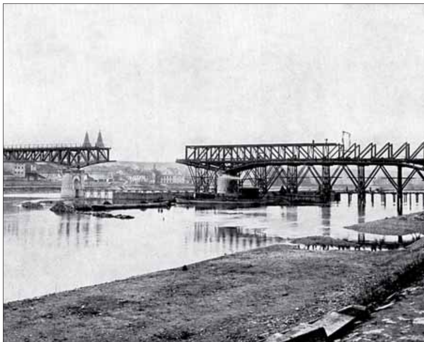
Montáž krakorcového mostního nosníku nad pravobřežním jezovým polem, v prostředním poli probíhá demontáž štětové jámky, v prostředním jezovém poli jsou zdviženy slupice.
