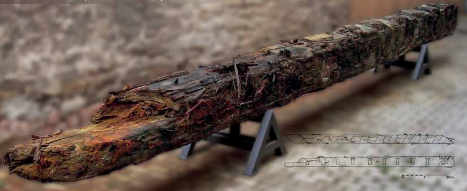
Jeden z trámů základového roštu gotického mostu objevených v roce 2004, Podřípské muzeum v Roudnici nad Labem (Foto M. Panáček 2006)
