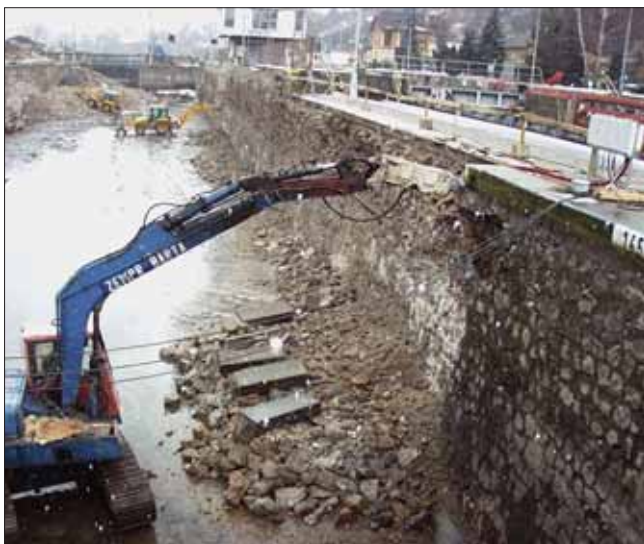
Bourací práce na stěnách komory
