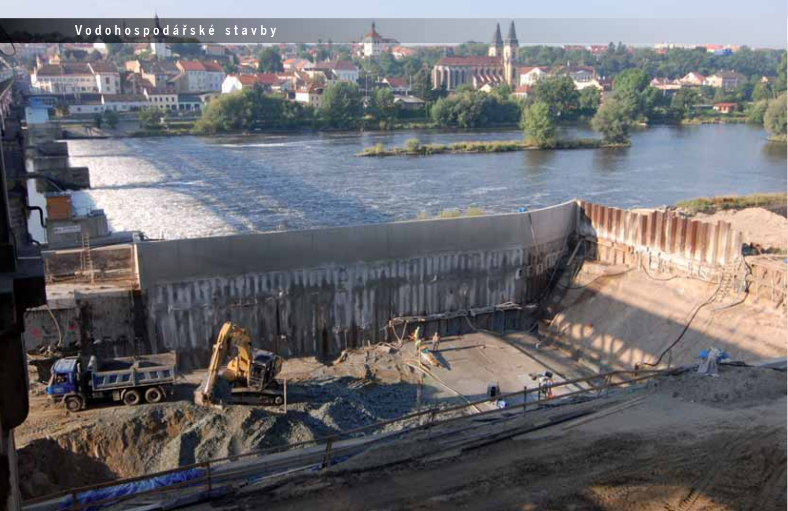
Stavební jáma během dokončování těžby na základovou spáru
