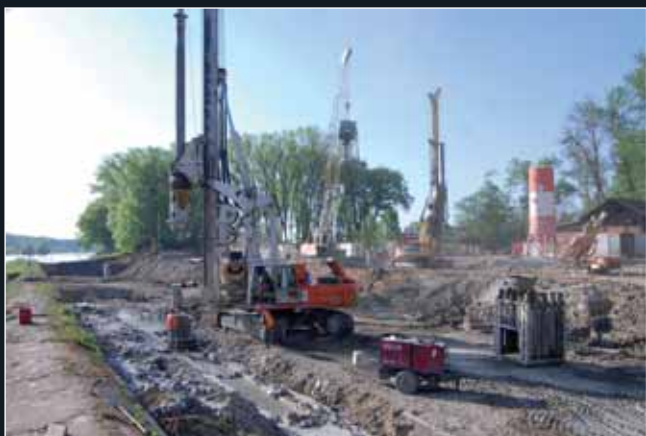
Práce na zhotovení obvodových převrtávaných pilotových stěn a štětové stěny na výtoku
