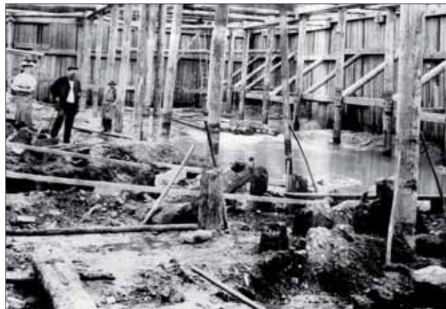
Jímka II. etapy vytěžená na základovou spáru se zbytky starého roudnického mostu
