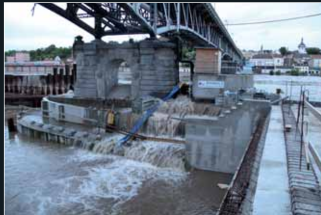
Řízené zaplavlávání stavební jámy při povodni přes jezový pilíř
