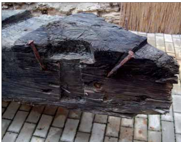
Jeden z trámů základového roštu gotického mostu objevených v roce 2004, pohled z vnější strany na sešikmené zhlaví, které bylo původně lípnuto k osovému trámu. Je vidět jeden oboustranně rybinovitý zapuštěný dlab na boční straně, jednoduchý dlab na horní straně a ohnuté hřeby, kterými byl trám přibit k osovému, Podřipské muzeum v Roudnici nad Labem (Foto M. Panáček 2006).
