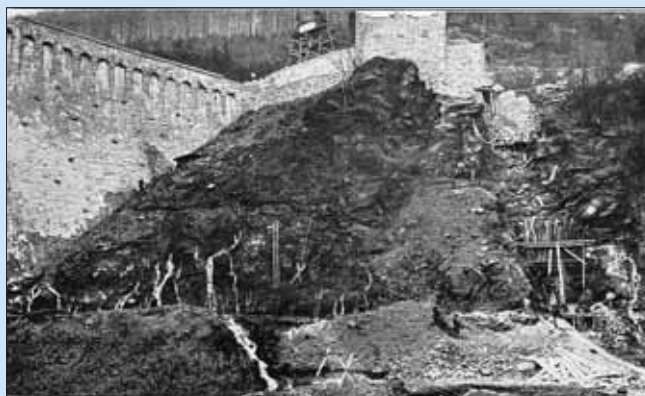
Průsaky v levoběžném zavázání se objevily brzy po prvním napuštění nádrže v roce 1914
