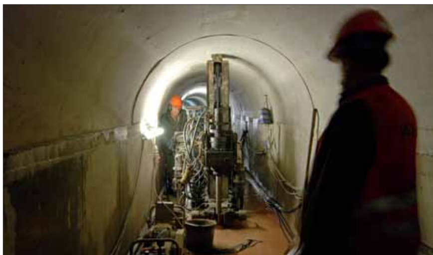
Hloubení injekčního vrtu v rovné části injekční štolý, vrtná souprava MSV 741/20
