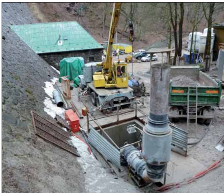
Pohled na vstupní šachtu a zařízení staveniště
