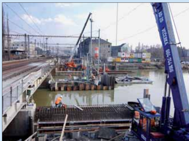
Současné provádění prací na všech říčních pilířích, v popředí pilíř P3
