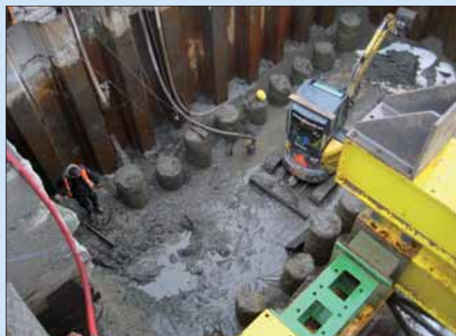
Hlavy pilot pilíře P4 před zarovnáním
