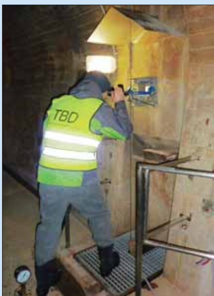
Měření náklonů hráze pomocí hrázového kyvadla
