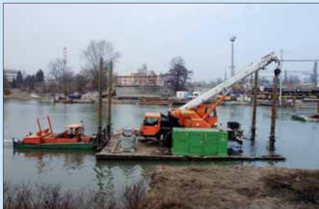
Sestava pontonů s hydraulickými nohama je tlačným člunem přesouvána na místo stavby.
