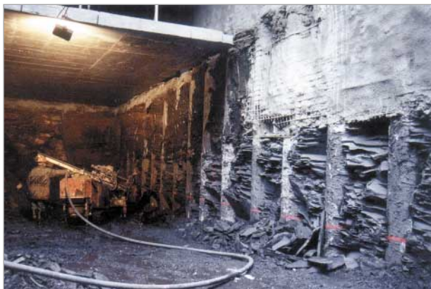
Provádění kotevnicí trnů pro statické zajištění pažicí konstrukce
