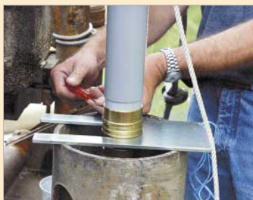
Obr. 4: Spojování měřicí pažnice pomocí teleskopických spojek, vrt MPD 02, 26. 7. 2002
