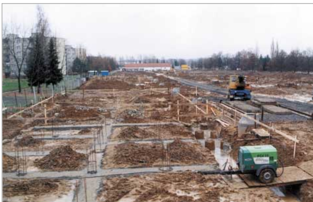
Zhotovené piloty pod budoucí základové pasy (Mariánské lázně)
