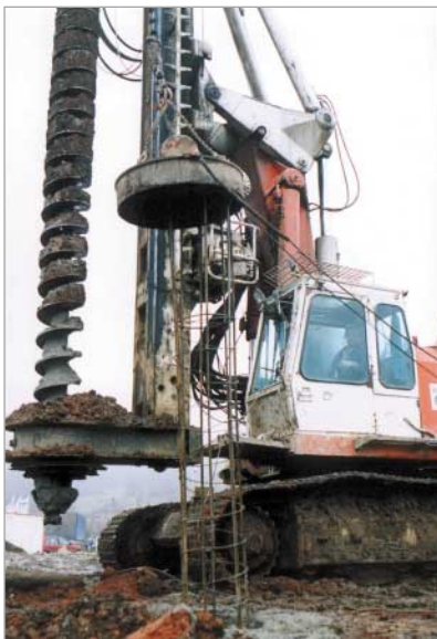
Osazování armokoše pomocí vibrační hlavy, souprava Delmag 1413
