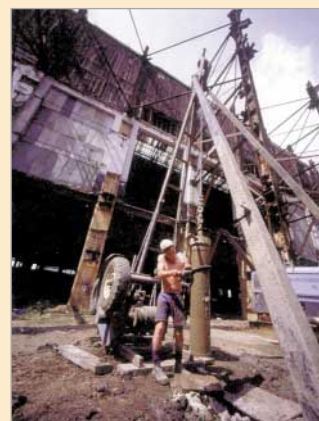
Elektrárna Battersea stojí na nezpevněných vrstvách naplavenin; průzkum staveniště odhalil rozsáhlé skryté základy.
