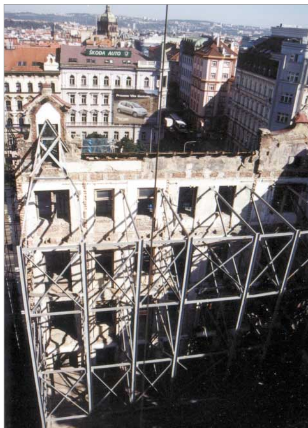
Ocelové ztužení ponechané památkově chráněné fasády původního objektu
