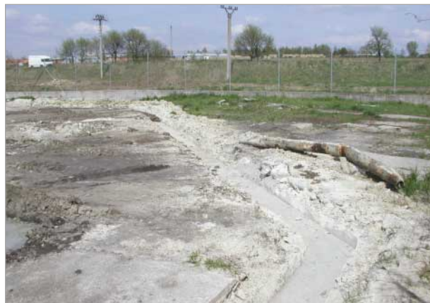
Těsnicí podzemní stěna
