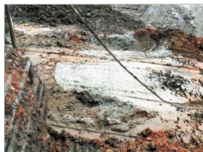
Hlava piloty po očištění čelníku nakladačem...
