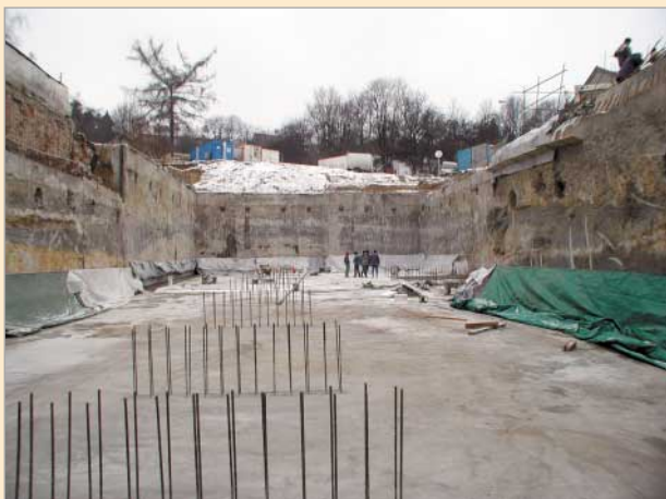
Zimní opatření byla prováděna i po dobetonování smršťovacích pásů v základové desce
