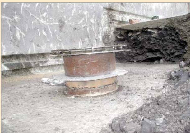
Studna pro čerpání podzemní vody v průběhu výstavby základové desky
