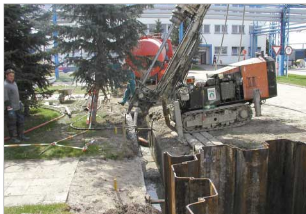
Provádění těsnicí podzemní stěny pomocí tryskové injektáže
