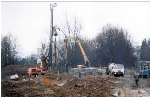
Technologie CFA v plné sestavě: vrtná souprava, čerpadlo, autodomčhávač (Mariánské lázně)
