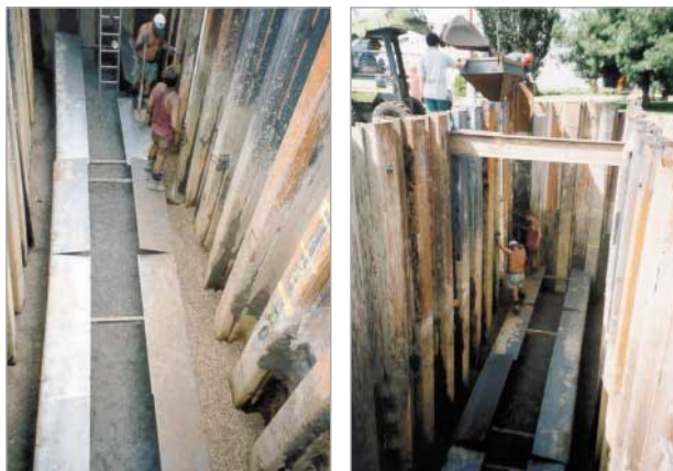
Provádění vertikální dělené výplně reaktivní brány
