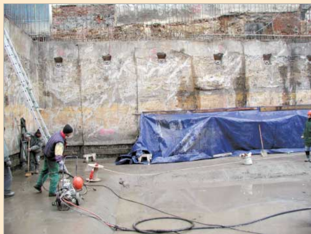
Ošetření drážky pro zavázání základové desky do podzemní stěny probíhalo v zimním období
