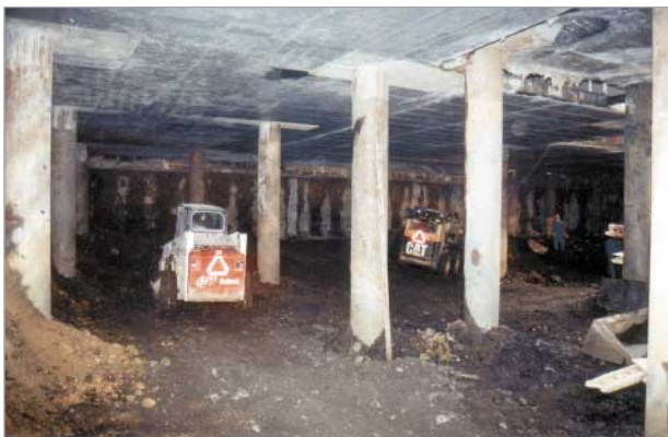
Zemní práce pod stropní deskou
