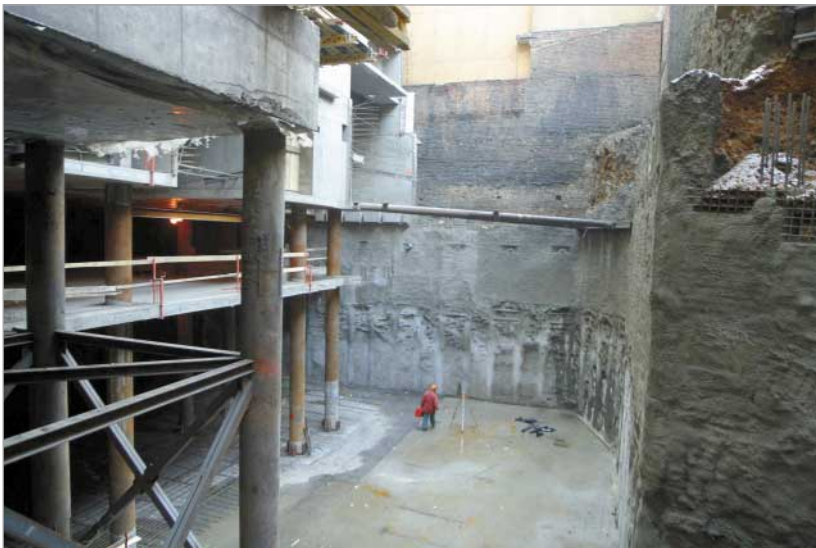
Pohled do stavební jámy - vpravo kotvené pilotové stěny, vlevo část objektu vybudovaného metodou "top and down"
