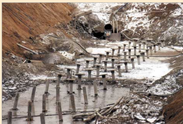
Detailní pohled na mikropiloty s částečně osazenými roznášecími hlavami tah-tlak
