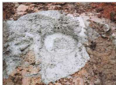
... a po ručním dočištění před osazením výztuže
