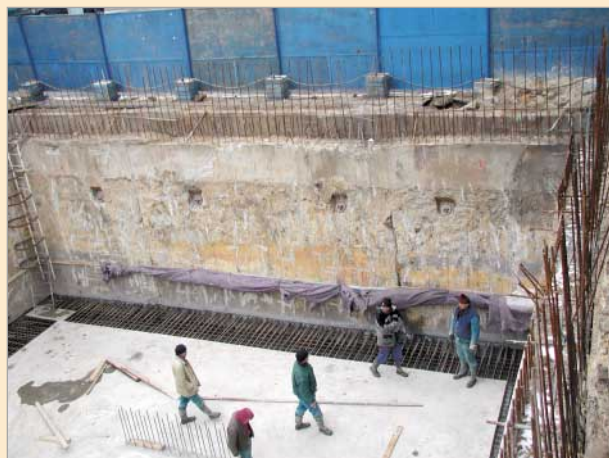
Příprava na betonáž smršťovacích pásů
