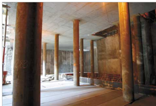
Obnažené ocelové sloupy v 2. PP osazované v předstihu před realizací stropní desky do pilotážních vrtů
