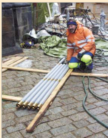
Obr. 3: Smontované měřicí pažnice před spuštěním do vrtu MPD 01, katedrála sv. Víta, 29. 11. 2001
