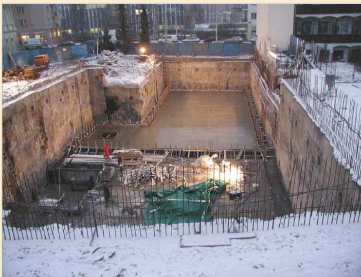
Konstrukční podzemní stěny kotvené v jedné úrovni. Betonáž prvního bloku základové desky probíhala za příznivějších teplot.
