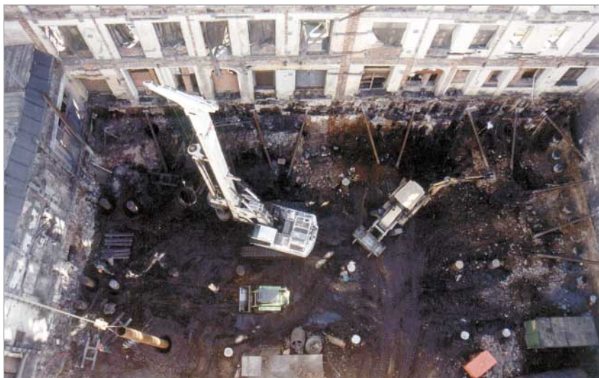
Práce z úrovně 1. PP nově budovaného objektu, hloubení pilot a osazování sloupů
