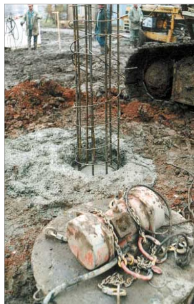
Částečně osazený armokoš délky 10 m, v popředí vibrační hlava
