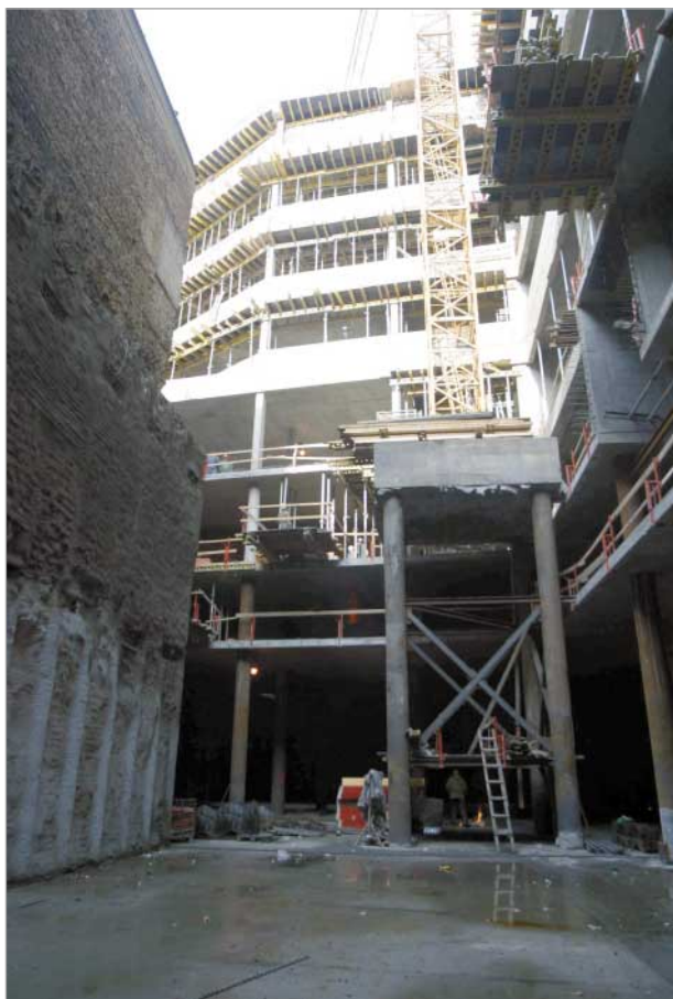
Pohled ze dna stavební jámy v části, kde výstavba probíhala klasicky od základové desky vzhůru. Dobře patrné je impozantní založení jeřábu na čtyřech sloupech.
