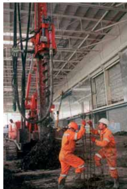
Společnost Bachy Soletanche provedla více než 3000 CFA pilotů v prostoru a kolem podlahy továrny
