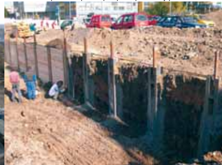
Svrchní část záporového pažení při úpravě průchodky pro kotvu
