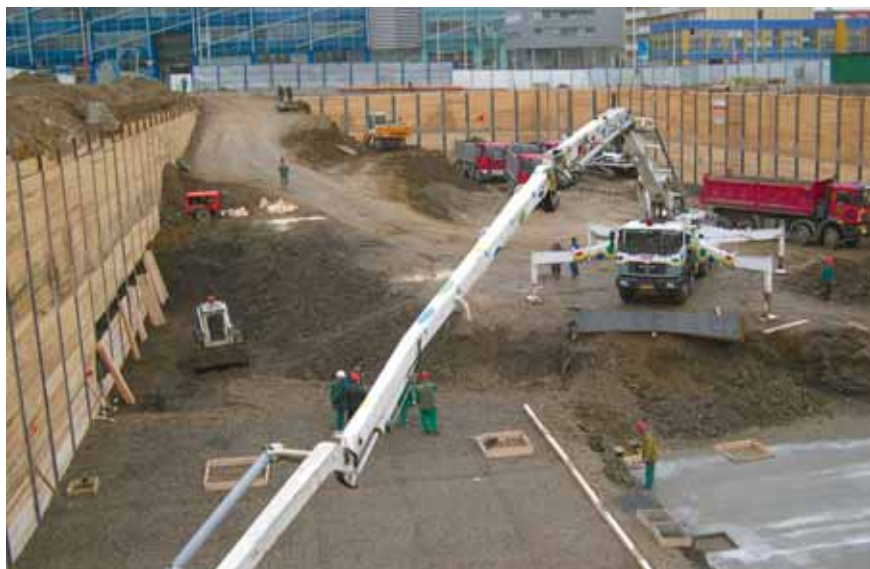
Betonáž podkladních betonů na připravenou plochu se šablonami pro základové piloty
