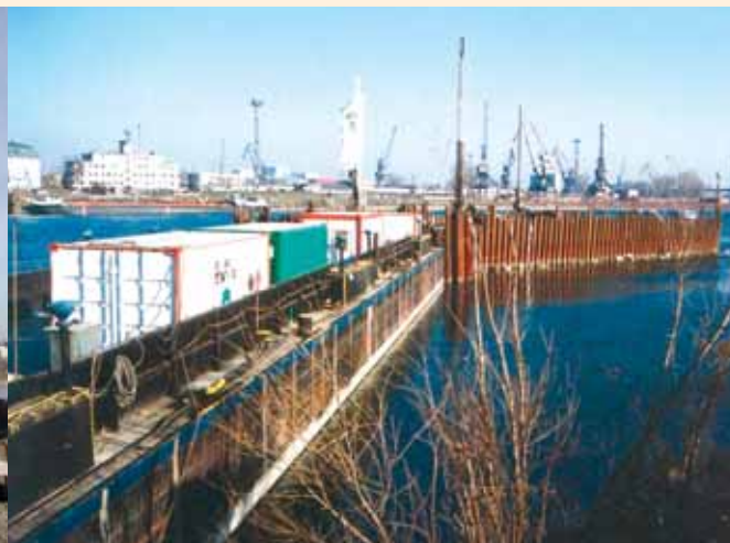
Spojení mezi břehem a umělým ostrovem tvořila paluba ukotveného tlačného člunu
