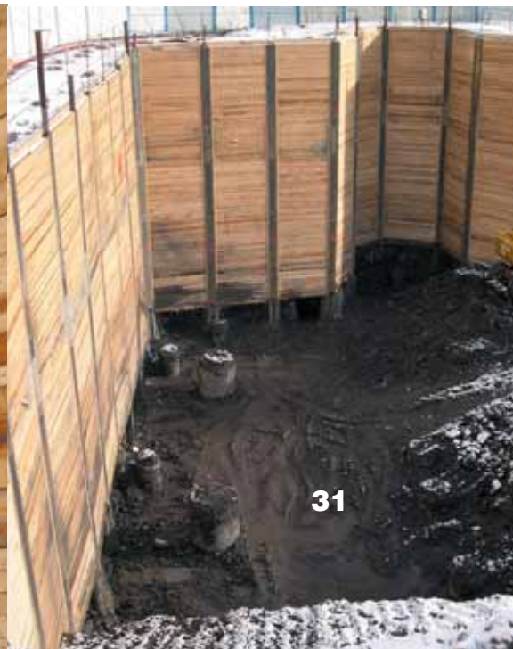
Záporové pažení sledovalo i komplikovaný půdorys stavební jámy, na základové spáře jsou zřetelné hlavy základových pilot
