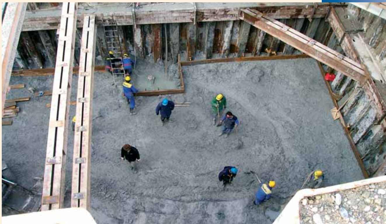
Přípravné práce před položením podkladního betonu na základovou spáru
