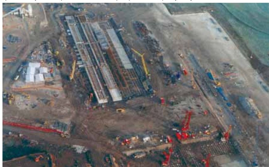
Společnost Bachy Soletanche provedla více než 3000 CFA pilotů v prostoru a kolem podlahy továrny
