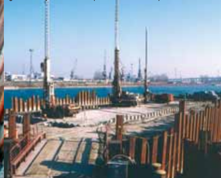
Trysková injektáž pro utěsnění dna vnitřní stavební jímky a zlepšení geotechnických vlastností v podzákladí mostního pilíře
