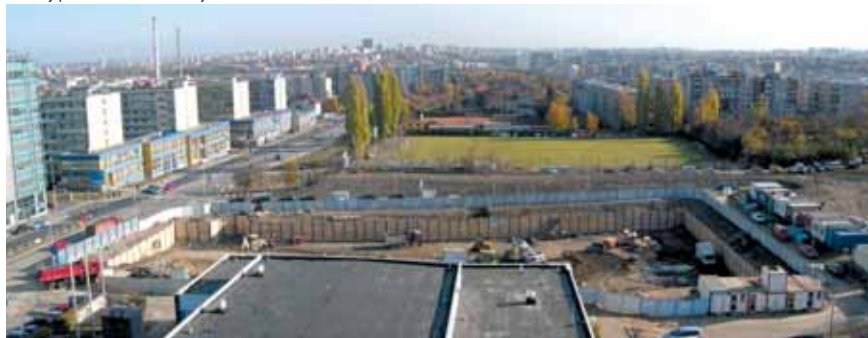
Celkový pohled na staveniště s jeho širším okolím
