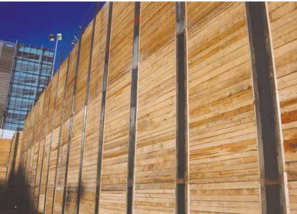
Celkový pohled na záporové pažení se skrytými hlavami kotev
