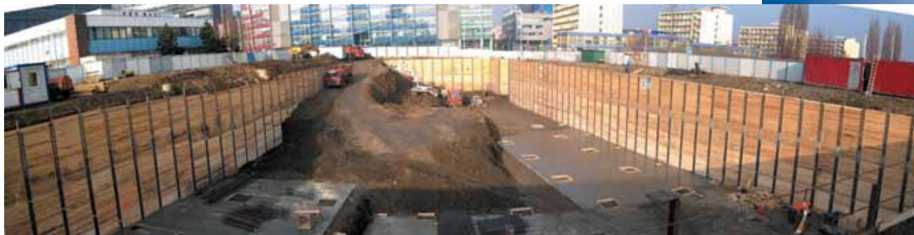
Panoramatický pohled na stavební jámu při provádění prací
