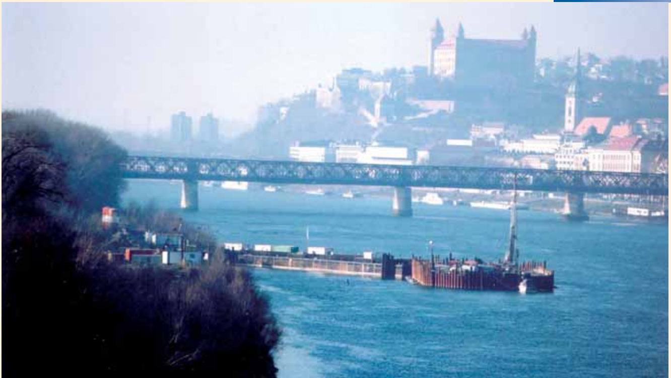
Celkový pohled na zakládání mostního pilíře č. 10 z umělého ostrova v řečišti Dunaje, provádění tryskové injektáže v podzákladí pilíře
