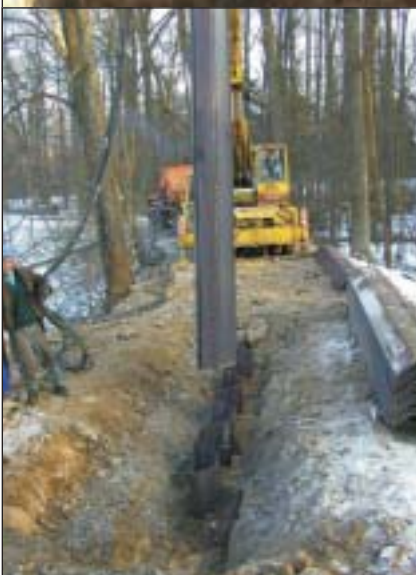
Provádění štětové stěny ze štětovnic VL 602
