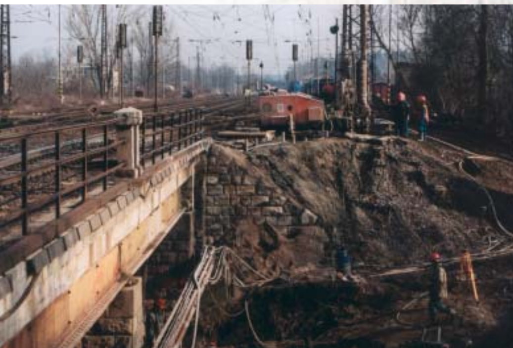
1. Vrtání mikrozápor pro zajištění výkopu jedné z rozšiřovaných závěrných zdí mostní opěry
