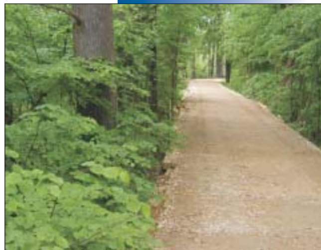
Pohled na opravenou hráz s jezdnuou vrstvou
