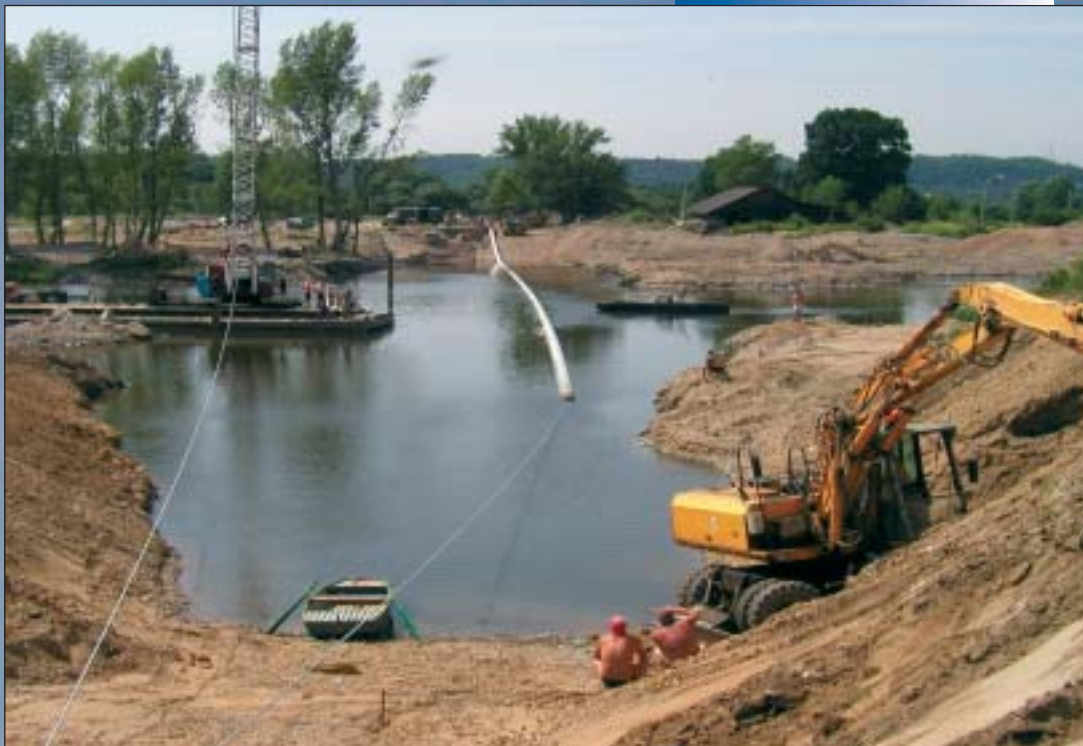
8. Trasa zatahované shybky plynového potrubí
