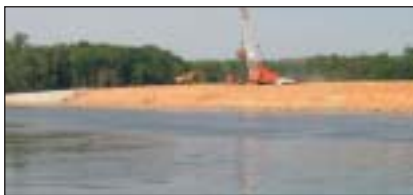
1. Celkový pohled na opravovaný úsek hráže u Veltrus
