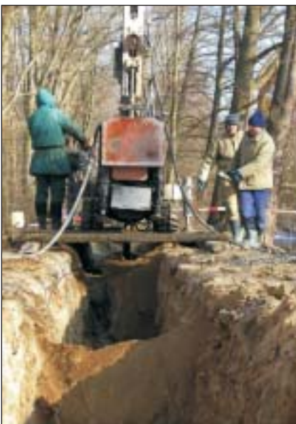
Provádění jílocementové clony do předvýkopu pomocí tryskové injektáže
