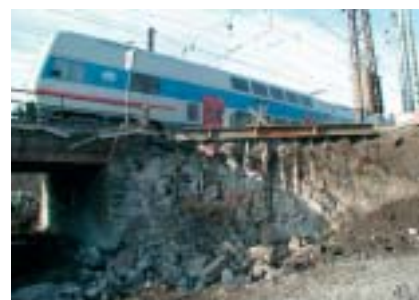
2. Pohled na kotvenou mikrozáporovou stěnu zajišťující výkop pro rozšíření stávajících mostních opěr.
