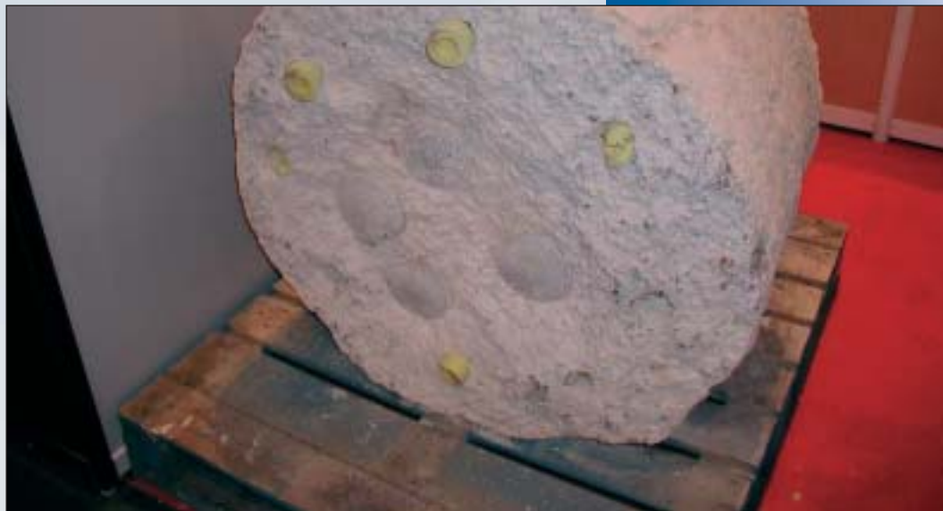
... odlomená horní část piloty po použití polystyrenových návleků
