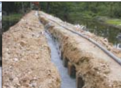
8. Jílocementový práh v místě porušeného úseku hráze
