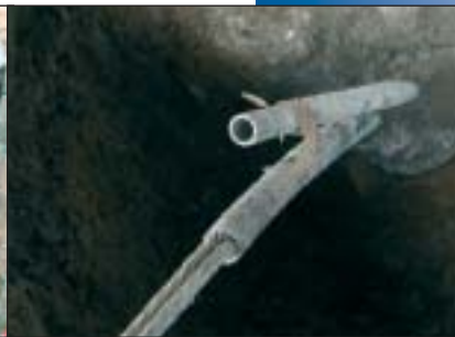
5. Detailní pohled na pramencovou kotvu, jejíž vrt i kořen byly realizovány technologií tryskové injektáže.
