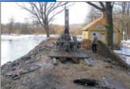
Provádění jílocementové clony pomocí tryskové injektáže v místě oddělení Nové řeky z Lužnice
