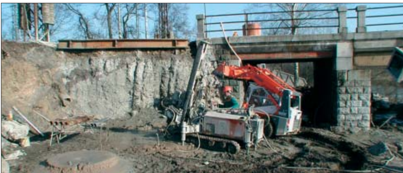
4. Realizace jednotlivých sloupů tryskové injektáže v podzákladí rozšiřujících se mostních opěr pro zvýšení únosnosti mostu. V pozadí je dobře patrné zapažení výkopu pro závěrnou zeď rozšiřované opěry, která je kotvena stěnou z tryskové injektáže (jednotlivé sloupky tryskové injektáže jsou vyztuženy ocelovou trubkou).
