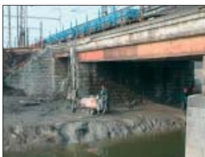
6. Realizace tryskové injektáže stavební jámy pro založení mostního pilíře č. 2
