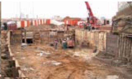
Pohled na stavební jámu od portálu
