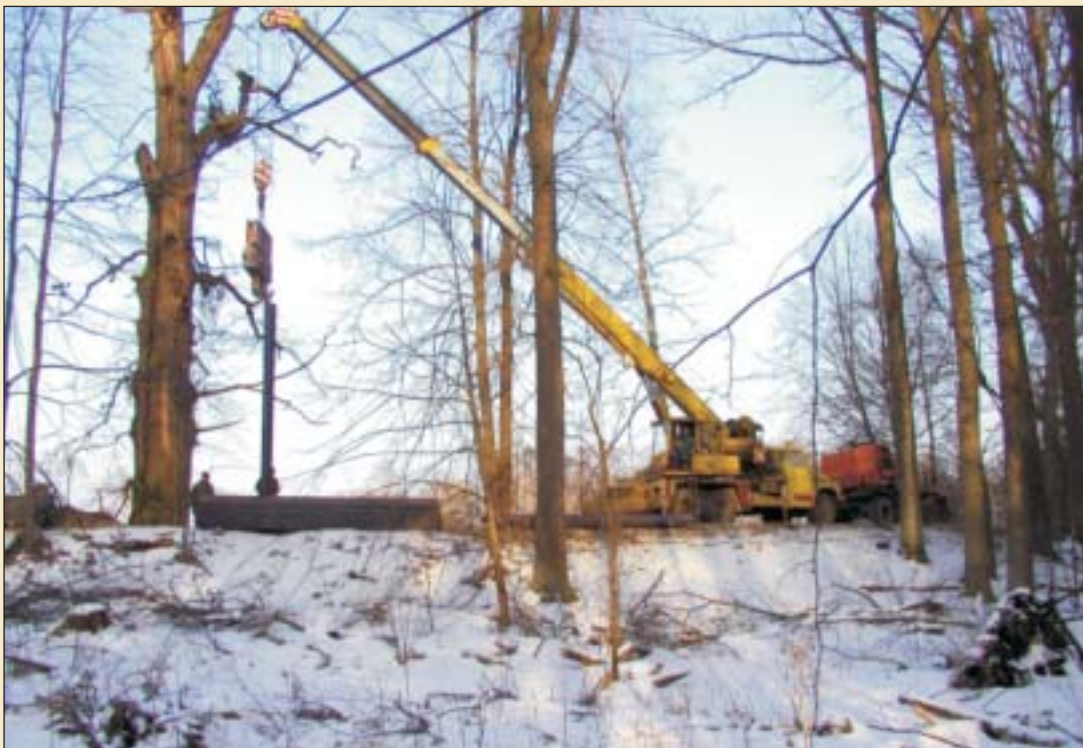
Provádění štětové stěny ze štětovic VL 602
