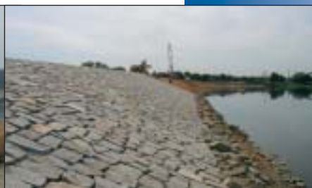
5. Obnovená kamenná dlažba břehového svahu lomovým kamenem do betonu
