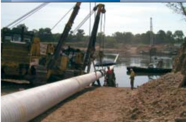
Obr. 7: Spojení dvou částí shybky při jejím zatahování
