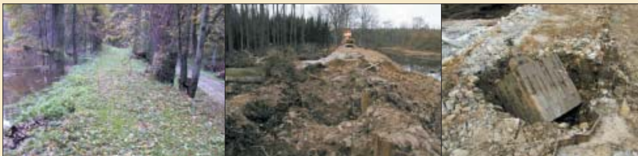
Hráz v místě protržení, probíhající dynamické hutnění pomocí 8,7 tunového závaží
