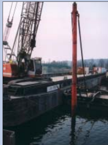
3. Vibroflotační jehla ve fázi hutnění zásypu pod vodní hladinou
