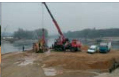
4. Pohled na realizaci hutnicího pokusu pro stanovení optimálních provozních parametrů pro následné hutnicí práce
