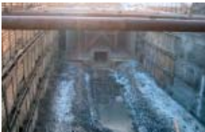
Stavební jáma rozepřená sedmi kusy ocelových trub
