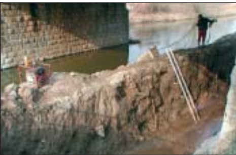
5. Část vytěžené stavební jámy pro založení nového mostního pilíře č. 3 realizovaná pomocí tryskové injektáže.
