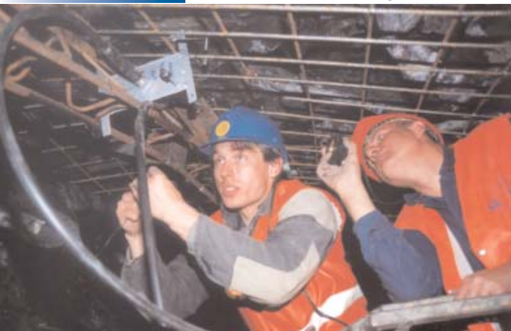
10. Osazování tlakové podušky v ZTT Mrázovka
