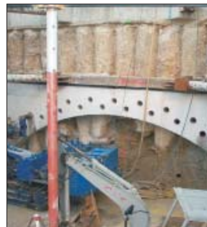
2. Řešení startovací jámy při budování ochranného mikropilotového deštníku
