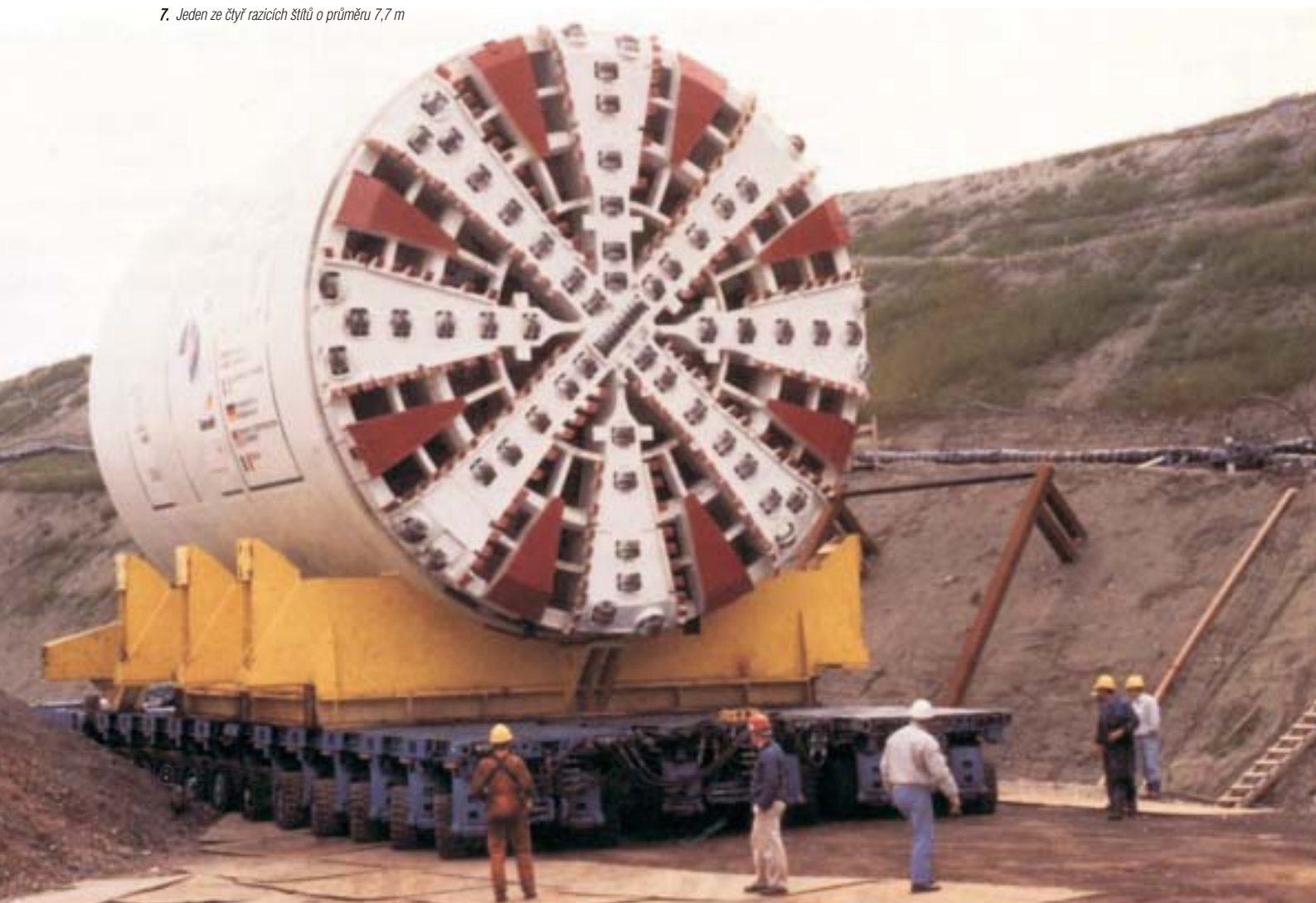
7. Jeden ze čtyř razicích štítů o průměru 7,7 m
