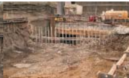
Pohled na částečně demontovanou mikropilotovou příčku
