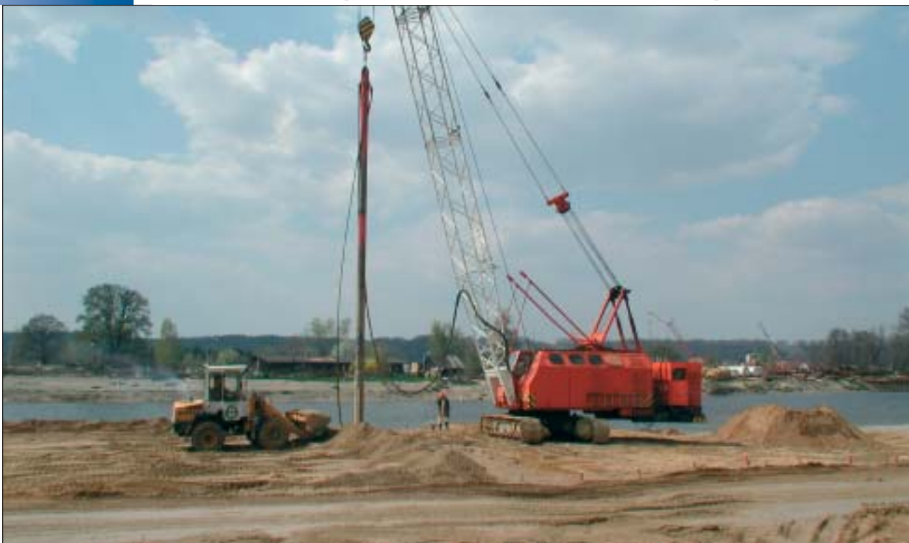
2. Strojní sestava použitá pro hloubkové hutnění metodou vibroflotace
