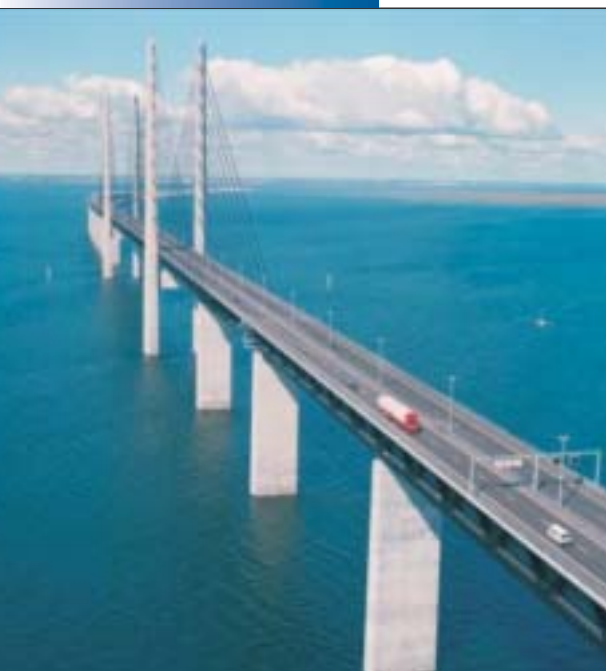
6. Celkový pohled na východní most délky 6,8 km
