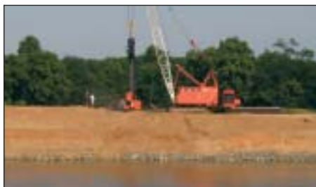
3. Vibroberanici souprava usazená na nasypné hrázi provádí beranění štětové stěny, v dolní části nad hladinou toku je zřetelná patka z lomového kamene.
