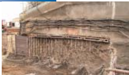
Pohled na stěnu A v místě kotvené mikropilotové stěny
