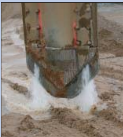
4. Detailní pohled na špicí vibroflotační jehly při spuštěném vodním výplachu
