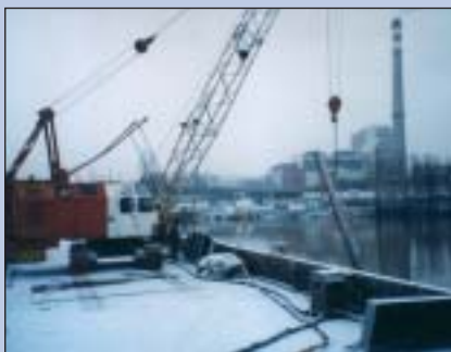
1. Sací bagr zavěšený na jeřábu RDK, fáze čištění průchodek pro podinjektování tubusu
