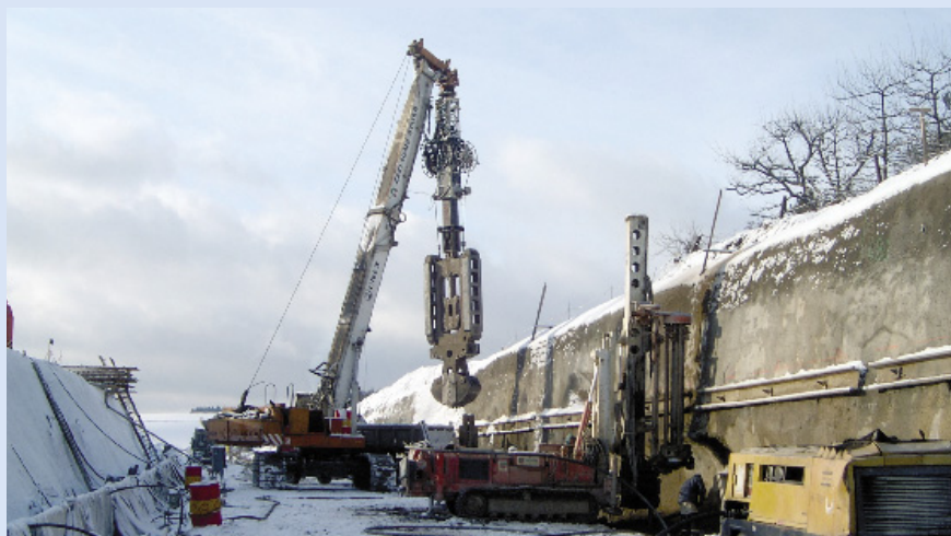
Obr. 13: Těžba rýhy podzemních stěn
