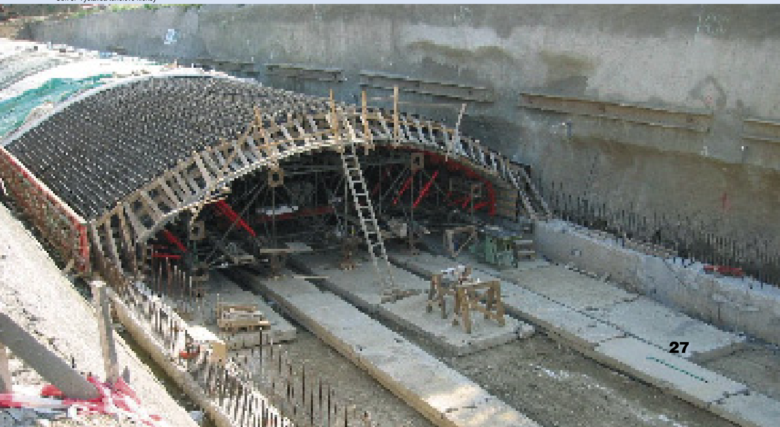
Obr. 8: Výstavba tunelové klenby
