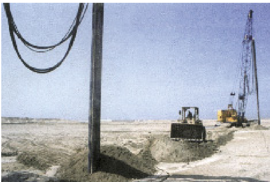
Obr. 3: Stavební týmy provádějící vibrační práce na výběžcích ostrova Jumeirah
