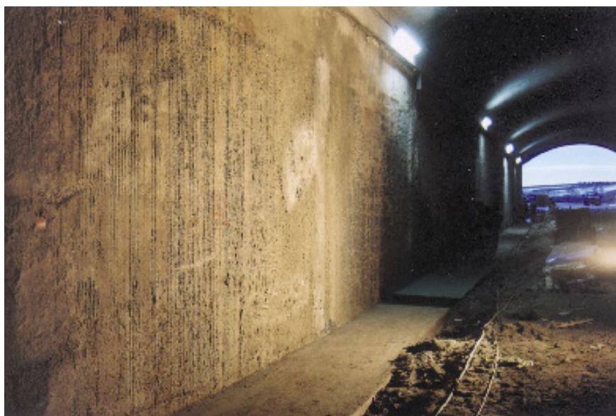
Obr. 16: Konečná úprava líce podzemních stěn
