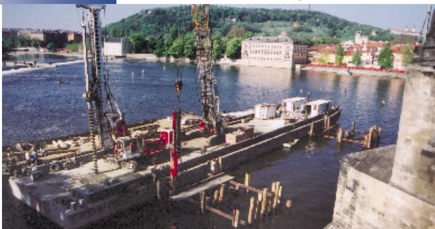
Obnova ledolamů před pilíři Karlova mostu
