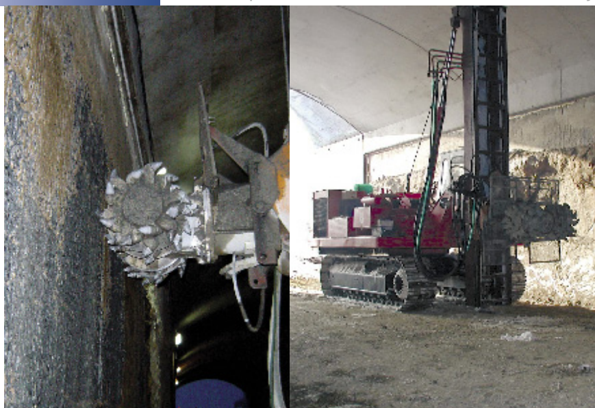
Obr. 14, 15: Zčištění líce podzemních stěn frézou
