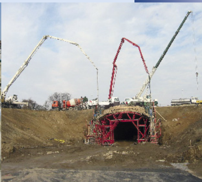
Obr. 9: Betonáž jižního portálu
