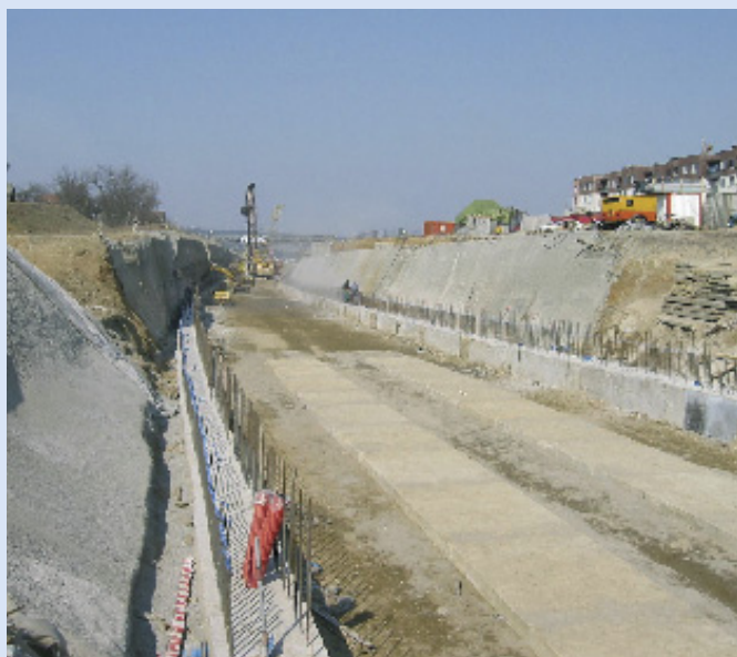
Obr. 7: Podzemní stěny před betonáží klenby
