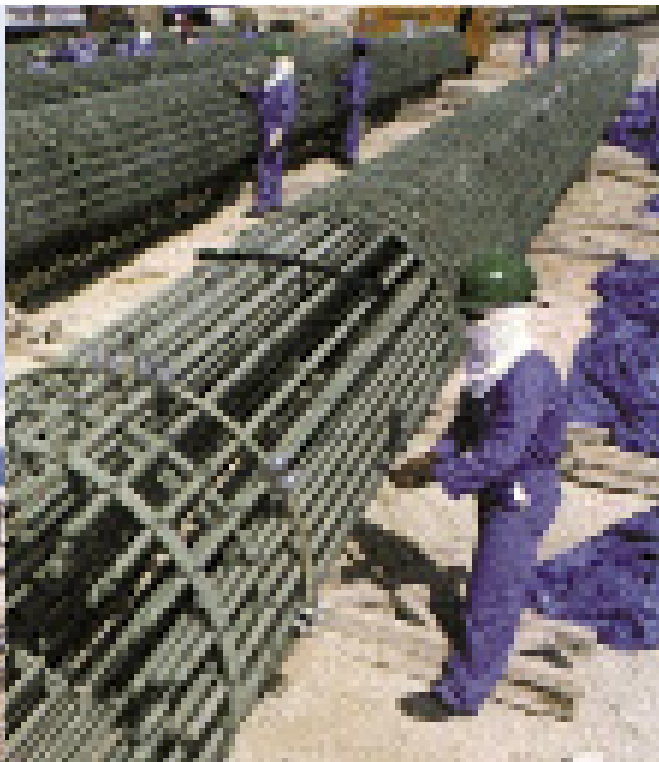
Obr. 5: Armovací ocel se zeleným epoxidovým nátěrem
