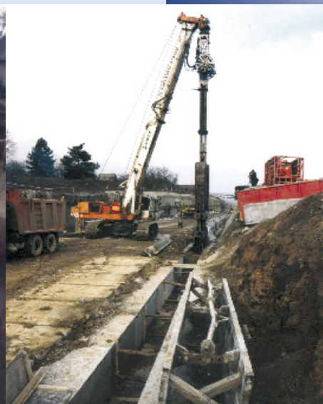
Obr. 12: Těžba rýhy podzemních stěn
