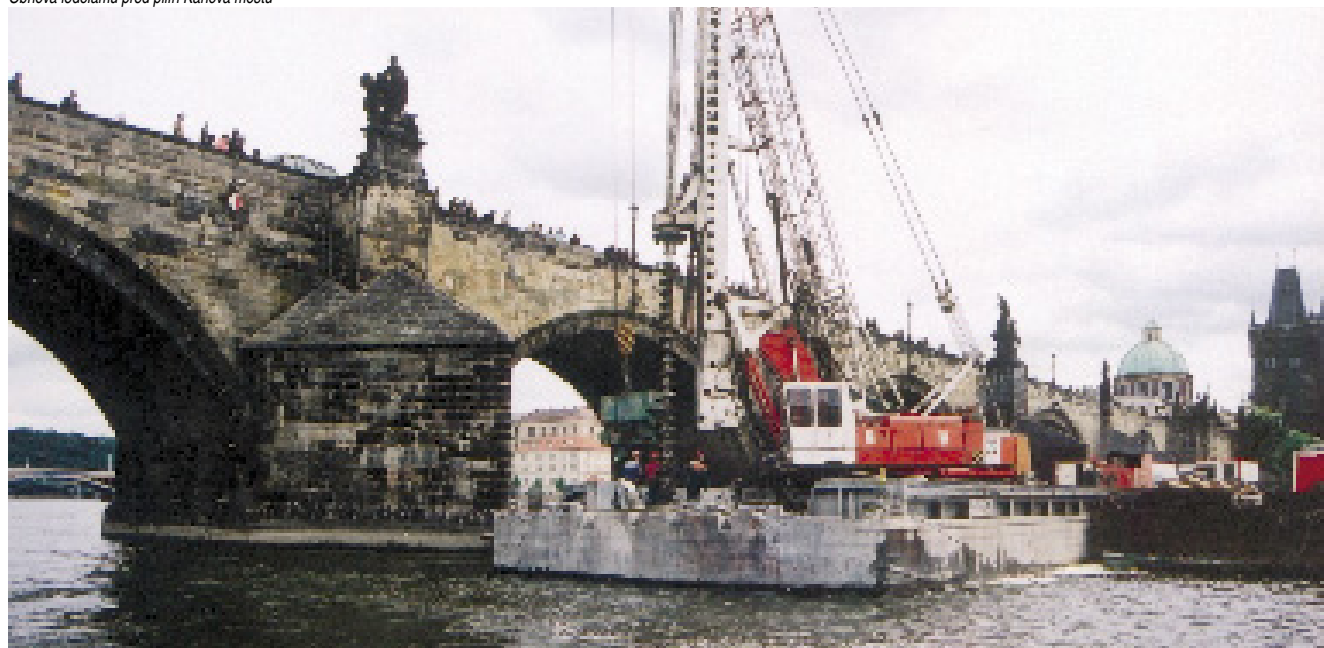
Obnova ledolamů před pilíři Karlova mostu
