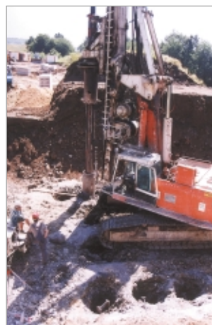
Vrtná souprava Delmag RH1413 v předvýkopu pro pilíř 2, vrtání zápor
