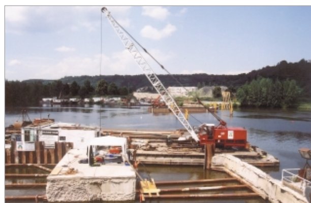
Práce na otevírání čela holešovické jímky, v pozadí soulodí provádějící vyrovnání dna výkopu v místě šesti příčných prahů
