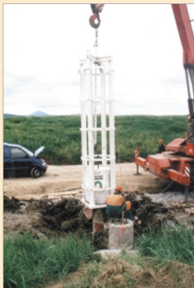
Dynamická zkouška DLT na pilotě Z3 (žel. most na trati Ústí n. L. – Trmice)
