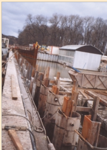
Pohled na část hotových stojek z larsen pro pravobřežní svodidlo, osazených do vrtů pod ochranou pažnic (2/2002)
