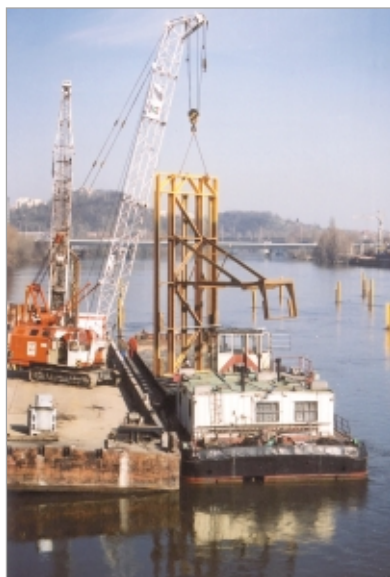
Manipulace s vyváženou 11tí tunovou ochrannou konstrukcí
