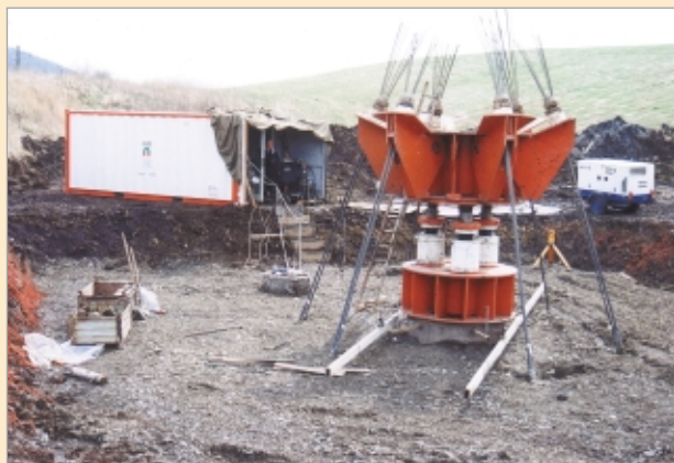
Sestava statické zatěžovací zkoušky piloty Z1 prům. 1500 mm (žel. most na trati Ústí n. Lab. – Trmice)
