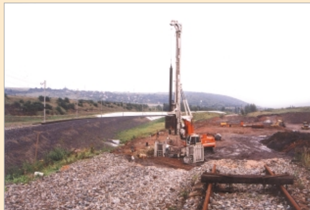
Hloubení vrtů pro piloty opěry č. 3 (teplotické)
