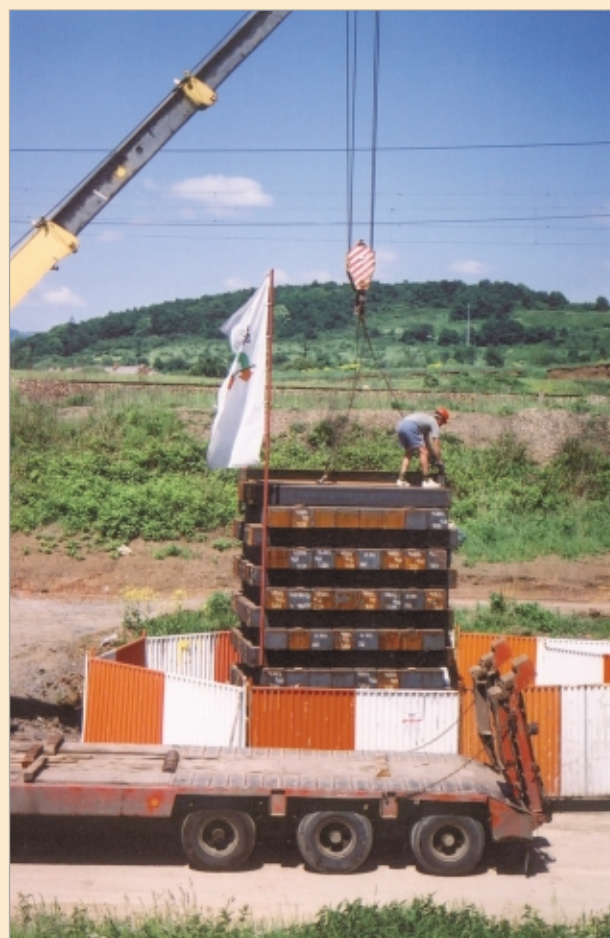
Sestava pro dlouhodobou statickou zatěžovací zkoušku piloty Z3 (žel. most na trati Ustí n. Lab. – Trmice)
