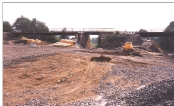
Trat' s mostními provizorii
