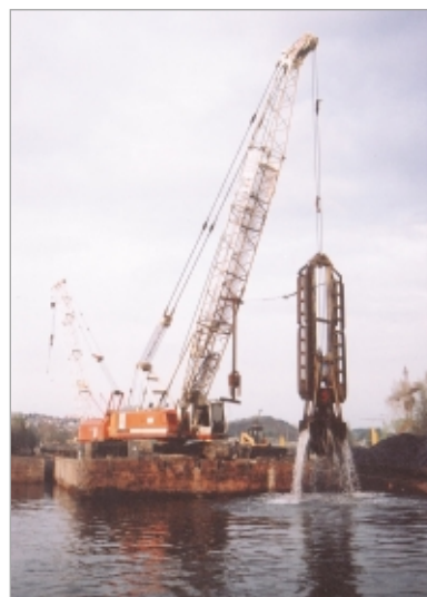
Těžba břidlic drapákem Stein
