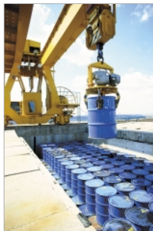
Obr. 6: Úložiště v areálu jaderné elektrárny Dukovany
