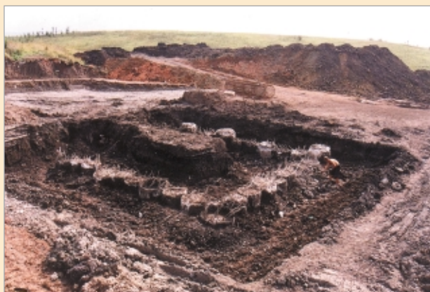
Hlavy pilot opěry č. 1 (ústecké) po odtěžení před úpravou
