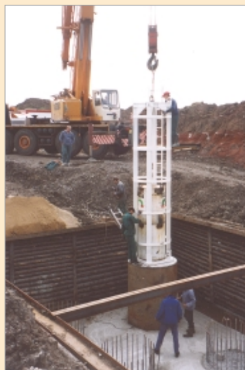
Dynamické zatěžovací zkoušky na hlavě jedné z pilot pilíře č. 2
