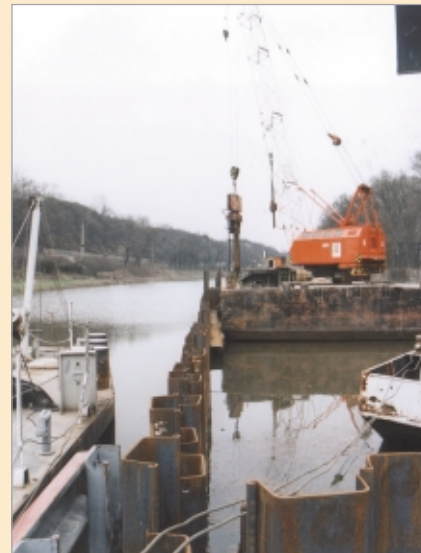
Beranění jímky z larsen na dolním ohlaví pod VPK, stěna mezi MPK a VPK (2/2001)
