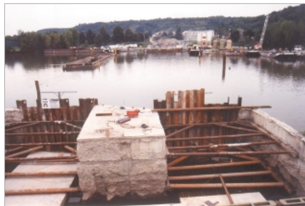
Holešovická jímka po zatažení tubusu a uzavření čela jímky
