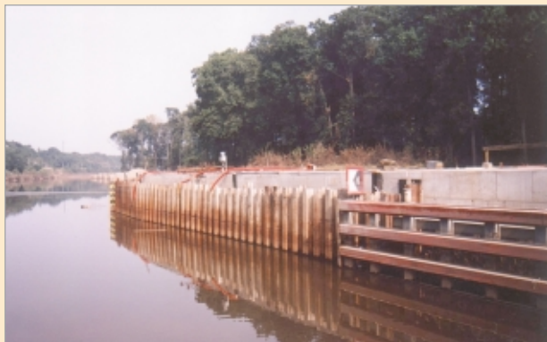
Pohled na štětovou stěnu jímky dolního ohlaví po rekonstrukci a po prodloužení dělicí zdi mezi VPK a MPK (8/2002)
