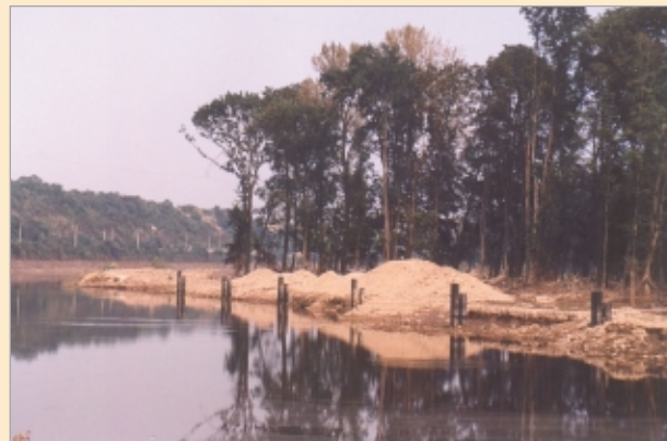
Osazené krabice z larsen pro montáž dalb na dolním plavebním kanále (08/2002)
