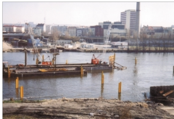
Osazování ochranné konstrukce tubusu, dobře patrná je síť vázacích larsen
