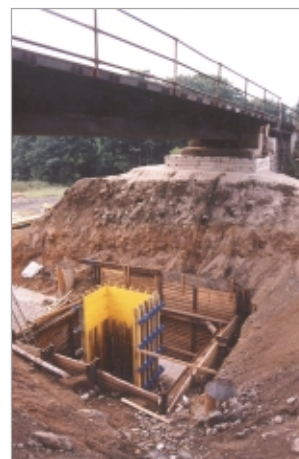
Stavba pilíře v jámce pod zprovozněnou tratí
