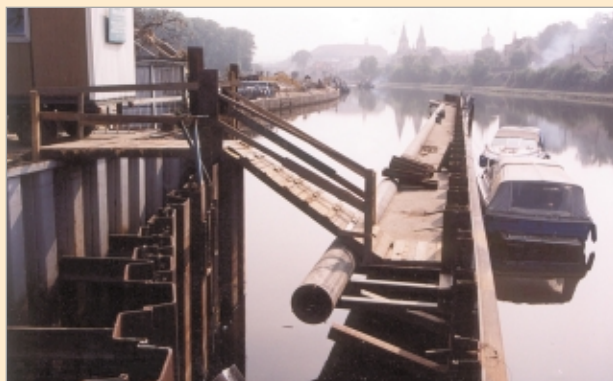
Již hotová část pravobřežních svodidel s lávkou, horní plavební kanál (8/2002), pohled z druhé strany
