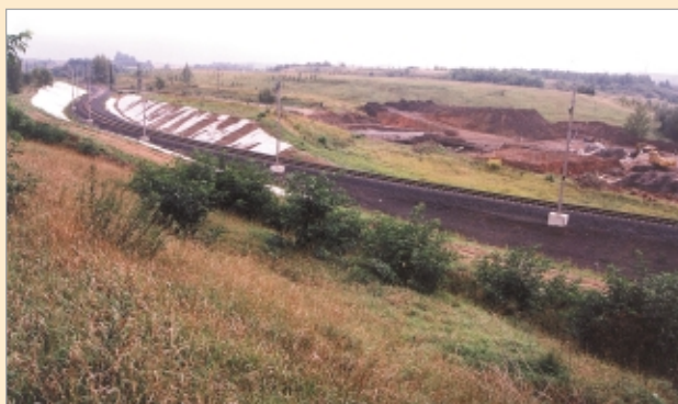
Celkový pohled na staveniště
