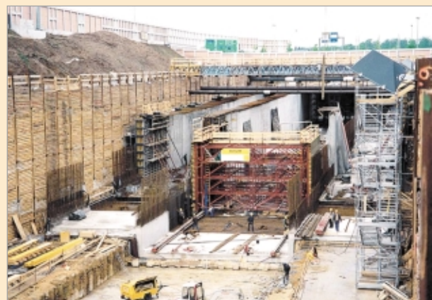
Obr. 2: Pohled do stavební jámy pro vysokorychlostní železnici u Frankfurtu
