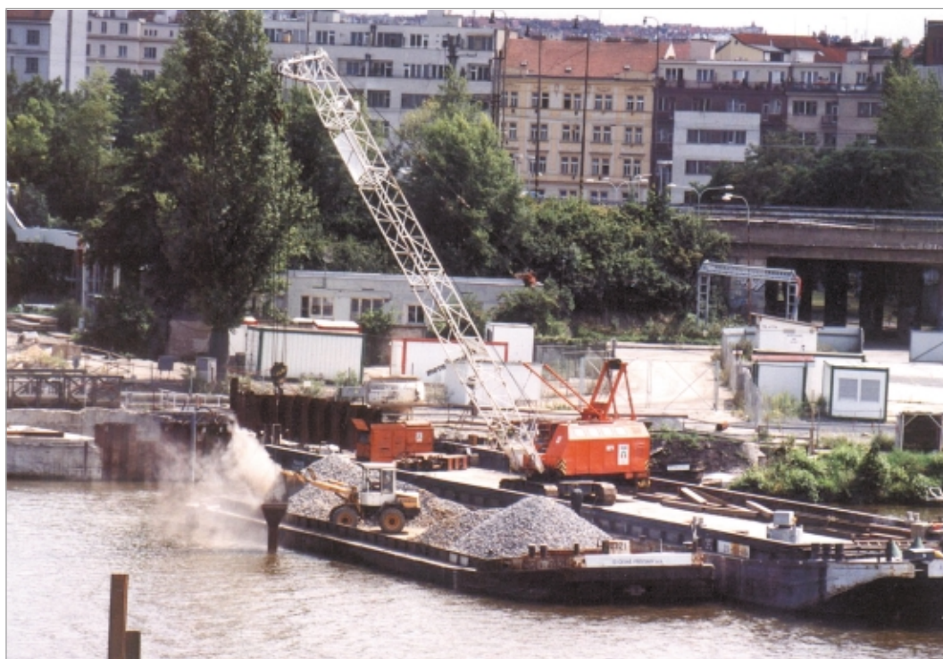
Obsypávání zataženého tubusu tříděným kamenivem pomocí násypky do hloubky cca 10 – 12 m
