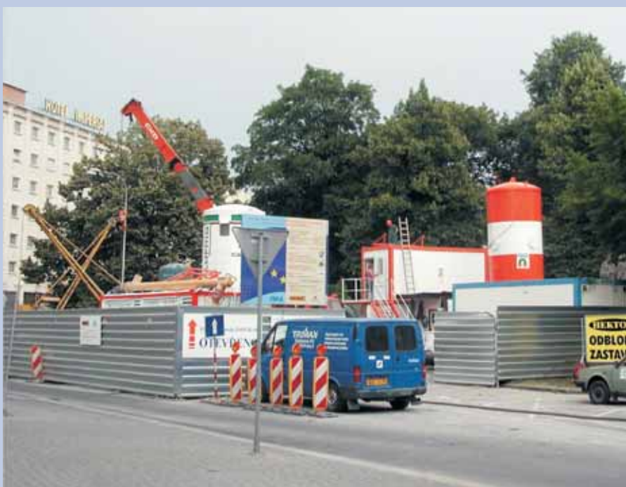
1. Zařízení staveniště v centru Ostravy
