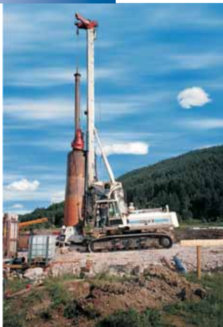
Vrtání velkopřůměrových pilot vrtnou soupravou Wirth ECOdrill 16 pro založení mostu „Gacka“ na dálnici Zagreb–Split
