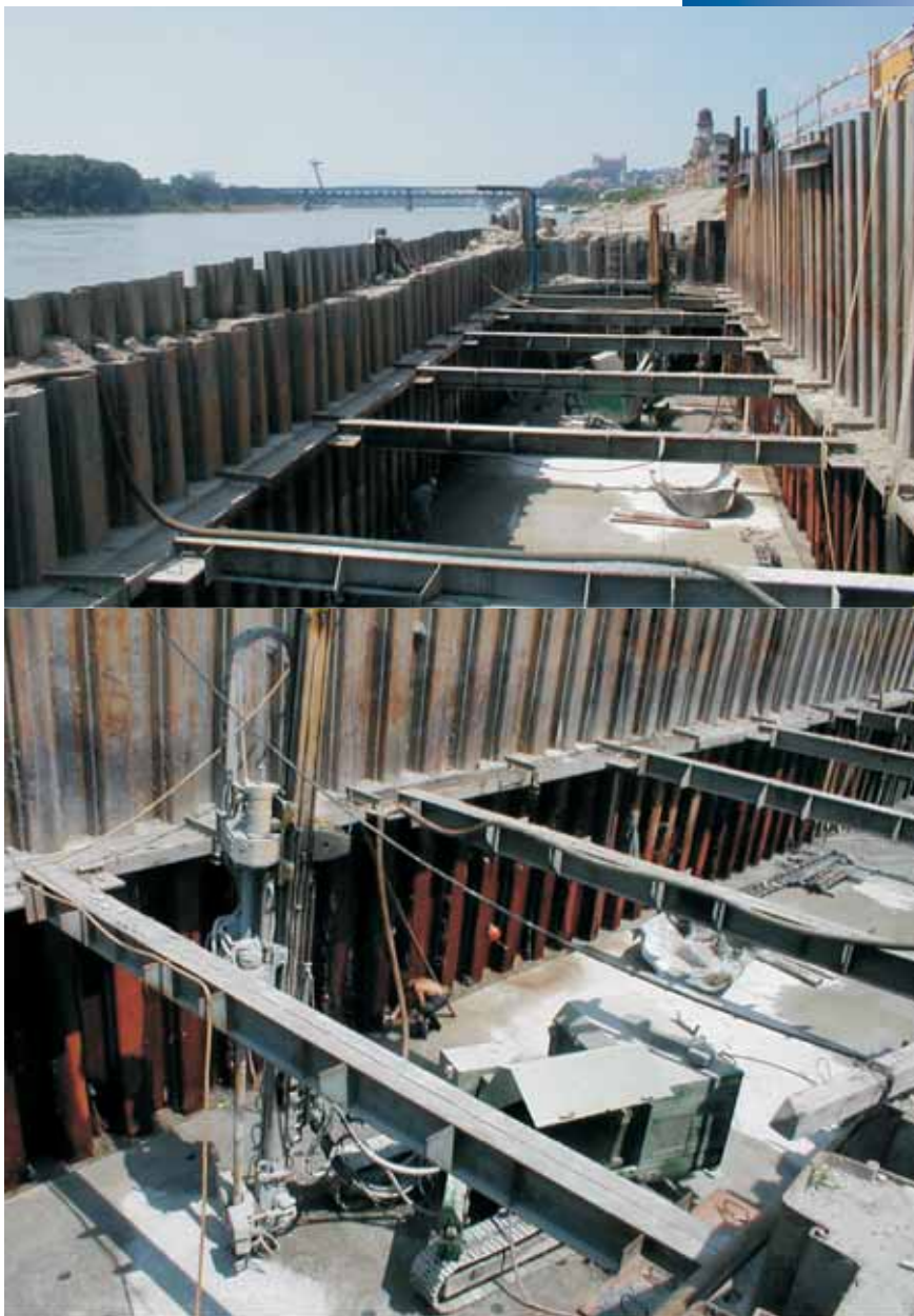
Hloubení vrtů pro mikropiloty pod pilířem nového přemostění přes Dunaj v Bratislavě. Jedna pata pilíře reprezentovala hloubení 333 mikropilot o délce 8 m.
