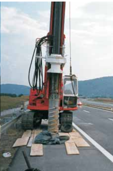
Vrtnou soupravou Soilmec R6 byly provedeny piloty pod sloupy protihlukové zdi na stavbě „ZZB Bosiljevo – Josipdol“
