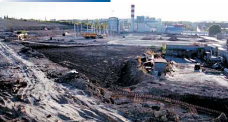
Staveniště obchodního centra Carrefour je situováno na navázkách staré cihelny, celkový pohled
