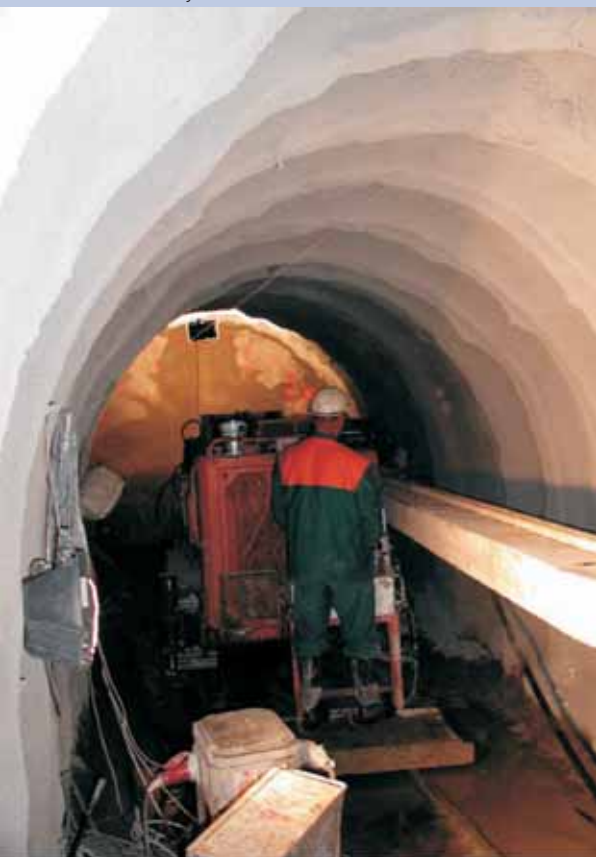
9. Vrtná souprava Casagrande M5SD při provádění sanační obálky z tryskové injektáže pro zajištění výrubu kaloty a boků tunelu
