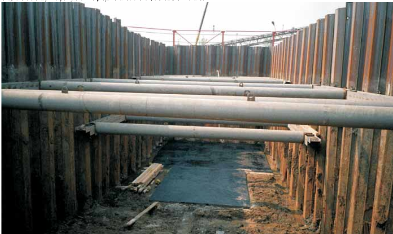
Rozepřená štětová jímka po vytěžení na projektovanou úroveň, stavba „FCL Lukavac“
