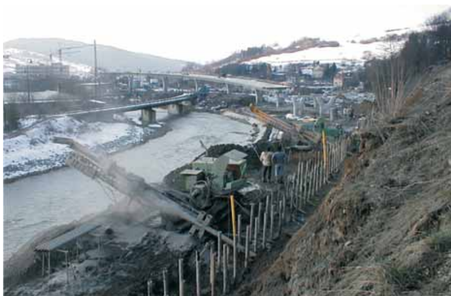
Hloubení vrtů pro kotvy vrtnou soupravou HVS 582 v rámci prací na obchvatu města Čadca (prováděla firma Geostatik). Celkově bylo na této stavbě vyhloubeno 15 km vrtů pro mikropiloty a kotvy.
