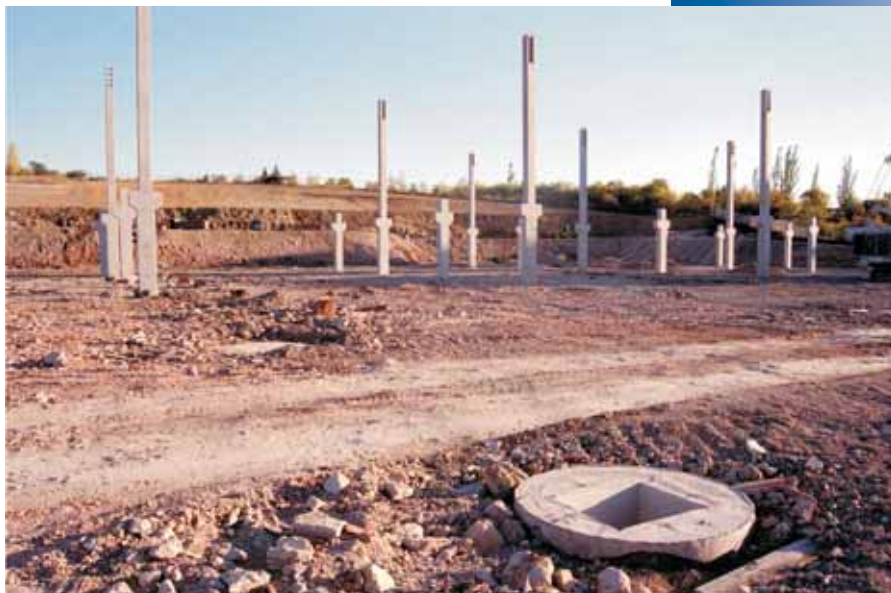
Do hlav pilot opatřených kalichy jsou vestavěny nosné sloupky budoucí konstrukce obchodního centra
