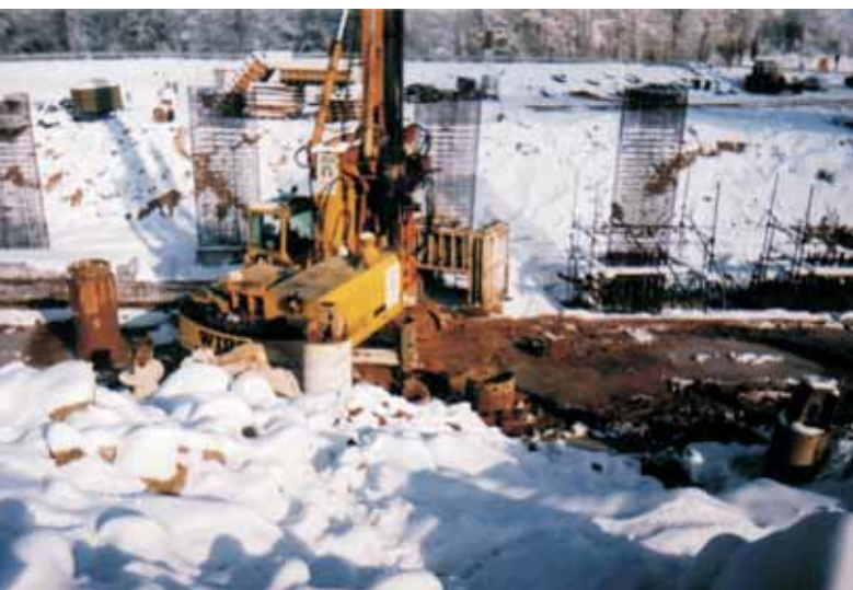
Hloubení pilot pod základy dálničního nadjezdu na budované dálnici Zagreb–Rijeka, stavba „Podvožňak Gaji“
