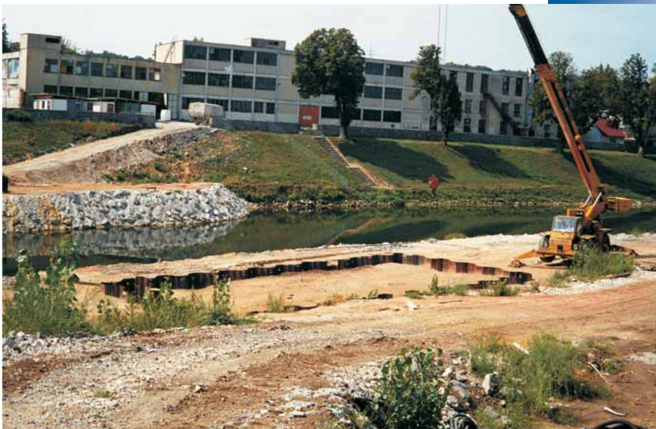
Celkový pohled na jímku před vytěžením, stavba „Most Drežnik Karlovac“
