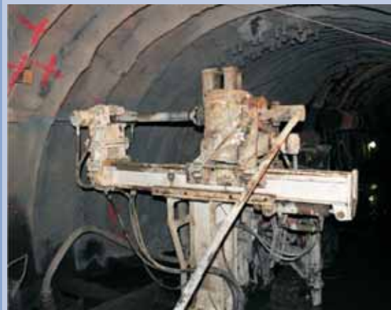
↑10, ↓11: Vrtná souprava MSV 741 s osazenou příčnou lafetou, umožňující vrtné a injekční práce i v omezeném pracovním prostoru
