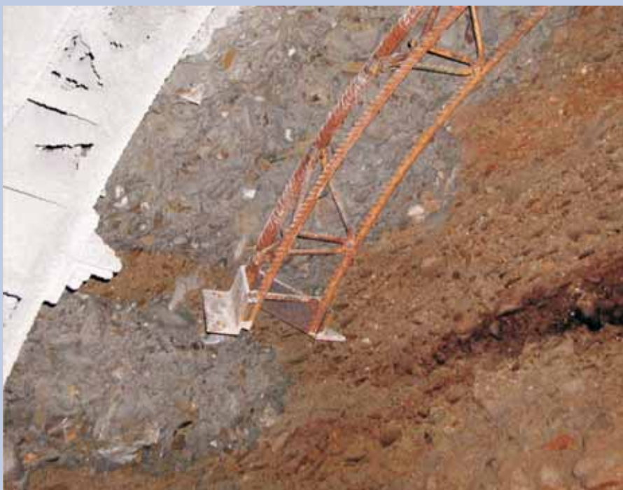
6. Pohled na celistvou sanační injecktáž boku štoly kolektoru
