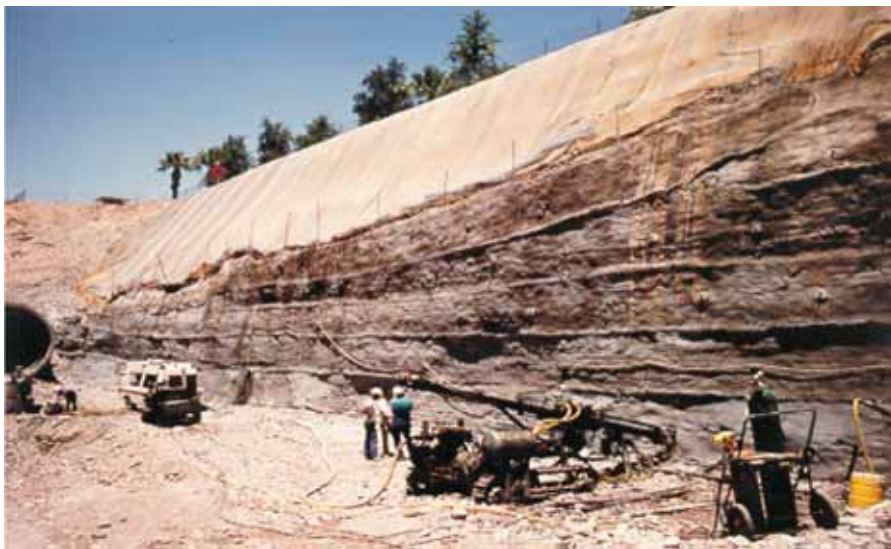
Soil nailing – ilustrační foto
