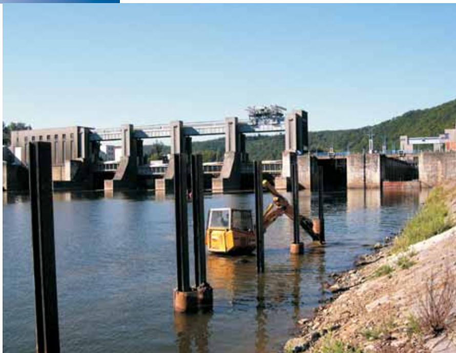
6. Štětovnice pro čekací stání osazené do vrtů
