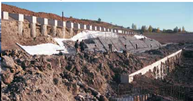
Stěny stavební jámy jsou podchyceny pilotovými a podzemními stěnami v kombinaci s gabióny
