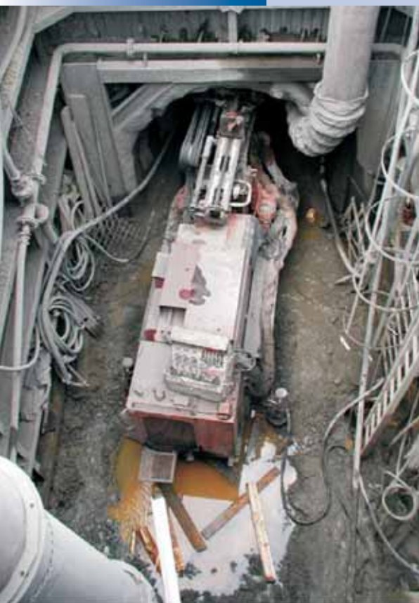
8. Vrtná souprava Casagrande M5 SD při zajištění z šachty Š 14 do štol kolektoru
