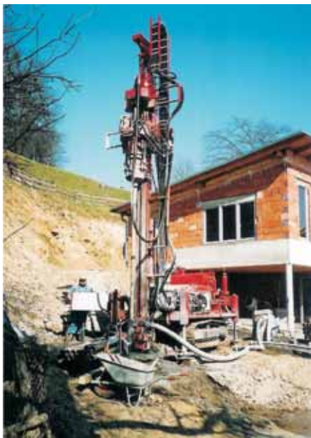
Hloubení vrtů pro tepelná čerpadla. Firma Hagleitner (Rakousko) vyhloubila se soupravami firmy JaNo, s. r. o., celkem 35 km vrtů pro tepelná čerpadla. Měsíční výkon pro jednu soupravu s dvoučlennou posádkou se pohybuje v rozmezí od 1000 do 1300 m. Vrtý se provádějí do hloubek 100 a 130 m a jsou v mnoha případech paženy v celé hloubce.
