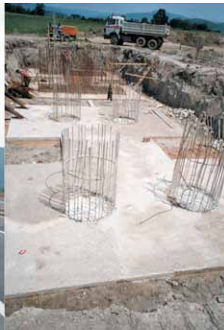
Hotové piloty po odšramování, stavba „Gacka“
