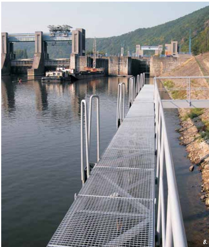
8. Pohled na ocelovou konstrukci čekacích stání na dolní vodě před dokončením
