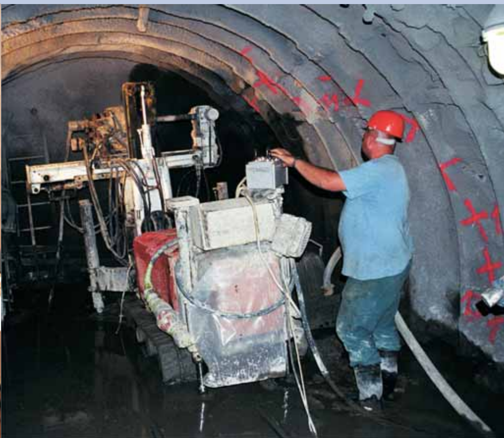
↑10, ↓11: Vrtná souprava MSV 741 s osazenou příčnou lafetou, umožňující vrtné a injekční práce i v omezeném pracovním prostoru
