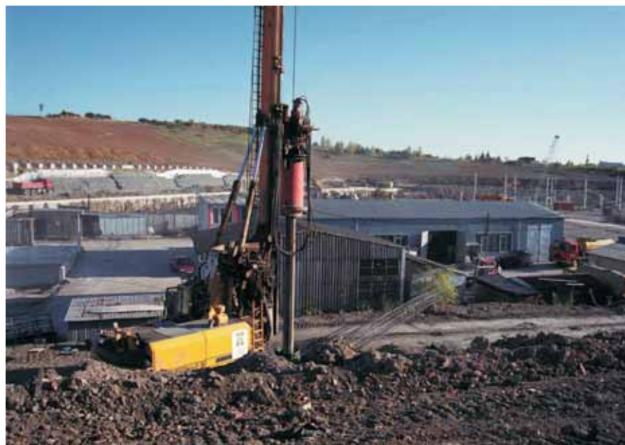
Vrtná souprava při hloubení vrtů pro piloty
