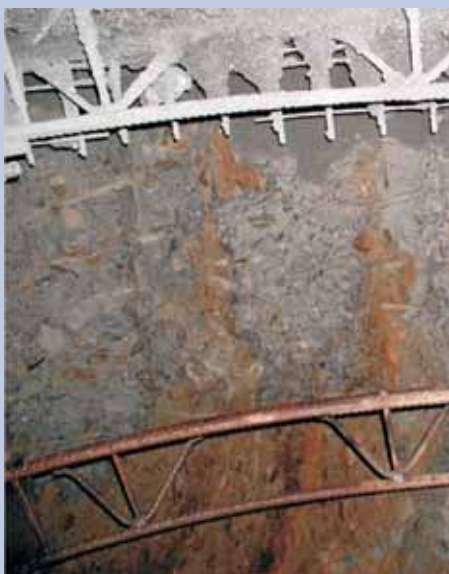
5. Pohled na celistvou sanační injecktáž kaloty štoly kolektoru
