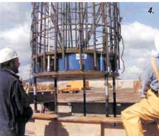
1. Ztracené Osterbergské buňky s větším počtem lisů lze začlenit do armokošů a zajistit tak velké množství údajů získaných v průběhu zkoušek.
