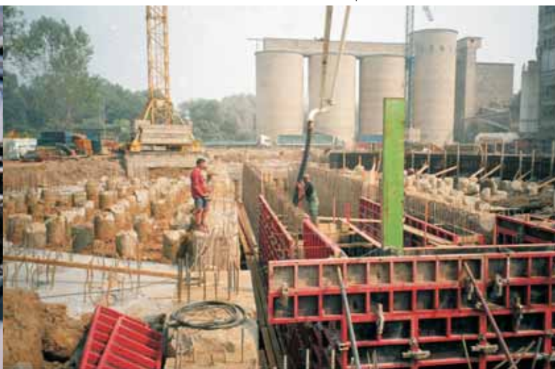
Stavební práce na modernizaci objektu cementárny „FCL Lukavac“
