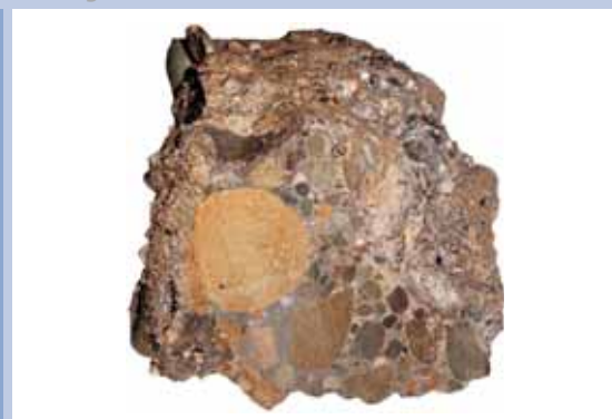
7. Pohled na řez odkopem homogenně proinjektované zeminy
