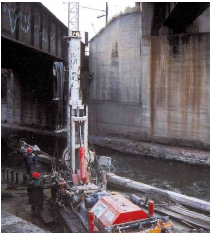
Obr. 8: Stísněné dispoziční poměry při provádění tryskové injektáže pod železničními mosty
