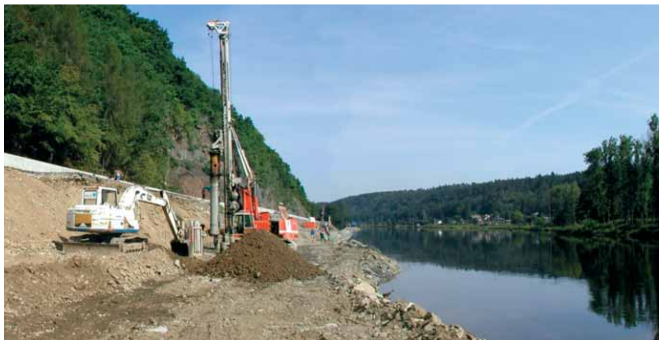
Pohled na staveniště a jeho okolí
