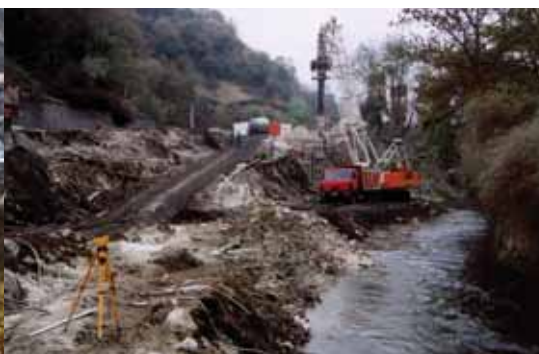
Obr. 4: Příprava pracovních plošin, sjezdová rampa
