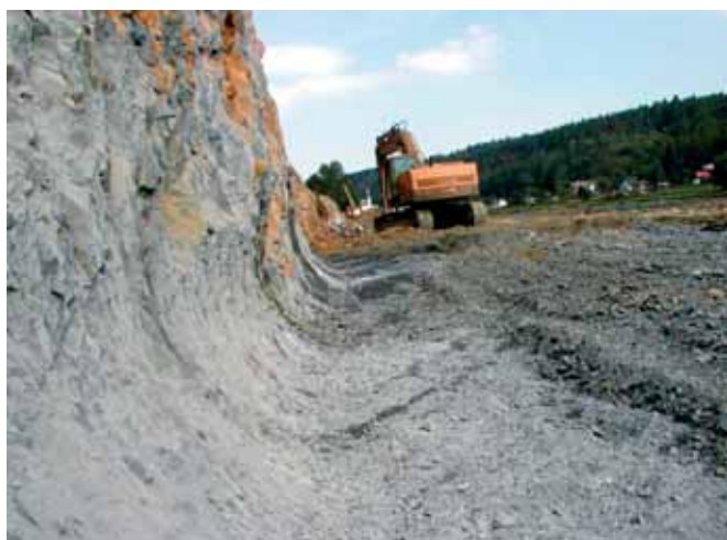
Pata svahu z břidlic se upravila frézou na úpravu povrchu podzemních stěn do potřebného tvaru
