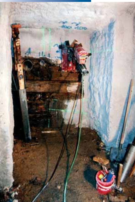
Realizace vrtů pro domovní přípojky inženýrských sítí z kolektorové ražené domovní rozrážky
