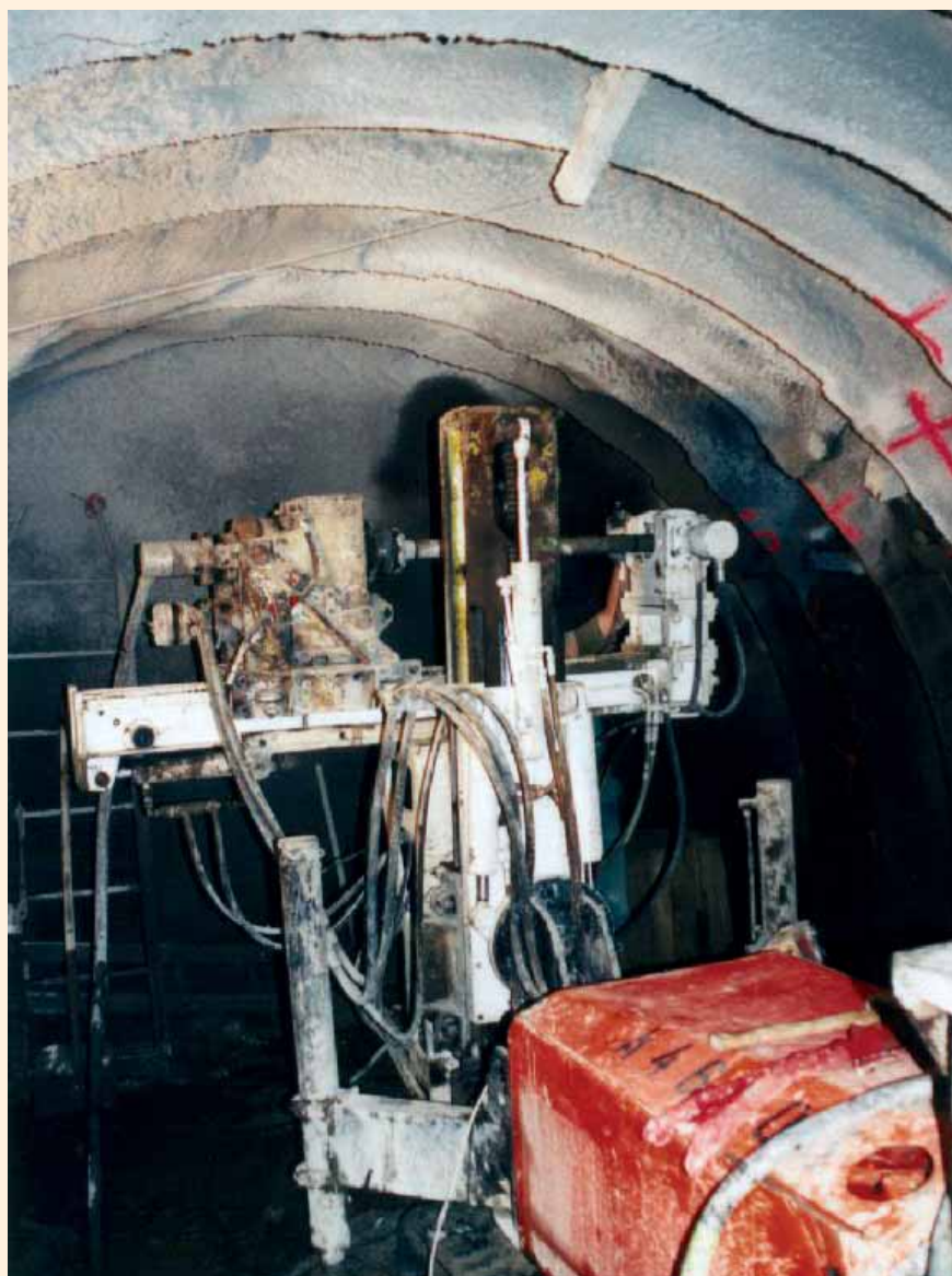
Vrtná souprava MSV 741/20 s příčnou lafetou při hloubení vrtů pro sanační injektáž ve štolu kolektoru.
