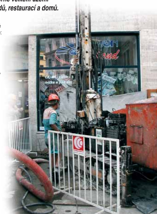
Realizace sloupů tryskové injektáže vrtnou soupravou Hütte
