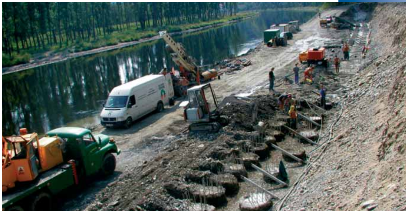
Část základové spáry opěrné zdi založené na začátku úseku na jedné řadě pilot a v další části na dvou řadách pilot
