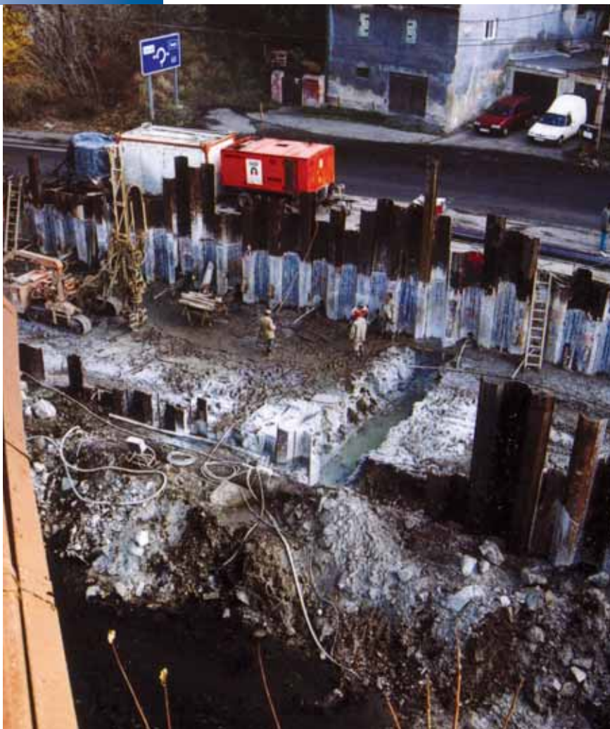
Obr. 6: Zaberaněná jímka s těsnicí přepážkou
