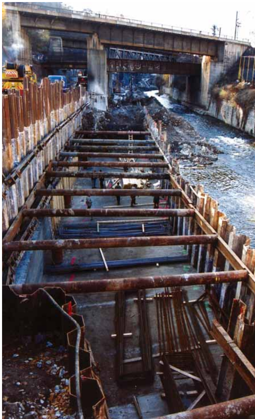
Obr. 10: Zabetonování dna spodního dilatačního úseku č. 6
