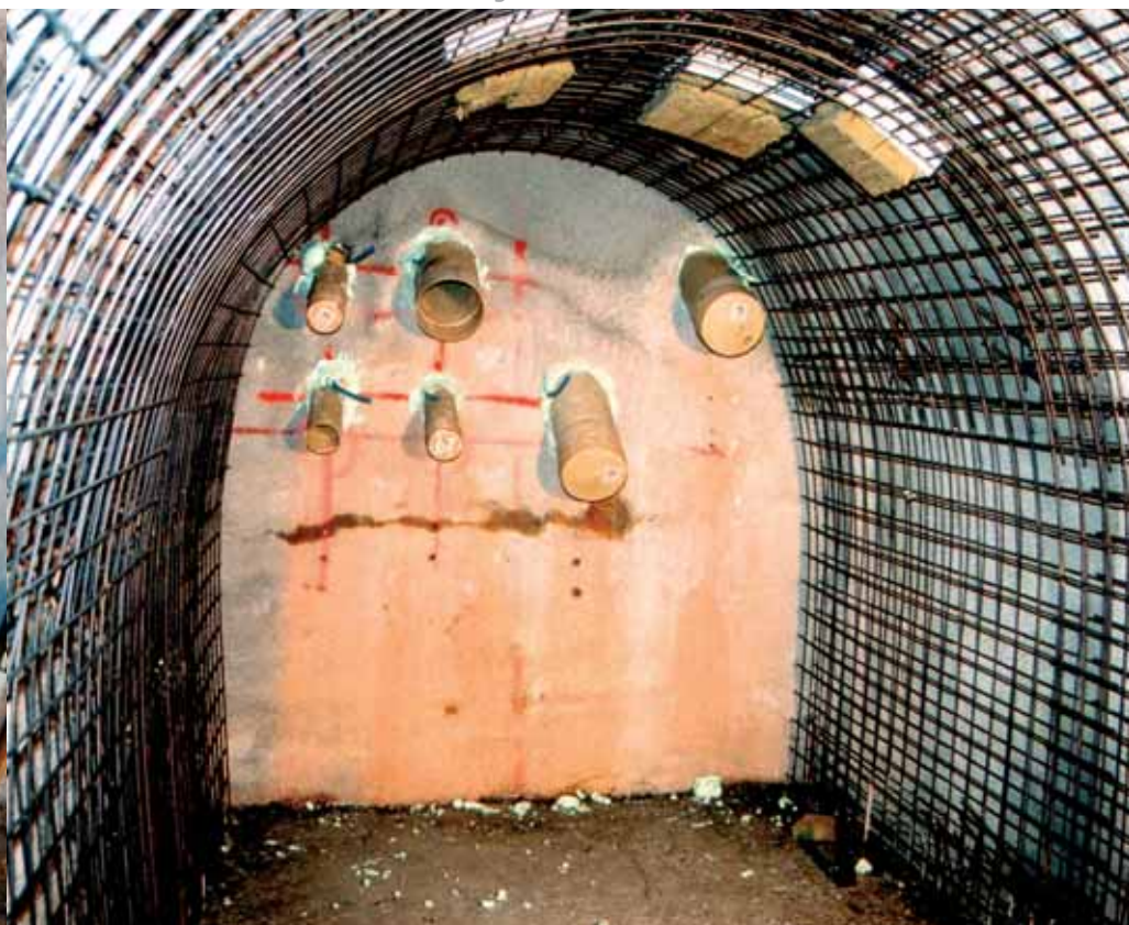
Domovní přípojky inženýrských sítí vystrojené laminátovými průchodkami z místa kolektorové ražené domovní rozrážky
