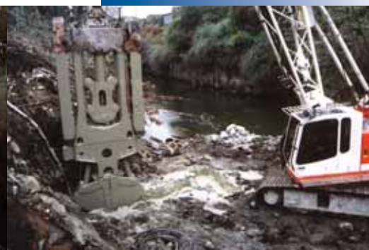
Obr. 5: Hlubení rýhy pro osazení štětovnic
