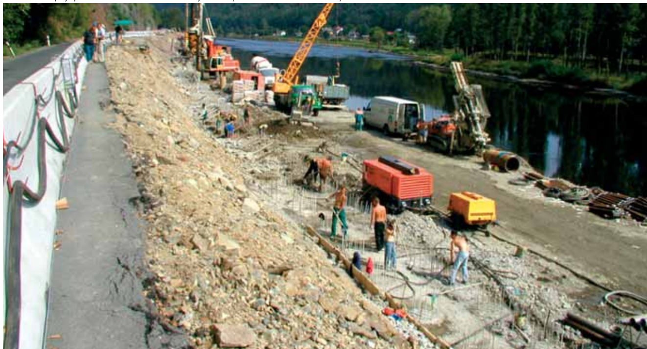
Část základové spáry opěrné zdi založené na začátku úseku na jedné řadě pilot a v další části na dvou řadách pilot
