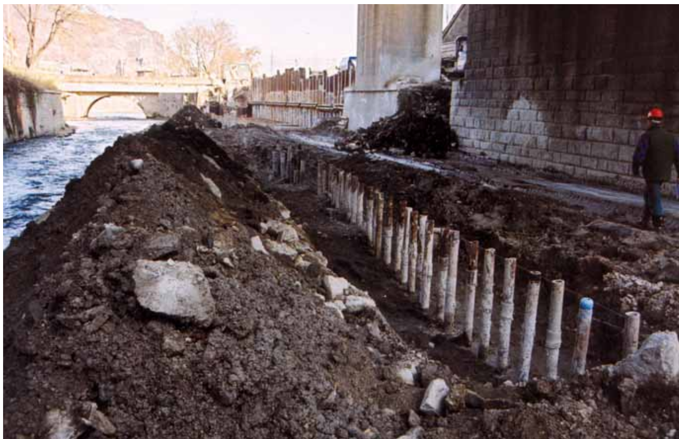
Obr.9: Trysková injektáž s osazenými výztužnými trubkami pod prostřením mostem
