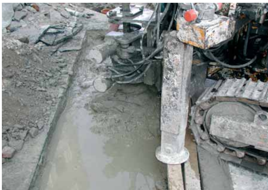
Pohled na vyplavený materiál při realizaci sloupů tryskové injektáže v jílovité zemině
