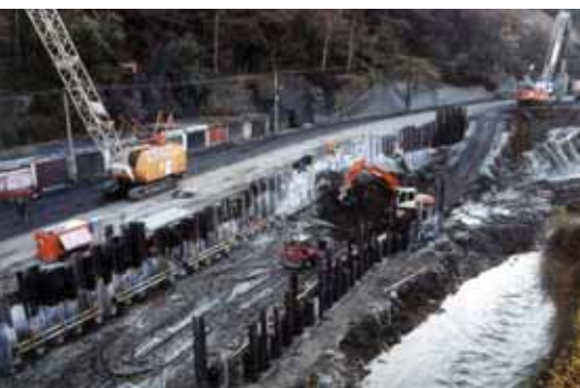
Obr. 3: Pohled na horní část staveniště po zaberání štětovnic
