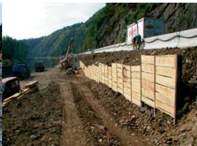
Dočasné záporové pažení; po vybetonování opěrné zdi byly pažící konstrukce odstraněny
