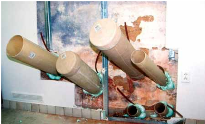
Domovní přípojky inženýrských sítí vystrojené laminátovými průchodkami ze sklepního prostoru před dokončovacími úpravami
