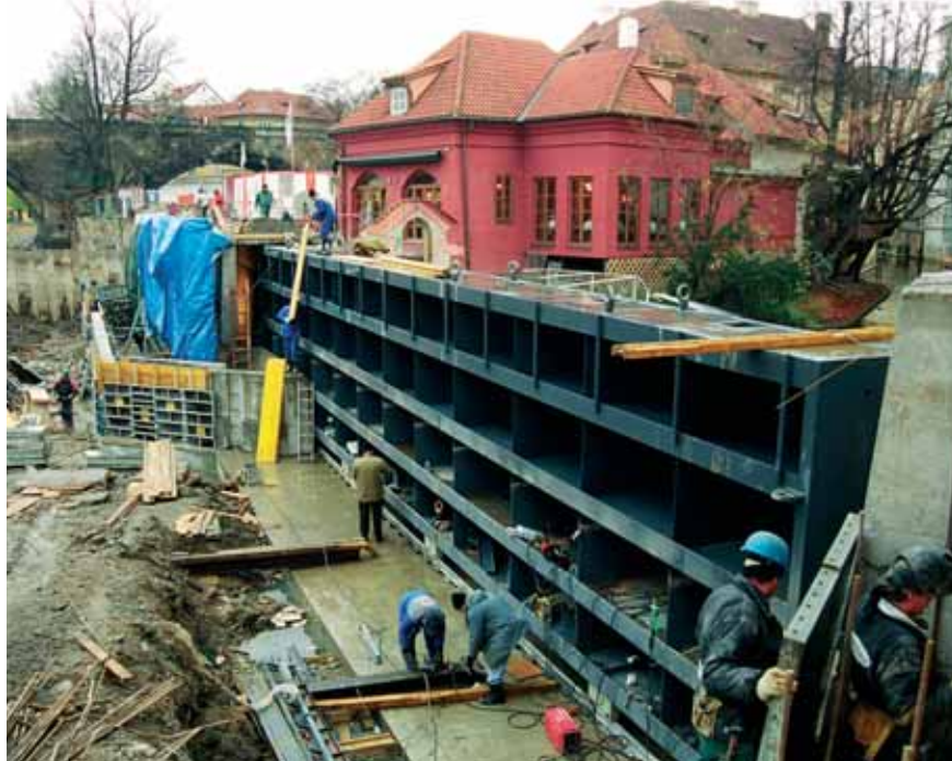
Pohled na tabulový uzávěr Čertovky při montáži
