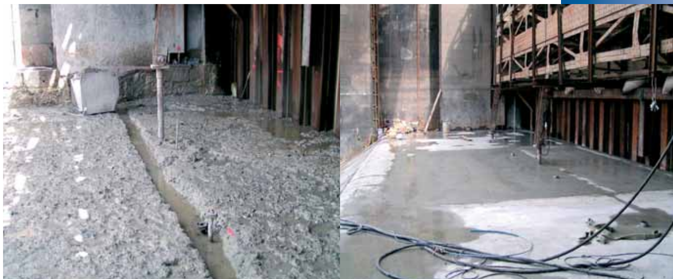
Pracovní spára pod budoucí novou železobetonovou deskou
