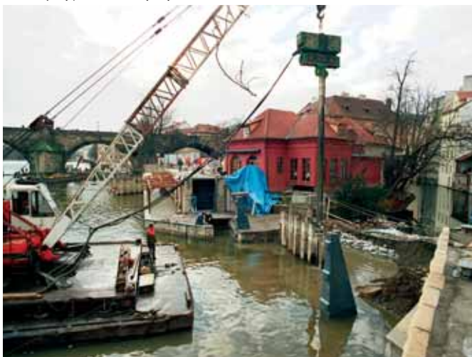
Likvidace jímky prováděná z vody – vytahování štětovic Larsen Illn
