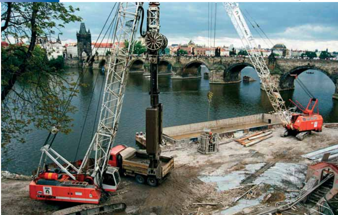
Těžba podzemních stěn
