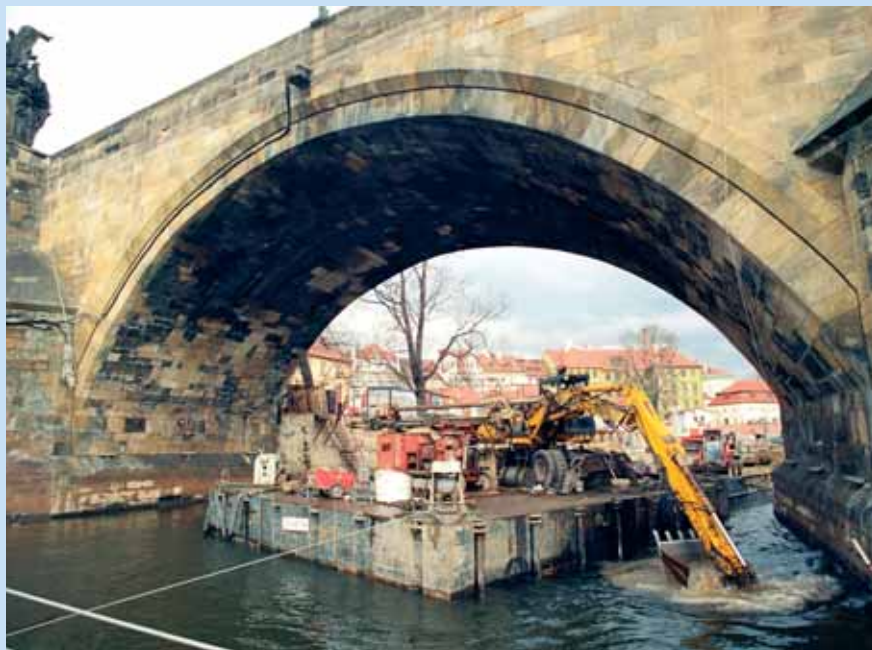
Odstraňování zbytků záhozu v místě budoucí ochranné obálky z pontonového soulodí strojem Sennebogen
