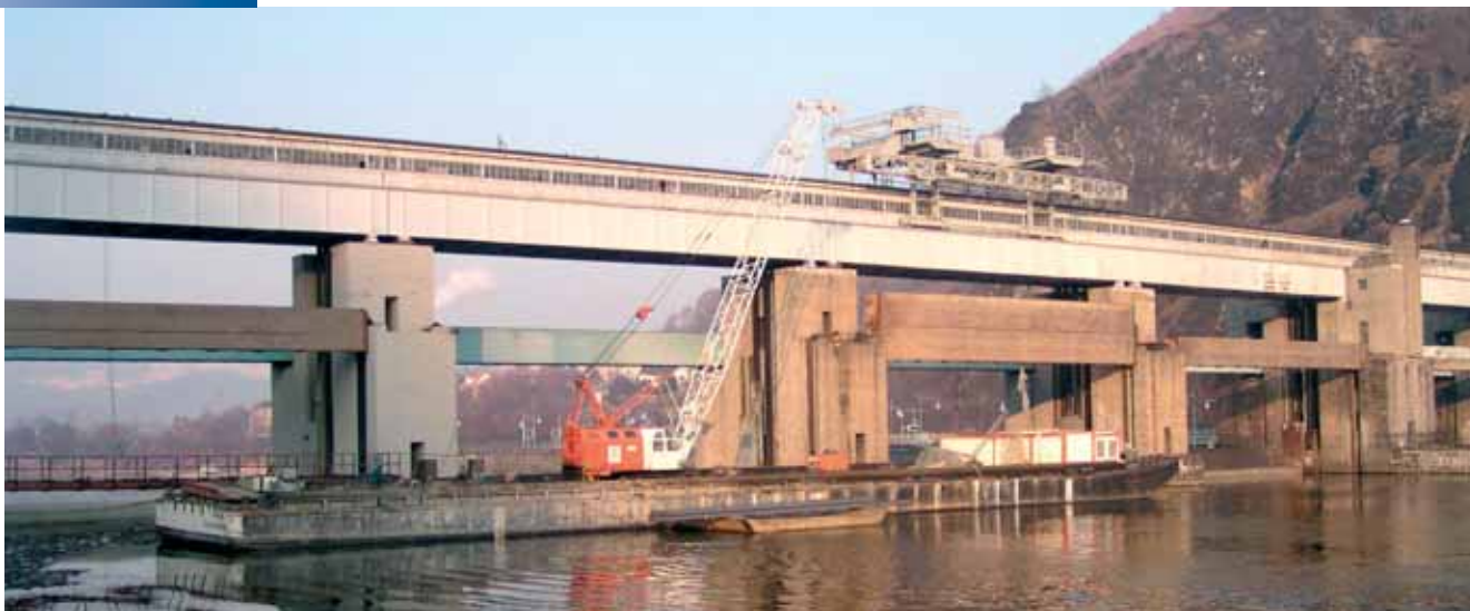
Stražení štětových stěn a následné práce na havarijním jímkování druhého jezového pole
