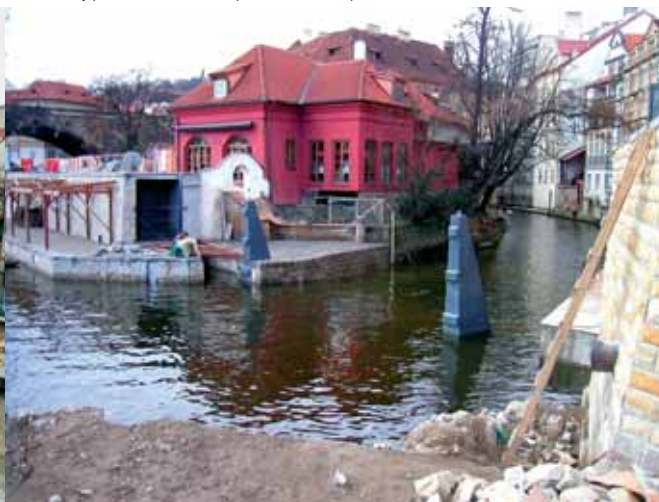
Ústí Čertovky po dokončení hlavních prací na stavbě posuvného uzávěru
