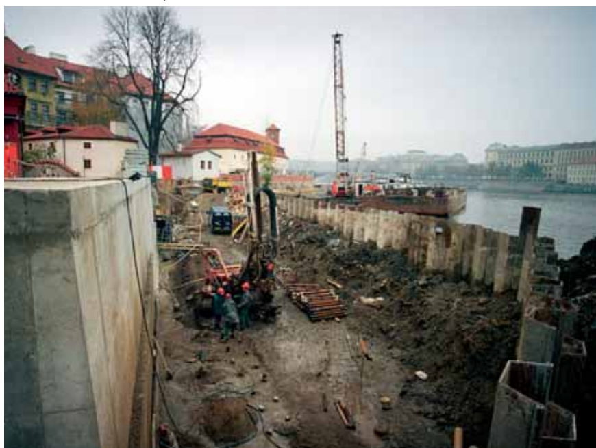
Zakládání nové nábrežní zdi na mikropilotách
