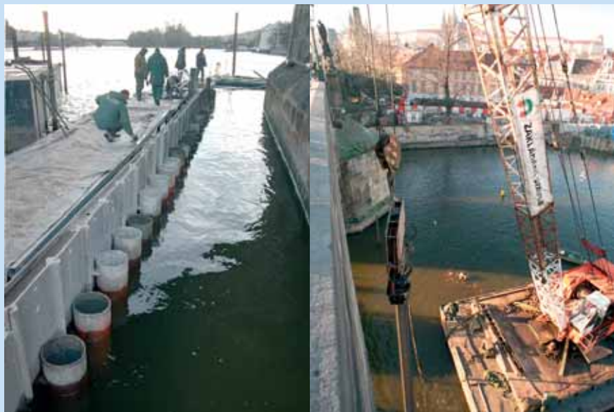
Zavrtané ocelové průchodky prům. 273/7 mm s osazenými panely z plochých štětovnic AS 500
