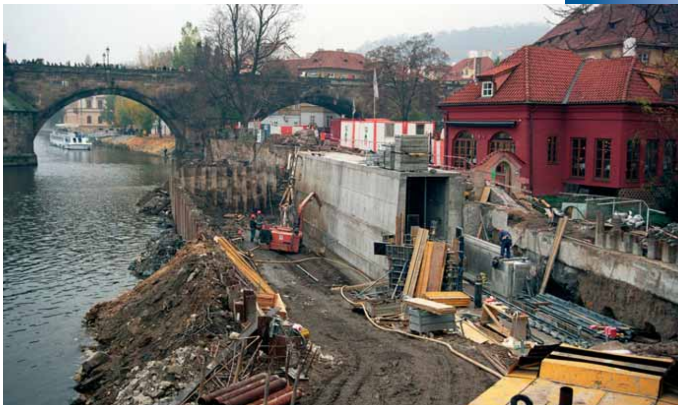
Železobetonová konstrukce „garáže“ pro posuvná vrata
