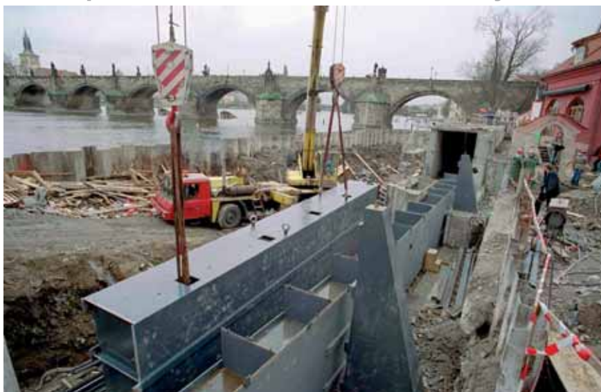
Montáž mobilního hrazení
