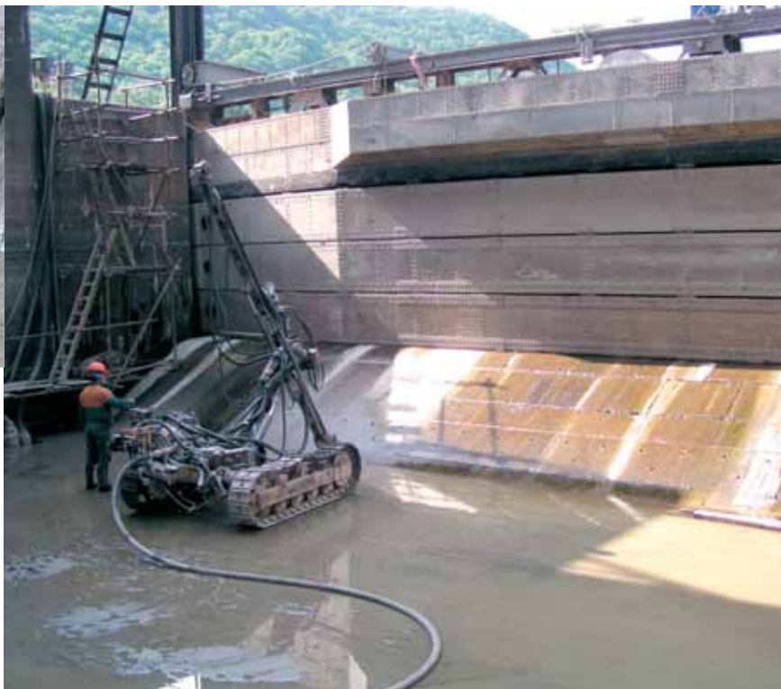
Hloubení vrtů pro sanační injektáž a pro následné kotvení kamenného obkladu
