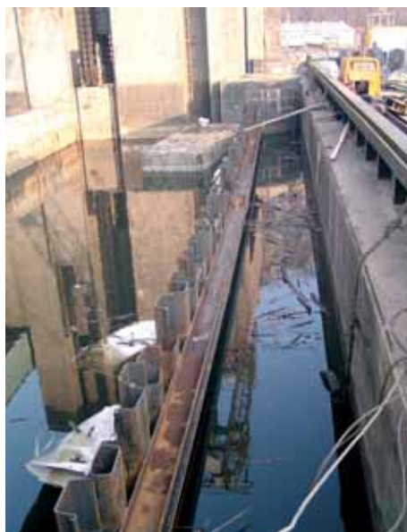
Štětová stěna před dokončením
