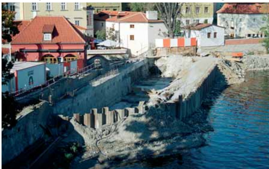
Vytěžená stavební jáma s obnaženými podzemními stěnami
