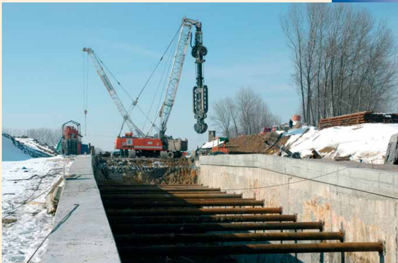
Pohled na úsek zárubních zdí (od Rudoltic) rozeptřených ocelovými troubami, v pozadí výroba podzemních stěn na objektu tunelu
