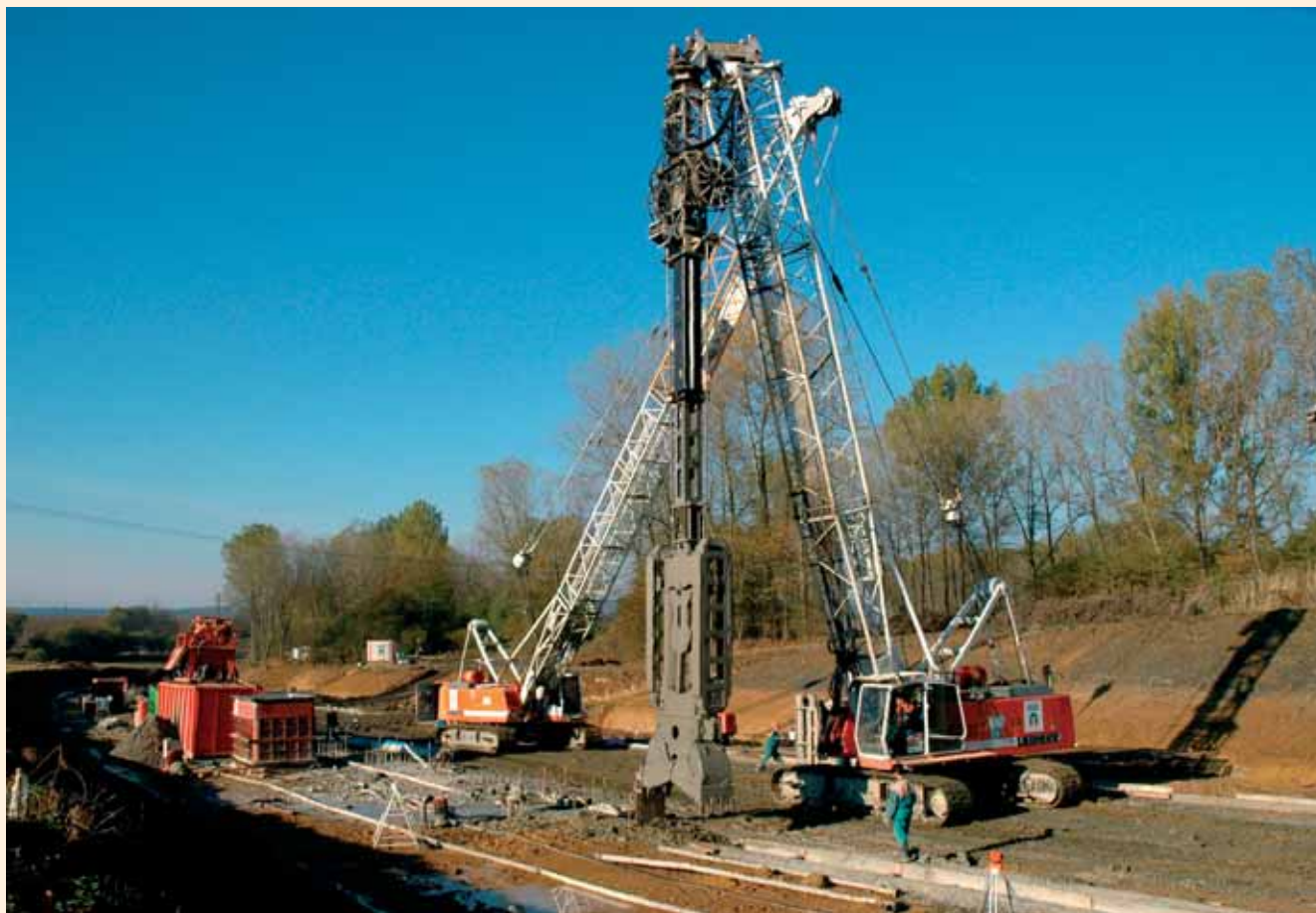
Těžba podzemních stěn zárubních zdí
