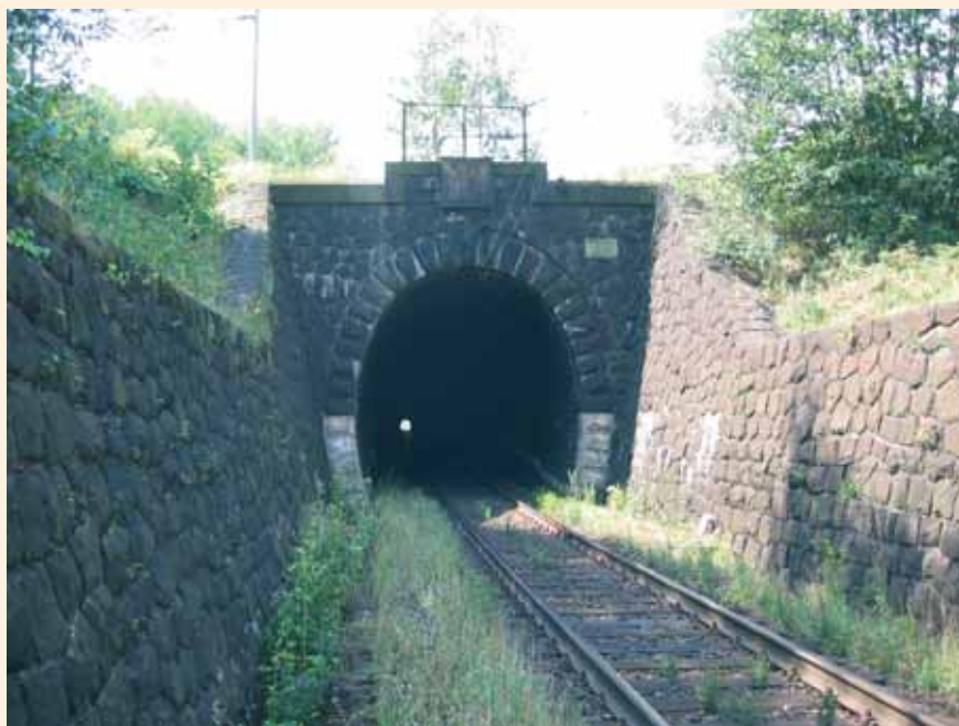
Obr. 8: Starý Třebovický tunel, stav z roku 2004
