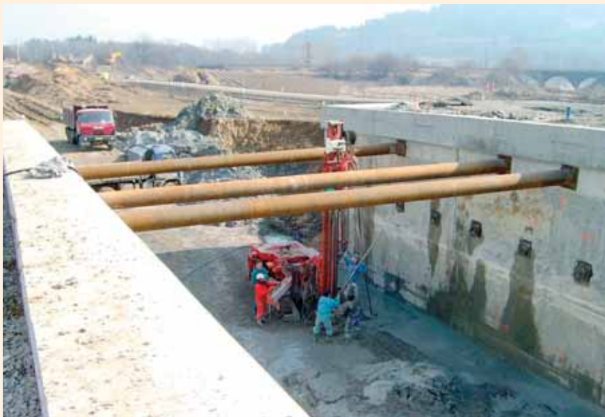
Provádění tryskové injektáže z úrovně základové spáry desky dna zářezu
