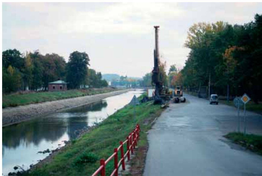
Hloubení vrtu V2 u plavebního kanálu v Tróji
