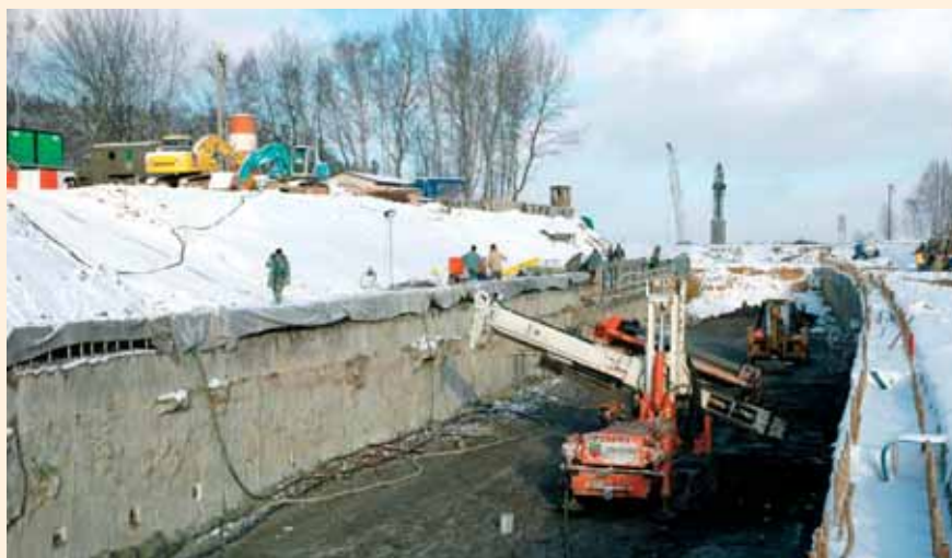
Provádění dočasných pramencových kotvěv v úseku obráceném ke Třebovicím
