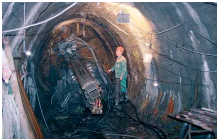
Vrtná souprava při hloubení vrtů pro mikropilotový deštník na čelbě průzkumné štoly
