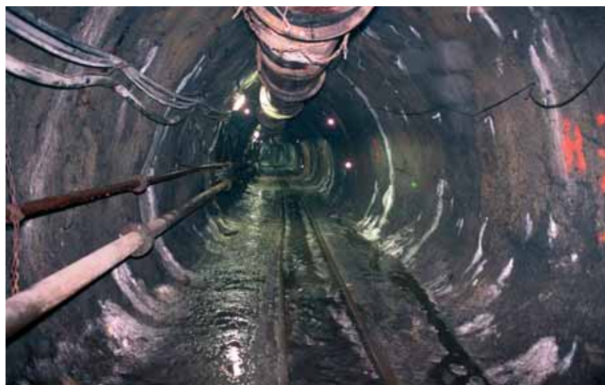
Pohled do průzkumné štoly
