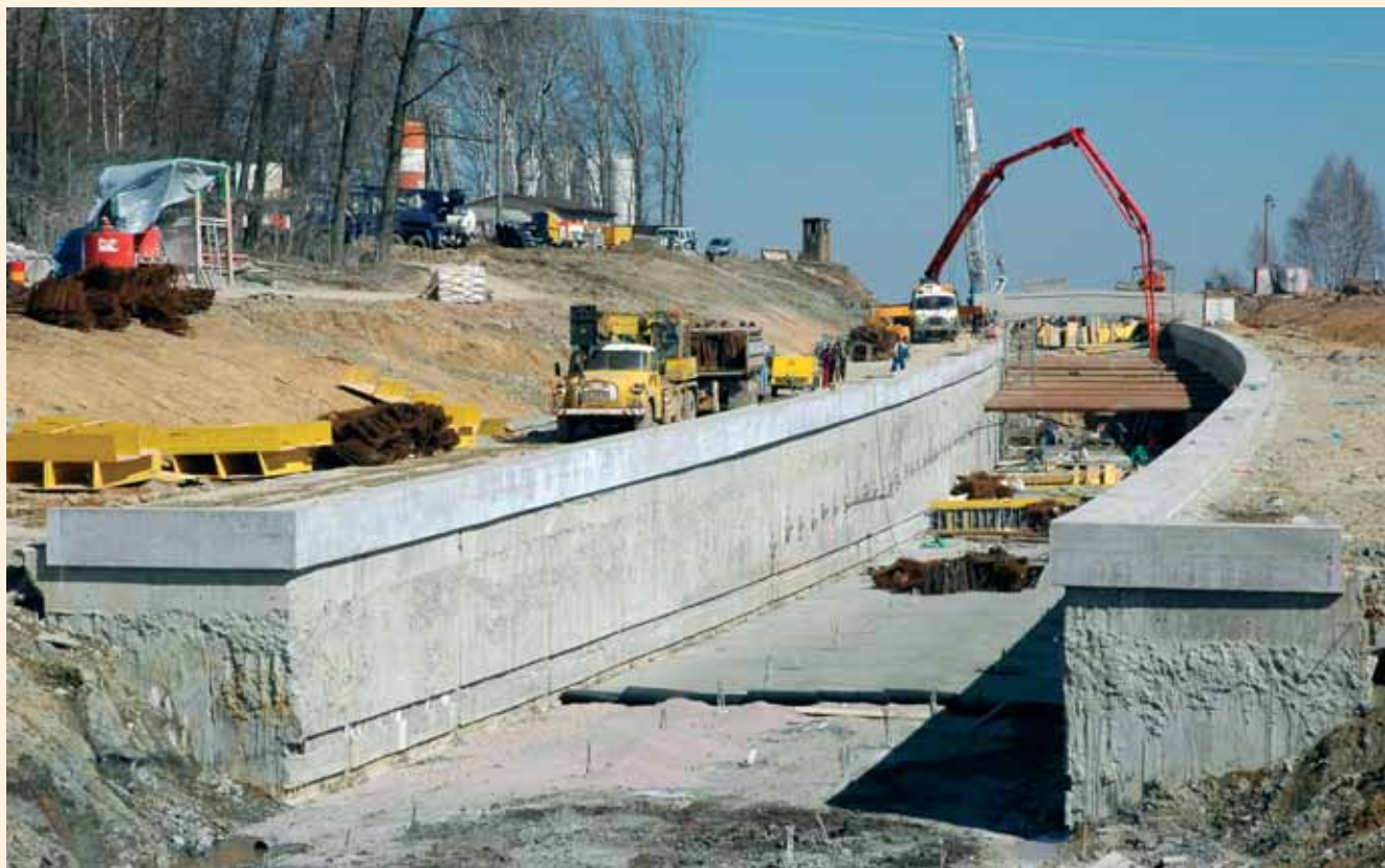
Celkový pohled na zárubní zdi (od Třebovic), v pozadí betonáž desky dna
