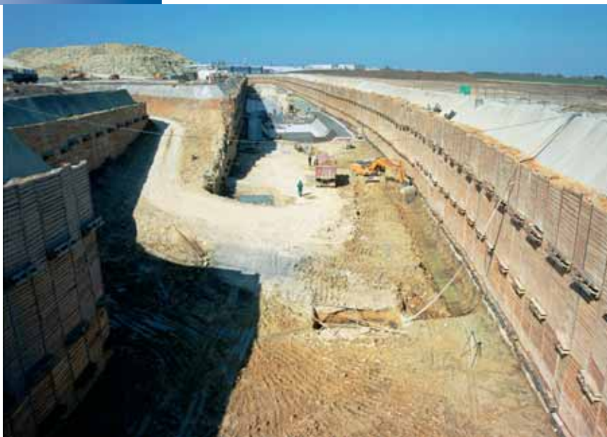
Stavební jáma stanice metra Letňany, pohled od portálu, vlevo je výjezdová rampa
