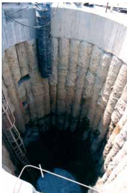
Převrtávané piloty na obvodu těžní a přístupové šachty Trója
