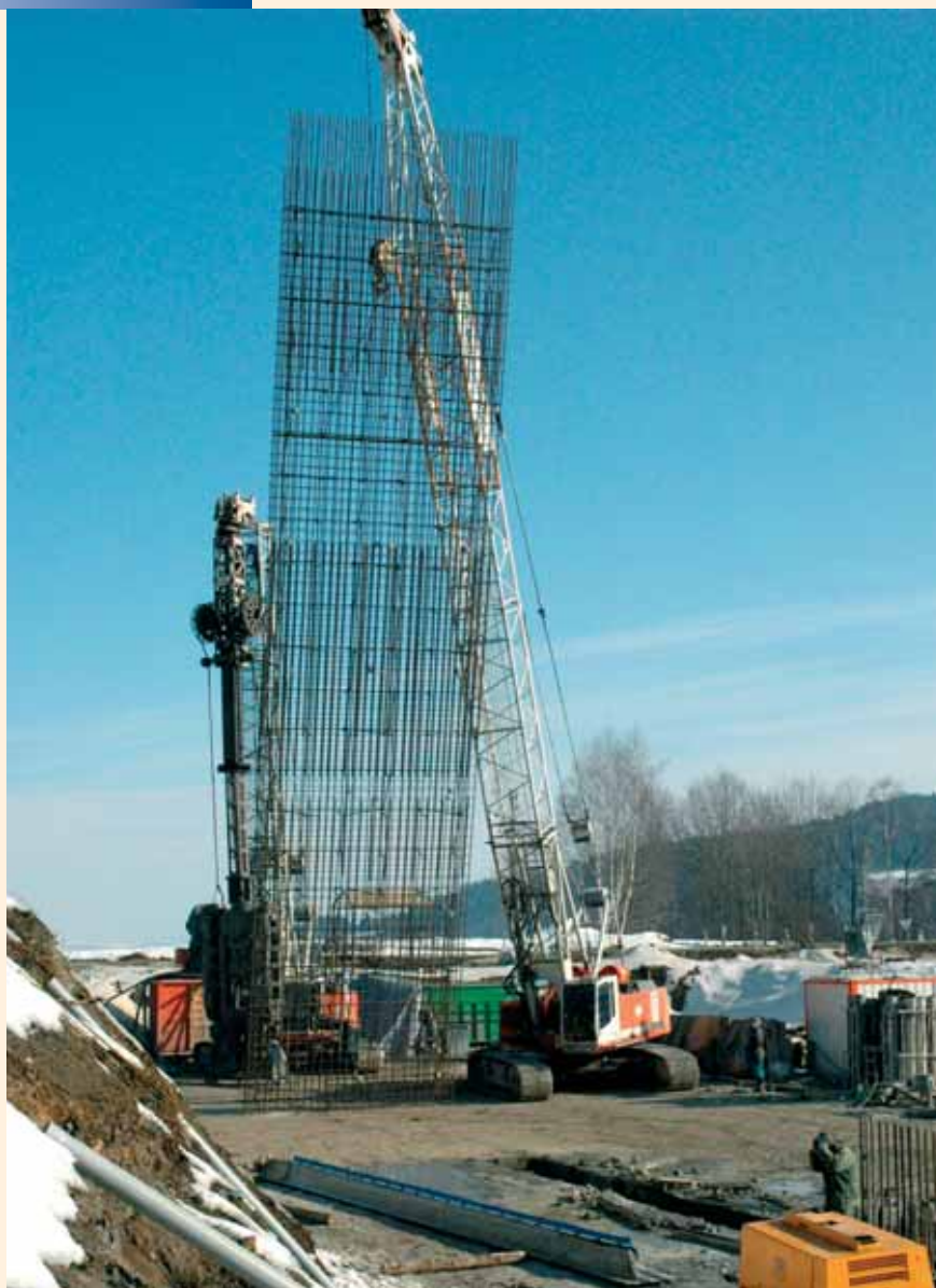
Osazování armokoše délky 24,6 m podzemní stěny konstrukce tunelu
