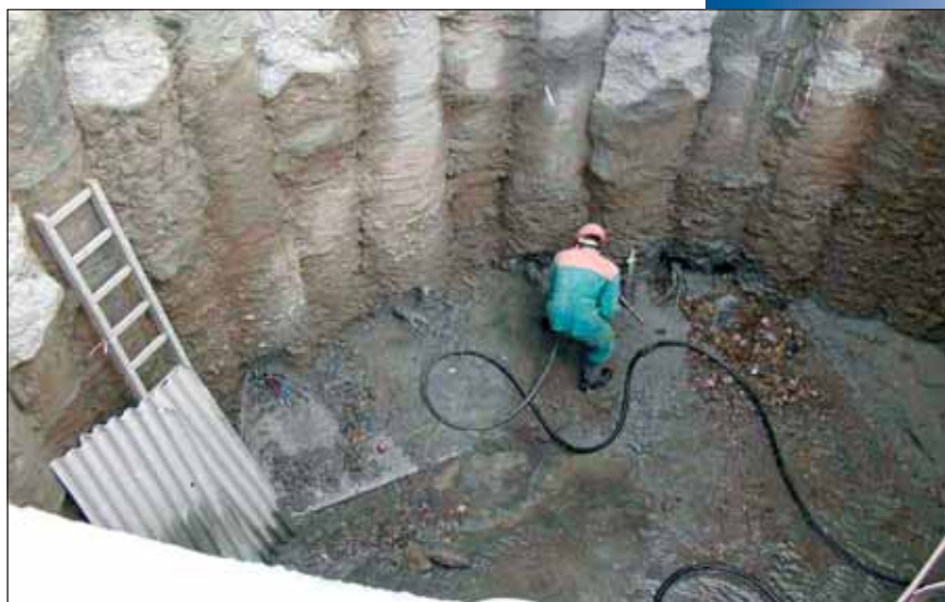
Kotvení v těžní šachtě Trója
