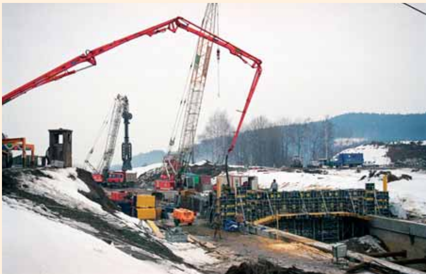
Betonáž portálu tunelu od Třebovic
