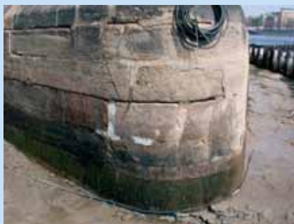
Obr. 4: Kamenická značka na špičce předního zhlaví pilíře č. 8, archiv Zemánek
