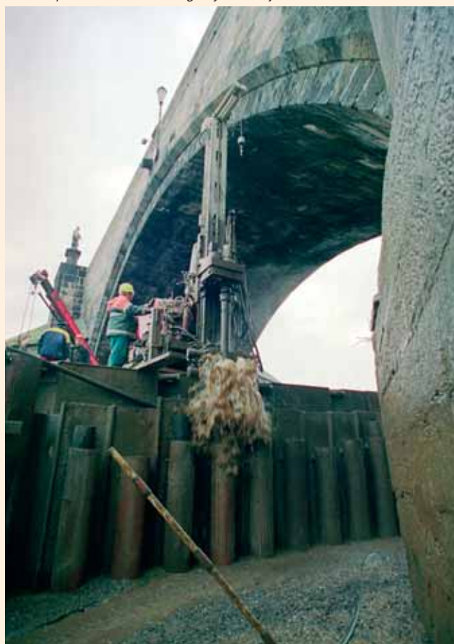
Dotěšňování přechodu mezi štětovou stěnou na špicích pilířů a ochrannou obálkou pod mostem technologií tryskové injektáže
