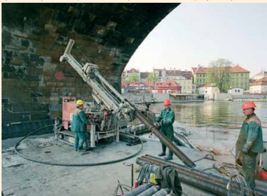
Výztužné trubky 194/10 mm před zavrtáváním systémem TUBEX do sloupů trykové injektáže
