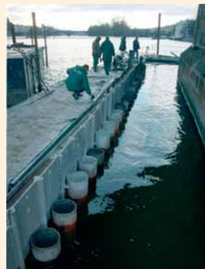
Zavibrované ploché štětovnice ARBED AS 500 s navařenými průchodkami 273/7 mm tvořily první část nově vytvářené ochranné obálky
