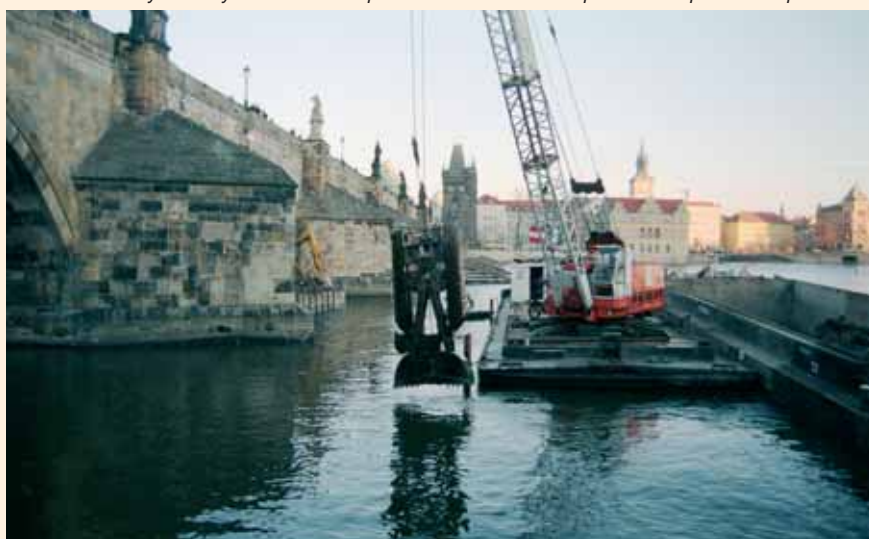
Odstraňování zbytků starých konstrukcí a prohlubování dna v okolí pilířů mostu pomocí drapaků
