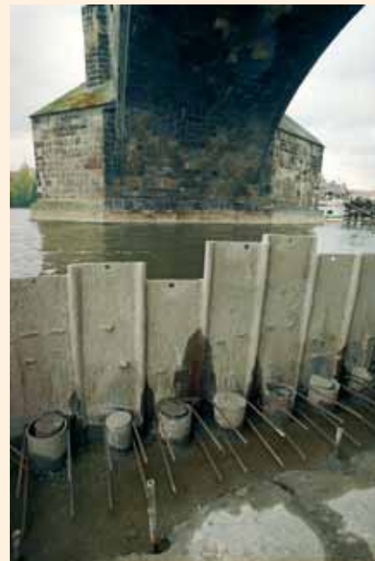
Dotěšňování přechodu mezi štětovou stěnou na špicích pilířů a ochrannou obálkou pod mostem technologií tryskové injektáže
