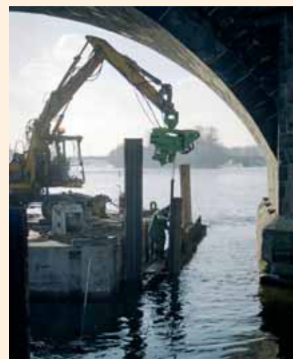
Zavibrované ploché štětovnice ARBED AS 500 s navařenými průchodkami 273/7 mm tvořily první část nově vytvářené ochranné obálky
