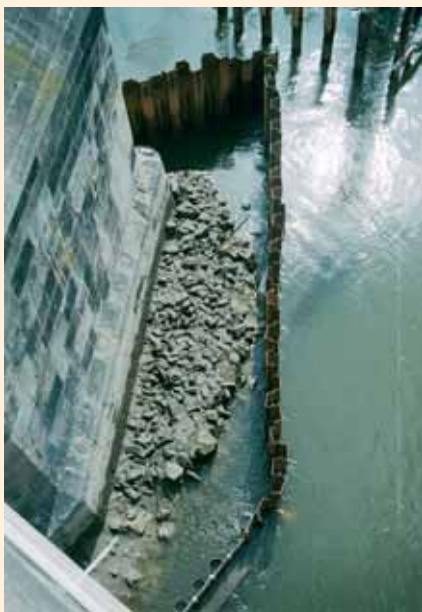
Uzavřená obálka ze štětovnic Larssen IIIIn v přední části pilíře po částečném vyčerpání
