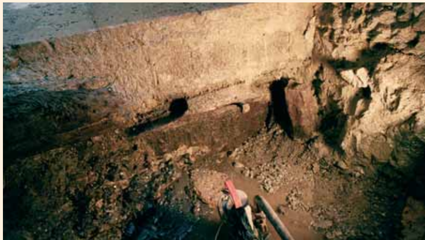
Obr. 3 a 4: Průzkumná sonda u pilíře č. 8 s pohledem na „konzolu“ a dřevěnou špuntovnici
