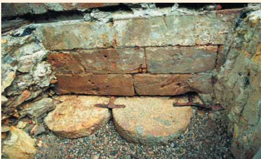
Obr. 5 a 6: Průzkumná sonda u pilíře č. 9 s „otesky“ mlýnských kamenů, které tvořily základovou spáru tohoto pilíře
