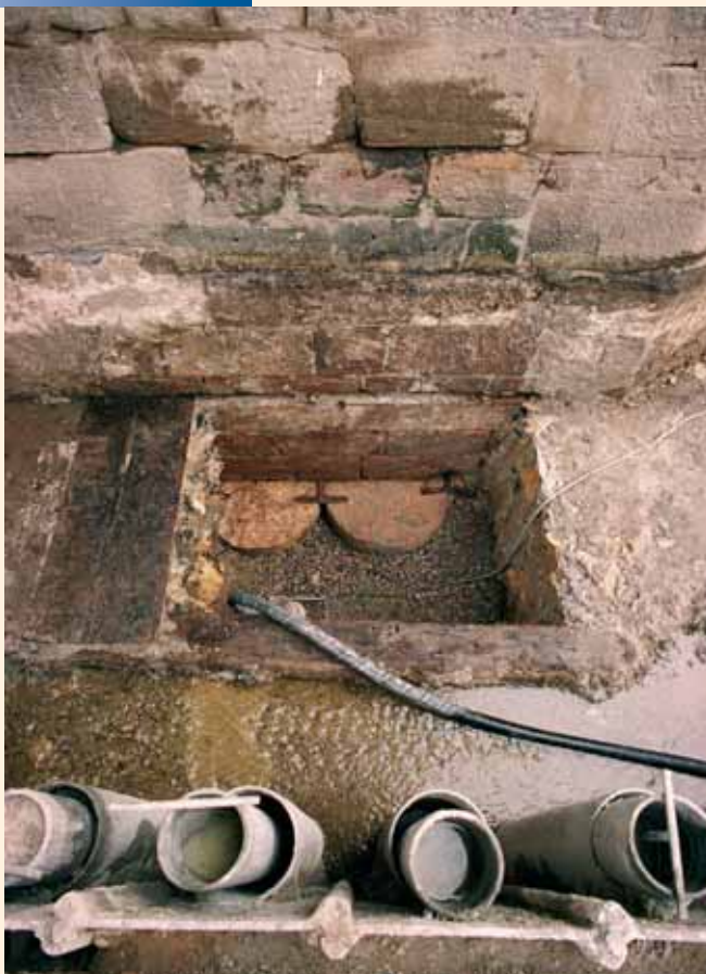
Kopaná archeologická sonda v zapažené jímce pro průzkum základů pilíře č. 9 s obnaženými mlýnskými kameny
