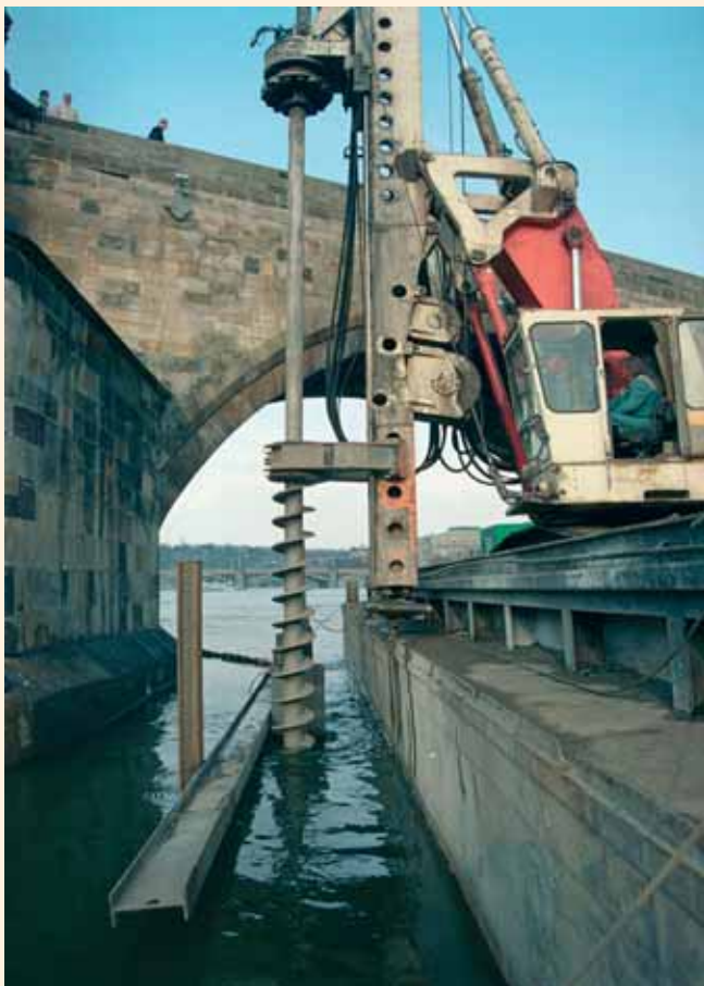
Uzavřená obálka ze štětovnic Larssen IIIIn v přední části pilíře po částečném vyčerpání
