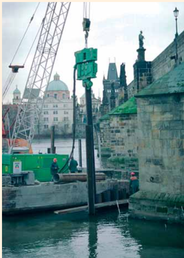
Výztužné trubky 194/10 mm před zavrtáváním systémem TUBEX do sloupů trykové injektáže
