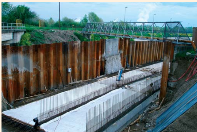
Trysková injektáž byla využita na stavbě záhřebské kanalizace i v místech křížení s inženýrskými sítěmi.
