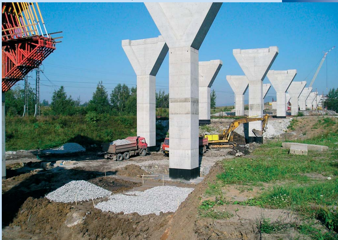
Realizované mostní pilíře
