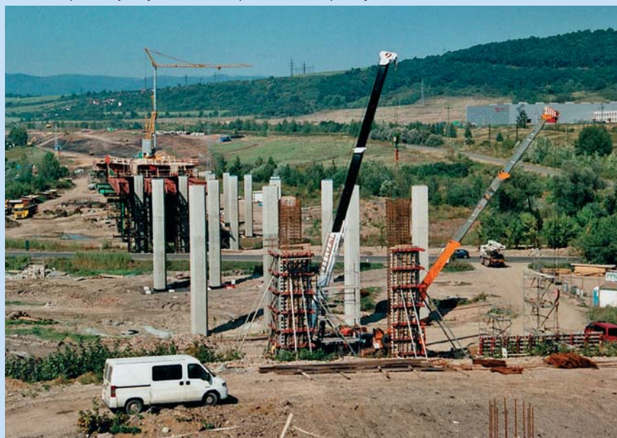
Pohled na pokračující výstavbu mostu přes Ždírnické potoky
