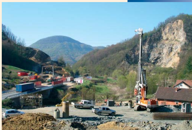
Na stavbě dálnice Zagreb–Macej se společnost Zakladani staveb, d. o. o. podílela na založení čtyřech mostních objektů.
