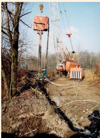
Tenká těsnicí stěna byla realizována v patě návodní strany hráze
