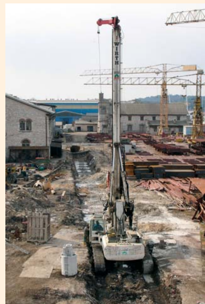
Výroba pilot pro založení jeřábové dráhy v loděnici Uljanik v Pule.
