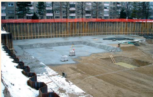
Zagreb Tower – stavební jáma po výkopu na základovou spáru
