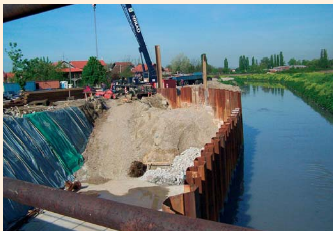
Štětová stěna v místě křížení budoucího kanálu v Záhřebu se železničním mostem
