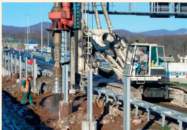
Vrtání pilot pro založení protihlukové stěny na dálnici Zagreb–Split
