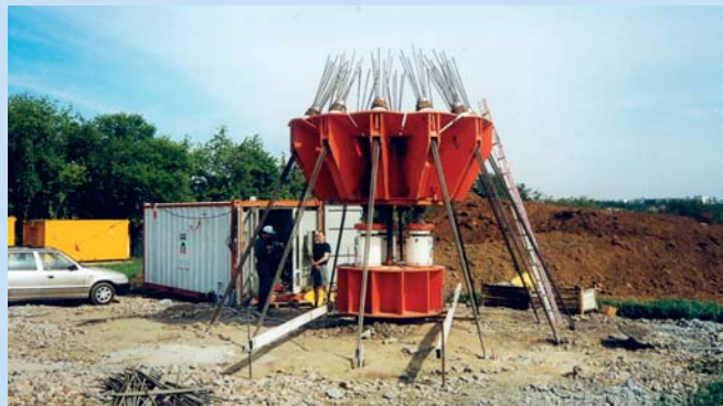
Zkušební ocelový most při statické zatěžovací zkoušce piloty
