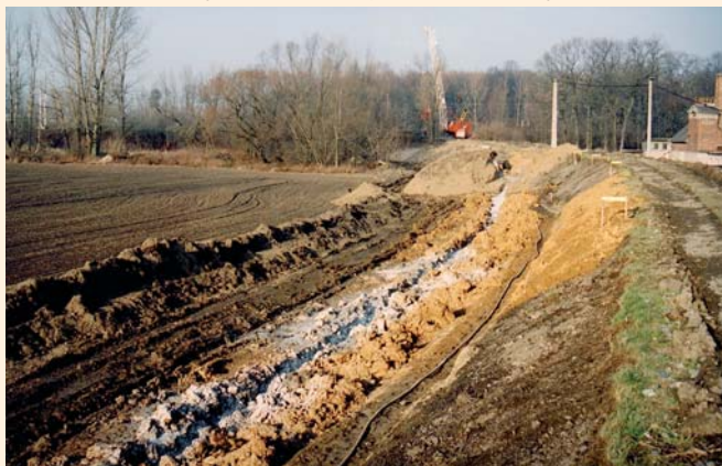
Tenká těsnicí stěna byla realizována v patě návodní strany hráze
