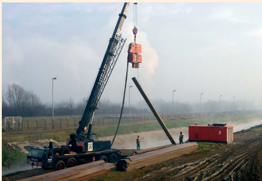
Beranění štetovnic pro zajištění výkopu při výstavbě nového kanalizačního systému v Záhřebu
