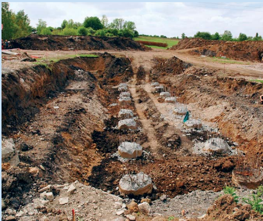
Pilotový základ typického mostního pilíře, hlavy pilot před odbouráním
