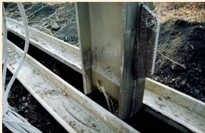
Pro usměrnění vibrovaného I-profilu byla používána vodící šablona
