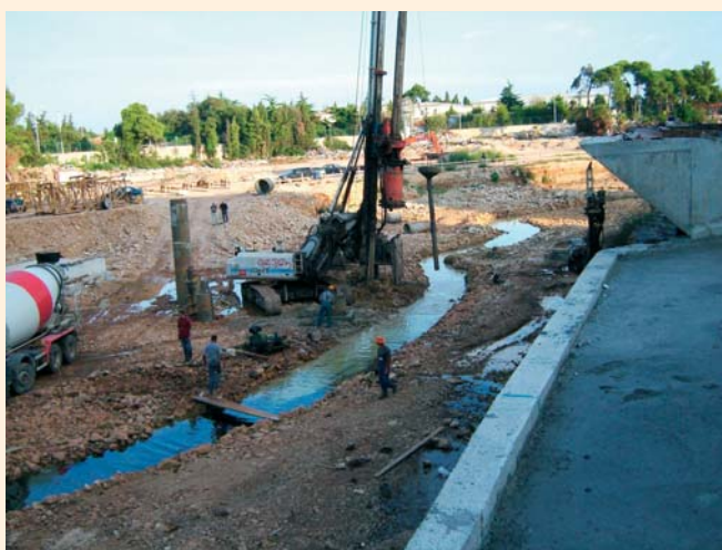
Při vrtání pilot pro založení obchodně-obytného komplexu v Zadaru vyvěrá podzemní voda přímo na úrovni pracovní plochy.
