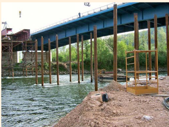
Zaprešić – beraněné dočasné ocelové podpory pro montáž ocelového dálničního mostu přes řeku Sávu.
