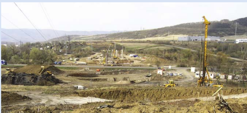
Pohled na místo provádění geofyzikálního průzkumu v oblasti zakládání mostů přes Ždírnické potoky
