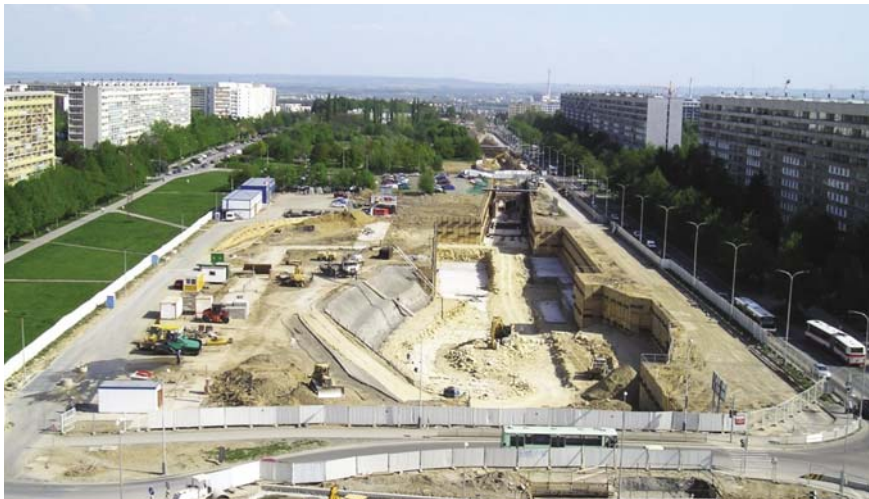
SO 10, dokončené záporové pažení stavební jámy stanice Střížkov
