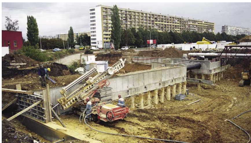
SO 09, vrtání kotev 1. kotvení úrovně při postupném provádění výkopových prací
