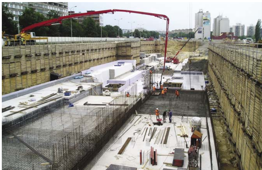
Provádění první fáze konstrukcí v prostoru budoucího kolejiště
