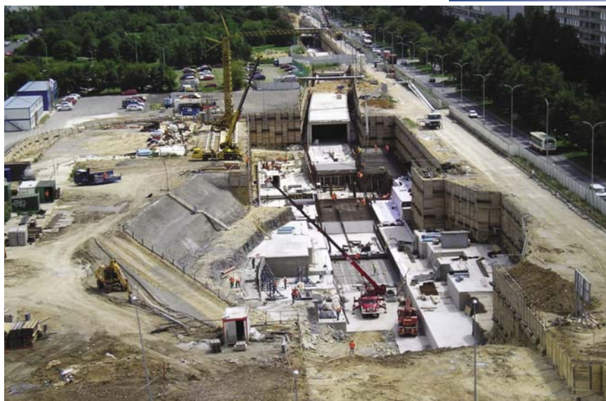
Celkový pohled na stavbu v průběhu betonáže základových konstrukcí
