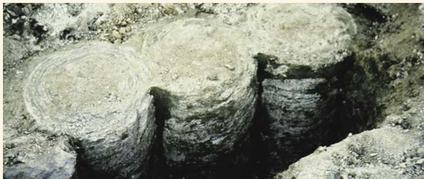
Částečně obnažené vápenné pilíře
