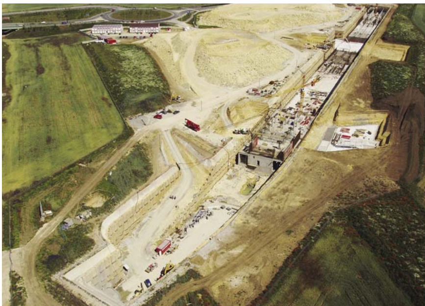
Letecký pohled na rozsáhlou stavební jámu v průběhu výstavby
