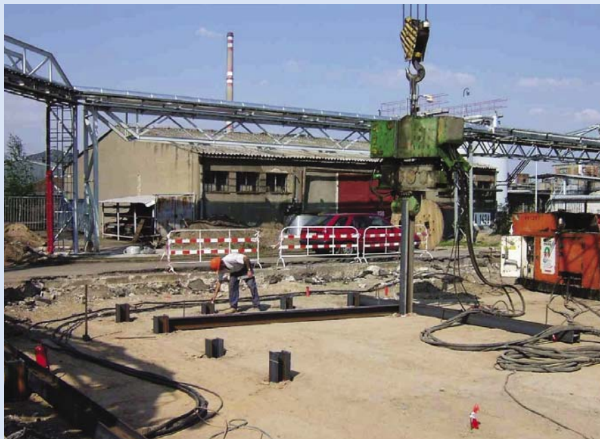
Beranění pilot pod plošnými základy haly
