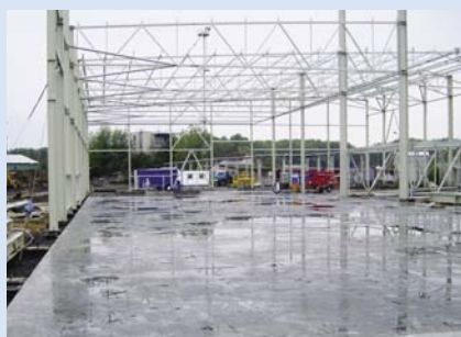
Dokončená drátkobetonová podlaha se vsypem
