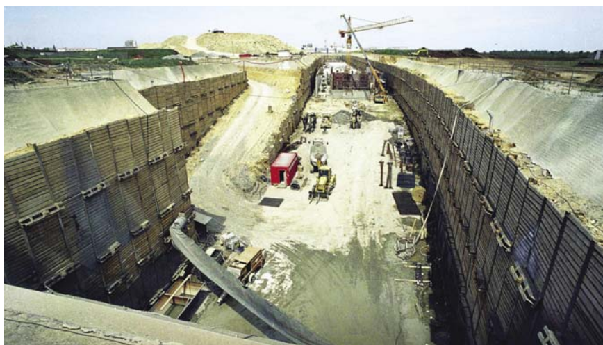
Stavební jáma pro stanici Letňany SO 14 s provizorní sjezdovou rampou
