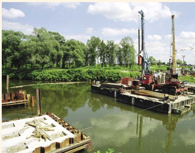
Dálnice D47 v úseku Hrušov–Bohumín Štěťové jímky a základové piloty na objektu estakády přes odru a Antošovické jezero.
