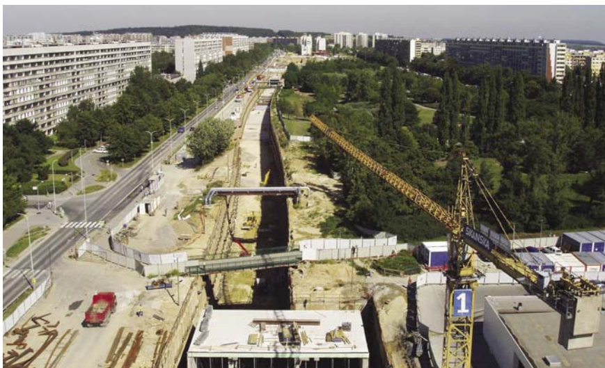
Celkový pohled na otevřenou stavební jámu SO 11 v délce 794 m
