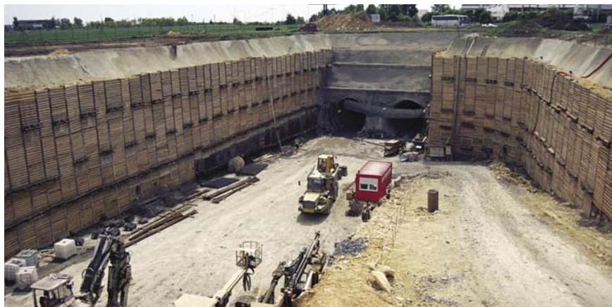
Stanice Letňany – SO 14, pohled na portál tratového tunelu stavebního úseku 13 (Prosek–Letňany)
