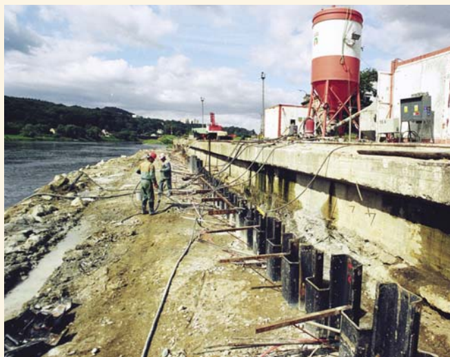
Přístav Ústí nad Labem – Ganza Prodloužení přístavní zdi pomocí trvalé štěťové stěny osazované do předhrabané rýhy a kotvené trvalými 6ti pramencovými kotvami.
