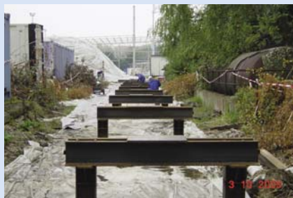
Dvojice pilot s U-profilu pro založení ocelové konstrukce haly
