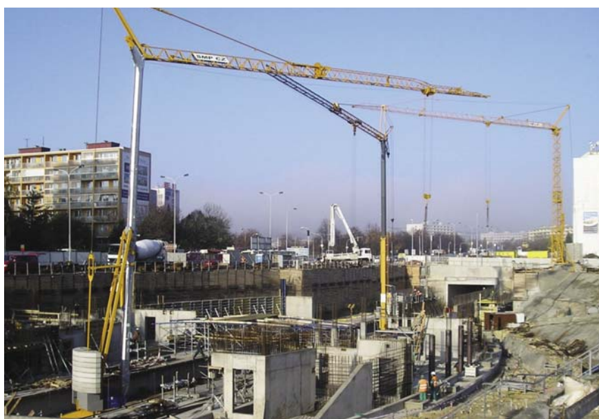
Zárodky konstrukcí žlb. interiérových lávek přes kolejiště
