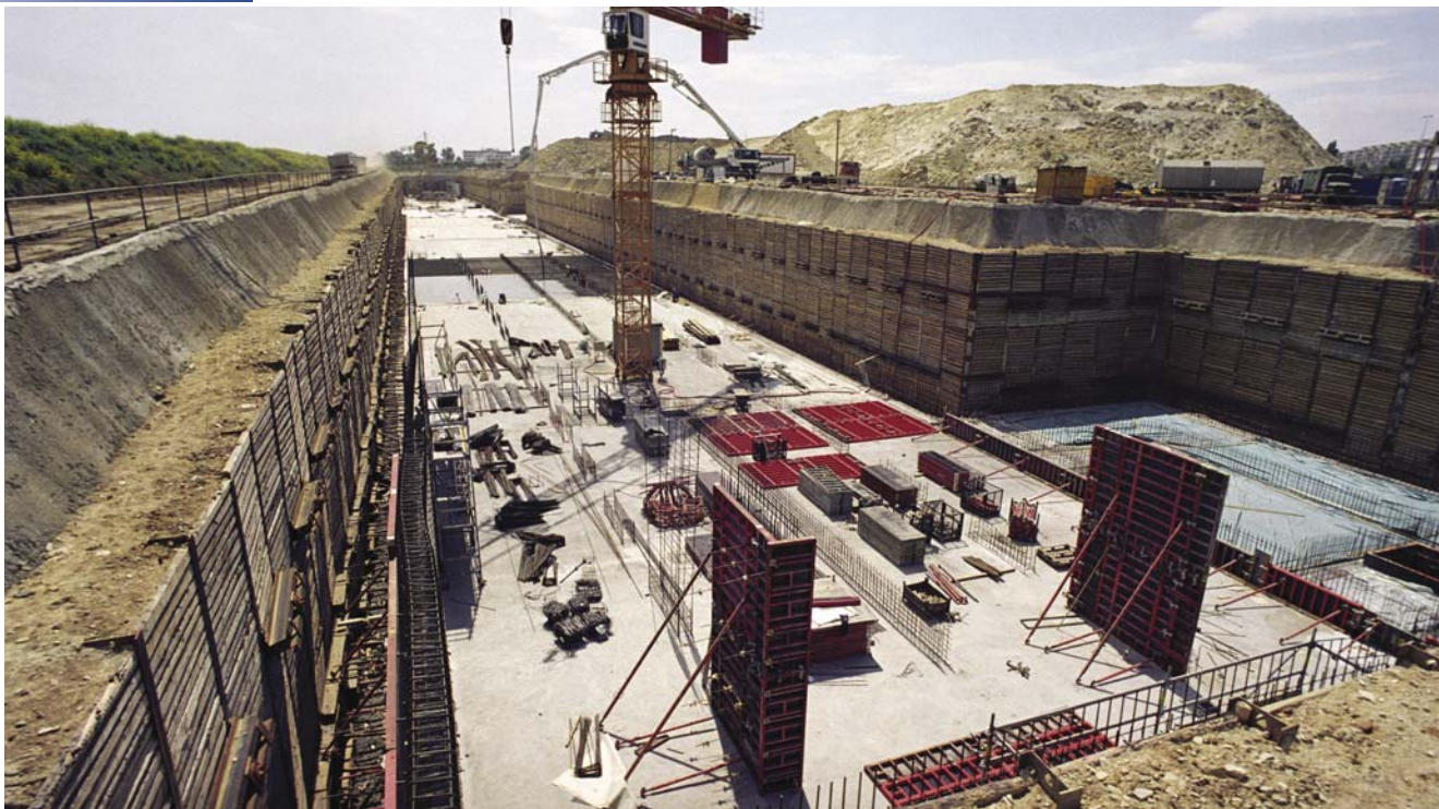
V dokončené stavební jámě začíná okamžitě proudově vyrůst objekt stanice
