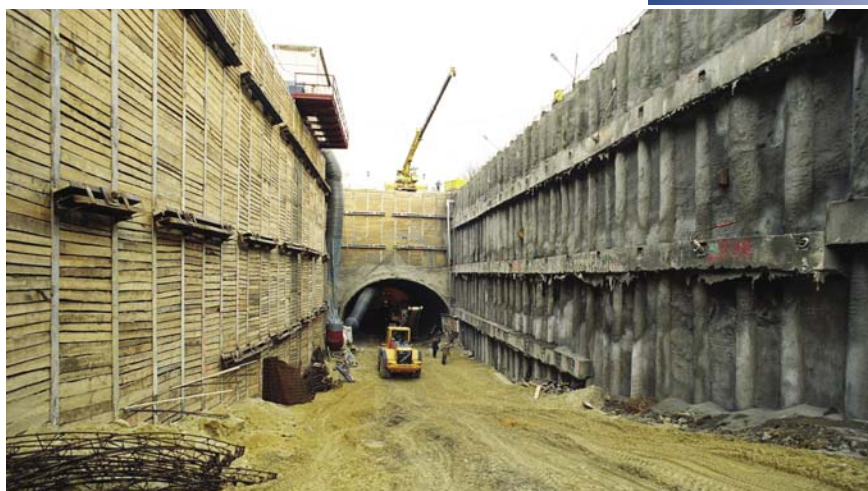
SO 08, pohled do otevřené jámy směrem k portálu traťového tunelu
