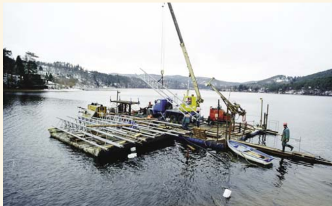
Zřízení kotevnicí dalb pro plovoucí molo na Slapské přehradě Osazování příhradové konstrukce jedné z dalb plovoucího mola na mikropilotový základ.
