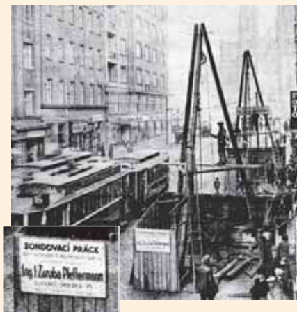
Sondovací práce pro II. železniční tunel na Vinohradech (1933), přetisk z přílohy Českého slova 2. 9. 1933
