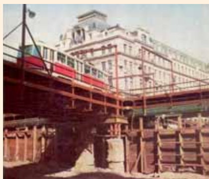
Stavba podchodu na Václavském náměstí v Praze (1967)
