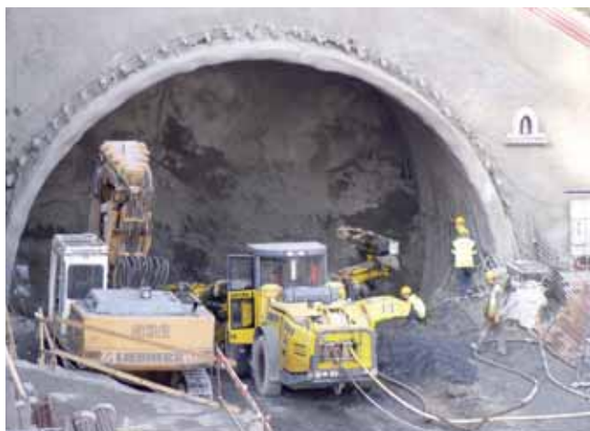
Obr. 8, 9: Portály tunelů vznikly velkými odřezy skalních stěn svahu Vítkov; zajištěny jsou horninovými kotvami v kombinaci s mikropilotami a armovaným stříkaným betonem.
