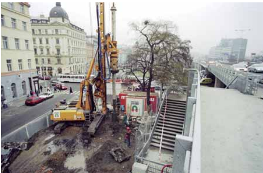
Vrtná souprava Bauer BG 24 H při hloubení vrtu pro pilotu.
