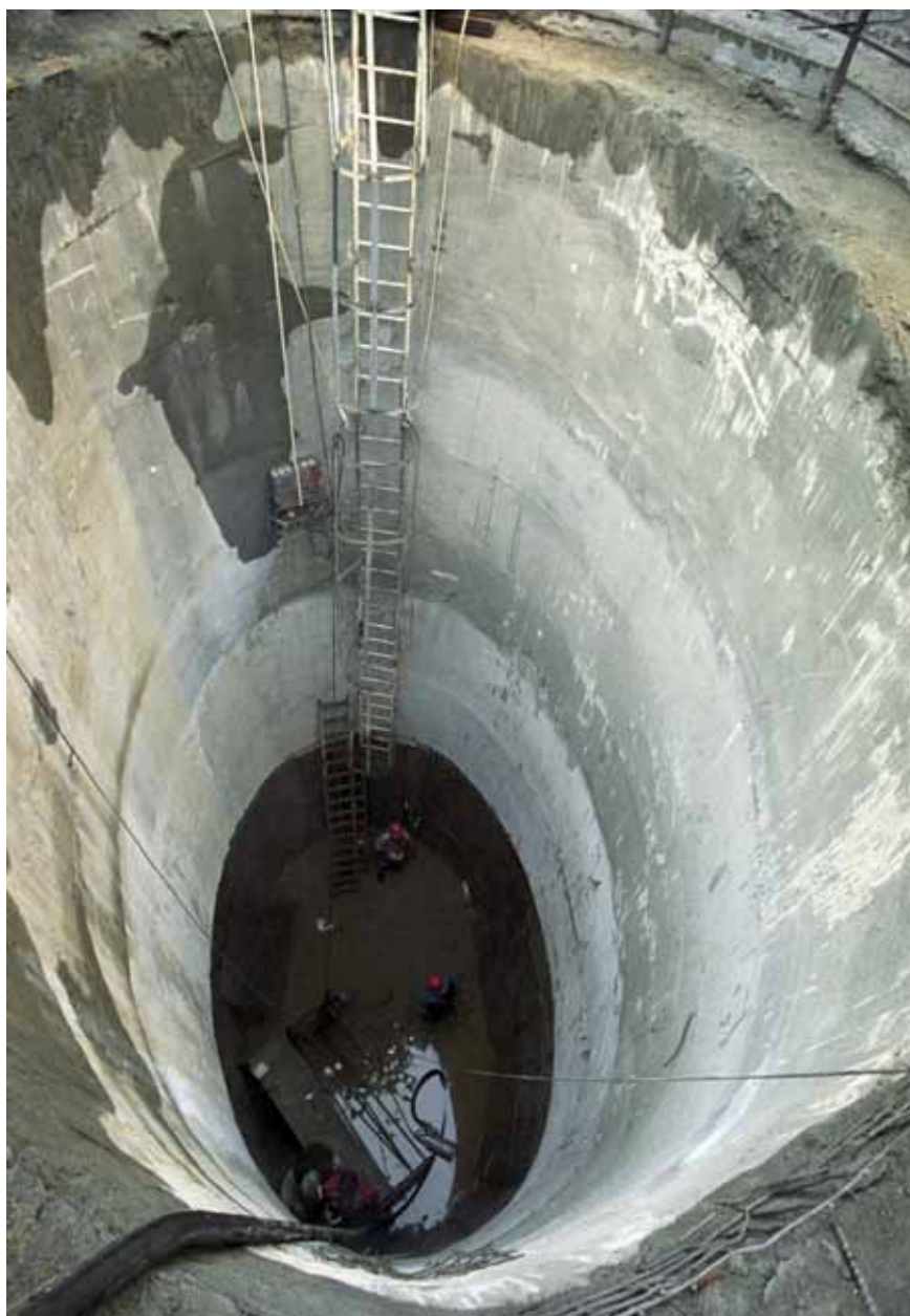
Pohled do šachty s upraveným lícem ostění ze stříkaného betonu
