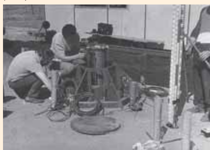
Výzkum v rámci státního úkolu „Srovnávání deformací základové půdy s předpoklady průzkumu“, instrumentace zkušebního základu hloubkovými měřidly sedání a snímači kontaktního napětí (1972)
