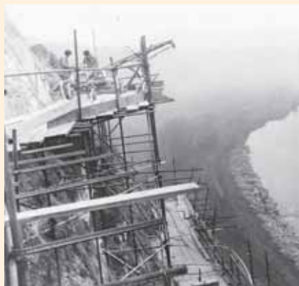
Tetín, zabezpečování skalního svahu kotvením (1972)
