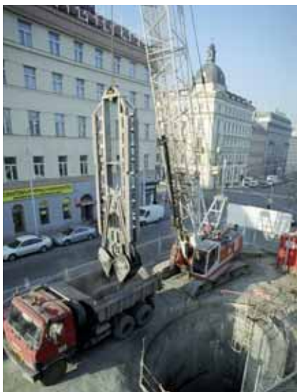
Pohled na staveniště v průběhu hloubení šachty.
