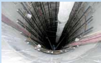
Obr. 1: Pohled do zapaženého a osazeného vrtu piloty. Kolona sypákových rour je připravena na betonáž pod vodou.
