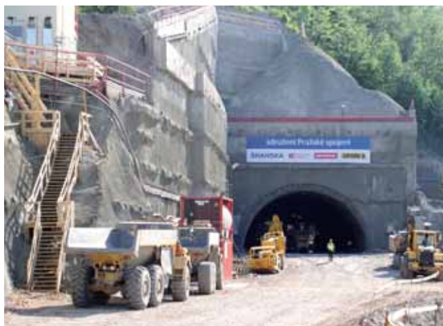
Obr. 8, 9: Portály tunelů vznikly velkými odřezy skalních stěn svahu Vítkov; zajištěny jsou horninovými kotvami v kombinaci s mikropilotami a armovaným stříkaným betonem.
