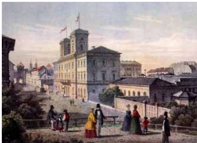
Obr. 2: Budovy dnešního Masarykova nádraží postavené v roce 1845 na dobové kresbě (Karel Würbs)
