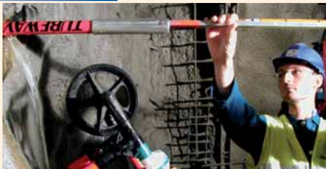
Georadarový průzkum horninového masivu před čelbou tunelu pomocí směrově orientované antény do vrtu (2003)
