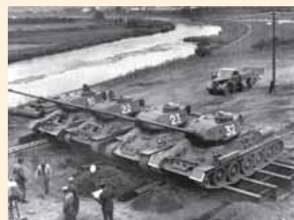
Zatěžovací zkouška v Lahovicích (1961)
