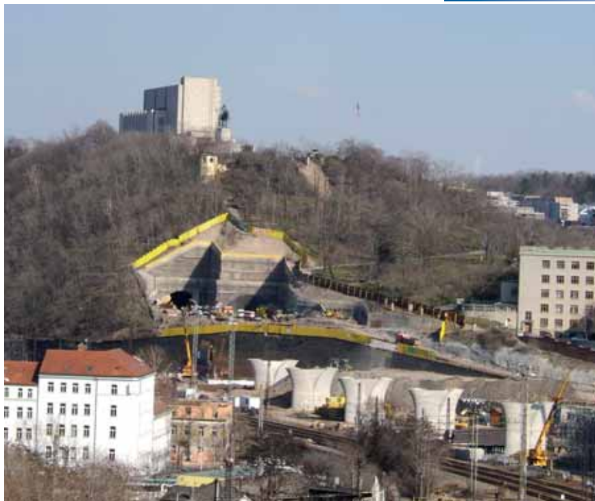
Obr. 6: Fotografie západního portálu tunelu Nového spojení pod vrchem Vítkov se vznikající železniční estakádou (březen 2006)
