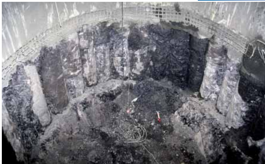
Převrtávaná pilotová stěna přecházející do skalního položí v hloubce cca 18m pod povrchem.
