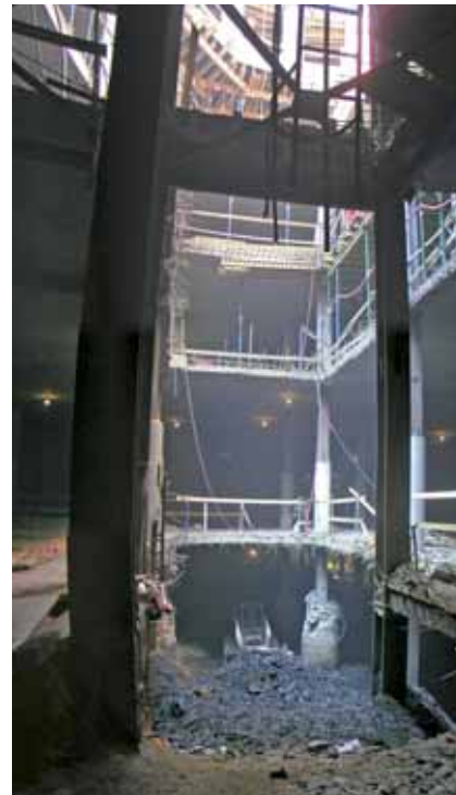
Ponechaný otvor ve stropních deskách pro těžbu zeminy umožnil nevšední pohled na pět rozestavěných stropních desek
