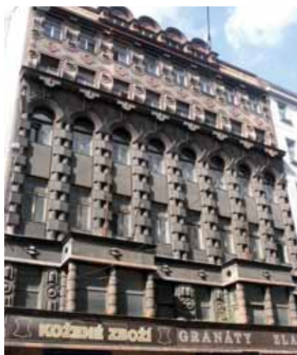
Kubistická a rondokubistická fasáda staré budovy „U Myšáka“ do Vodičkovy ulice
