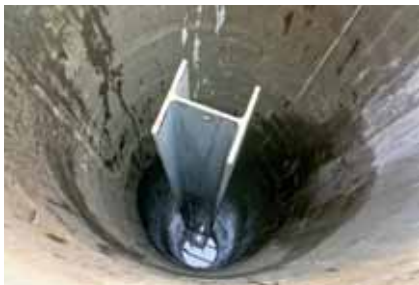
Sloup HEB den po betonáži, těsně před zpětným zásypem
