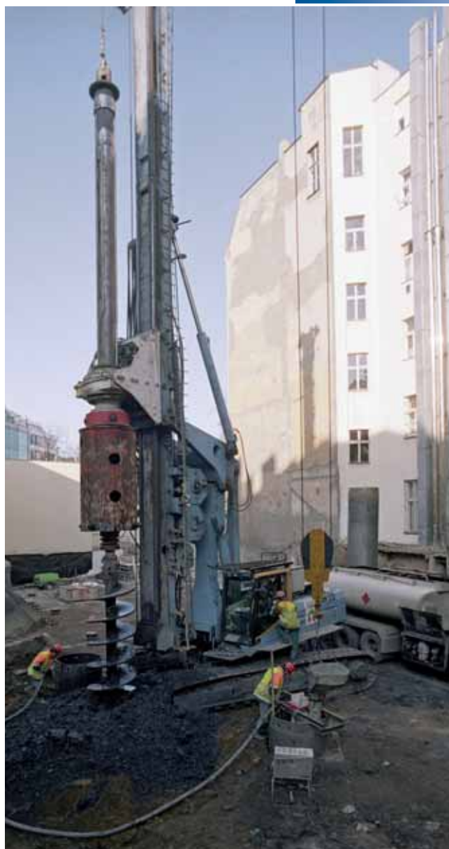
Vrtná souprava při hloubení vrtu průměru 1200 mm pro osazení ocelového sloupu
