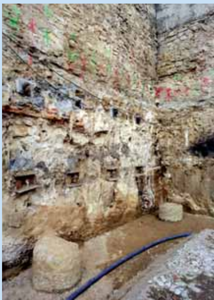
Trysková injektáž u objektu 304 kotvená ve dvou úrovních tyčovými kotvami
