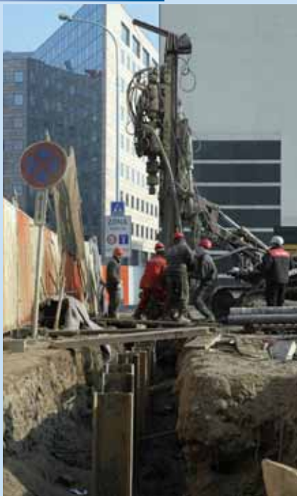
Hloubení vrtů pro osazení zápor podél ulice Pobřežní z předvýkopu pro obnažení inženýrských sítí
