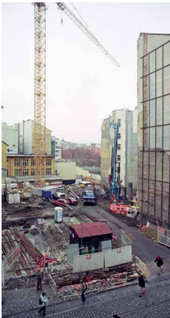
Staveniště během těžby podzemních stěn a hloubení vrtů
