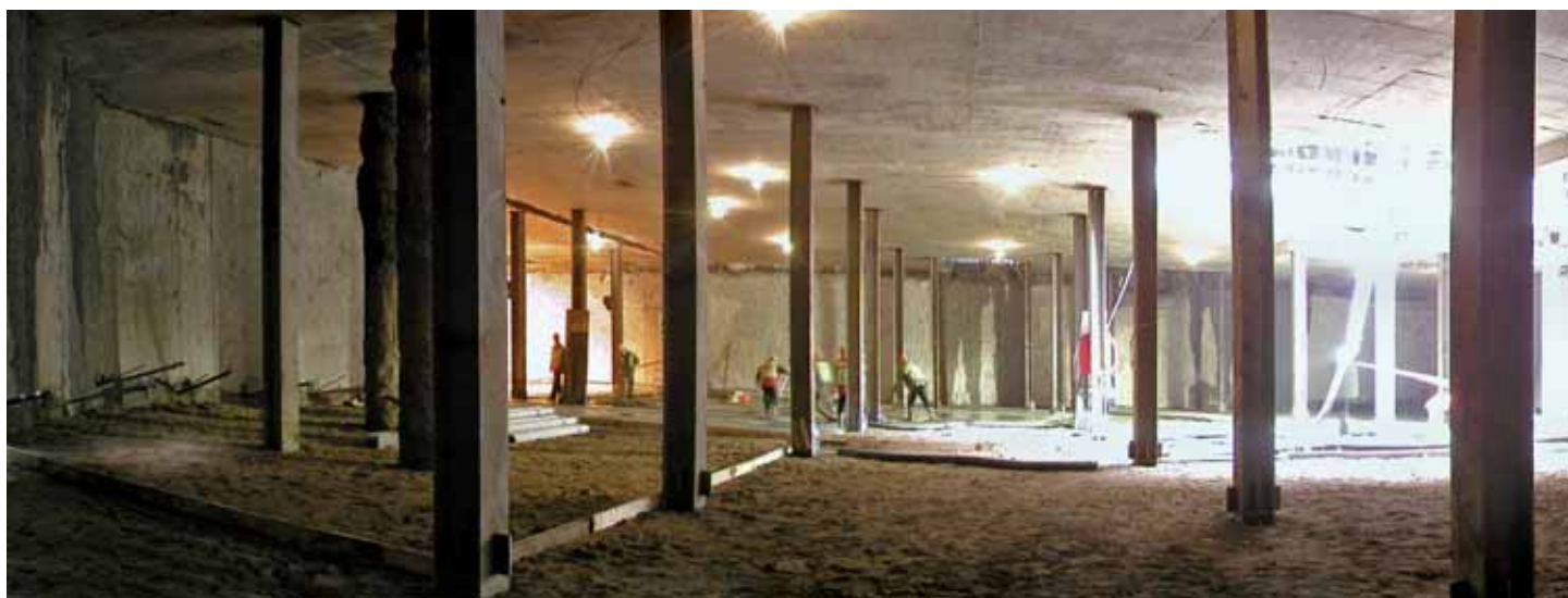
Panoramatický pohled do suterénu v úrovni 3. PP s oštrými podzemními stěnami, v zadní části probíhá pokládka podkladních betonů pro stropní desku 4.PP
