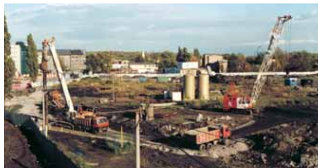
Zakládání staveb, a. s., se na sanaci areálu Karolina podílela realizací podzemních stěn po celém obvodu lokality
