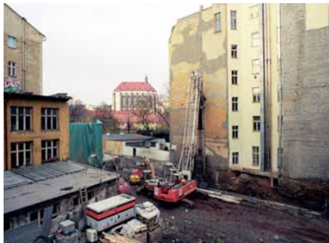
Hloubení monolitických podzemních konstrukčních stěn
