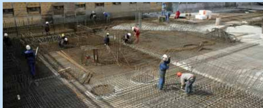
Vyarmovaná základová deska zesílená nad tubusy metra před betonáží
