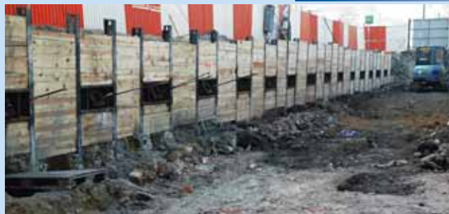
Pohled na záporové pažení se zapuštěnými kotevními převázkami
