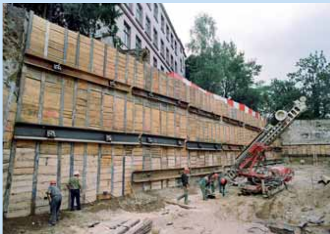
Osazení kotev 3. KÚ pažení podél obchodní akademie
