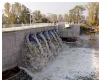
Zkouška čerpací stanice po jejím dokončení
