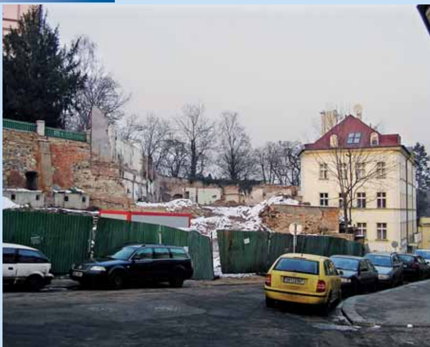
Pohled na staveniště po částečné demolici původní zástavby
