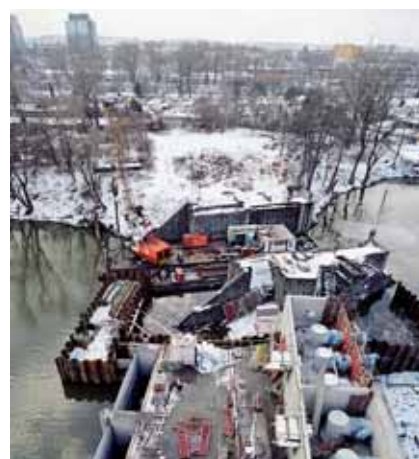
Vznikající konstrukce čerpací stanice a protipovodňových vrat Libeňských přístavů
