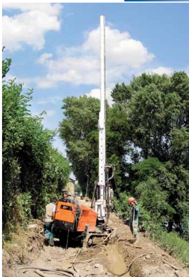
Provádění těsnicí clony tryskovou injektáží
