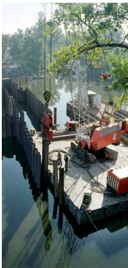
Beranění jímky z pontonového soulodí
