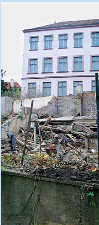
Zahájení bouracích prací
