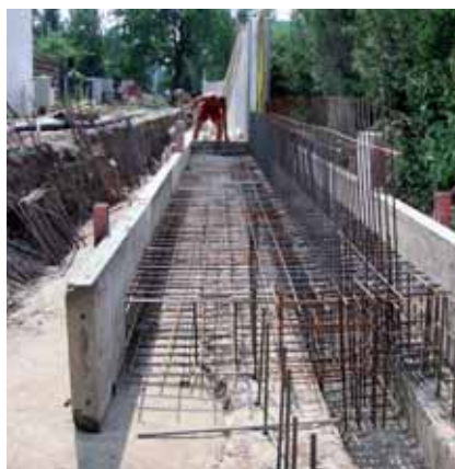
Armatura protipovodňové zídky nasazená na TPS
