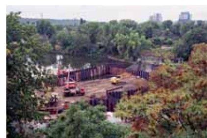
Beranění jímky pro čerpací stanici
