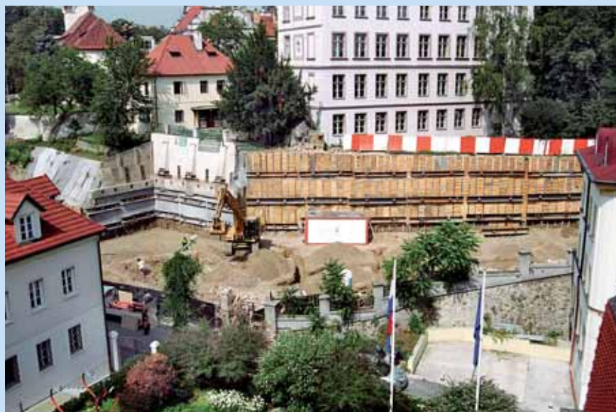
Pohled na stavební jámu před dotěžením
