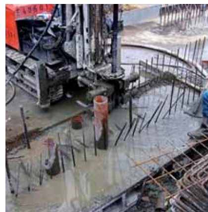
Provádění těsnicí tryskové injektáže
