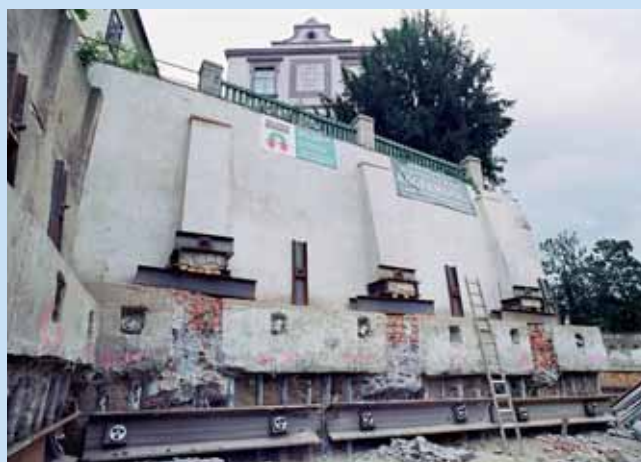
Ponechaná opěrná zeď s původním mikrozáporovým pažením
