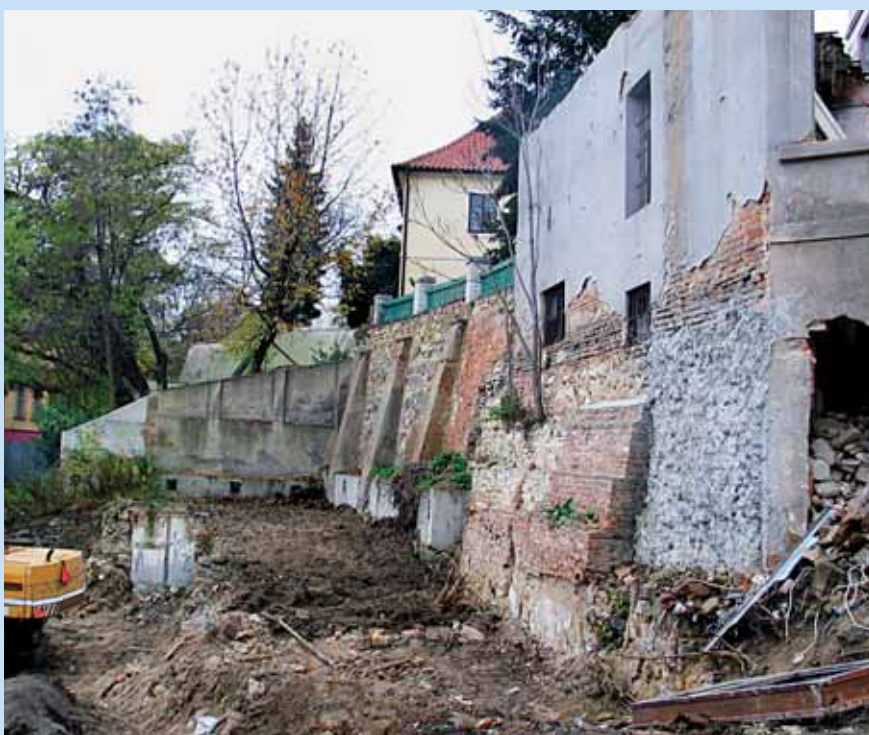
Opěrná zeď mezi farou a obchodní akademií s původním kotevním věncem
