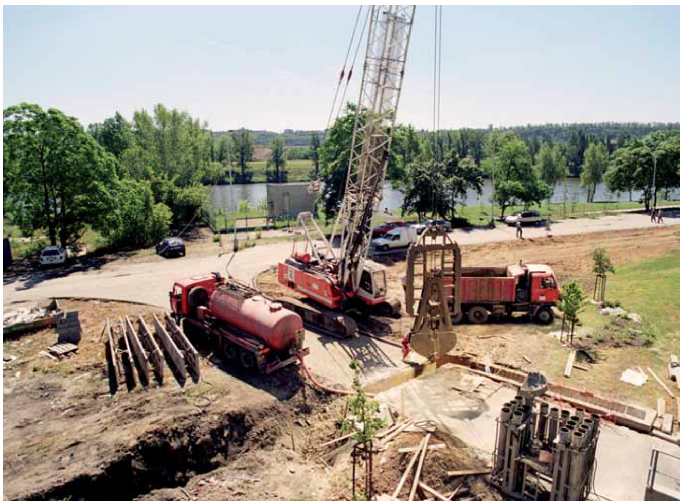
Těžba rýhy pro těsnicí podzemní stěnu
