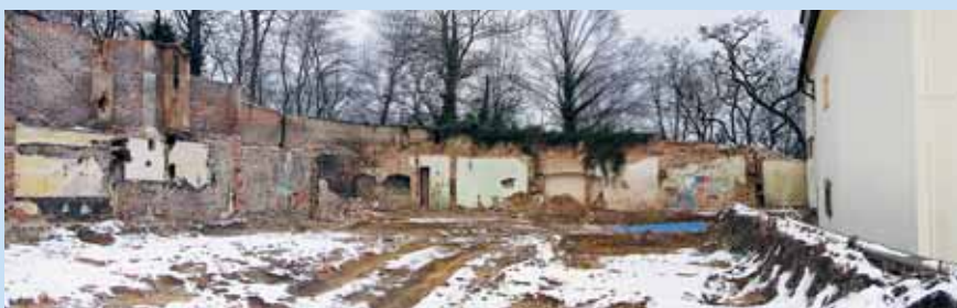
Pohled na staveniště směrem ke Stromovce
