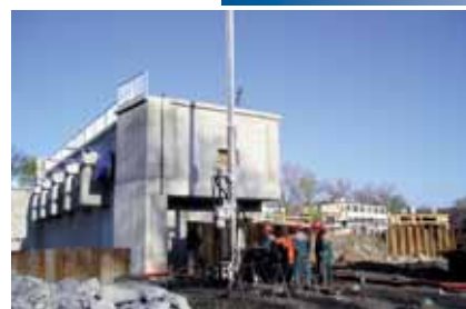
Provádění těsnicí stěny technologií tryskové injektáže mezi čerpací stanicí a protipovodňovými vraty Libeňských přístavů
