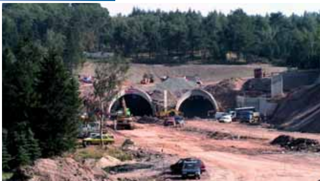
Tunely Panenská, severní portál
