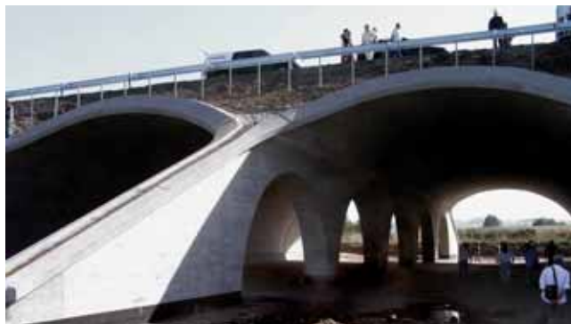
Most pro průchod zvěře na dokončovaném úseku dálnice D8
