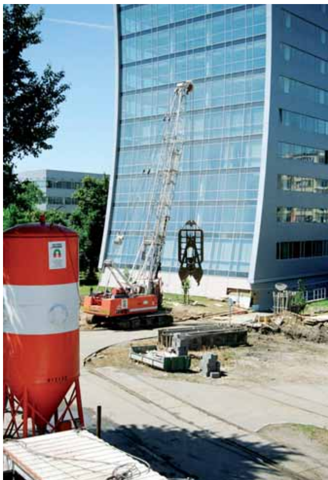
Těžba rýhy pro těsnicí podzemní stěnu
