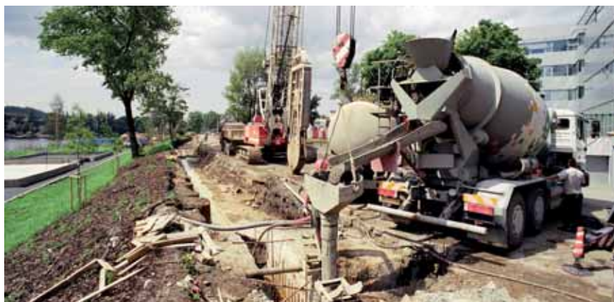
Betonáž konstrukční žlb. podzemní stěny
