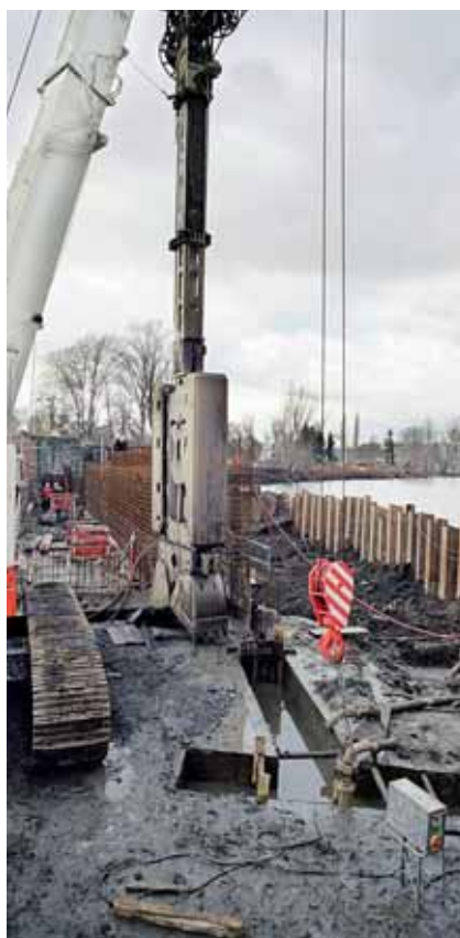
Hloubení těsnicí podzemní stěny mezi protipovodňovými vraty Rokytky a čerpací stanicí
