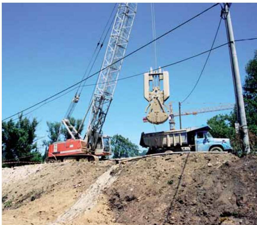
Hloubení těsnicí podzemní stěny (TPS) z nasypané hrázky
