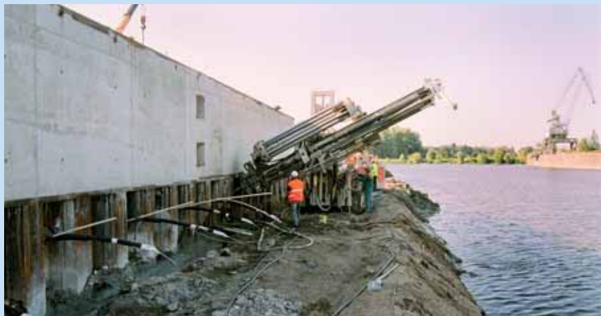
Provádění zemních kotev zajišťujících stabilitu nově budované části přístavní zdi z umělé vytvořeného násypu
