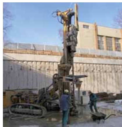
Hloubení vrtů pro trvalou tyčovou kotvu Dywidag ze základové desky
