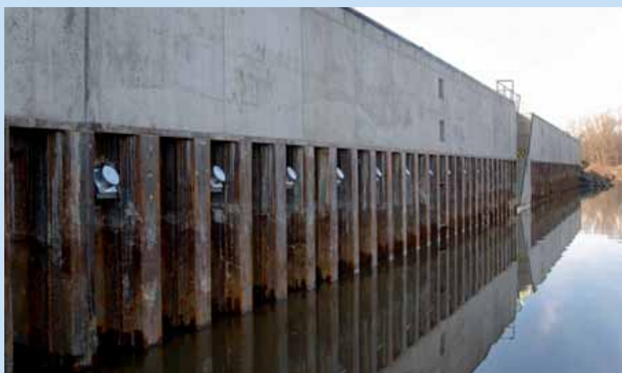
Nový úsek ochranné nábrežní zdi po dokončení
