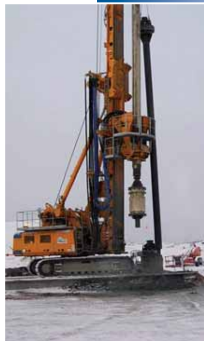
Obr. 4: Hloubení vrtu pomocí prodlužované Kelly tyče
