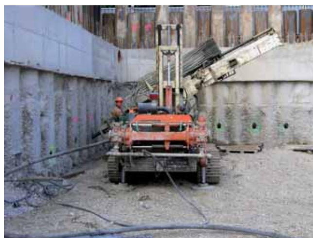
Hloubení vrtů pro dočasné lanové kotvy zajišťující převrtávanou pilotovou stěnu
