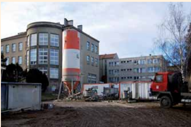
Obr. 1: Zařízení staveniště technologie TI před objektem Ústavu anatomie zvířat (č. 34)
