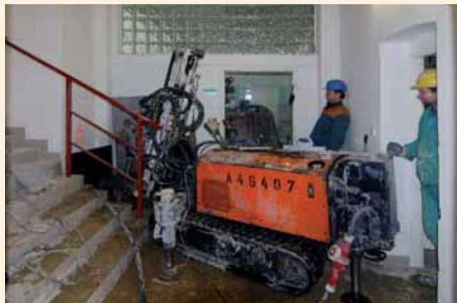
Obr. 2: Podchycení vnitřního traktu tryskovou injektáží vrtnou soupravou MSV 741/80, Ústav anatomie zvířat
