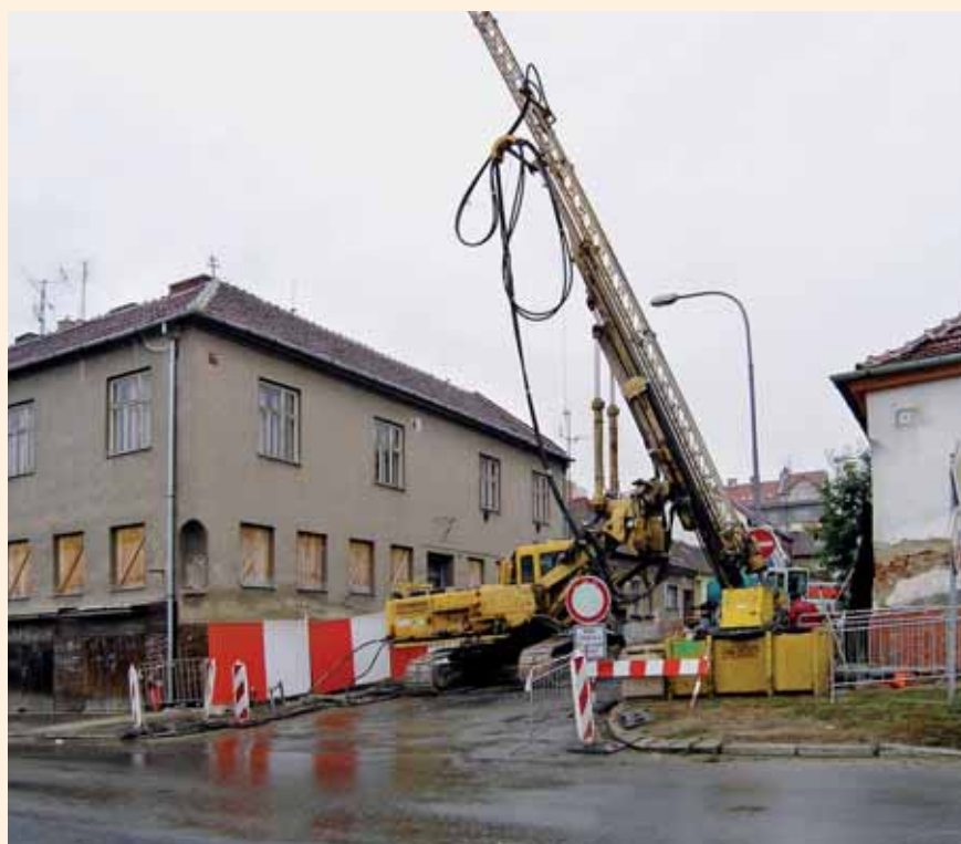
Obr. 7: Injekční práce prováděné vrtnou soupravou osazenou na velkoprofilovém pásovém podvozku
