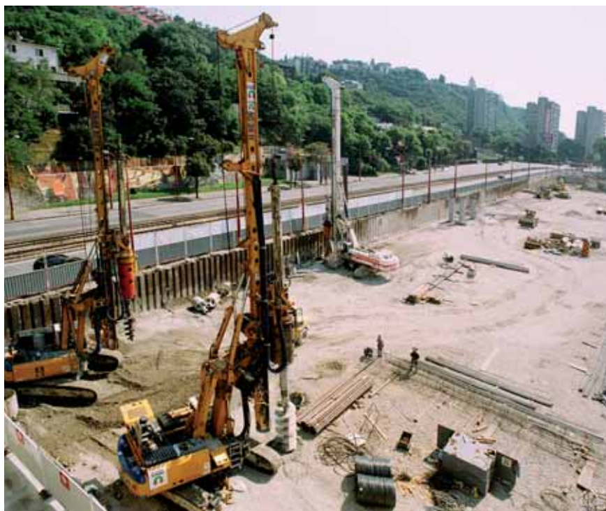
Provádění převrtávané pilotové stěny
