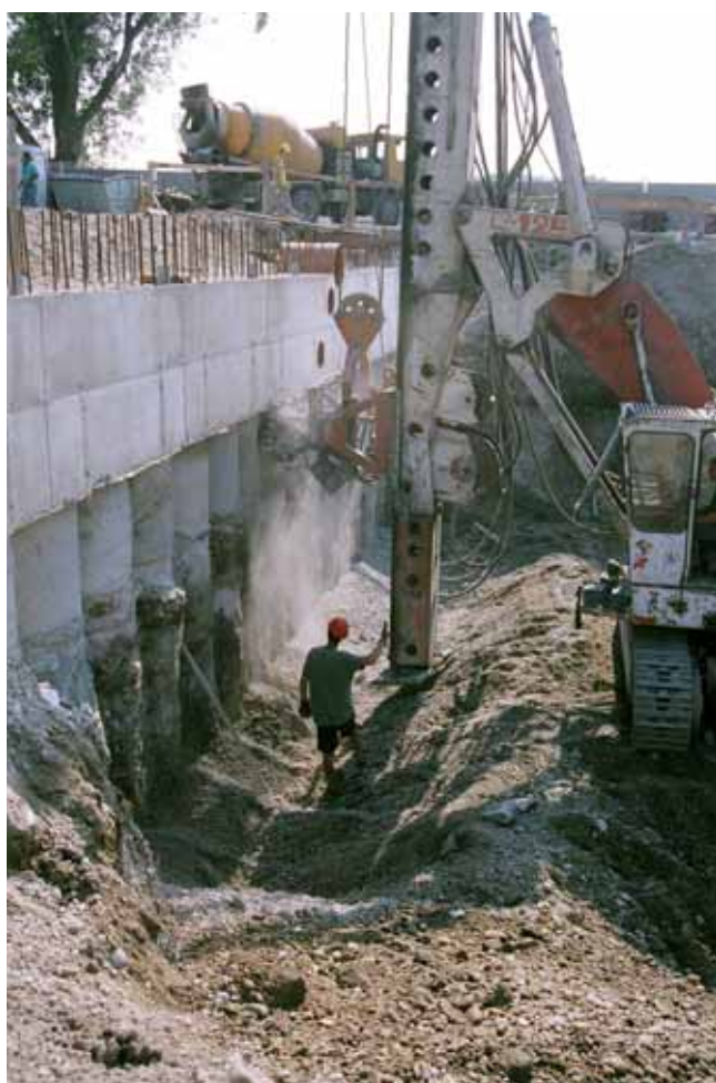
Frézování líce převrtávané pilotové stěny
