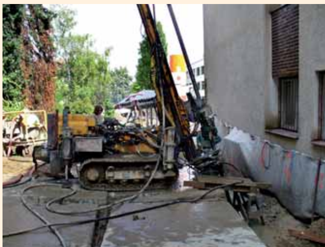
Obr. 5: Zajištění SZÚ clonou z tryskové injektáže, vrtná souprava Hütte 200/2 TF
