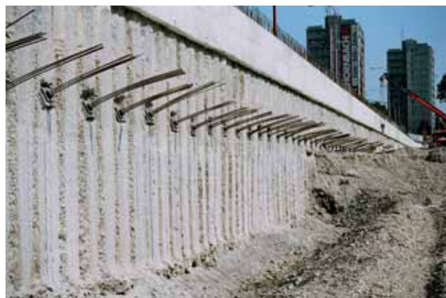
Pohled na zakotvenou a ořezovanou stěnu
