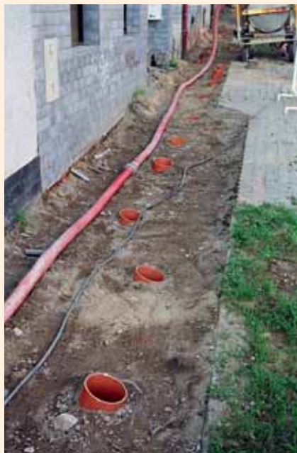
Obr. 8: Osazené průchodky pro sloupy sanační clony z TI
