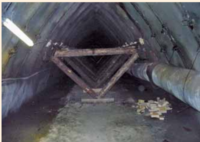
Obr. 3: Rozepření stávajících průzkumných štol při zajištění zástavby tryskovou injektáží
