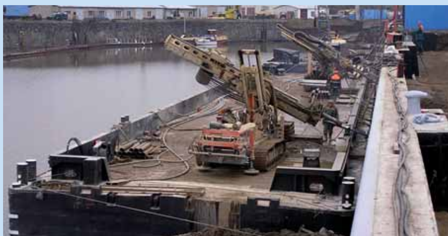
Provádění zemních kotev z lodí Jantar
