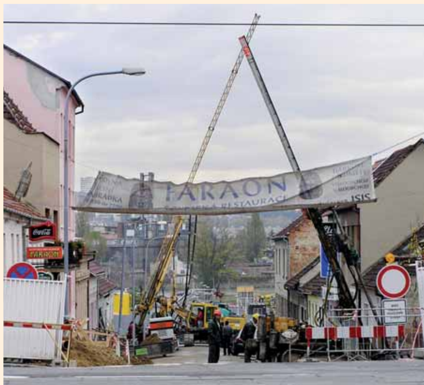
Obr. 6: Práce na zajištění objektů v ulici Veleslavínové (pokračování ulice Dobrovského)
