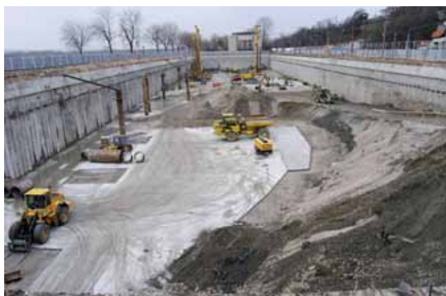
Stavební jáma se sestavou čerpacích studní
