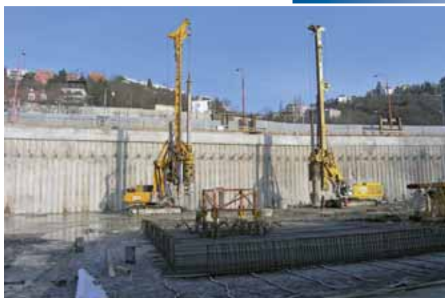
Provádění pilot pod základovou deskou
