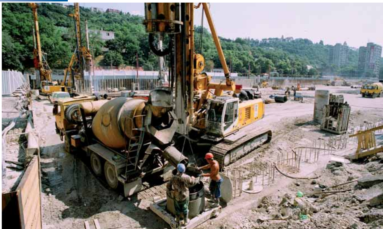
Betonáž sekundární piloty
