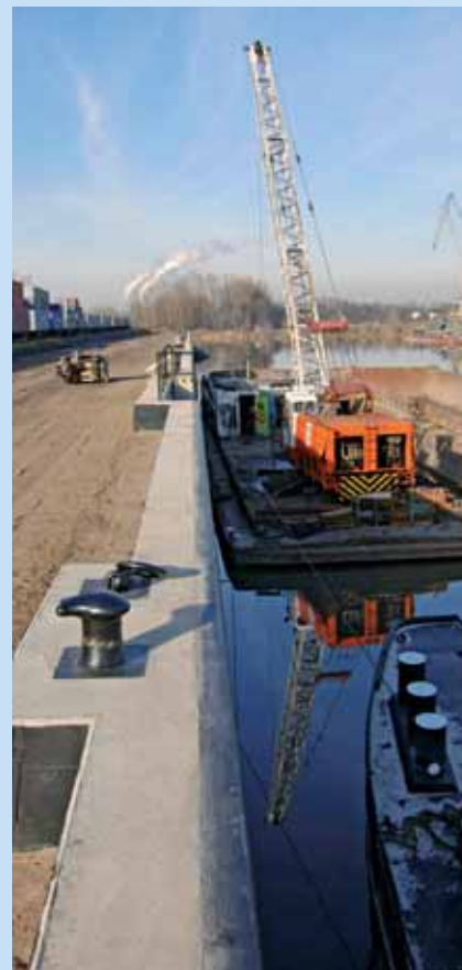
Nový úsek nábrežní zdi po dokončení hlavních prací
