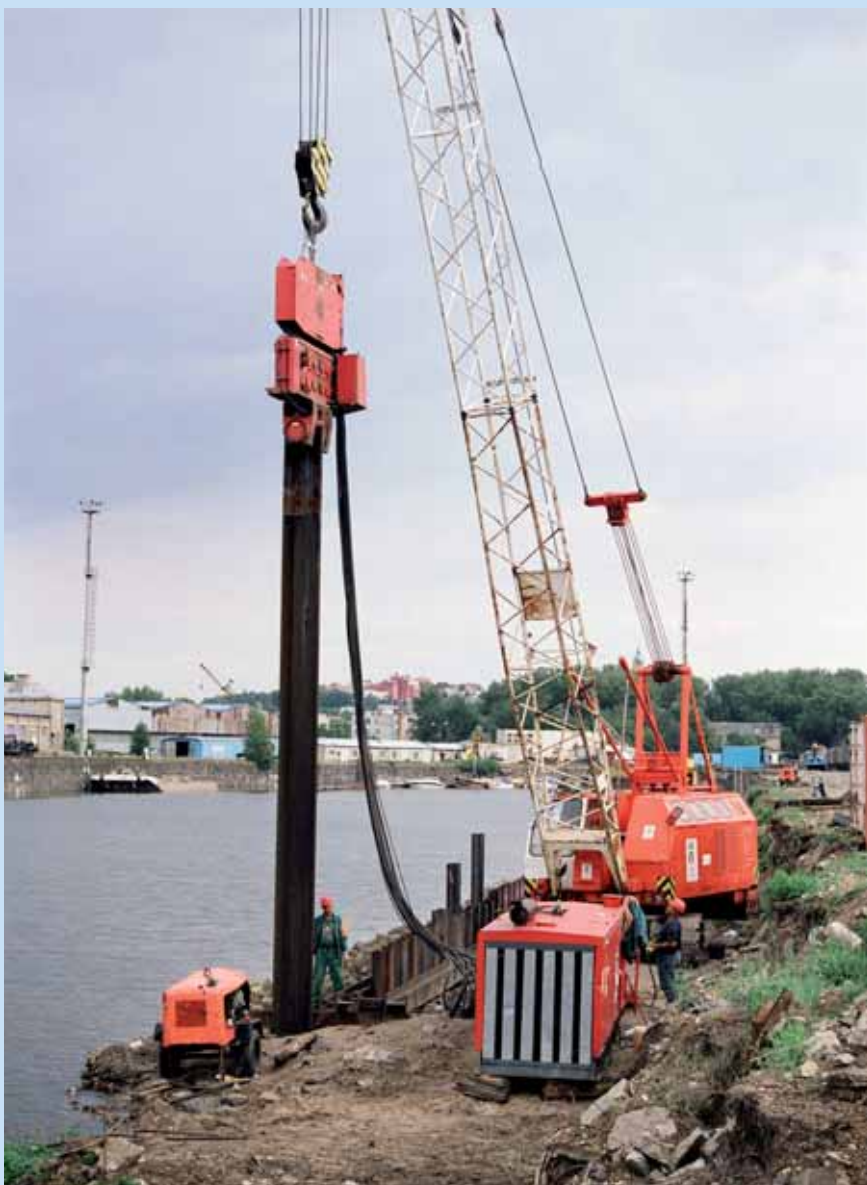
Realizace štětové stěny vibroberanidlem PTC 30
