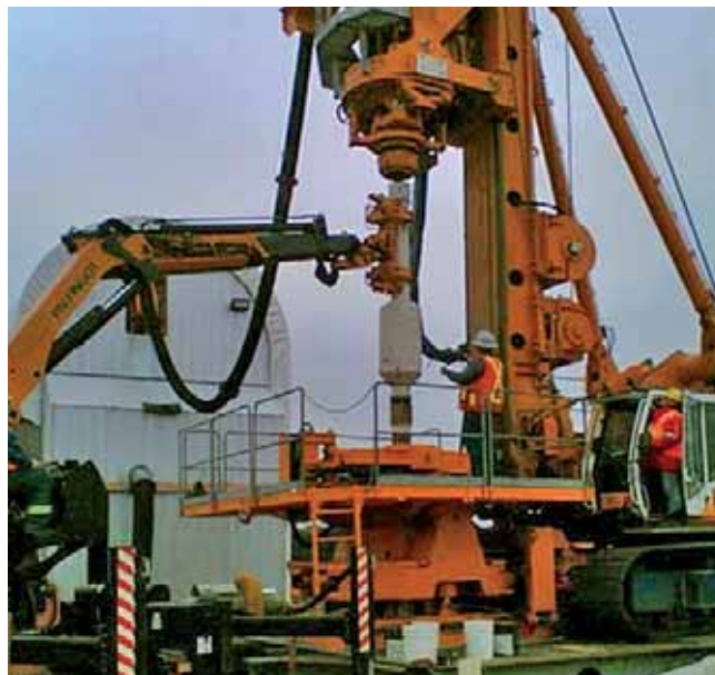
Obr. 6: Zvedání DSG soutyčí pomocí manipulátoru
