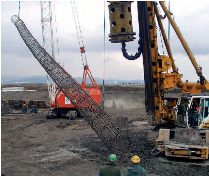
Obr. 2: První armokoše byly zvedány současně jeřábem a vrtnou soupravou
