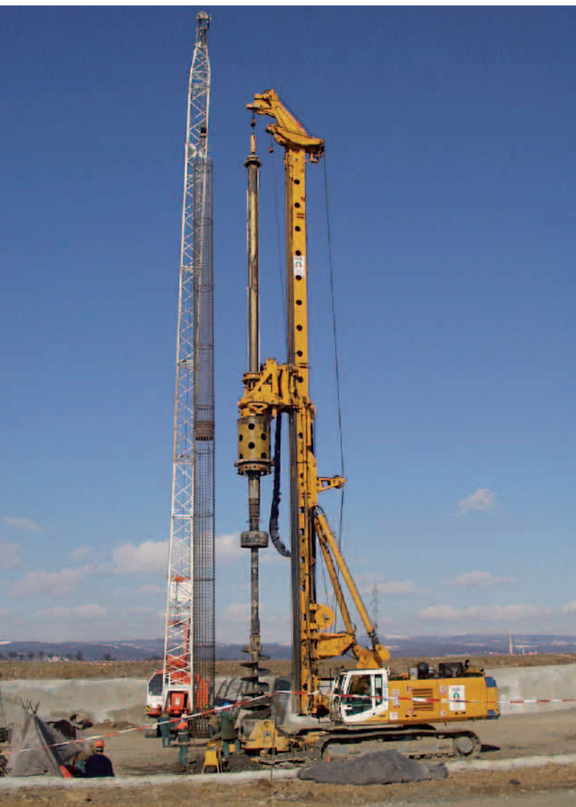
Obr. 3: Osazování armokoše po jeho sestavení v montážním vrtu
