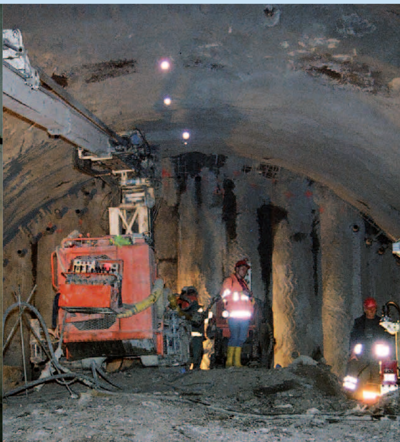
Detail pilotové stěny s mikropilotovým deštníkem
