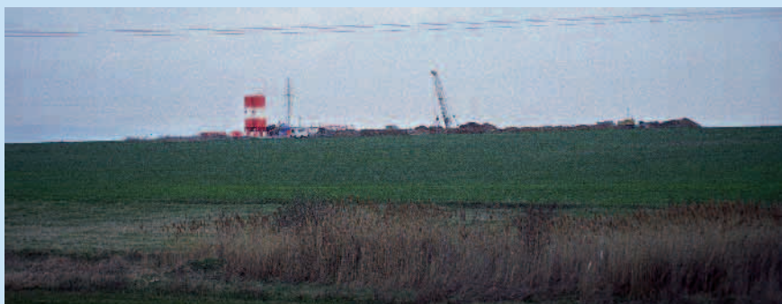
Místo provádění příčných přepážek a hluboké šachty z převrtávaných pilot nad tunelem Březno u Chomutova
