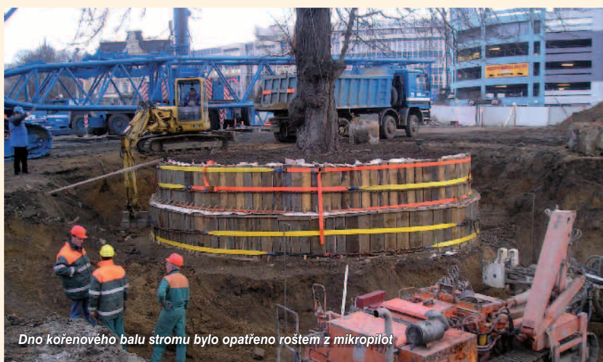
Přemístění stromu a kořenového balu za pomoci výkonného jeřábu, celková hmotnost zátěže činila 320 000 kg.
