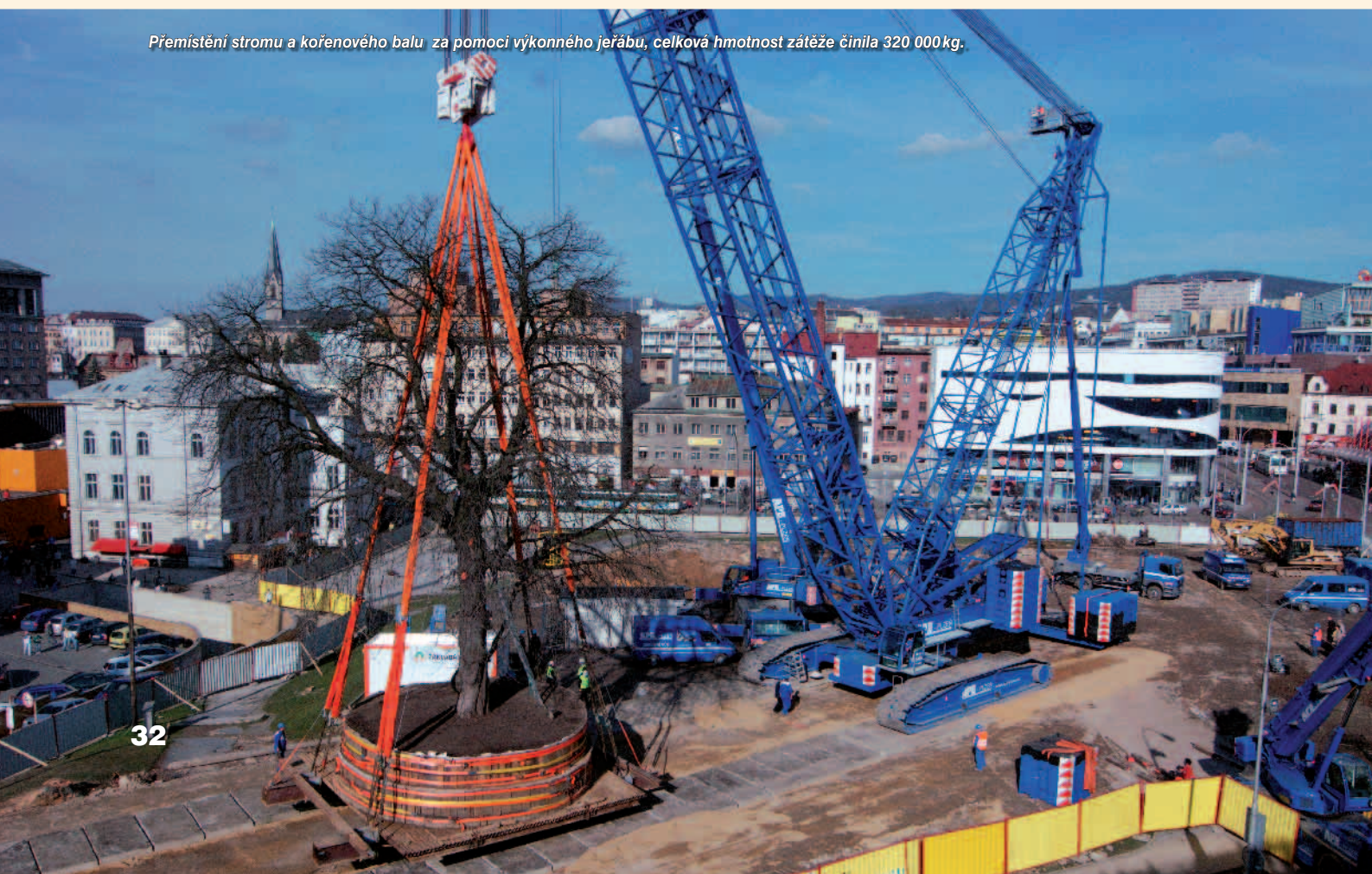
Dno kořenového balu stromu bylo opatřeno roštem z mikropilot
