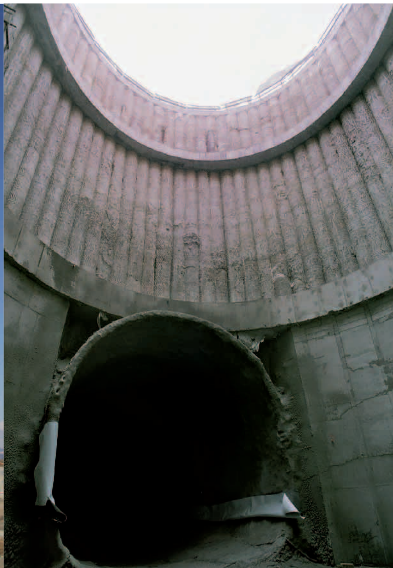
Dokončená šachta s proraženým tunelem od vjezdového portálu
