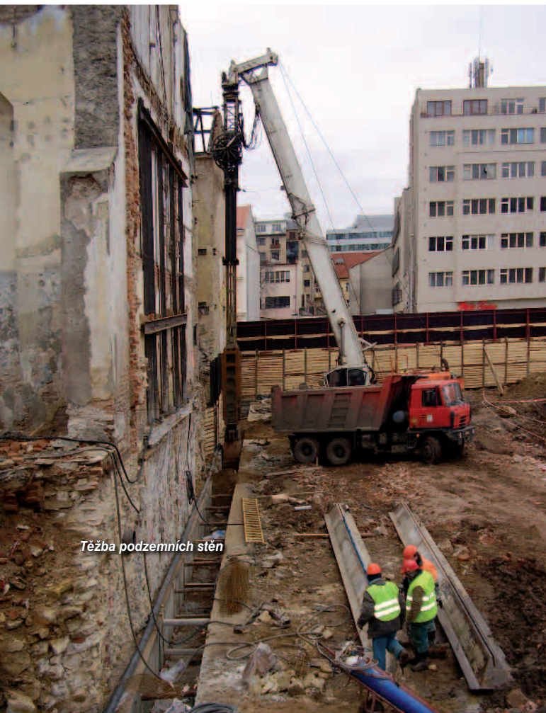
Nasazení frézy při očištění povrchu podzemních stěn
