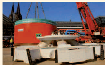
Obr. 2: Dovož štítů na úsek Sever s pohledem na kolínský dóm.
