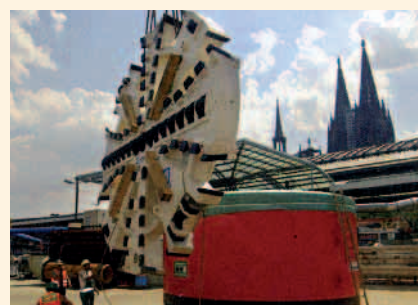
Obr. 3: Sestavování štítů o průměru 6,8 m pro úsek Sever
