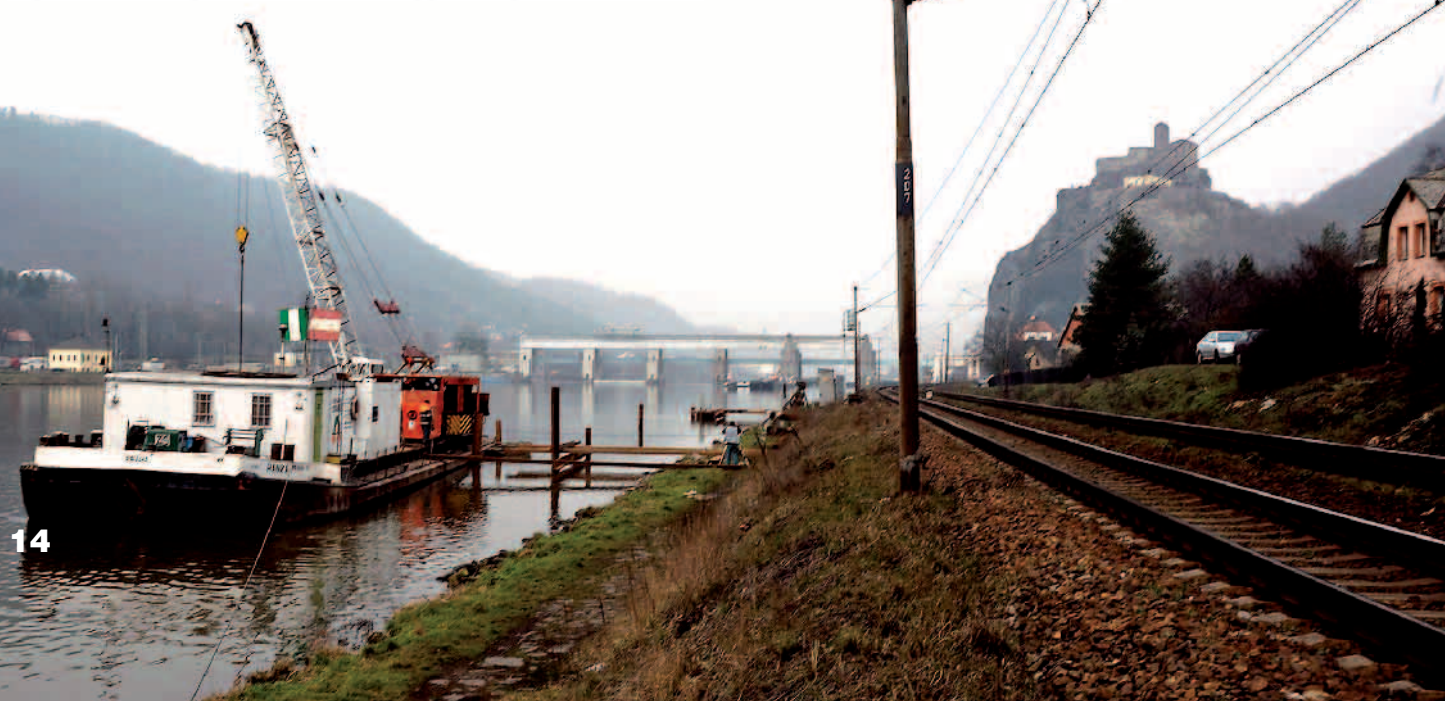
Příprava na beranění pomocné konstrukce dalby pro velká plavidla na horní vodě
