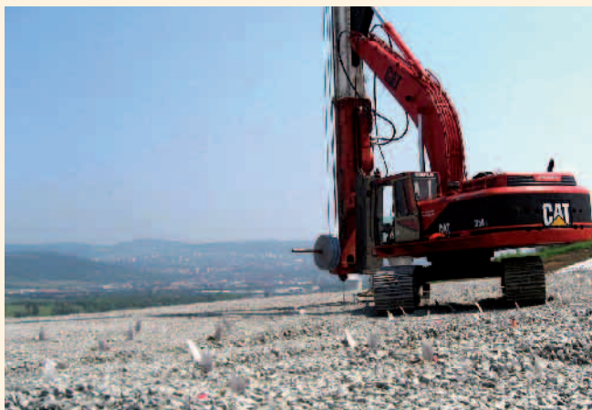
Pohled na drenážní vrstvu se zapuštěnými drény
