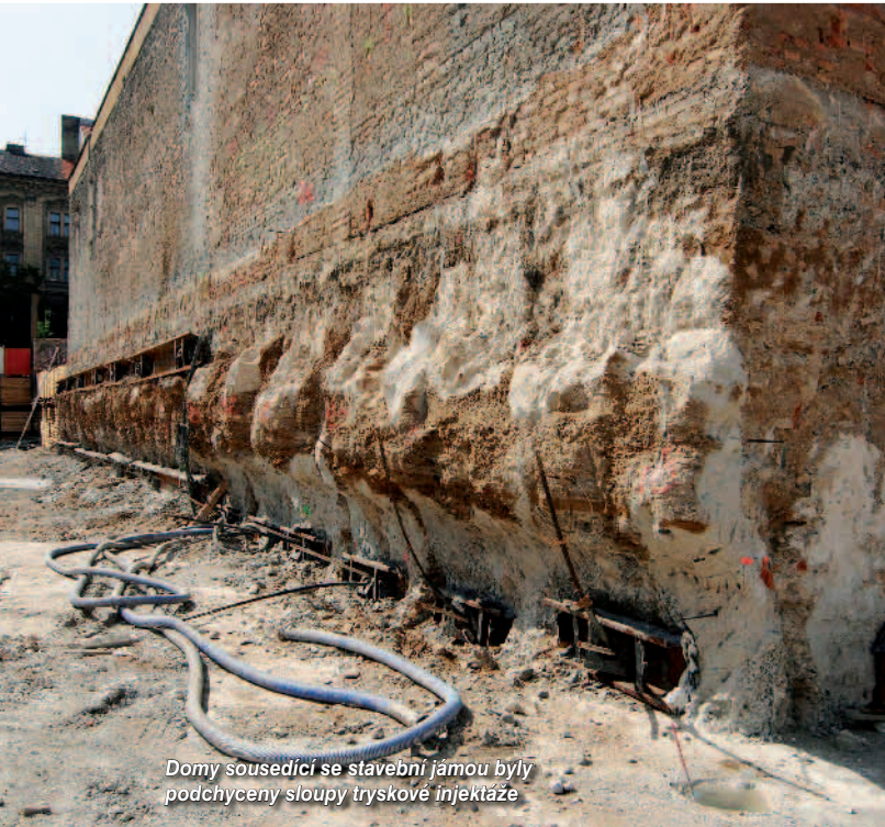
Frézování sloupů tryskové injektáže přesahujících lic budoucí vestavby
