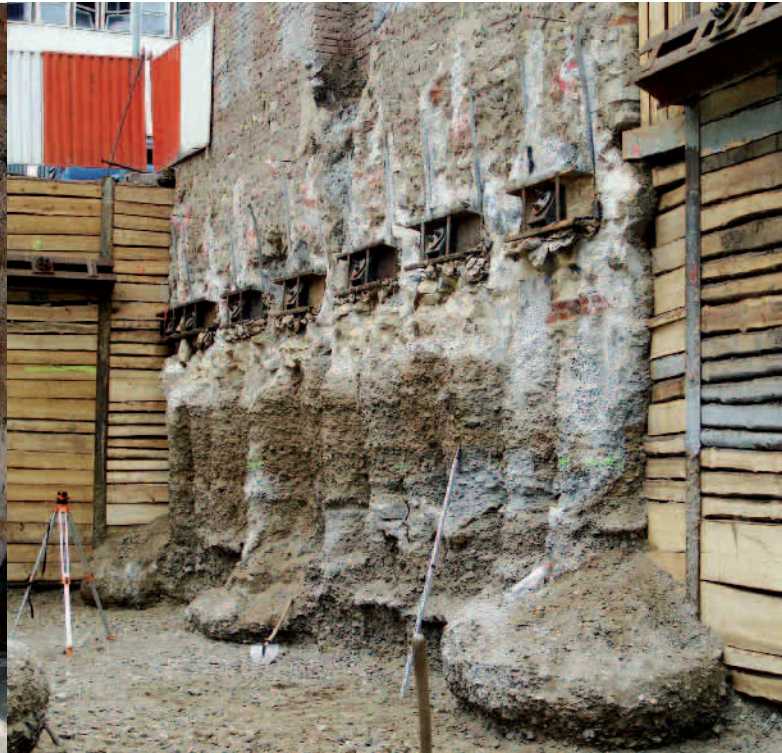
Provádění sloupů tryskové injektáže pro založení objektu
