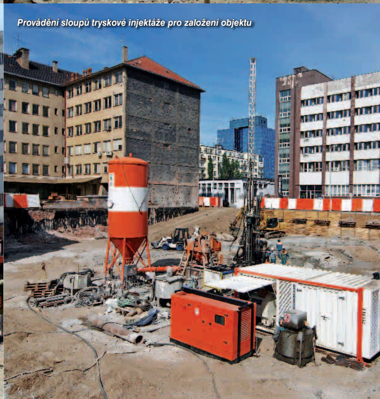
Frézování sloupů tryskové injektáže přesahujících lic budoucí vestavby
