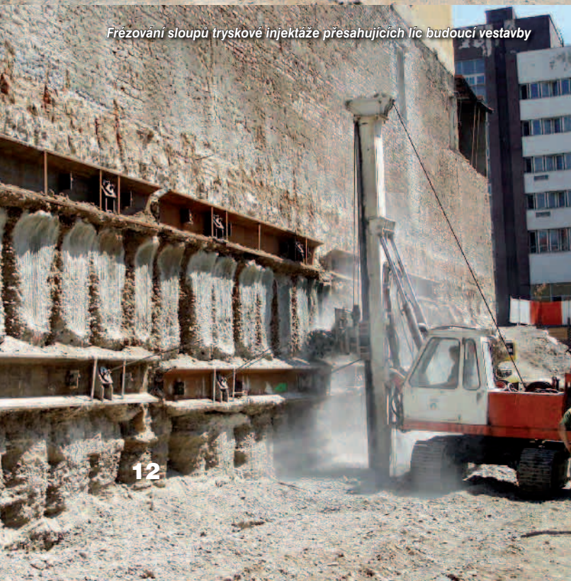
Domy sousedící se stavební jámou byly podchyčeny sloupy tryskové injektáže
