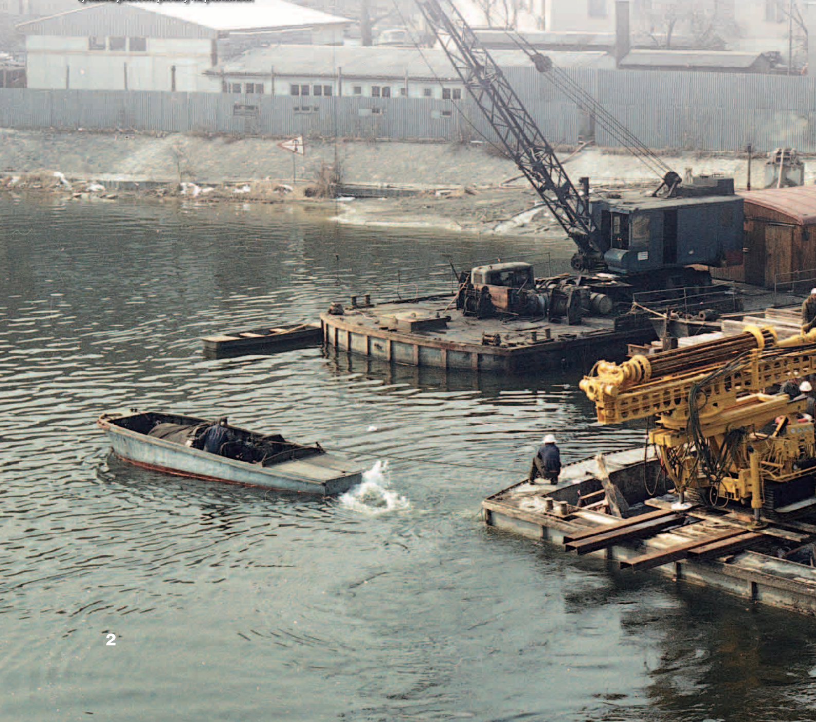
Pontony pro hloubení vrtů z hladiny Vltavy u malostranského břehu, výstavba pracovní plošiny na pontonech
