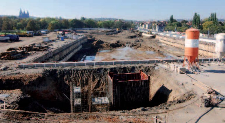
Celkový pohled na částečně otevřenou stavební jámu tunelů Blanka na Letné
