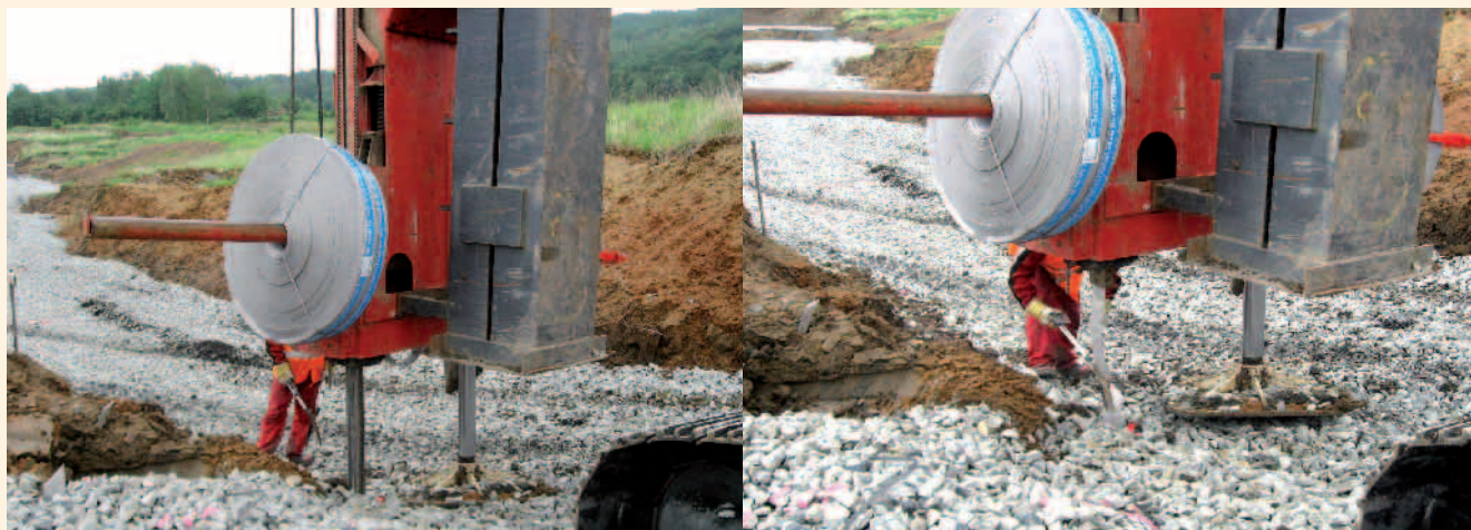
Detail zapouštění drénu do podloží
