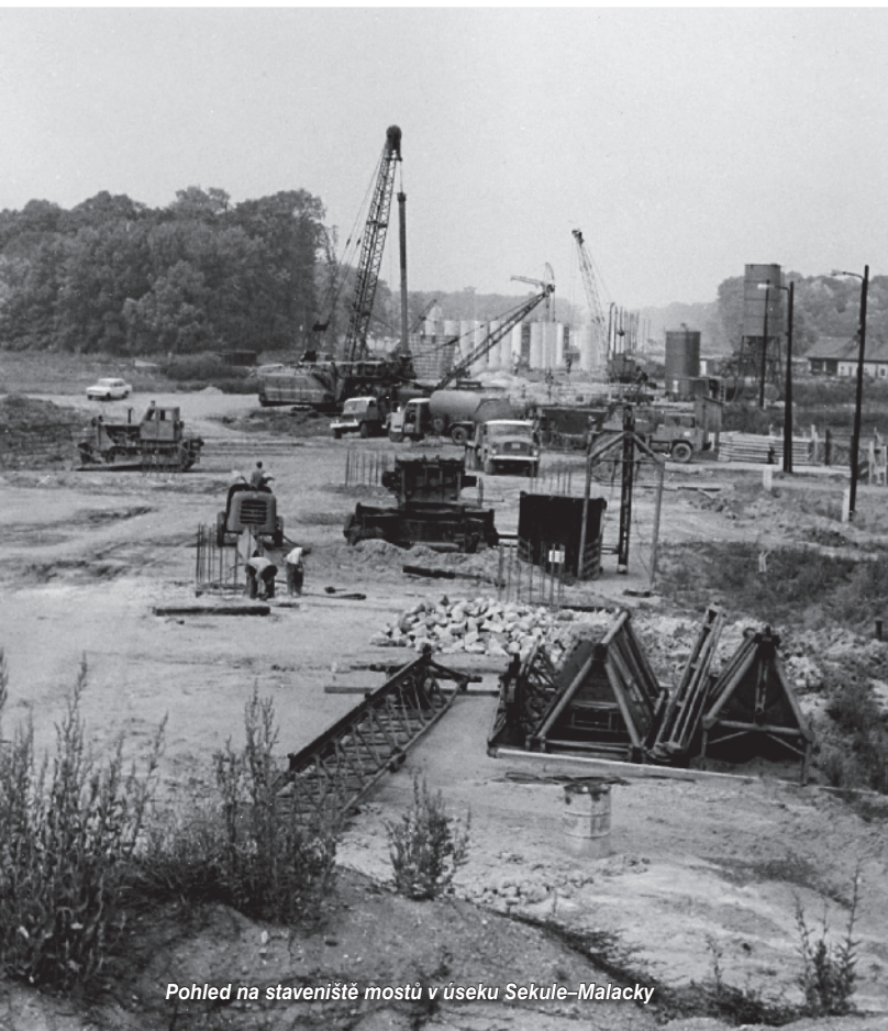
Pilíře dálniční estakády u Sekule jsou založeny na pilotách
