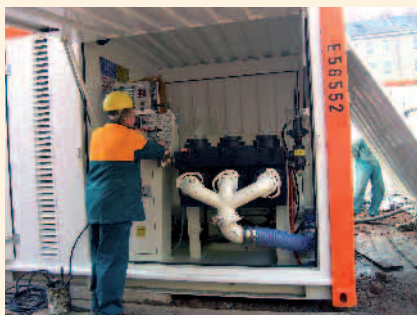
Nasazení injektážního čerpadla na jedné ze staveb realizovaných v současnosti společností Zakládání staveb, a. s., – Maha, Praha-Holešovice.
