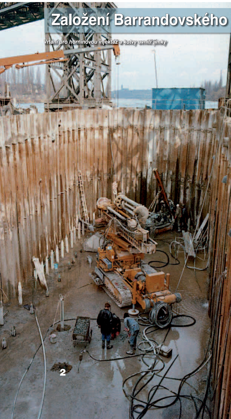
Dvojitá štětová jímka v řečišti Vltavy pro založení pilíře Barrandovského mostu
