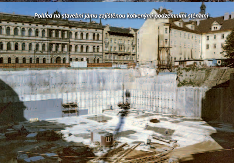
Hloubení vrtů pro drátové předpjaté kotvy, zajišťující v 1. a 2. úrovni podzemní stěny
