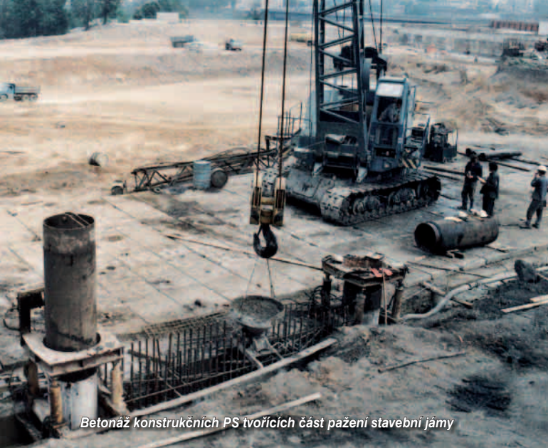
Realizace základových bloků pro sloupy. Bloky jsou založeny na dvojicích a trojicích pilot.
