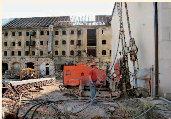
Podchycení objektu kotelný sloupy z tryskové injektáže...
