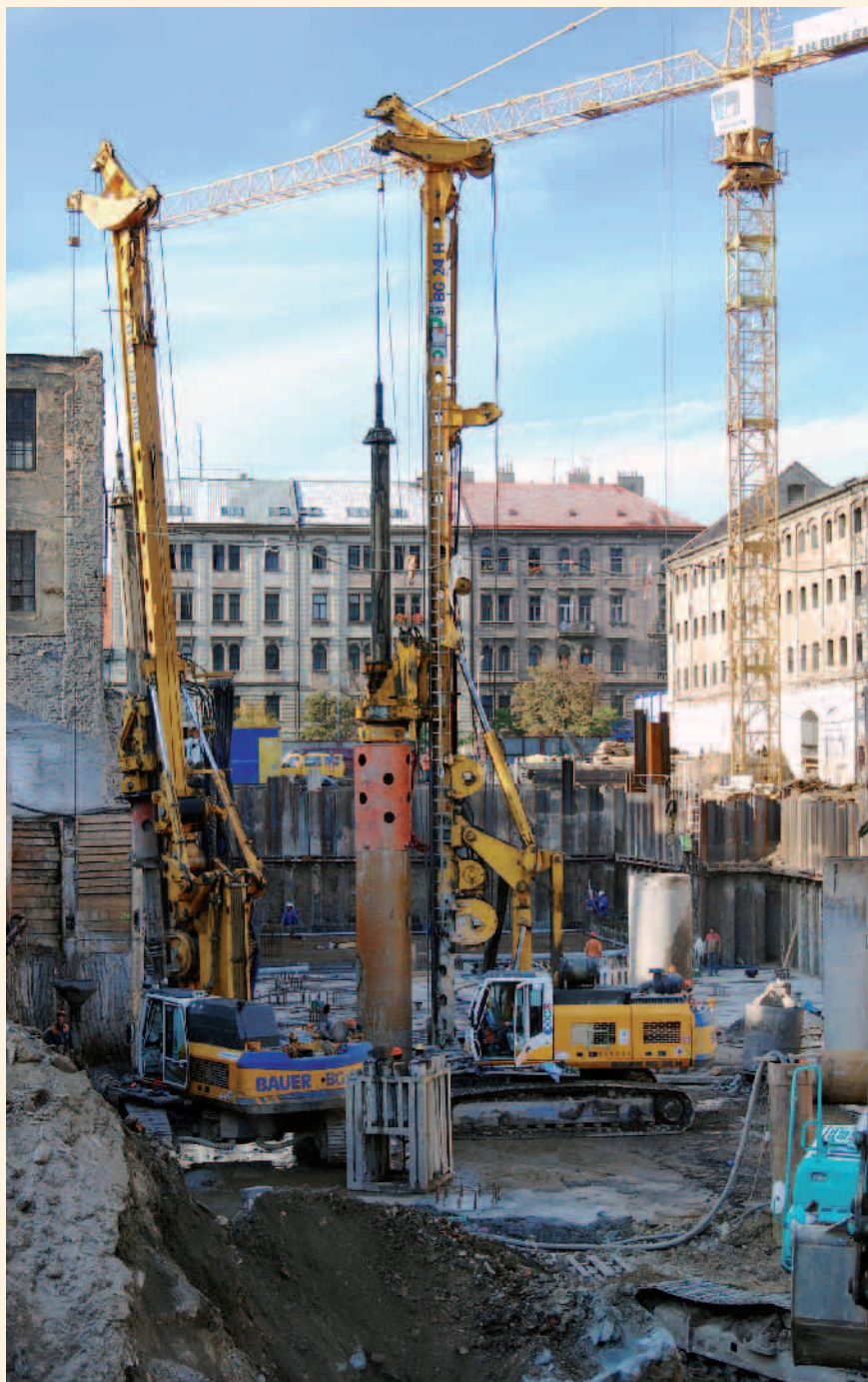
Provádění základových pilot ze dna stavební jámy
