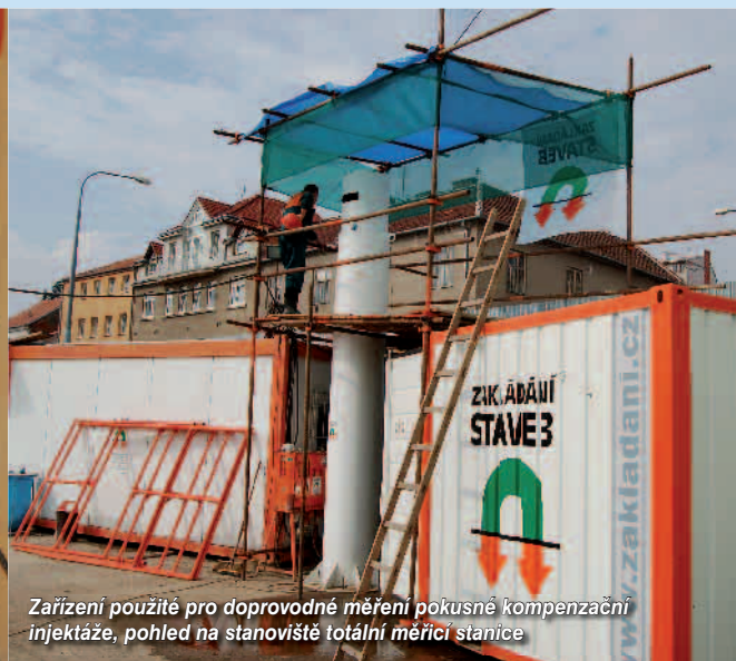
Zařízení použité pro doprovodné měření pokusné kompenzační injektáže, pohled na měřicí válce hydrostatické nivelace v přízemí předmětného objektu
