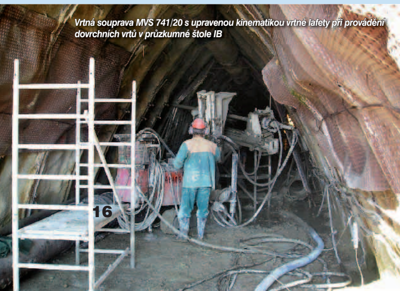
Usměrněná injektáž injektážního pole ze štoly IB
