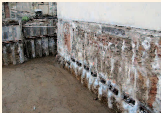
...a dokončená obnažená kotvená stěna.
