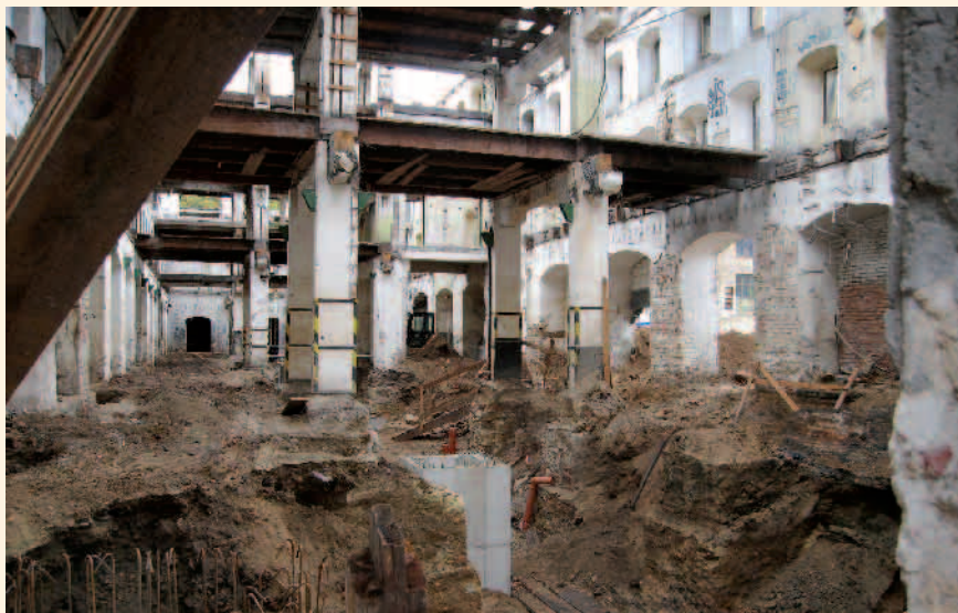
Obnažené patky sloupů stávající tovární budovy
