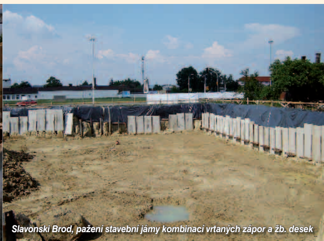
Dubrava, kompletní zajištění stavební jámy kotvenými štětovými stěnami
