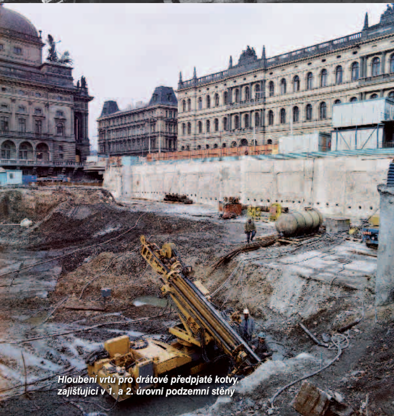
Pohled na stavební jámu zajištěnou kotvenými podzemními stěnami
