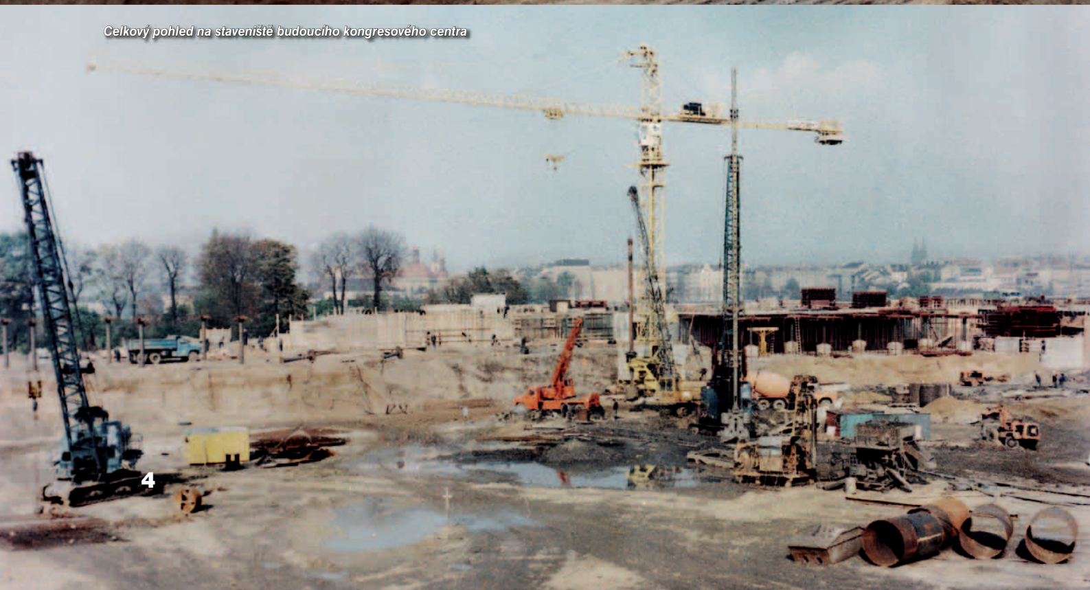
Vrtání velkopřůměrových pilot 850–2000 mm
