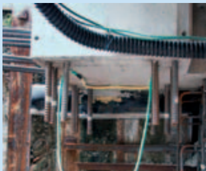
Způsob uchycení injektážních hadiček
