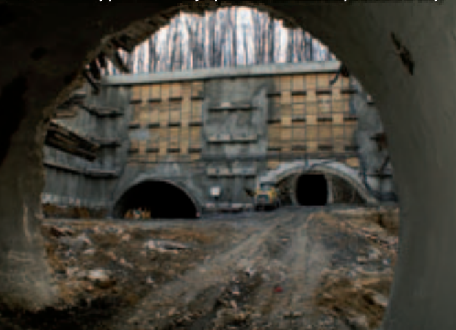
Obr. 4: Horninový pilíř mezi tunely – pohled z demolané průzkumné štoly
