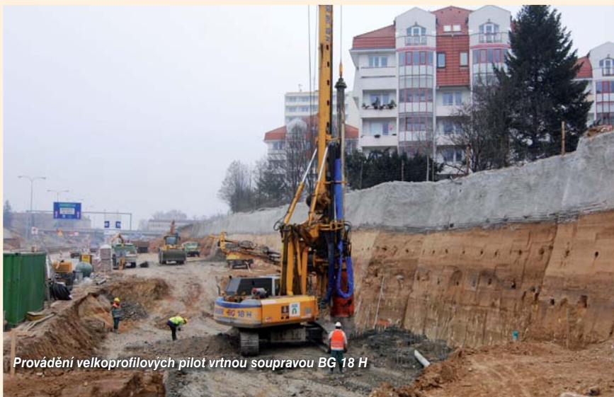
Provádění velkoprofilových pilot a zemních trnů pro zajištění stability svahu
