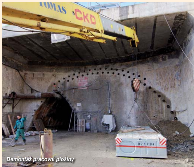
Pohled na průzkumné štoly s realizovaným MP deštníkem
