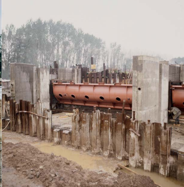
Jez Veletov: pohled na jezová pole s osazenými klapkami
