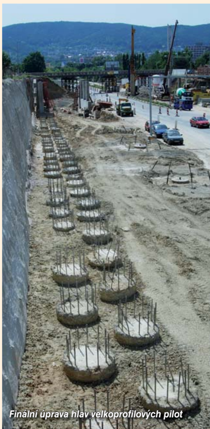
Provádění velkoprofilových pilot vrtnou soupravou BG 18 H
