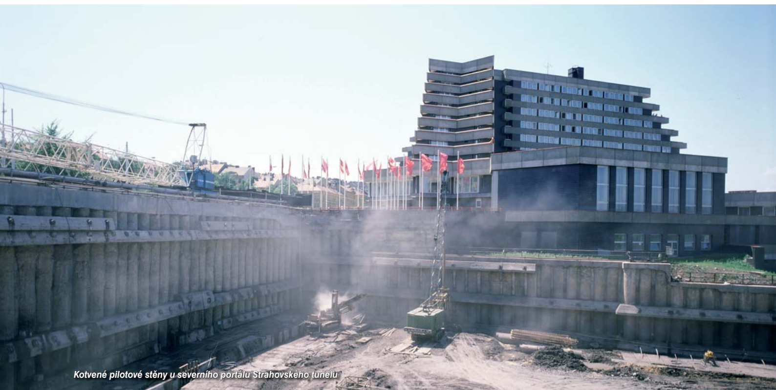
Jižní portál Strahovského tunelu byl proveden v kotvených podzemních stěnách
