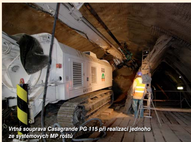
Detailní pohled na čelbu, ze které je prováděn MP deštník
