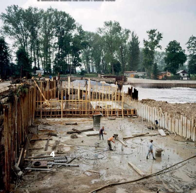
Jez Veletov: pohled na stavební jámu poloviny jezu s mikropilotami ve dně a štětovou stěnu na horní i dolní vodě
