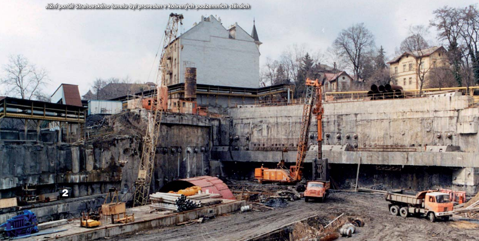
Jižní portál Strahovského tunelu byl proveden v kotvených podzemních stěnách
