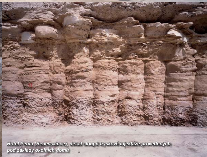
Hotel Penta (Renaissance), stavební jáma zasahovala pod úroveň základů sousedních objektů, které byly podchyceny sloupy tryskové injektáže
