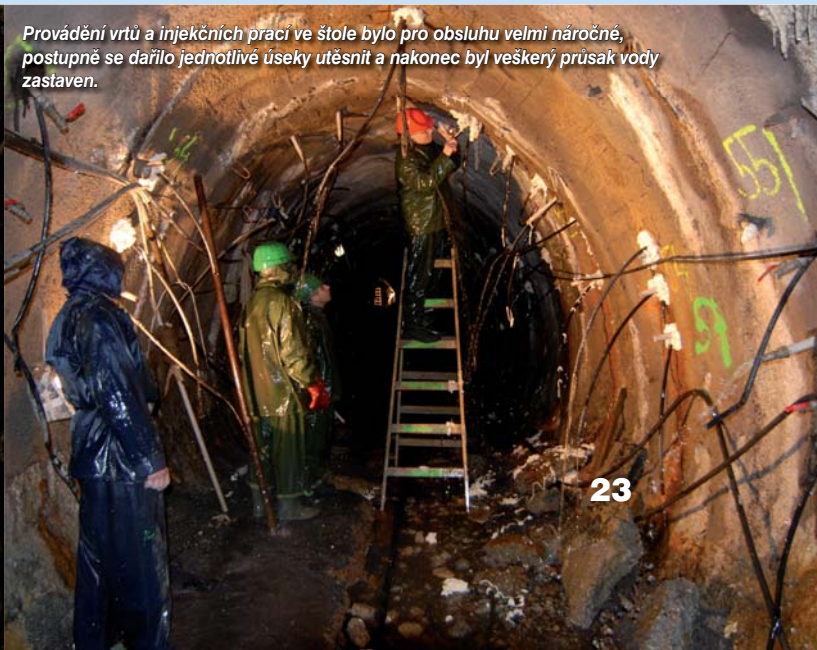
Průzkumná štola před zahájením injekčních prací byla udržovaná v provozu trvalým čerpáním podzemí vody vytékající masivně na mnoha místech ze stěn a stropu.
