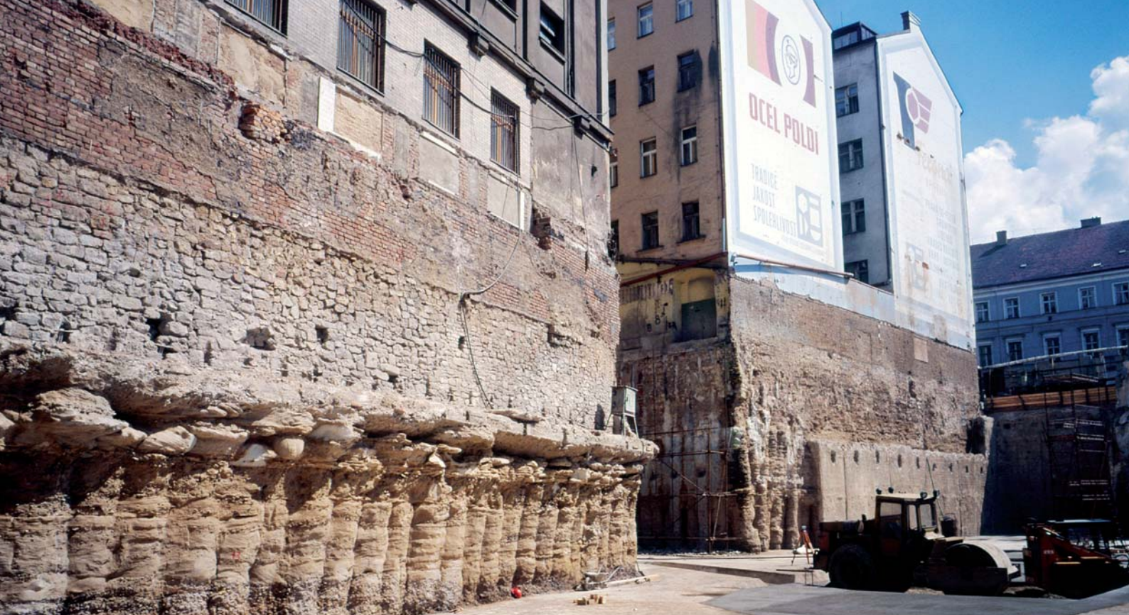
Hotel Penta (Renaissance), stavební jáma zasahovala pod úroveň základů sousedních objektů, které byly podchyceny sloupy tryskové injektáže
