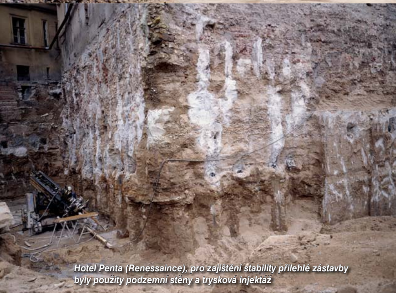
Hotel Penta (Renaissance), stavební jáma zasahovala pod úroveň základů sousedních objektů, které byly podchyceny sloupy tryskové injektáže
