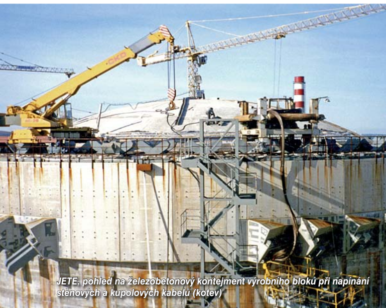
JETE, očníce stěnových kabelů na plošině pod kupolí
