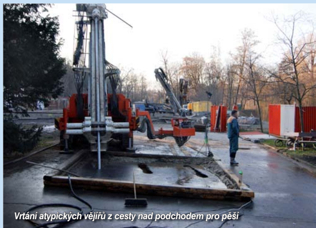
Dokončuje se jedna etapa tryskové injektáže na severní tunelové troubě a připravuje se překročení potoka s atypickými vějíři pod ochranou již realizovaných štětových stěn.
