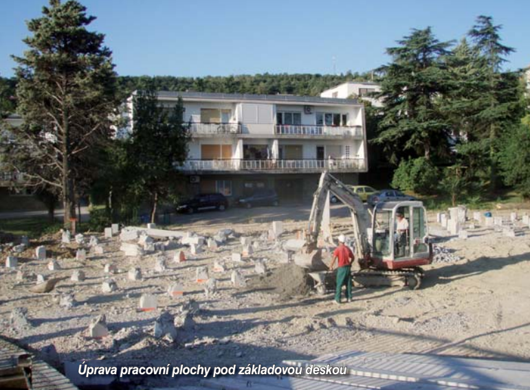
Piloty po odsřamování hlav, připravená plocha pro armování a betonáž základové desky
