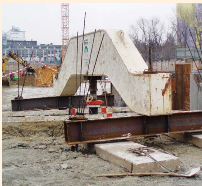
Pohled na celkovou sestavu statické zatěžovací zkoušky
