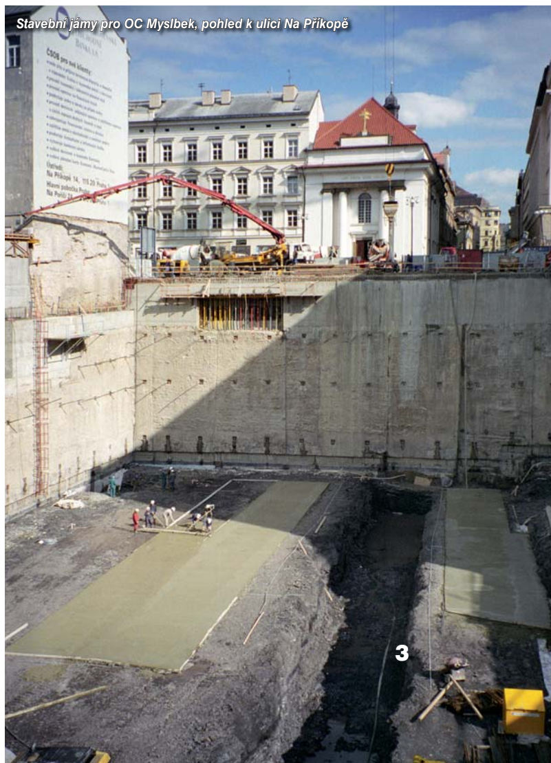
Stavební jáma pro OC Myslбек byla pažena konstrukčními železobetonovými stěnami, pohled k Ovocnému trhu
