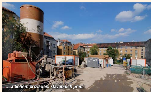
Začátek těžby šachty po provedení svislé TI
