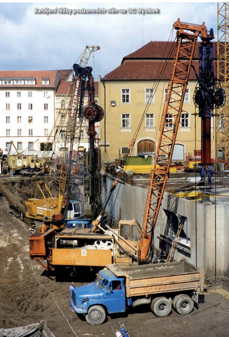
Stavební jáma pro OC Myslбек byla pažena konstrukčními železobetonovými stěnami, pohled k Ovocnému trhu
