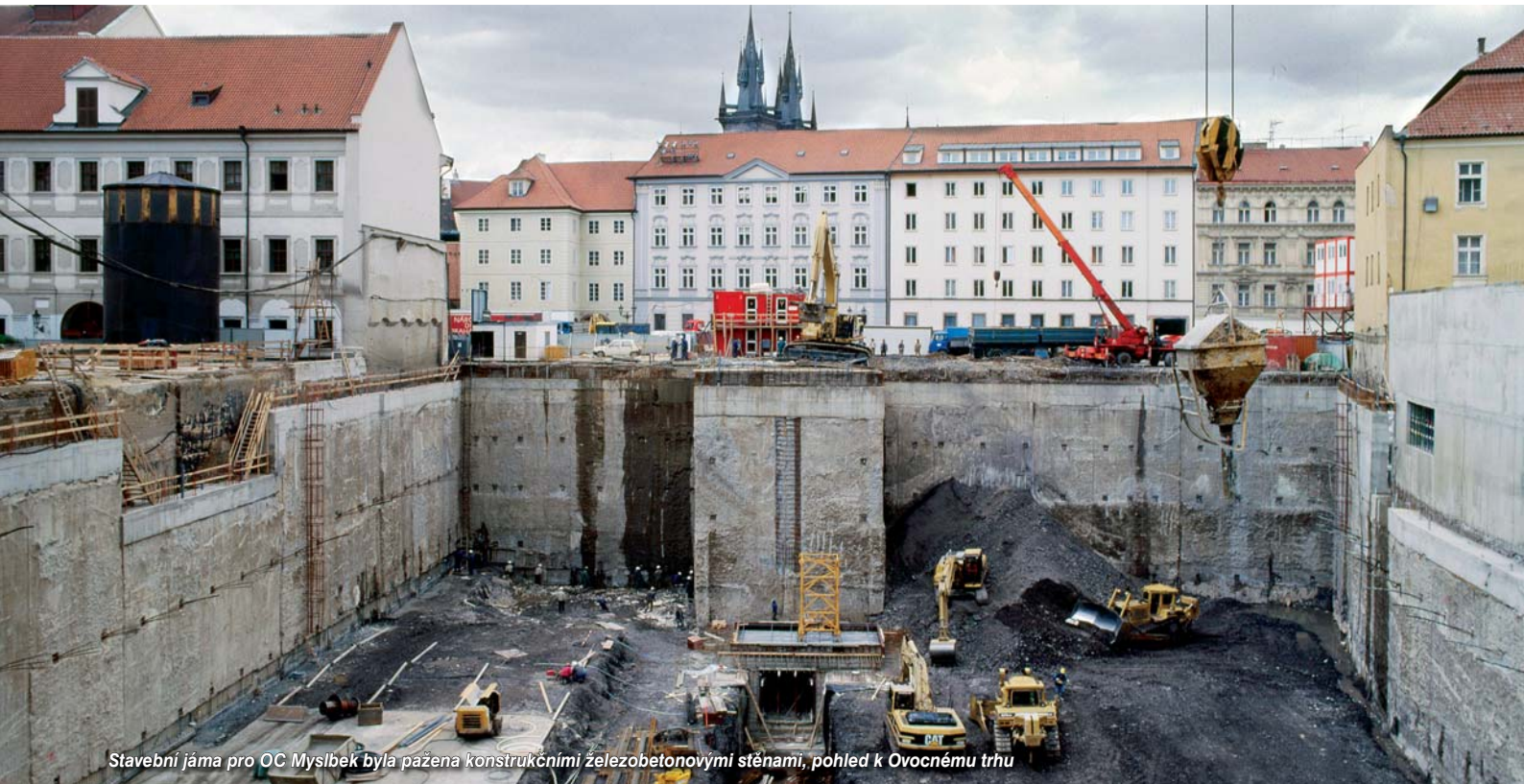
Zahájení těžby podzemních stěn na OC Myslбек
