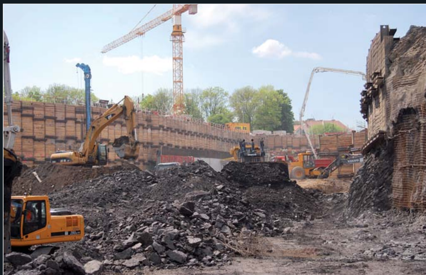
Probíhající těžba při postupném snižování výkopu v návaznosti na projektované kotevní úrovně ve stavební jámě, zajištěné v horní části záporovým pažením.
