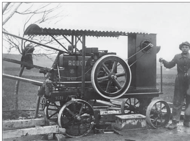
Benzinový motor Wikov typu ROBOT o výkonu 11–13 koní pro pohon kompresoru na silniční stavbě firmy Nejedlý, Řehák a spol.
