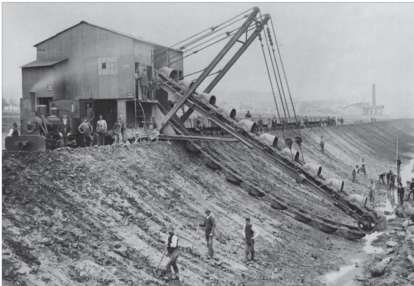
Parním rypadlem typu B z Lübecké strojírny vyhrabávala firma A. Lanna bazén přístavu v Ústí nad Labem. Na fotografii z 29. 4. 1891 vidíme také lokomotivu z továrny Jung, která odvážela naložené vozíky.
