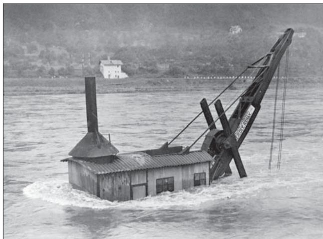
V srpnu 1925 nestačilo před velkou vodou ve Střekově odjet rypadlo. Několik dnů po opadnutí vody stroj už zase spolehlivě pracoval.
