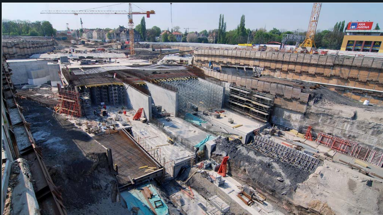
Kontinuálně probíhající výstavba tubusů budoucích tunelů od dilatace 12 směrem k budoucímu portálu raženého tunelu v zapažené stavební jámě
