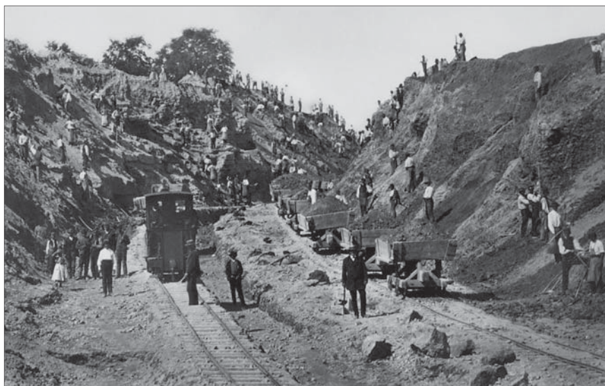
Nejstarší doložené využití parní lokomotivy na stavbě u nás ukazuje fotografie ze 4. 9. 1874. Firma Hügel & Sager s pomocí parní úzkorozchodné železnice prokopávala zářez u Vysokova na trati Týniště nad Orlicí – Broumov. (archiv NTM)
