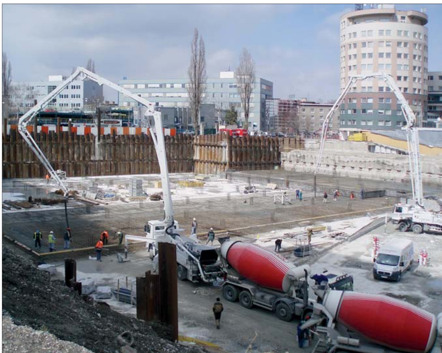
Betonáž základové desky
