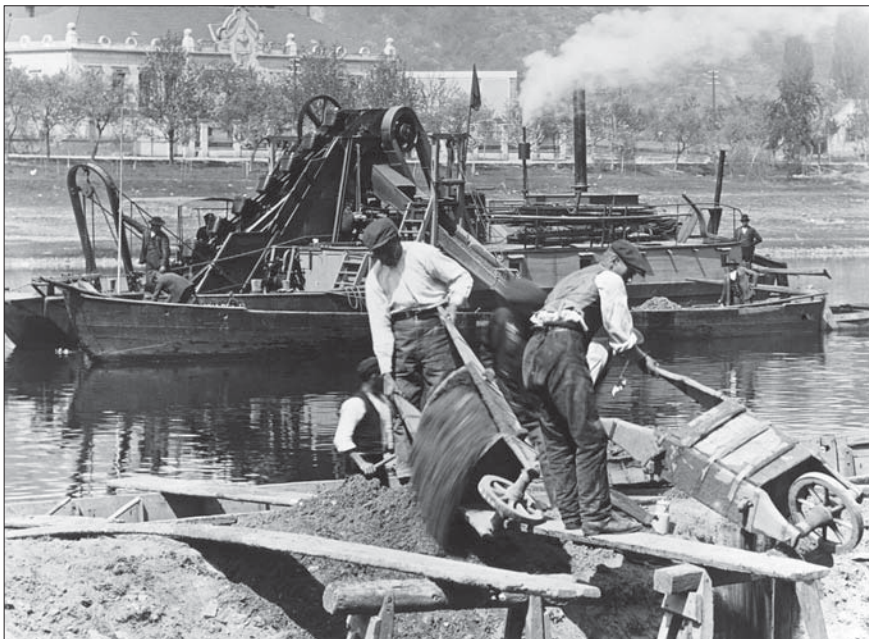
Pracovní scéna při vykládání člunu od bagru č. 6 firmy Lanna na počátku 20. století v Praze-Troji. Výrobce bagru není přesně znám, kotel dodala pražská firma Martinka v roce 1889.
