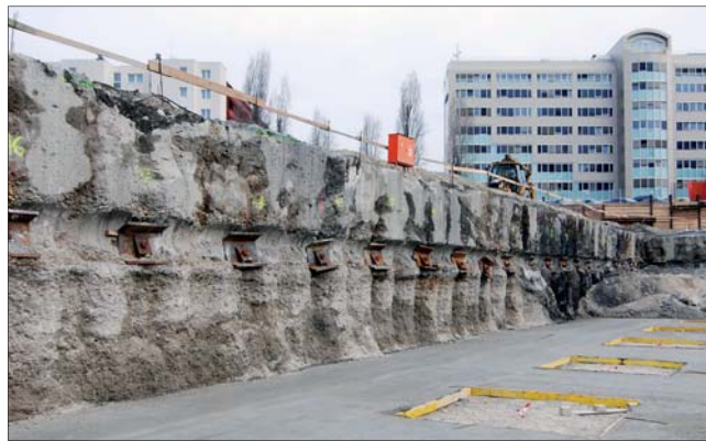
Pažení stavební jámy kotvenou stěnou ze sloupů tryskové injektáže, severní část u sousedního objektu BBC I
