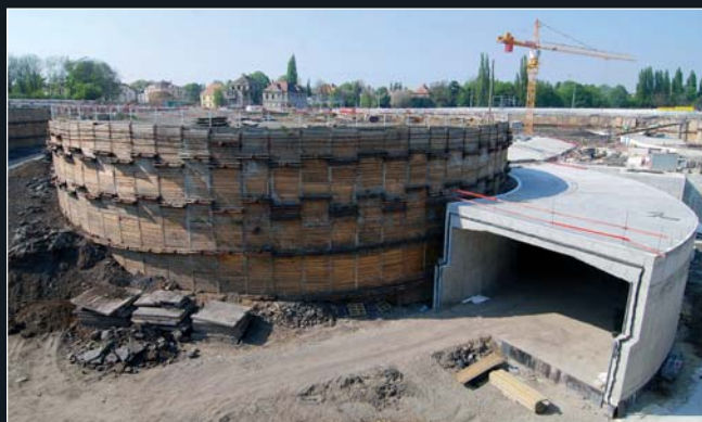
Pohled na oblast vjezdové a výjezdové rampy s poměrně komplikovaným pažením okolo sevřeného horninového masivu, kde bylo nutné kromě kotev k zajištění stability navíc použít i kotevní obruče a táhla.
