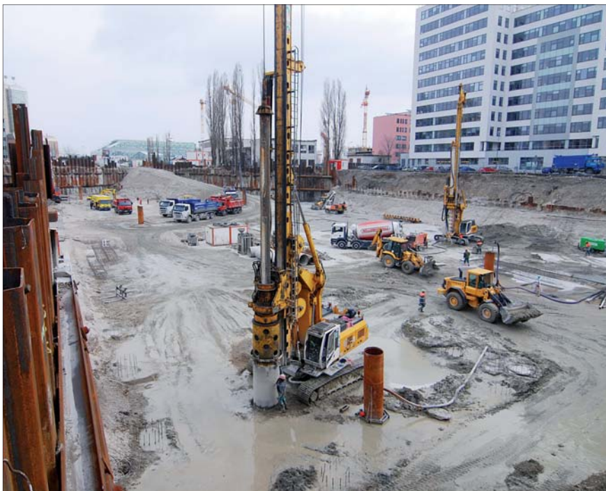
Provádění velkoprofilových pilot ze dna stavební jámy, v pozadí technologie CFA
