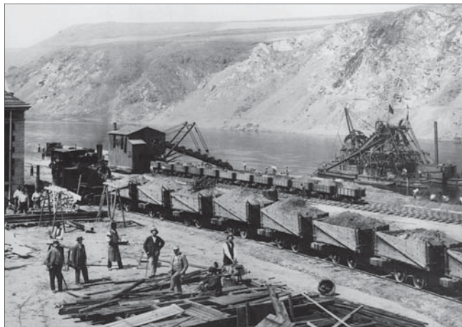
Zdymadlo v Klecanech stavěla také firma A. Lanna. Na fotografii z 12. 8. 1897 se představují vedle dvou lokomotiv korečkové rypadlo Lübeck a na vodě elevátor z Pražské akciové strojírny.
