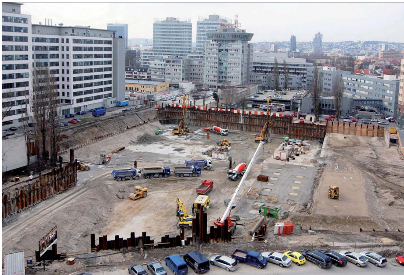
Celkový pohled na staveniště od východu
