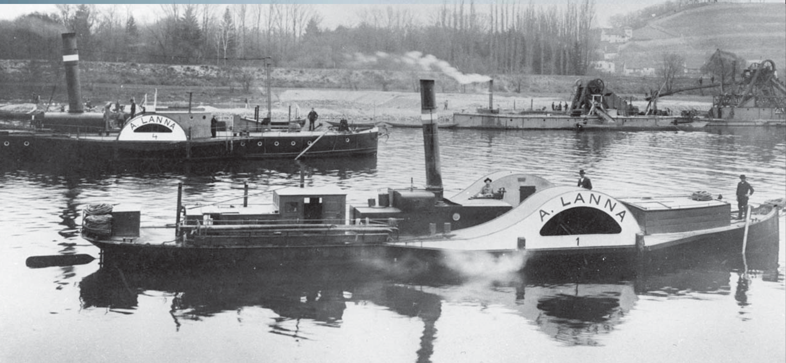
Část plovoucí techniky firma A. Lanna u Dolních Beřkovic 7. 11. 1904: vlečné kolesové parníky 1 (výrobce ÖNWDG Drážďany 1890) a 4 (Pražská akciová strojírna 1900), parní bagr a elevátor.
