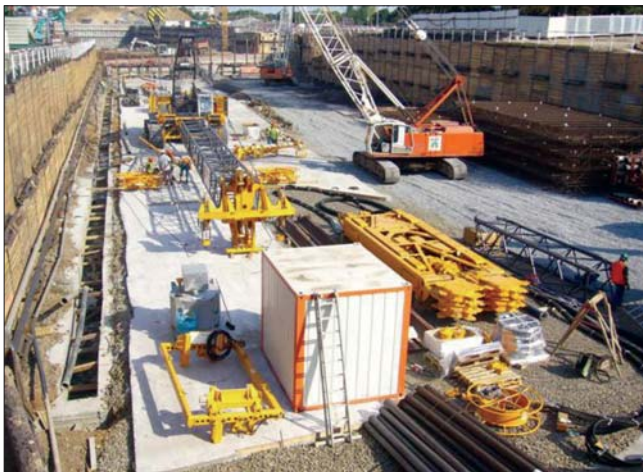
Montáž frézy na staveništi
