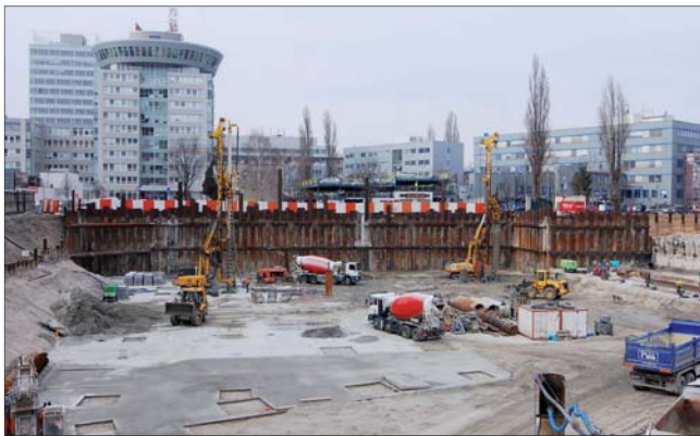
Stavební jáma zapažená štětovou stěnou, kotvenou ve dvou úrovních, západní část u Plynárenské ulice
