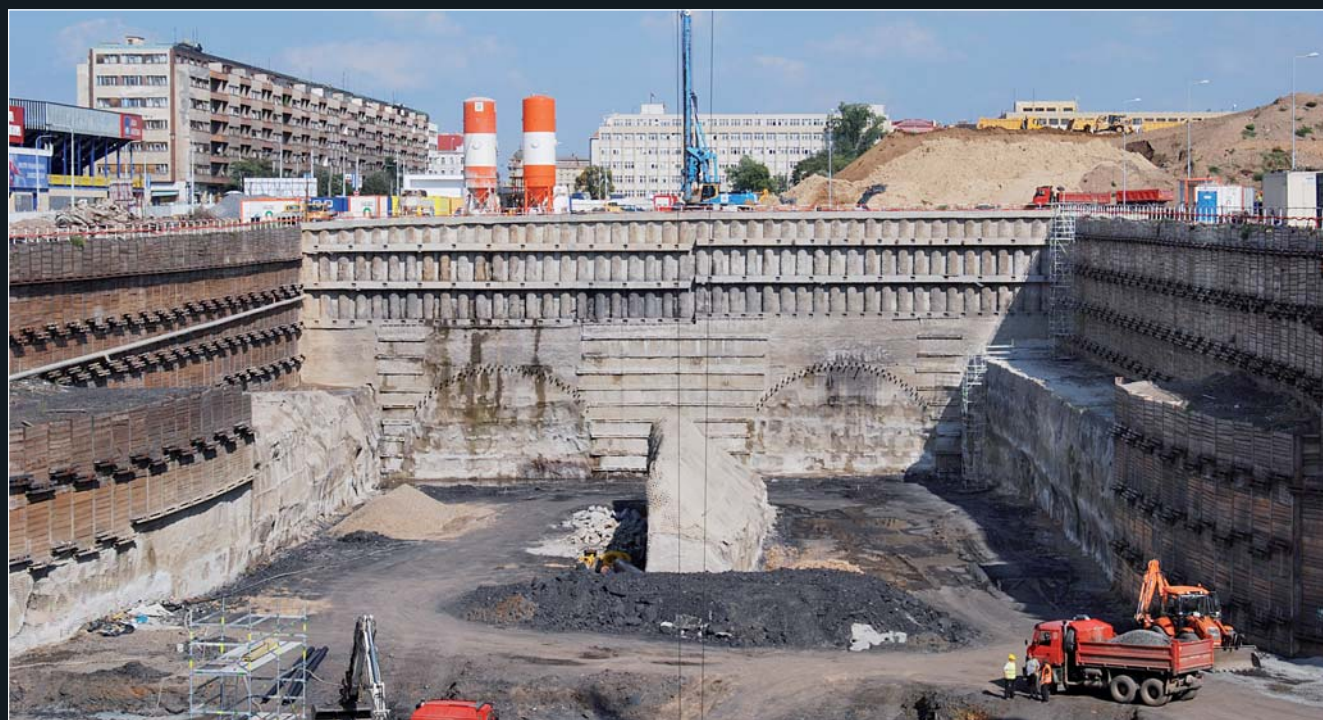
Zajištění portálové stěny kotvenou pilotovou stěnou (v horní části) v kombinaci s kotvenými mikropilotami a stříkaným betonem (ve spodní části), kde se nachází již skalní hornina. Vlastní profil tunelů je zajištěn ocelovými hřebíky a mikropilotovým deštníkem.
