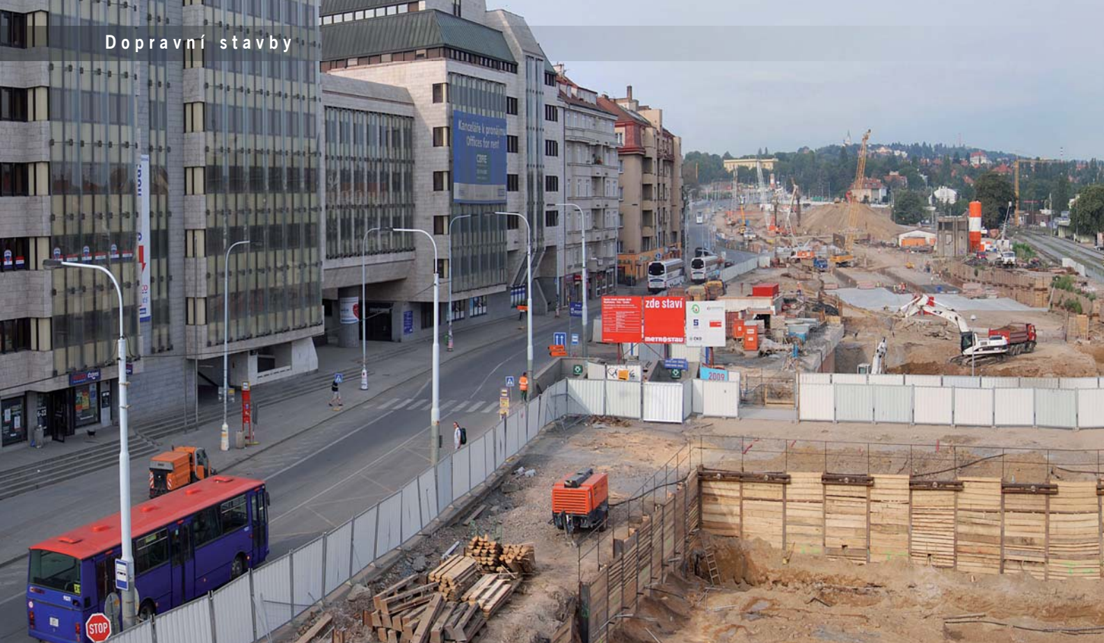
Stavební práce na třídě Milady Horákové, stavba č. 0080, pohled od Špejcharu na západ
