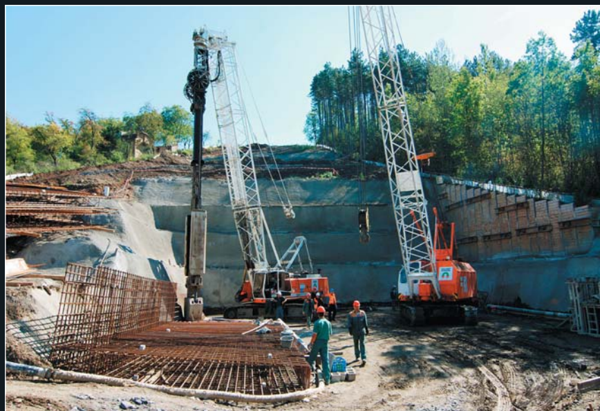
Hloubení lamel krabicového založení podpěry P3
