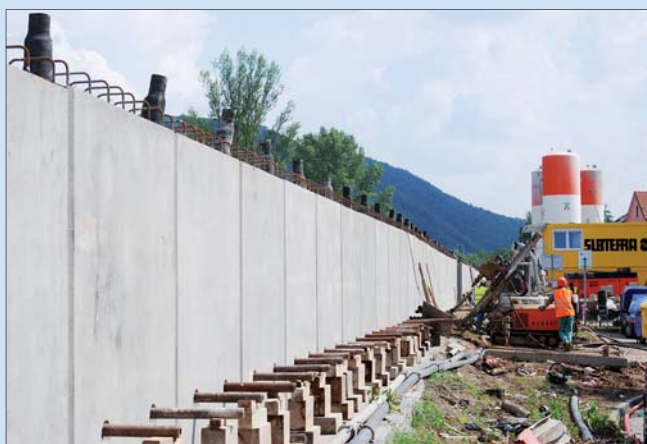
Prefabrikovaná podzemní stěna během osazování tahových mikropilot
