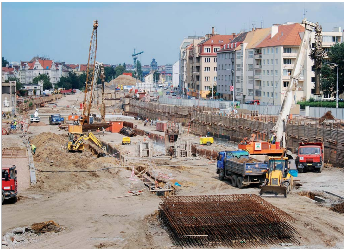
Stavební práce na dilataci D, pohled směrem ke stanici Hradčanská
