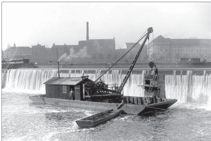
Při opravě Helmovského jezu v Praze se na počátku 40. let uplatnila kesonová loď firmy Lanna, vybavená kromě parního dmychadla i ručním „Prášilovým“ jeřábem pro manipulaci s kesonem. Ten sloužil jen pro práce na dně řeky a nebyl určen do základů některé vodní stavby.
