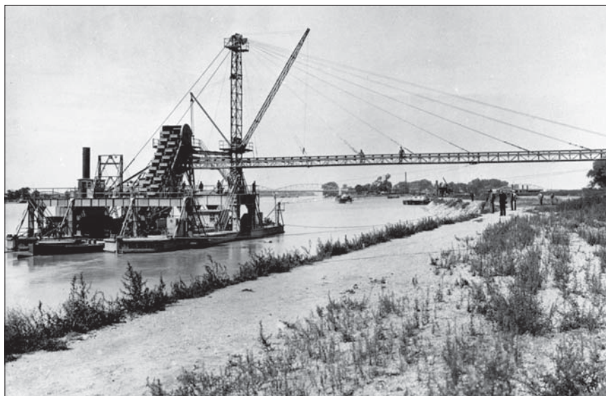
Největší plovoucí korečkový stroj u nás představoval státní elevátor RADHOŠŤ pro udržovací práce na Dunaji. Vyrobila ho Akciová společnost dř. Škodovy závody jako potomek firem Ruston a Bromovský.
