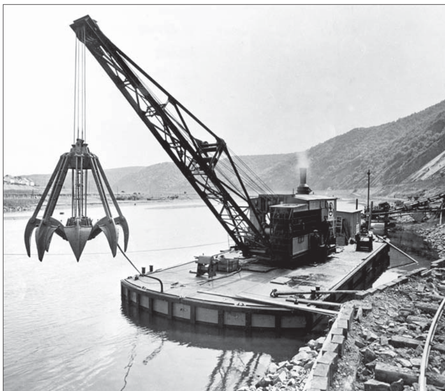
Jediný parní drapák vyrobila firma Škoda v roce 1932 pro podnikatele Ing. Hlavu, budujícího tehdy jez ve Vraném nad Vltavou. Drapák, obecně nazývaný podle typu koše „polyp“, se podílel ještě na stavbě Orlické přehrady. (foto J. Starec)
