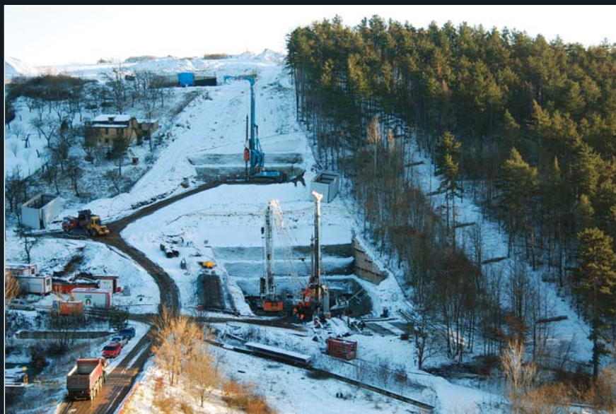
Stavební jámy podpěr mostu na jižním svahu Lochkovského údolí
