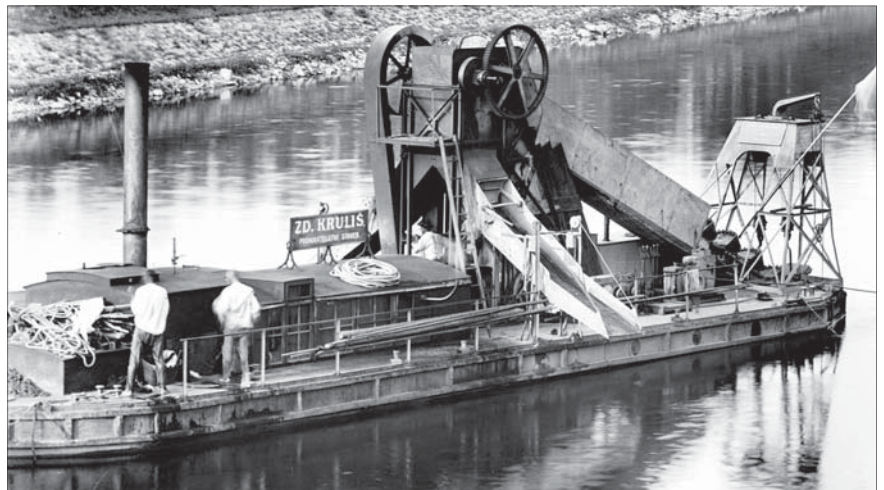
Parní bagr Breitfeld – Daněk podnikatelství Zd. Kruliš bagroval před první světovou válkou u Živanic na Labi přibližně 30 metrů krychlových za hodinu
