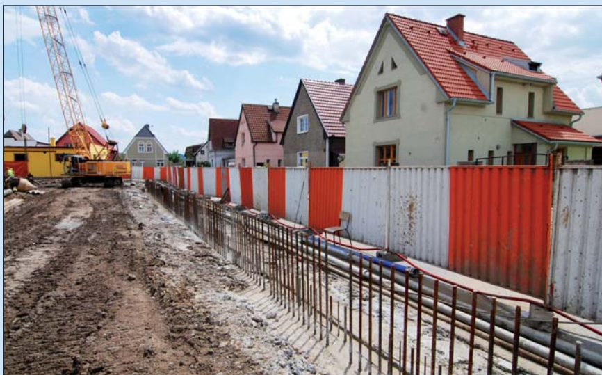
Dokončená monolitická podzemní stěna před napojením nadzemní části z žb. stěny, ulice U Jankovky v Radotíně
