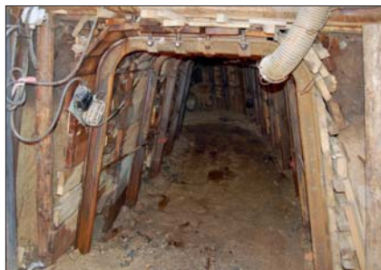
Ražená štola pro přeložení kanalizace pod ještě nevykoupěnými pozemky budoucích tunelů
