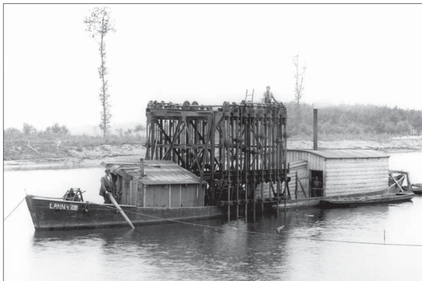
Drticí loď firmy Lanna, rozbíjející svislými dláty opuku na dně Labe u Kovanic v září 1925, byla unikátem. Nevíme ani, kdo zajímavý stroj vyrobil.
