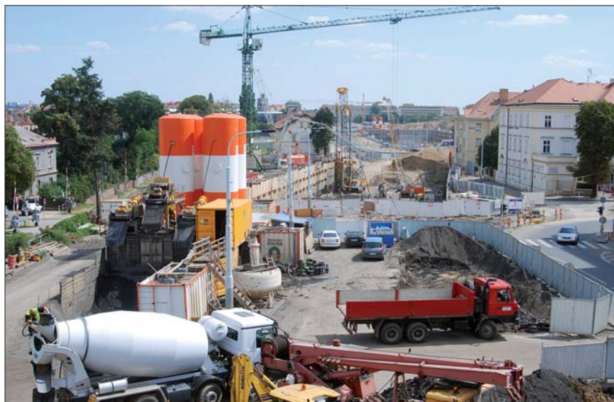
Pohled od stavby č. 0080 k Letné a navazujícímu úseku stavby č. 0079, kde probíhá těžba podzemních stěn frézou, vlevo dekantační zařízení
