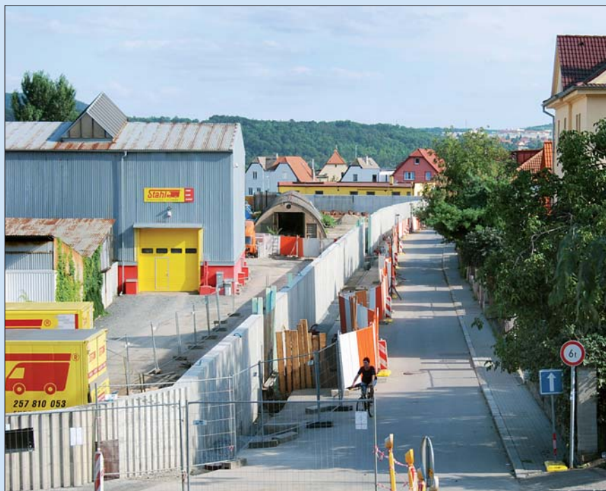
Protipodvodňová stěna před dokončením, ulice U Jankovky, Radotín
