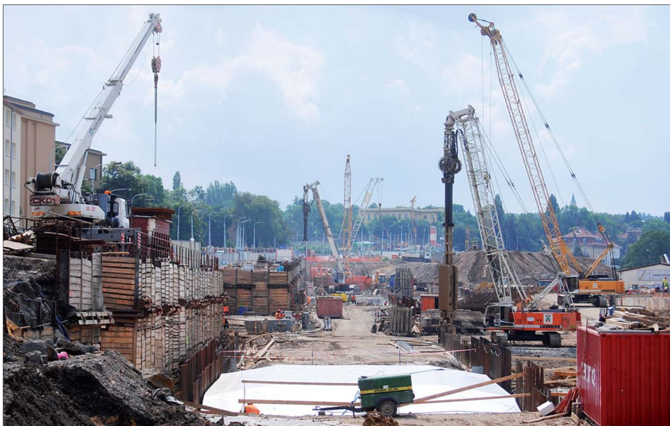
Budování podzemních stěn na jižní a střední části budoucích tunelů
