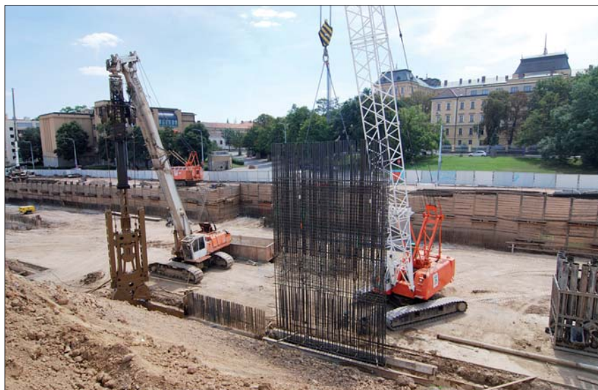
Osazování armokoše podzemní stěny do vyhloubené rýhy
