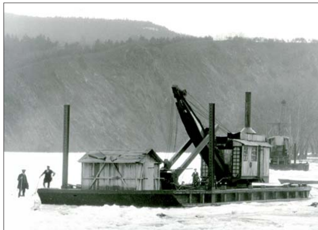
Firma Kruliš byla u nás jediná, která trvale využívala lopatové rypadlo na pontonu. Stroj s lopatou 1,5 m 3 vyrobila roku 1925 strojírna Orenstein & Koppel. Na fotografii z ledna 1928 ve Štěchovicích jsou vidět dvě ze čtyř opěr, které musely být při práci vzepřeny do dna řeky. Později bylo rypadlo s pontonem přestěhováno na stavby vážské kaskády.
