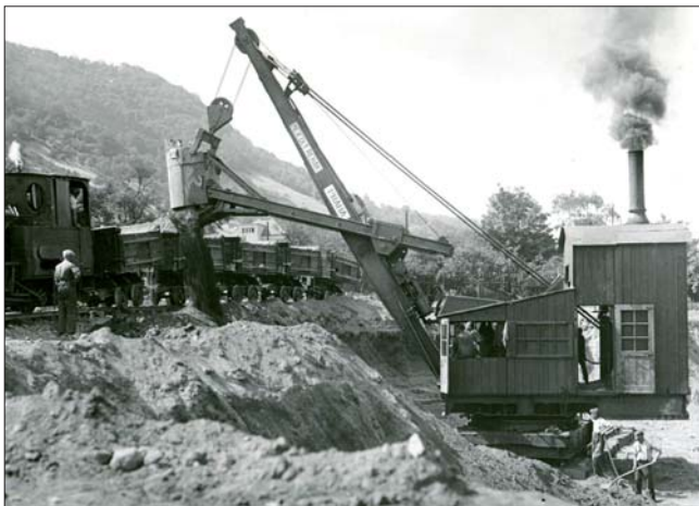
V roce 1923 vyrobila Akciová strojírna, dříve Škoda, pro firmu Nejedlý – Řehák dvě velká parní lopatová rypadla s lopatou 2 m 3 , z nichž jedno na fotografii v červnu 1930 právě hloubilo jámu pro vodní elektrárnu ve Střekově. Parní stroj, viditelný na výložníku, ovládal nejen vysouvání lopaty, ale podle patentu výrobce také otevírání jejího dna.
