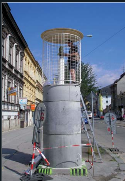
Obr. 1: Monument Palackého–Dobrovského při instalaci systému
