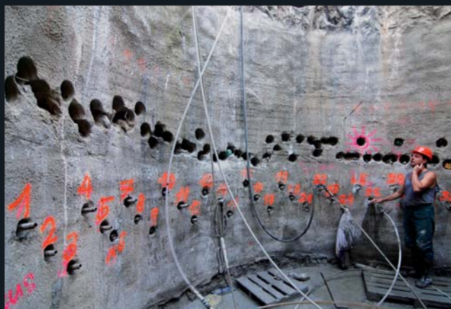
Obr. 7 a 8: Pohled na injektční vrty pro kompenzační injektáž s osazenými manžetovými trubkami a na výše položené návrtné body pro subhorizontální clonu z TI, šachta 04
