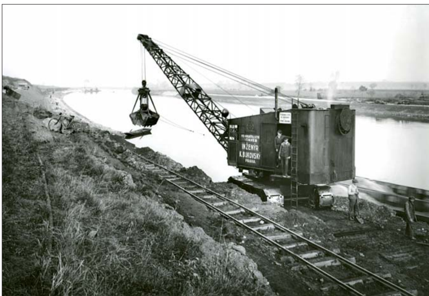
U starších parních lopatových rypadel se v případě potřeby odmontovala lopata a na její zdvihač í lano se zavěsil drapákový koš. K novějším rypadlům se už dodávaly zvlášť upravené drapákové výložníky. Motorové rypadlo Menck & Hambrock typu M IV v drapákové úpravě použila firma Bukovský v letech 1931–32 u Brandýsa nad Labem.
