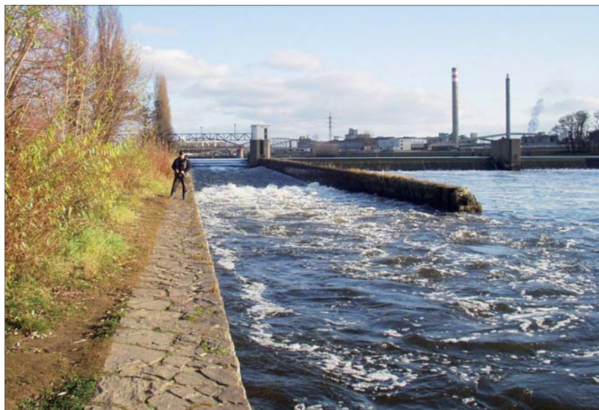
Pohled na vorovou propust a pilíř jezu z dolní vody před zahájením prací na MVE
