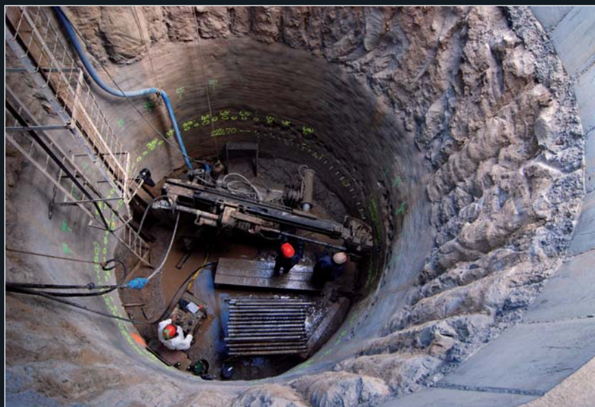
Obr. 3: Pohled do šachty při hloubení vrtů pro osazení injekčních trubek
