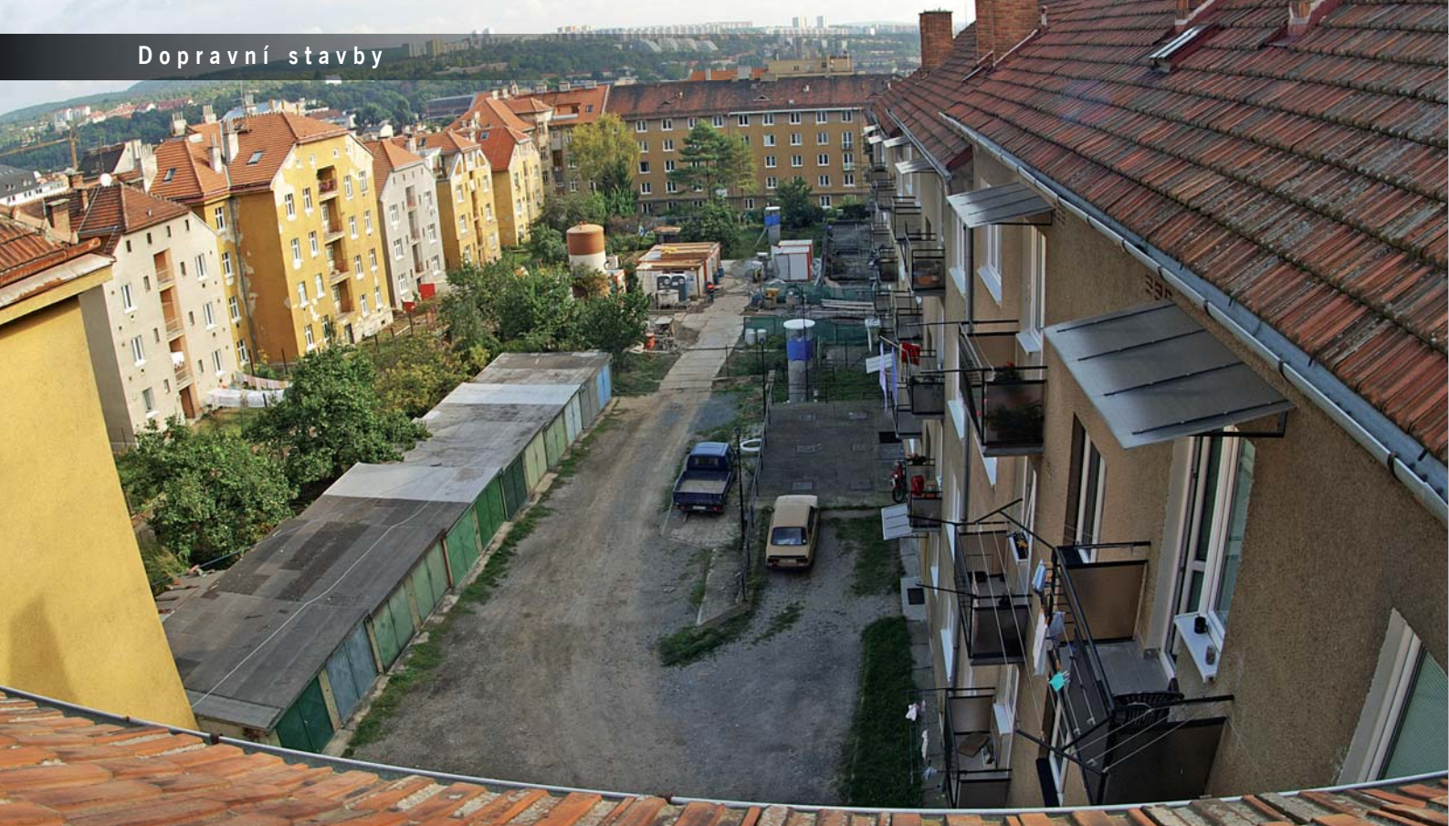
Obr. 1: Pohled na objekty bloku bytových domů, vybraných pro zabezpečení metodou kompenzační injecktáže
