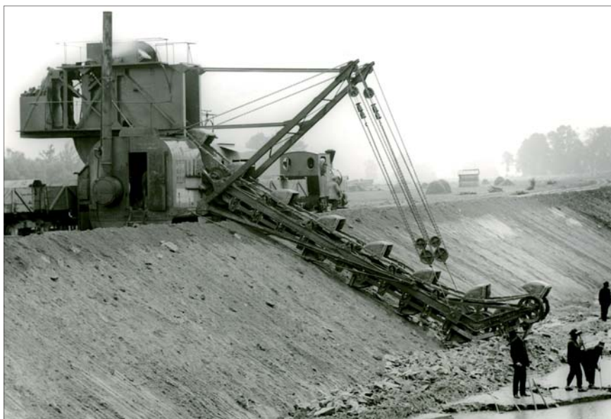
Parní rypadlo, vyrobené strojírnou DMS v Drážďanech roku 1907, používala firma Kruliš při hloubení nového řečiště Labe u Živanic v červnu 1909 se saněmi pro pevné vedení spodní větve korečkového dopravníku, navíc s úhlovým zakončením. Stroj o výkonnosti 90 m 3 /h ale mohl pracovat i s volně prověšeným řetězem.
