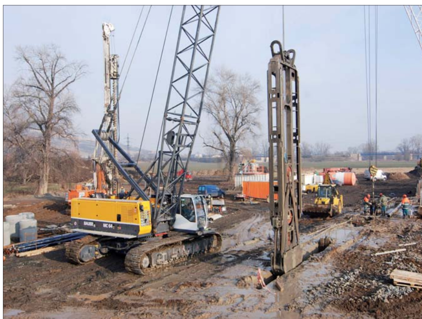
Hloubení podzemních stěn v místě budoucí strojovny MVE
