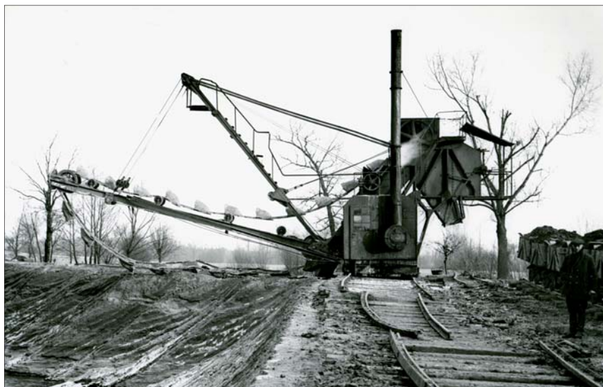
Podnikatelství Kapsa & Müller si na počátku 20. let pořídilo od radotínské firmy Ferrovía menší parní korečkové rypadlo, nápadně připomínající stroje vyrobené firmou Orenstein & Koppel. Na fotografii, pořízené v prosinci 1932 ve Starém Kolině, se stroj přesouvá do dalšího řezu.
