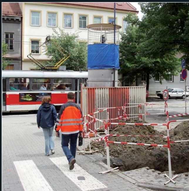
Obr. 5: Monument na nároží ulic Pešínova–Dobrovského – kontrola systému
