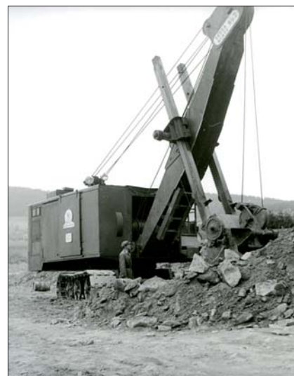
Licenční provedení motorového rypadla Škoda-Menck typu Mb2 s lopatou 1 m 3 na stavbě přehrady Lipno v roce 1952. Německé stroje typů Mb a Mc se u nás začaly vyrábět během druhé světové války, kdy byly bombardovány továrny v Německu, a jejich produkce pokračovala ve Škodě a ČKD i po válce.
