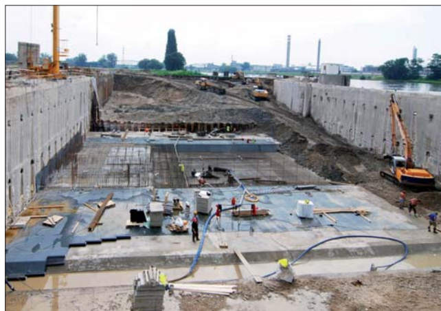
Pohled do stavební jámy z místa výtoku z MVE během provádění základové desky strojovny
