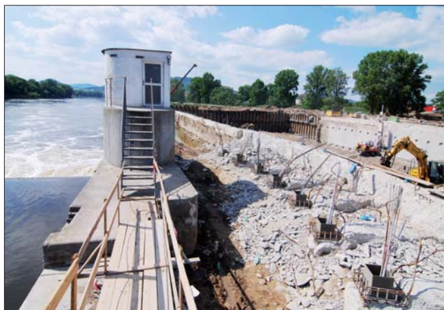
Hlavy kotev T-lamel podzemních stěn vedle pilíře jezu
