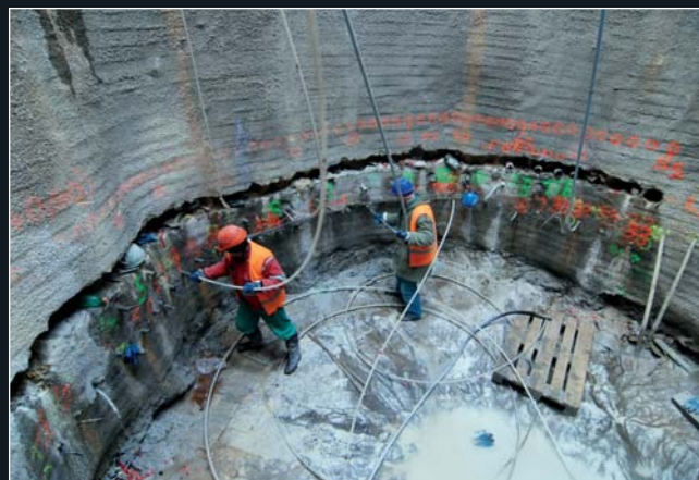
Obr. 7 a 8: Pohled na injektční vrty pro kompenzační injektáž s osazenými manžetovými trubkami a na výše položené návrtné body pro subhorizontální clonu z TI, šachta 04
