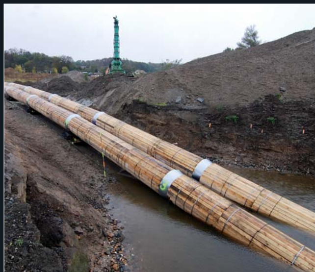
Potrubi shybky během zatahování na dráze o poloměru 300 m
