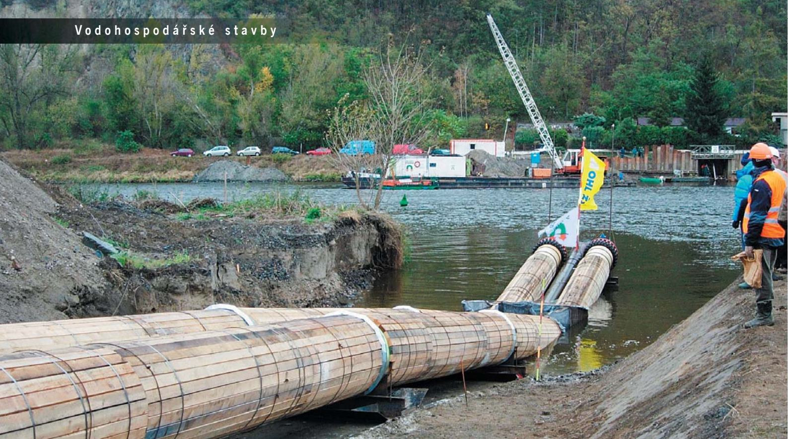
Čelo zatahované části shybky právě dosáhlo vodní hladiny, v pozadí je ve štětové stěně vidět zatahovací „komůrka“ se zatahovacím lisem
