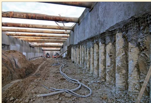
Pilotová stěna tunelu I
