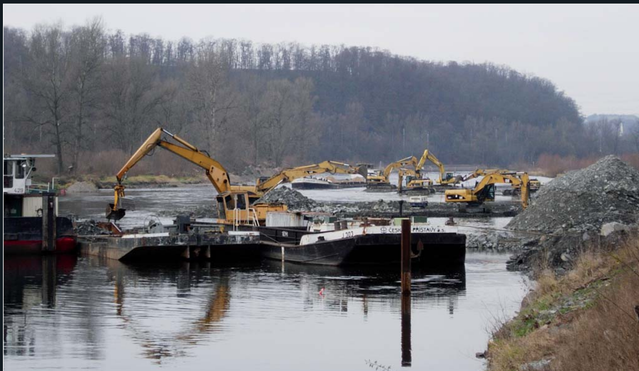
Provádění tvrdé prohrábkky ze tří plošin nasypných v řece
