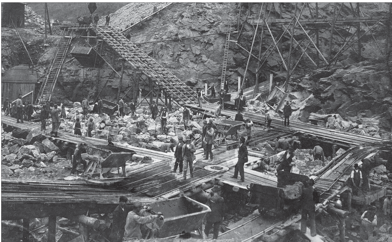
Pro dopravu kamene a malty do základů zděné hráze přehrady Janov sloužily dvě dvoukolejné svážnice. Vpravo nahoře je na fotografii z 3. 5. 1912 vidět dřevěný žlab pro převedení jednoho z potoků.
