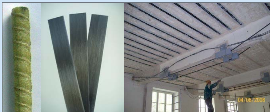
Vlevo: vnitřní kompozitní výztuž PrefaREBAR ze skleněných vláken, uprostřed: vnější uhlíková výztuž PREFEN FS, vpravo: aplikace zesilovacího systému PREFEN FS pro zvýšení nosnosti stropů.
