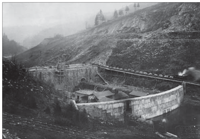
Na staveništi Labské přehrady firmou Redlich & Berger byly 14. 9. 1913 vyfotografovány dvě parní lokomotivy drážky pro dovoz kamene a dalšího materiálu. Kvůli kolejím byl vytvořen otvor v ochranné hrázce, v popředí je část svážnice. Foto W. Pfohl.
