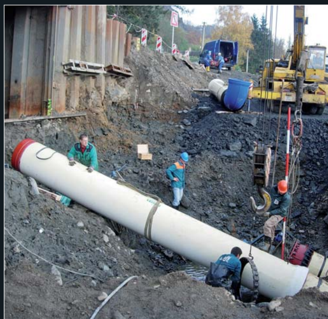
Napojování potrubí na konec shybky ve vyčerpané pravobřežní jímce
