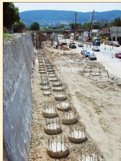
Pilotové založení zadní stěny galerie objektu C 211
