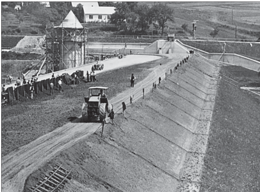
Sypaná hráz přehrady ve Fryštáku na Zlínsku vznikla ve 20. letech minulého stol. z materiálu vybagrovaného z budoucí nádrže parním korečkovým rypadlem. Do hráze ho vozily motorové lokomotivky a zhutňovaly ho traktory s vlečnými rýhovanými válci.
