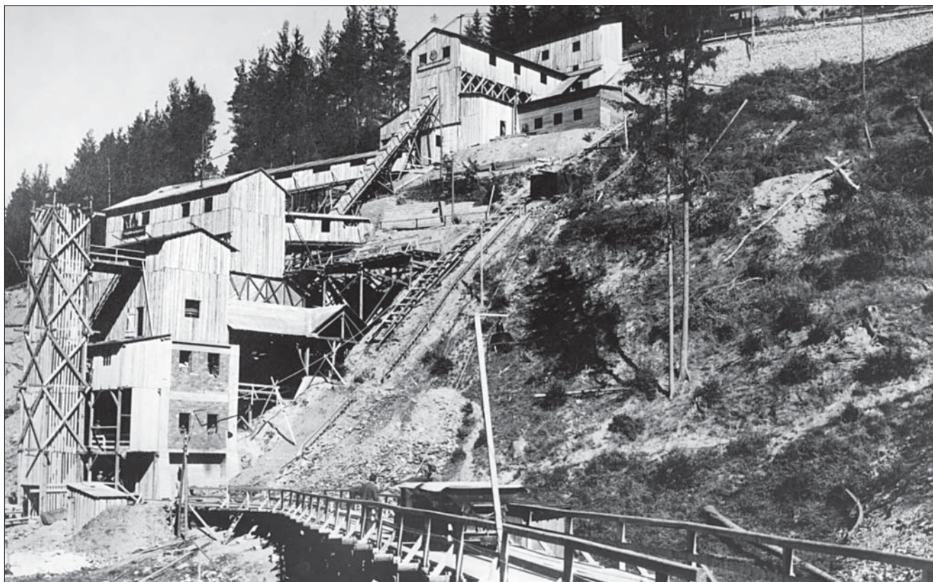
Betonárna na stavbě přehrady Vír na Svatce byla postavena z velké části ze dřeva. Na snímku ze srpna 1949 je vedle ní vidět část opuštěného kolejového výtahu, nahore na zdi stojí parní lokomotiva šterkové dráhy rozchodu 900 mm, dole je drážka rozchodu 600 mm pro odvoz betonu k jeřábům. Zaústění lanovky, dovážející z nádraží cement, není vidět.
