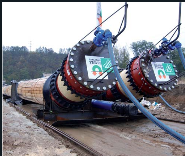
Koncová část šyby v průběhu zatahování; zřetelně je vidět funkce „saní“, osazené hadicemi pro dopouštění potrubí vodou
