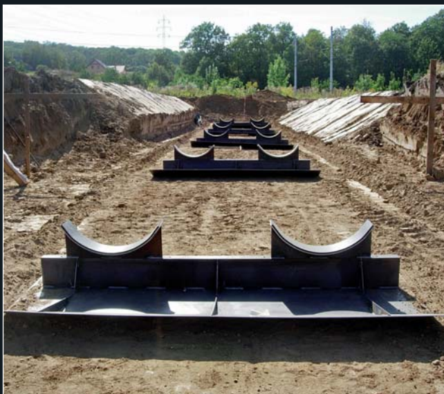
Montážní plocha na levém břehu s položenou montážní a spojovací konstrukcí
