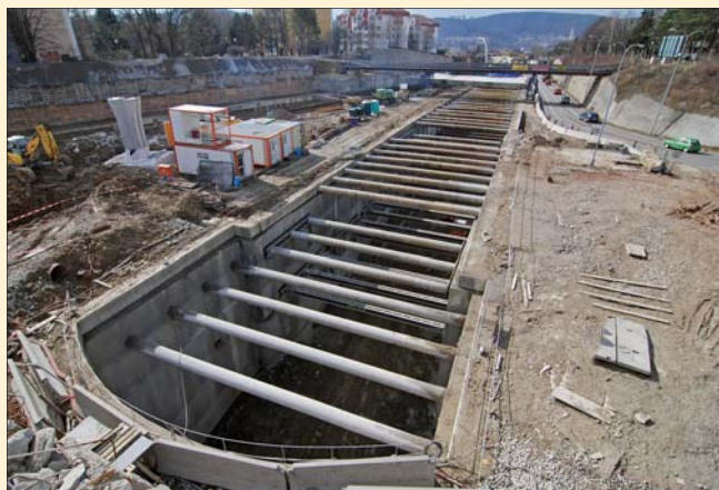
Hloubená část tunelu I a provizorní portál rozeptřené trubními rozpěrami
