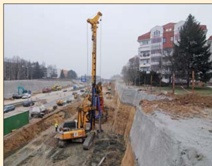
Souprava BG 18 při hloubení vrtů pro piloty na objektu C 211 – galerie na větví H4
