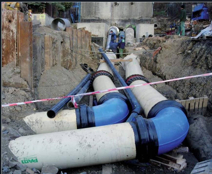
Dokončení montáže potrubí v zapáženém výkopu a napojení potrubí do pravobřežní armaturní komory
