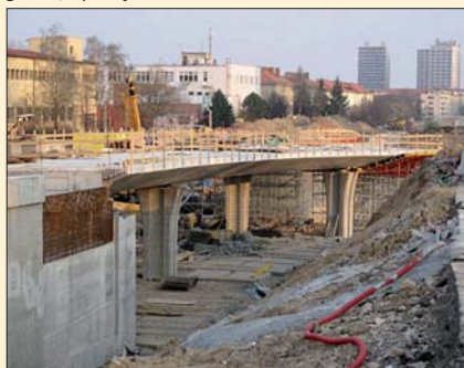
Část mostního objektu C 202 na Hradecké ul. přes rondel založená na velkopřůměrových pilotách
