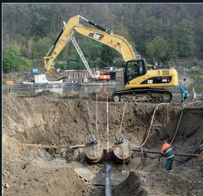
Levobřežní čelo shybky po vyčerpání vody z břehové jímky
