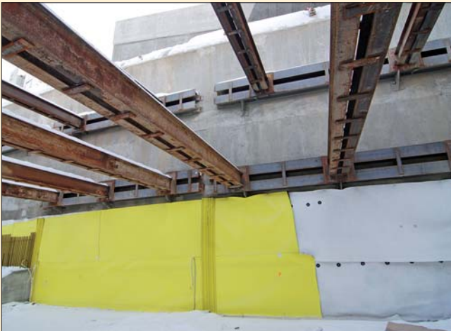
Hloubená část tunelu II rozepřena ve dvou úrovních, položena je izolace pro armování a betonáž dna tunelu
