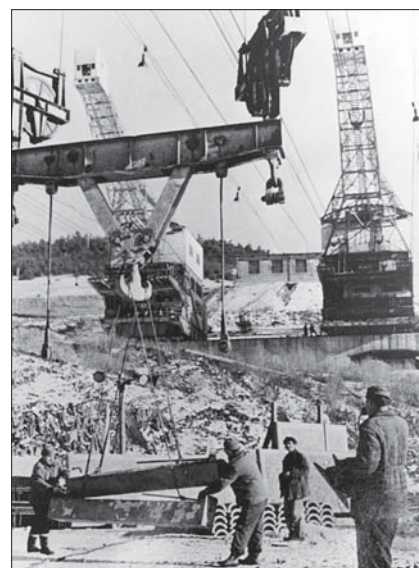
Dvojici dvacetitunových kabelových jeřábů dodal pro stavbu přehrady Orlík v 50. letech minulého stol. podnik Transporta Chrudim. Velín jeřábu byl v budce, vystrčené na „žirafím“ krku.
