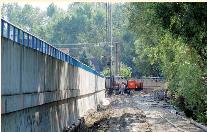
Vrtná souprava HVS JET při realizaci 1. fáze z púlslouppú tryskové injektáže
