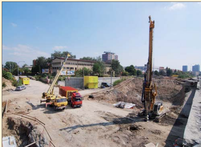
Vrtná souprava BG 18 při hloubení příčných clon z pilot (pomocná opatření pro ražbu), objekt C 618 tunelu I
