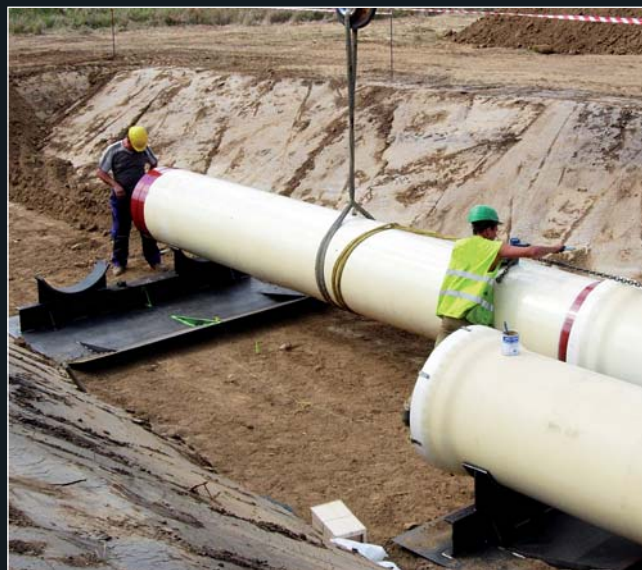
Montáž potrubí šyby na montážní a spojovací konstrukci
