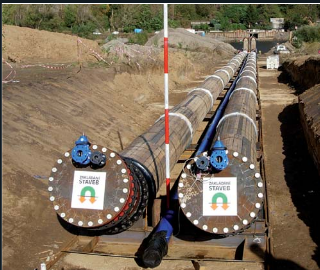
Dokončená zatahovaná část šyby s ochranným dřevěným obedněním před zatažením do rýhy v řece
