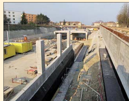
Přední a zadní stěna galerie na větví H4, založené na velkopřůměrových pilotách (v pozadí definitivní portál Královopolského tunelu)
