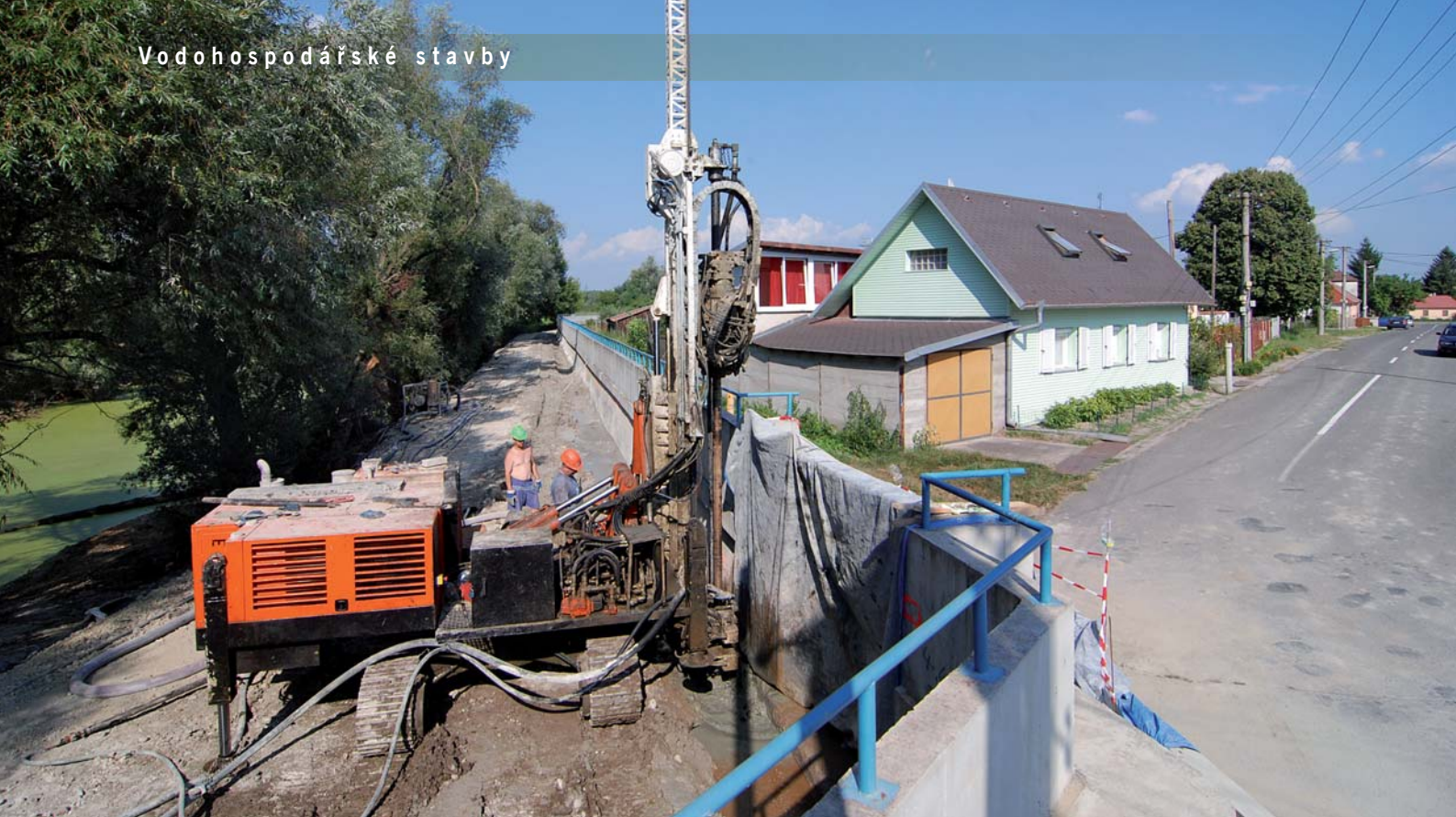
První fáze tryskové injektáže – realizace půsloupů
