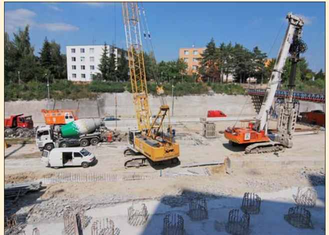
Provádění podzemních stěn definitivního portálu
