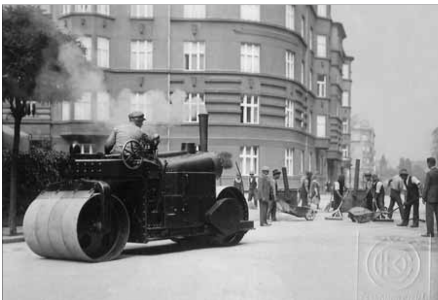
Nejmenší parní válec typu AT vyrobila ČKD jen ve čtyřech exemplářích. Na konci 20. let se tento tandemový válec předváděl v Praze na Žižkově při asfaltování vozovek, o deset let později si jeden koupila stavební firma Beneš.
