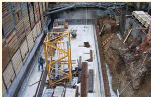
Definitivní výkop, provádění základové desky a montáž jeřábu
