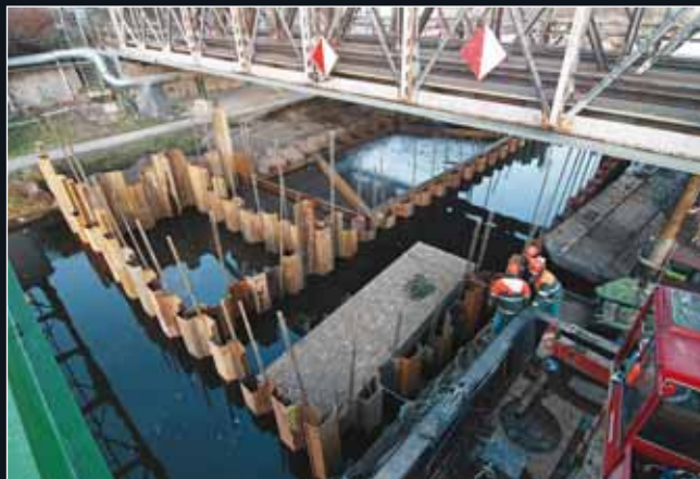
Beraněnské štětové stěny pro jímku pilíře P3
