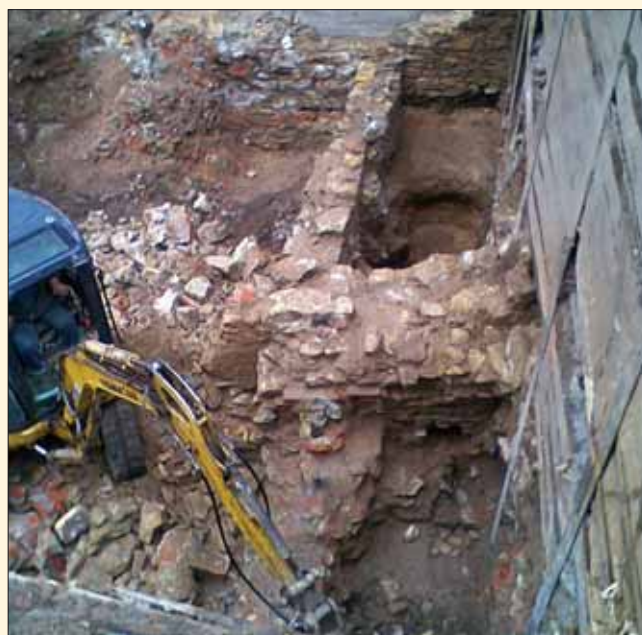
Zemní práce v místě výskytu suterénního zdiva starého objektu
