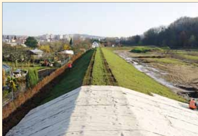
Protipovodňová zemní hráz u zahrádkářské kolonie
