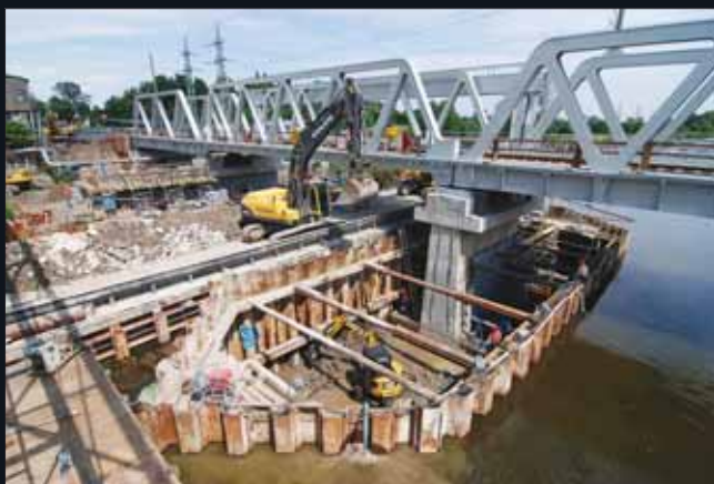
Jímka u pilíře P2, dotěžování na základovou spáru před budováním druhé poloviny pilíře
