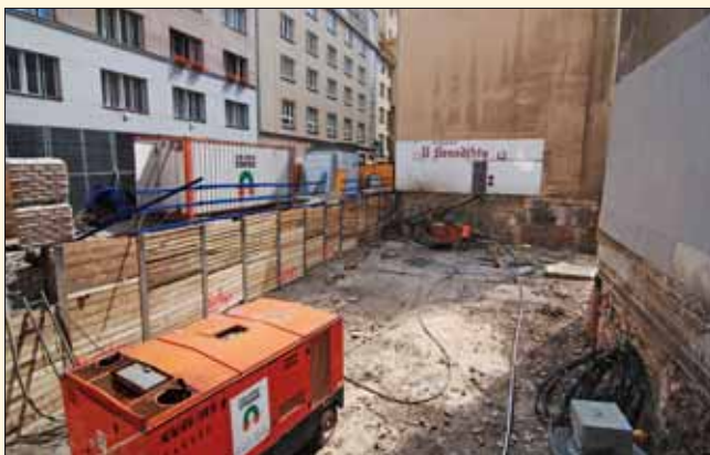
Výkop stavební jámy pro provádění 1. kotevní úrovně
