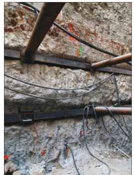
Ocelová konstrukce je u objektu Zlatá husa rozepřena do stěny z nově vytvořených sloupů tryskové injektáže
