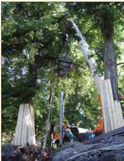
Beranění štětové stěny na Nábřeží krále Jiřího
