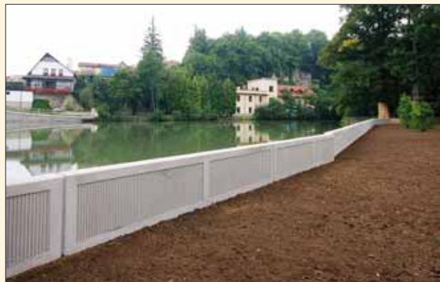
Ochranná zeď nad horním válcovým jezem
