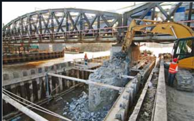
Odbourávání původního dřívku pilíře P4 v místě budoucího nového pilíře P2
