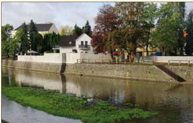
Pohled na pravý břeh pod spodním válcovým jezem
