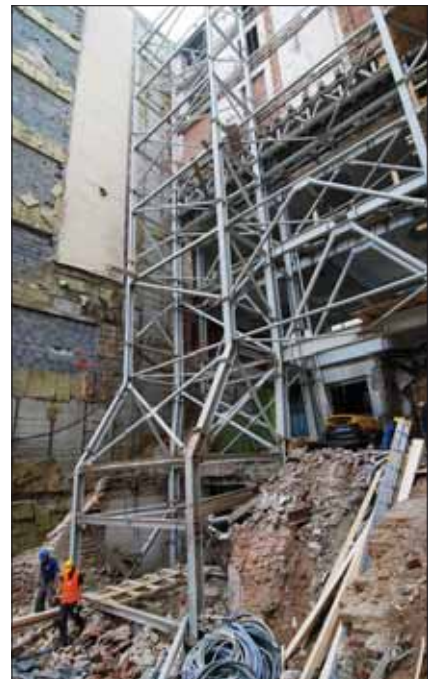
Provizorní ocelová konstrukce
