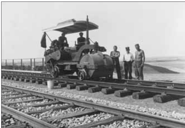
V letech 1930–31 si ČSD pro novostavby tratí a výstavbu druhých kolejí obstaraly deset motorových válců Tatra (licence Kemna) s hmotností 5 až 7 tun. Válcové byly vybaveny přídatným zařízením pro přesun vlastním pohonem po kolejích.
