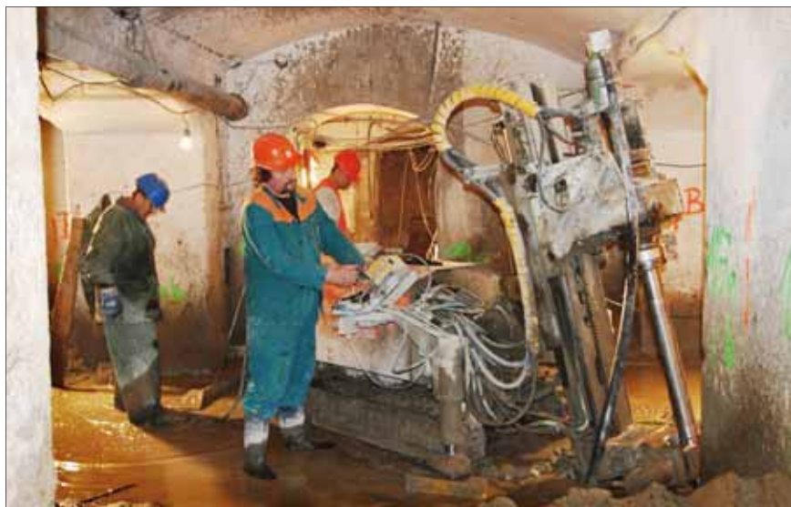
Provádění tryskové injektáže v prostoru 2. PP původního objektu
