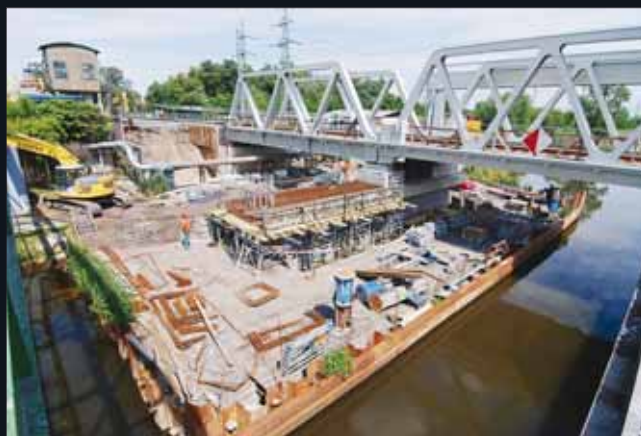
Dvojitá jímka u pilíře P3, budování druhé poloviny nového pilíře
