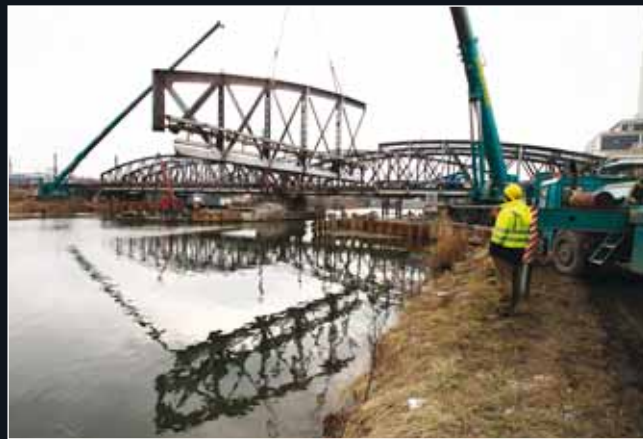
Demontáž návodní poloviny staré konstrukce mostu
