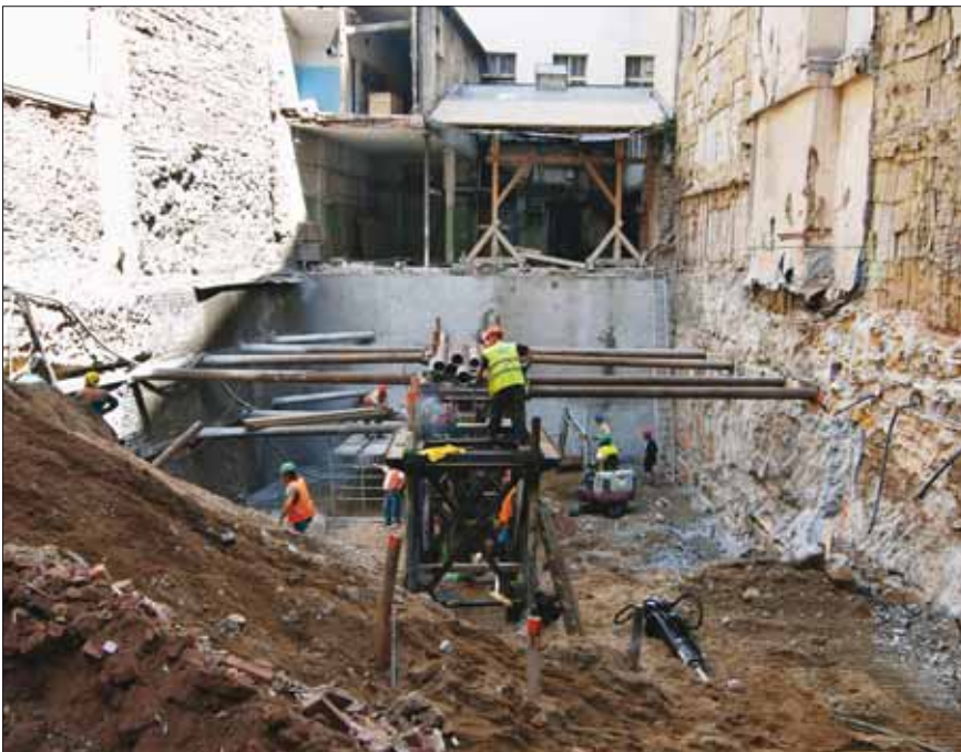
Ve východní části stavební jámy vzniká ocelová rozpěrná konstrukce
