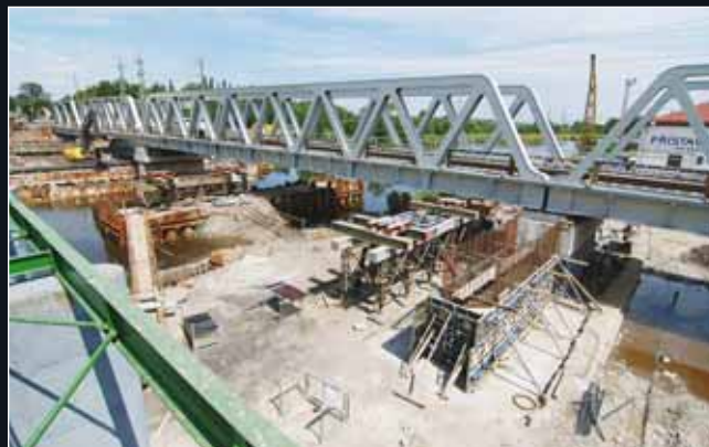
Budování povodní poloviny pilíře P1
