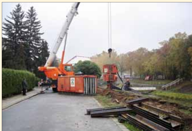
Beranění štetové stěny u Obchodní akademie
