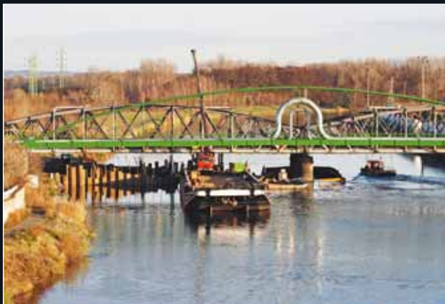
Beraněnské dvojité nasazené jímky pro nový pilíř P3 a pilíř P2 v místě původního pilíře
