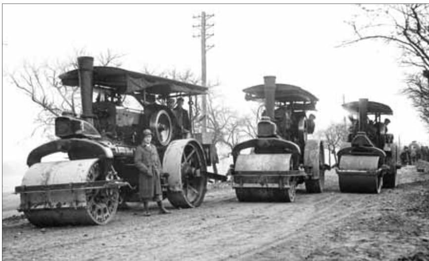
Tři parní válce ČKD podnikatelství Nejedlý, Řehák a spol., při práci na silnici asi v roce 1930. První dva jsou patnáctitunové „mamuty“, napravo asi o čtyři tony lehčí typ M.
