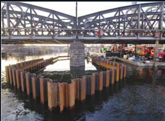
Dosud nedokončená štětová jímka u pilíře P2
