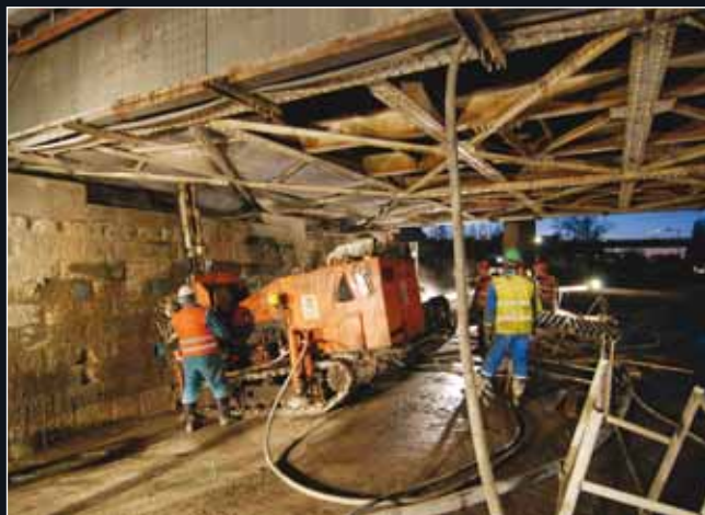
Provádění tryskové injektáže u opěry 01 pod starou konstrukcí mostu
