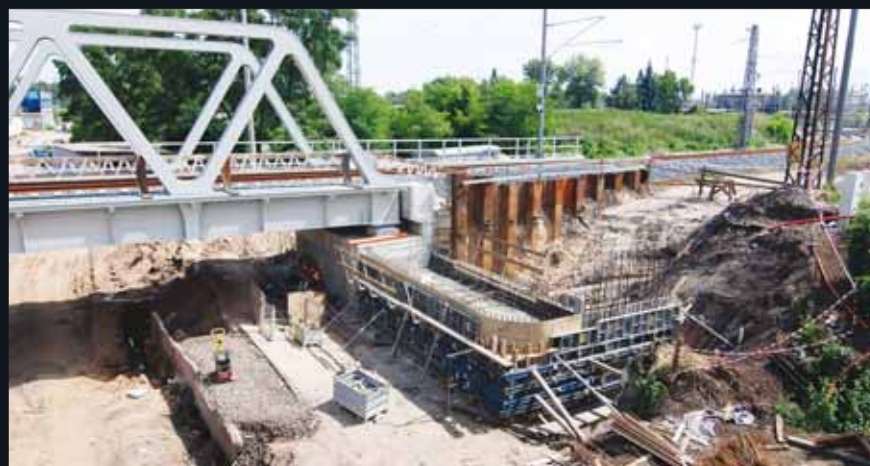
Opěra O1, výstavba druhé části povodní opěry před montáží nové konstrukce
