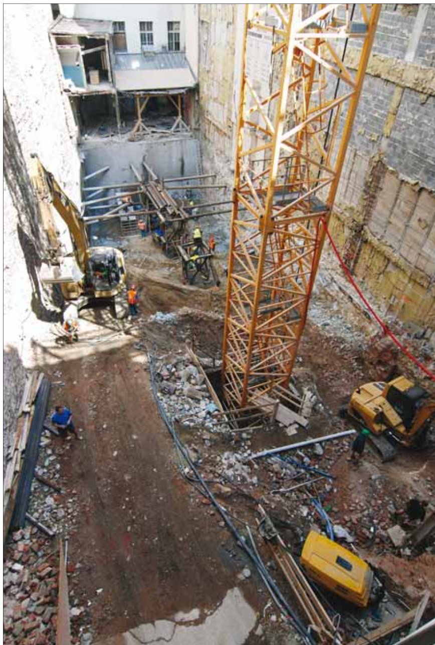
Pohled na stavební jámu z provizorní ocelové konstrukce
