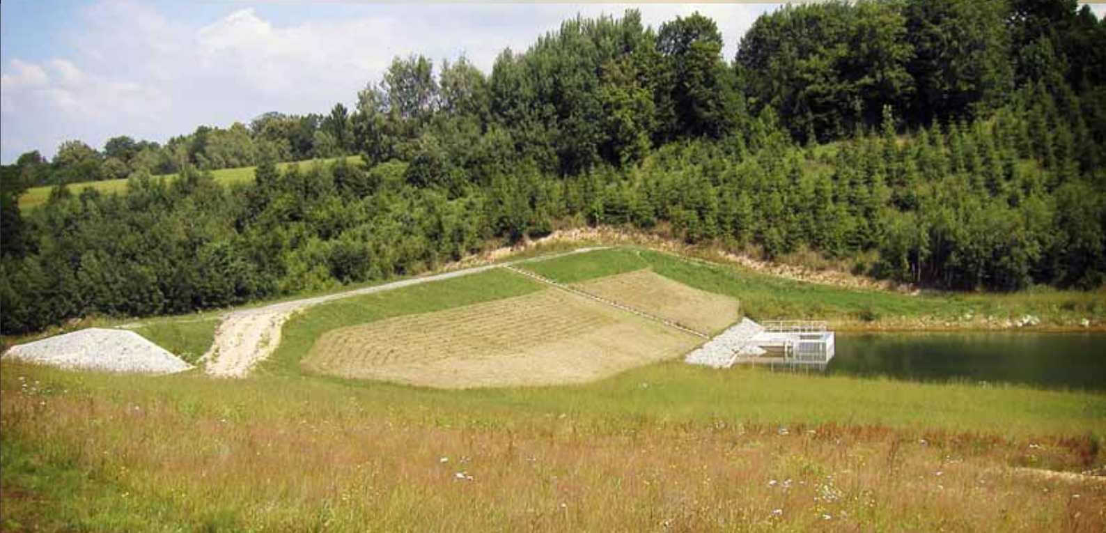
Pohled na hráz poldru č.5
