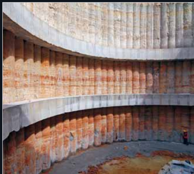
Odtěžená a očištěná stěna montážní šachty na úrovni převážek T2 a T3, prováděna je právě masivní převážka T4 nad klenbou budoucích tunelů metra
