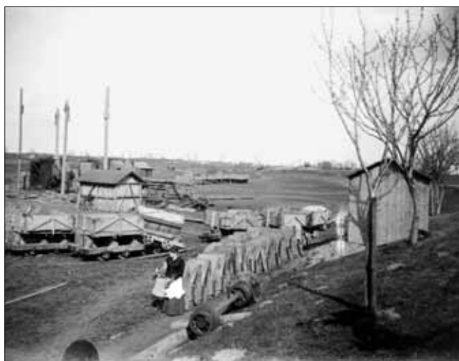
U Přelouče poblíž Lohenic, v místě, kde začínal další průkop nového řečiště Labe, se počátkem dubna 1911 začalo montovat korečkové rypadlo Breiffeld-Daněk. Na prvním obrázku vidíme čtyři sloupy pomocného lešení a vůkol malebně poházené vozíky polní drážky, součásti rypadla a dámu s holčičkou. Pak několik týdnů usilovně pracovali dělníci i příroda. Zatímco stromky obrostly listím, rypadlo je na druhém snímku už téměř sestavené a dámu nahradili zaměstnanci stavební firmy Kruliš. Zbývá ještě smontovat a zavěsit korečkový dopravník, aby se 20. května mohlo začít bagrovat.
