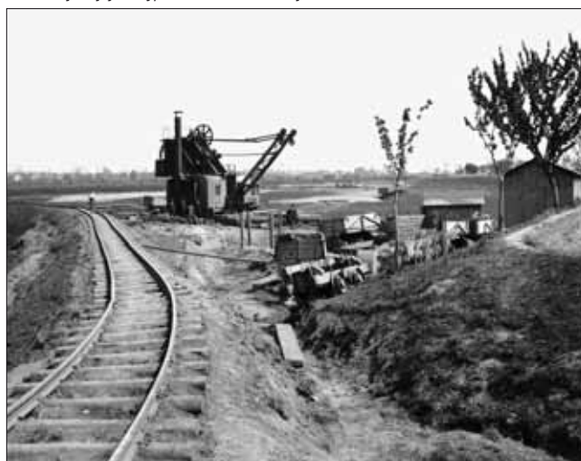
U Přelouče poblíž Lohenic, v místě, kde začínal další průkop nového řečiště Labe, se počátkem dubna 1911 začalo montovat korečkové rypadlo Breiffeld-Daněk. Na prvním obrázku vidíme čtyři sloupy pomocného lešení a vůkol malebně poházené vozíky polní drážky, součásti rypadla a dámu s holčičkou. Pak několik týdnů usilovně pracovali dělníci i příroda. Zatímco stromky obrostly listím, rypadlo je na druhém snímku už téměř sestavené a dámu nahradili zaměstnanci stavební firmy Kruliš. Zbývá ještě smontovat a zavěsit korečkový dopravník, aby se 20. května mohlo začít bagrovat.
