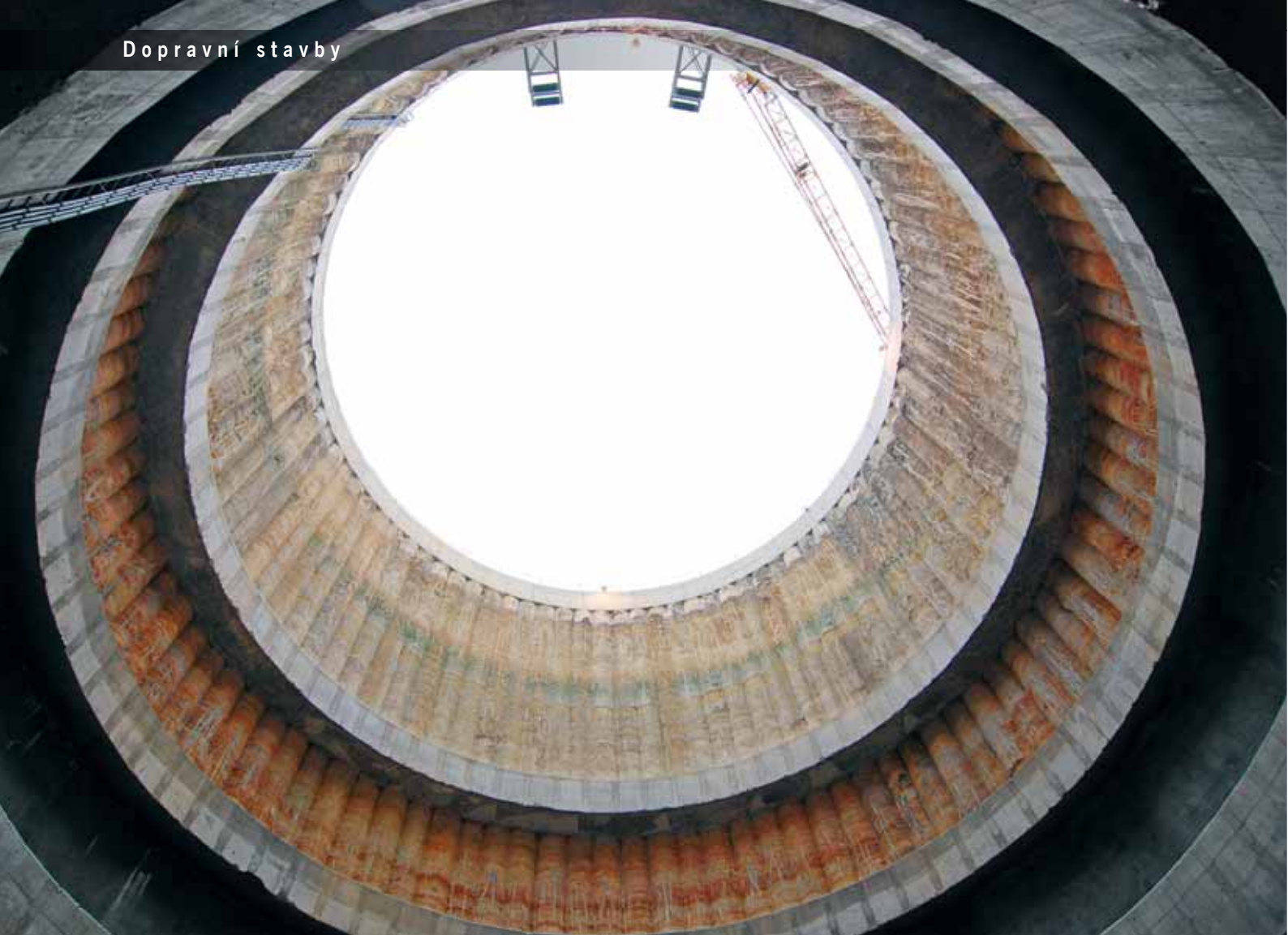
Impozantní prostor montážní šachty hloubky 33,9 m a průměru 24,8 m
