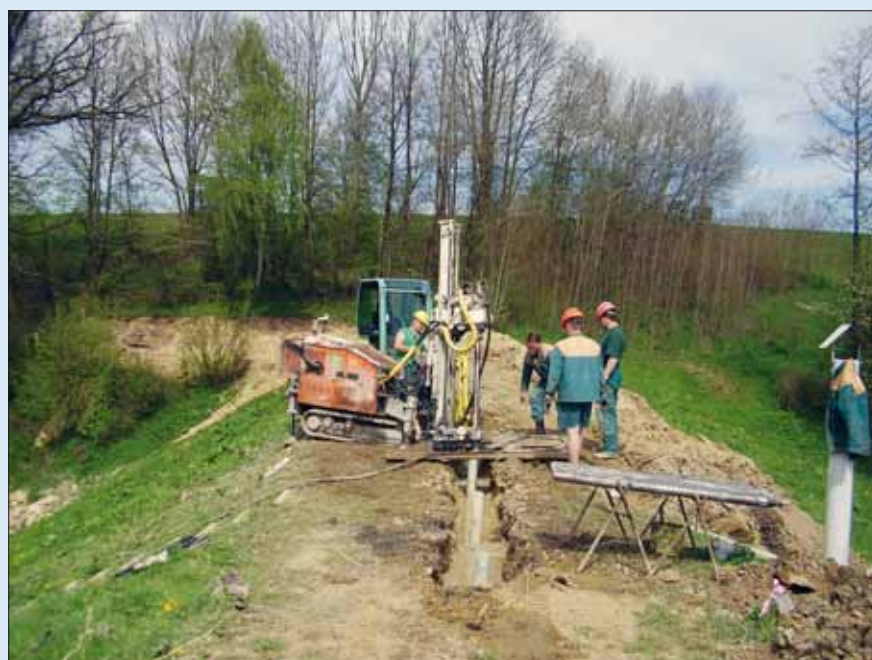
Provádění tryskové injecktáže z koruny hráze
