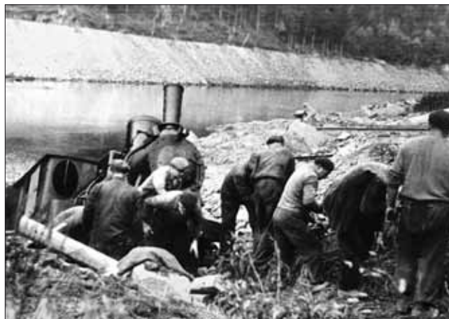
Ne vždycky ale přeprava po vodě skončila úspěšně. Parní lokomotivy, předtím znárodněné společností Lanna, se vozily po Vltavě na stavbu slapské přehrady. V říjnu 1950 se jednu z nich sice podařilo bez problémů vyložit, ale při vytahování po strmém břehu vzhůru povolilo kotvení kladkostroje a lokomotiva sjela dolů. Naštěstí zůstala téměř nepoškozená na břehu a neskončila ve štěchovické nádrži. Obrázek je z jejího vyprošťování v následujících dnech. (foto Mühlbach)
