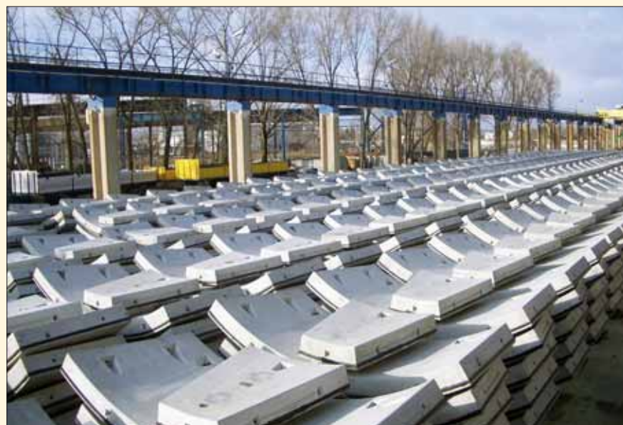
Obr. 13: Skladování segmentů v závodě Prefa Senec
