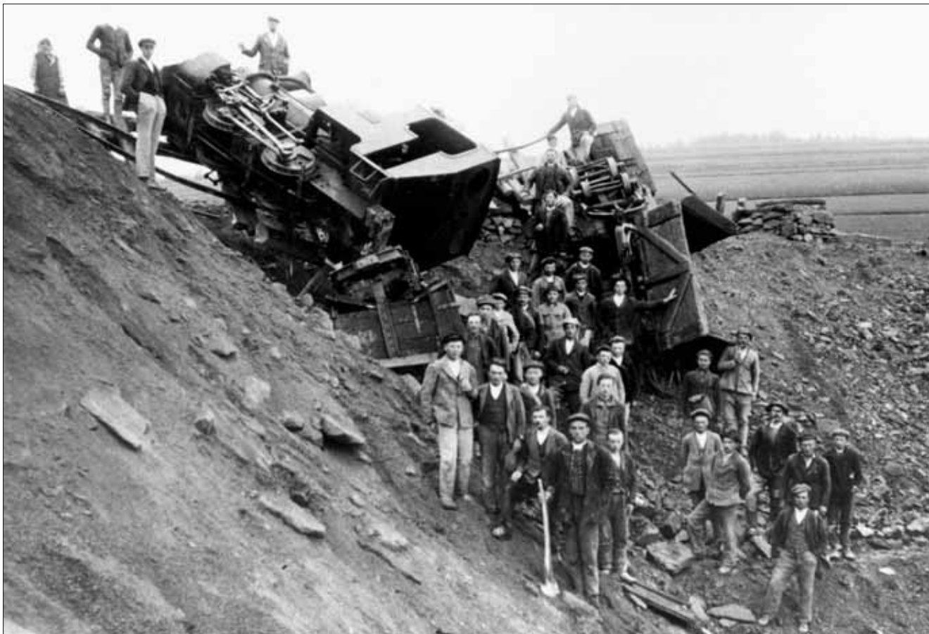
Vykolejení vozíků nebo lokomotiv, pokud se obešlo bez vážnějšího zranění, se přecházelo bez povšimnutí. Vrátit zpátky na koleje vozík trvalo pár minut, s mašinkou to bylo trochu delší, ale pokud se nepřevrhla, i to se dalo s heverem nebo aspoň sochorem a trochou vhodného dříví zvládnout do půl hodiny. Takové nehody, jako je ta na fotografii, se ale často nestávaly. Tady už bylo zapotřebí hodně úsilí a „tvůrčích“ schopností, aby se všechno napravilo. O příčinách nehody dnes nic nevíme, ani o tom, zda se obešla bez následků pro osádku lokomotivy. Stalo se to firmě Nejedlý, Řehák a spol. v roce 1926 na stavbě dráhy u Myjavy v km 36,0. Naspával se tu materiál do náspu a podle obrázku se zřejmě pod mašinou italského původu zřítilo dřevěné lešení v místě, kde ještě nebylo zasypano. Asi tam nanosit spoustu pražců, aby z nich pod mašinou vytvořili podpěru, a pak přijdou na řadu zvedáky, lana a řetězy. Vyprostit vozíky už bude hračka.
