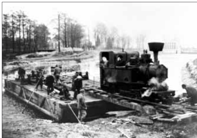
Na mnoha vodních stavbách se sice budovaly provizorní dřevěné mosty pro převážení zeminy z jednoho břehu na druhý, to ale nebyl případ stavby Trilčova jezu v Českých Budějovicích. Když proto pracovníci firmy Litická, a. s., potřebovali v únoru 1938 převézt lokomotivu (výrobek Českomoravské strojírny) na protější stranu Vltavy, pomohli si dřevěným pontonem.
