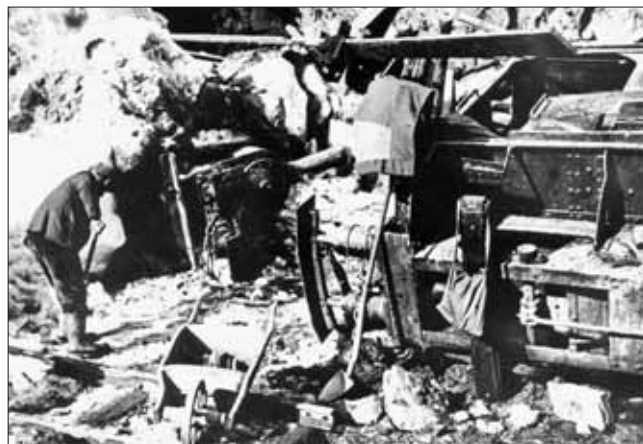
Zima v roce 1940 byla krutá. Drtivý tlak ledových ker na Vltavě zcela zdevastoval staveniště štěchovické přehrady. Firma Lanna musela odepsat jeden parní jeřáb, řadu vozů a lodí i další menší kusy z inventáře. Parní lokomotivy sice přežily, dalo však hodně práce je před příchodem jara doslova vykopat z ledového hrobu a potom opravit poničené části, většinou našťásti jen ty plechové.
