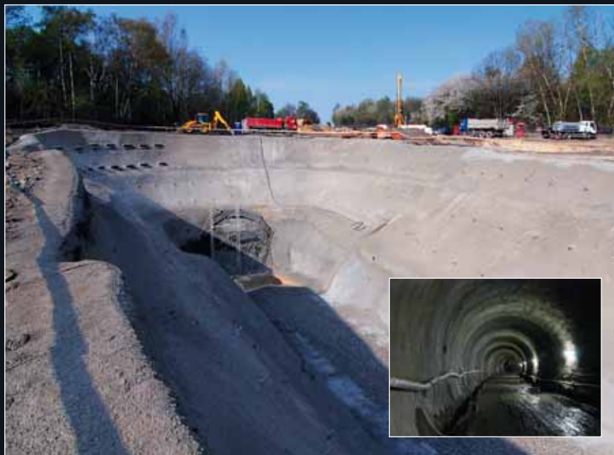
Stavební jáma s příjezdovou rampou pro přístupovou štolu před ražbou portálu Vpravo dole: Přístupová štola zhruba po půl roce
