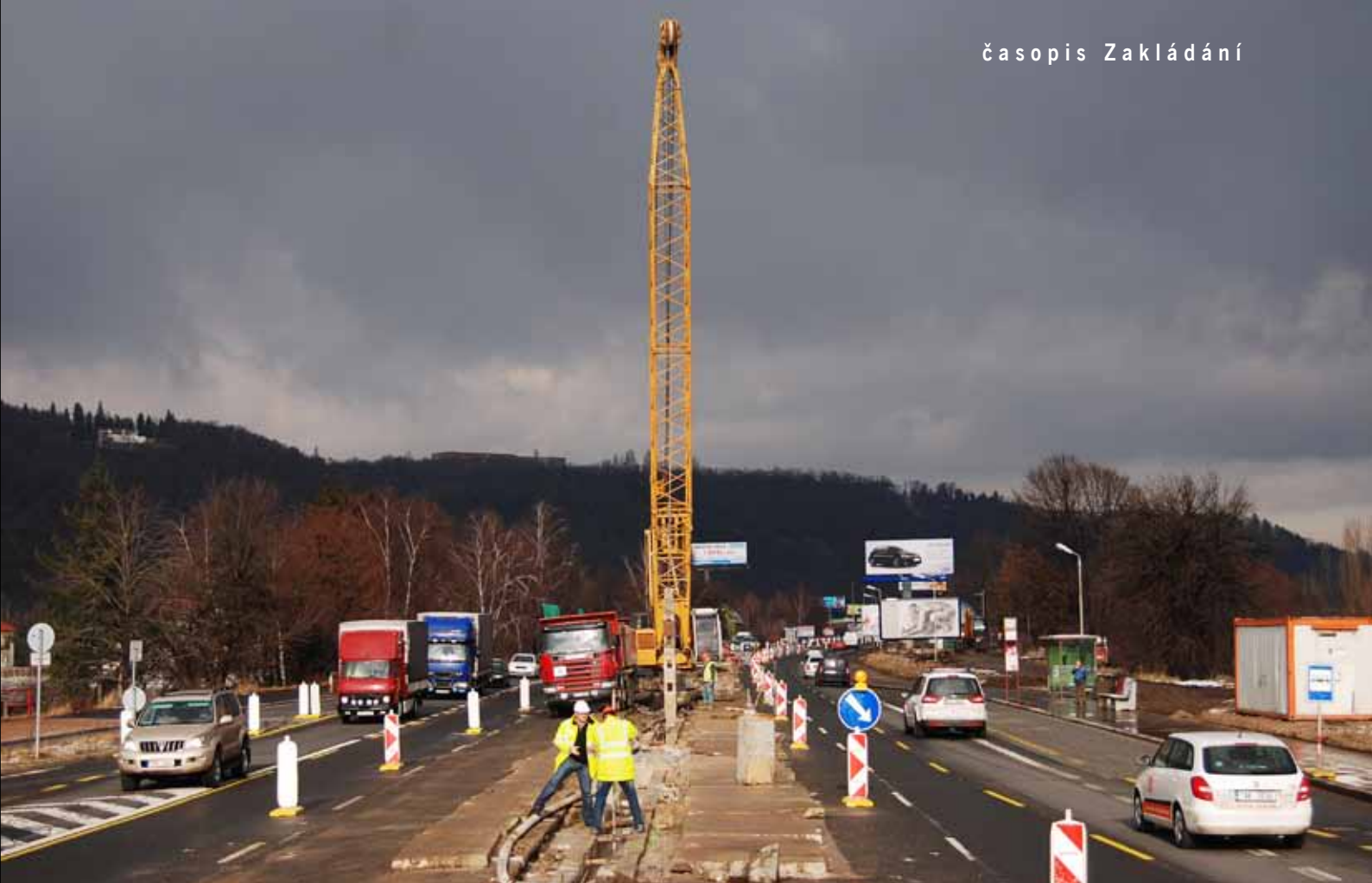
Hloubení podzemní těsnicí stěny ve středním pásu Strakonické ulice, OP 203
