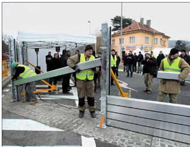
Zkušební postavení mobilního hrazení na křižení Dostihové a Strakonické
