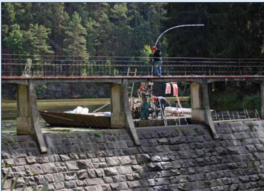
Osazování manžetové injekční trubky z plovoucí pracovní plošiny
