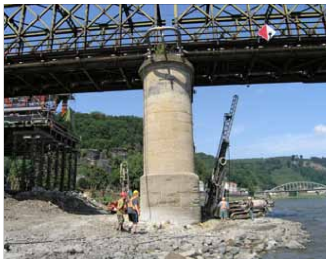
Trysková injektáž podloží pilíře P10
