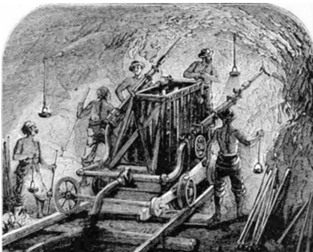
Obr. 1: Vrtací vůz s prvními pneumatickými kladivy, zavedený na stavbě tunelu Fréjus v roce 1861
