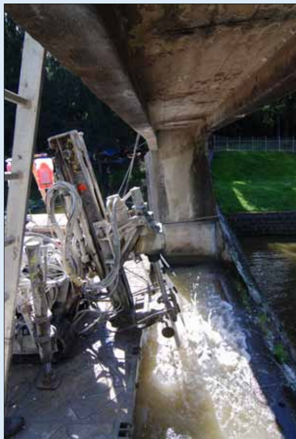
Hloubení injekčních vrtů do koruny hráze
