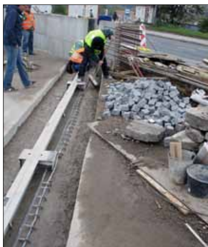
Základ pro mobilní hrazení na podzemní stěně – přechod komunikace Strakonická z křižovatky s Dostihovou (OP 202)
