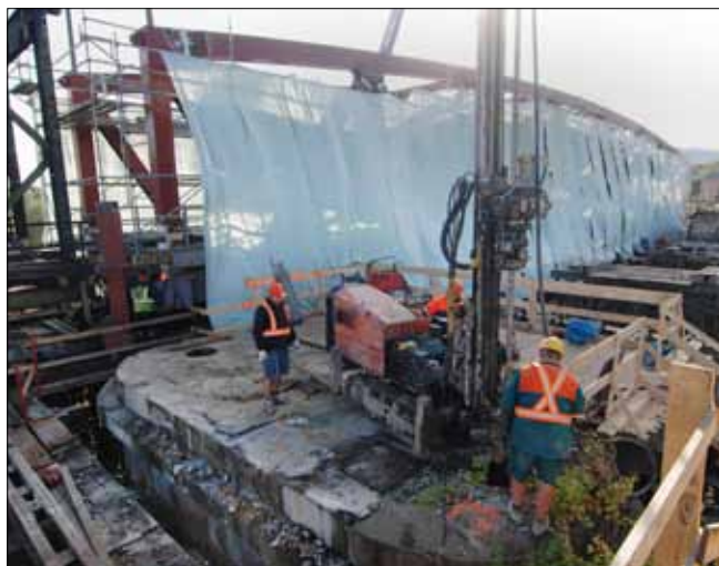
Hloubení vrtů pro osazení svislých prutů výztuže v pilíři P10
