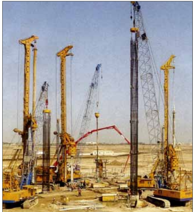
Pilotovací práce na staveništi, délka pilot dosahovala až 110 m
