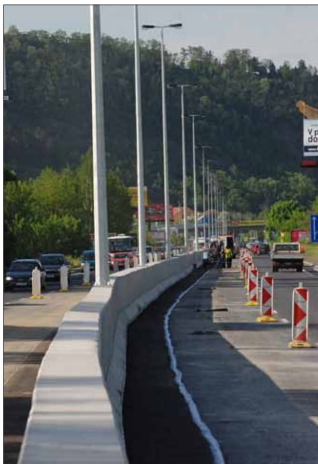
Dokončené opatření OP 203 před odstraněním dopravního omezení
