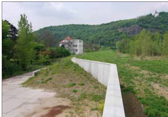
Železobetonová PPO stěna ve výstavbě (OP 204b) a po dokončení se zemní hráží v pozadí (OP 205 a 206)
