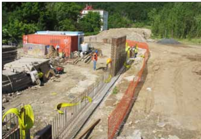
Železobetonová PPO stěna ve výstavbě (OP 204b) a po dokončení se zemní hráží v pozadí (OP 205 a 206)
