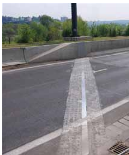
Druhý přechod Strakonické dokončeným základem pro mobilní hrazení (OP 204a) na navazující žlb. stěny (OP 204b)
