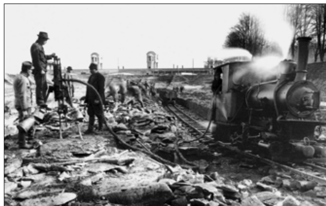
Obr. 9: Vrtání původním Ingersollovým kladivem na trojnožce s improvizovaným parním pohonem z lokomotivky při rozrušování opuk ve dně výkopu pro plavební komoru v Nymburce v roce 1919 (Z. Bauer, Stavební stroje firmy Lanna, str. 54)
