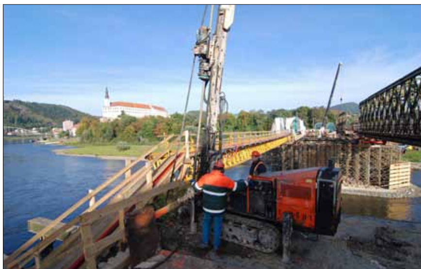
Vrtná souprava na pilíři P10
