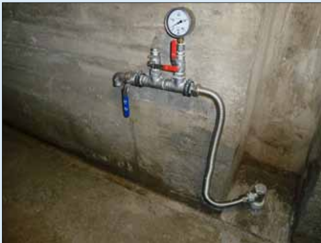
Zhlaví nového vztlakoměrného vrtu
