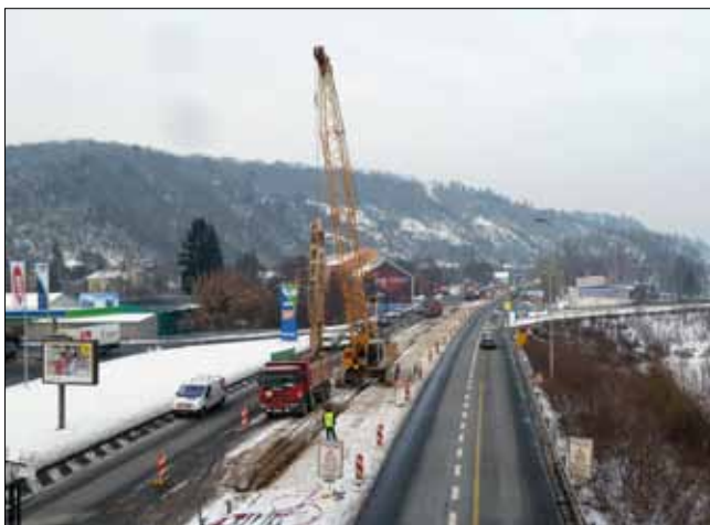
Realizace podzemní těsnicí stěny v Malé Chuchlí, opatření 208c
