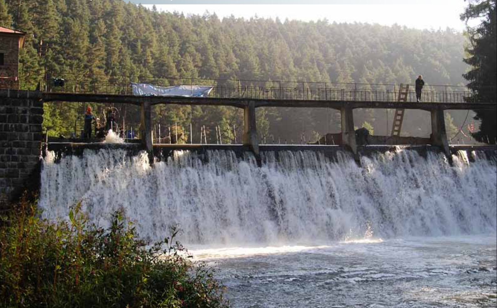
Vrtné a injekční práce probíhaly za plného provozu vodního díla – voda přetéká přes bezpečnostní přeliv
