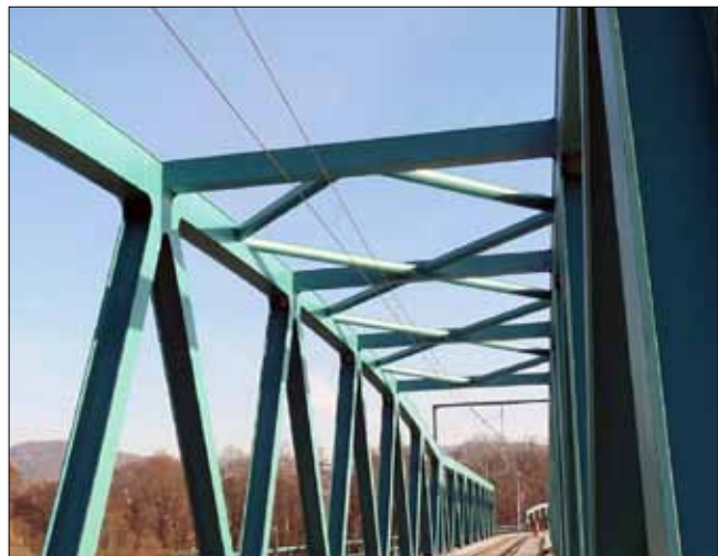
Průhled horním ztužením nosné konstrukce v poli 11
