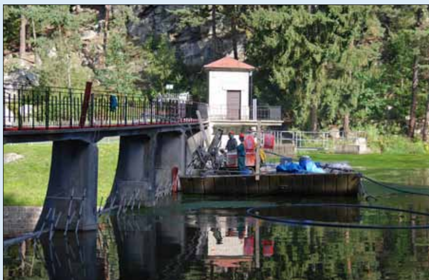
Vrtná souprava MSV 741/20 na plovoucí pracovní plošině
