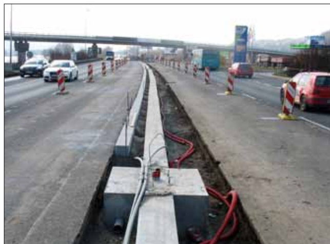
Stejně opatření před dokončením povrchu vozovky a osazením lanových svodidel
