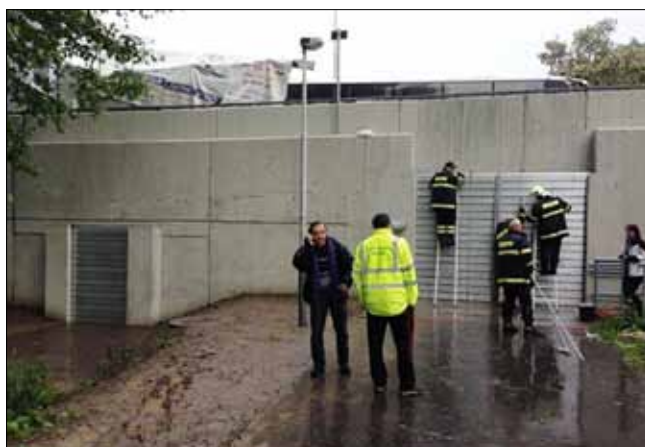
Zahrazení Lážeňského potoka a podchodu při povodni v roce 2013 a stav mimo ohrožení povodni
