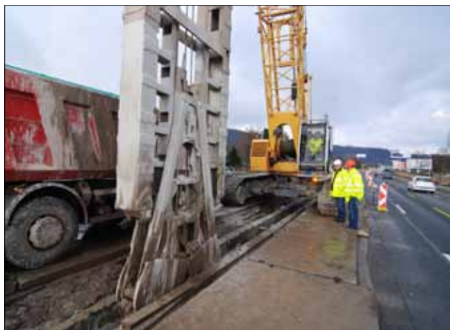
Hloubení podzemní těsnicí stěny ve středním pásu Strakonické ulice, OP 203
