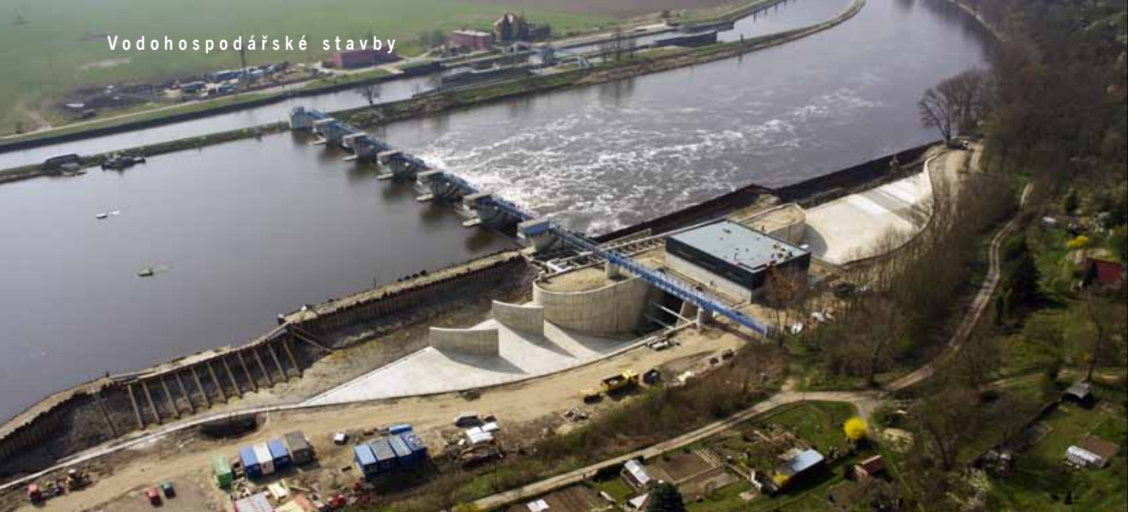
Letecký pohled na elektrárnu před prvním zaplavením, duben 2014
