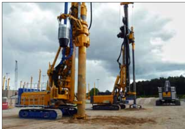
Aresing – ukázky nových technologií „in-situ“
