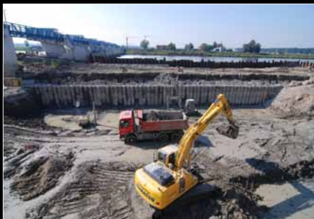
Těžba stavební jámy v podjezí
