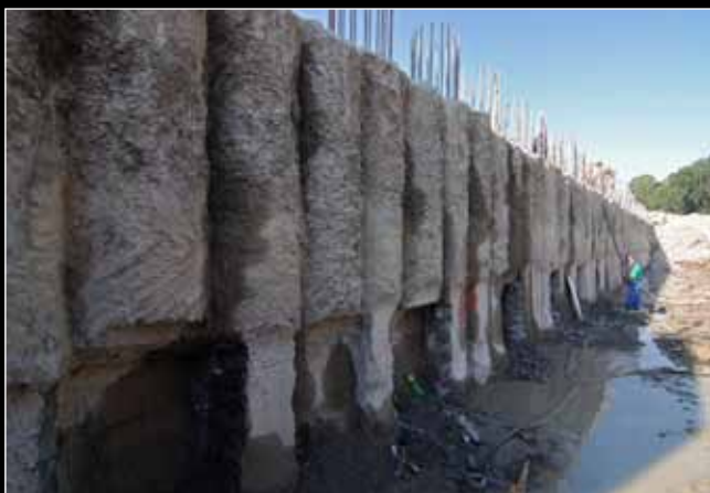
Odkopaná horní část převrtávané pilotové stěny na 1. úroveň kotvení
