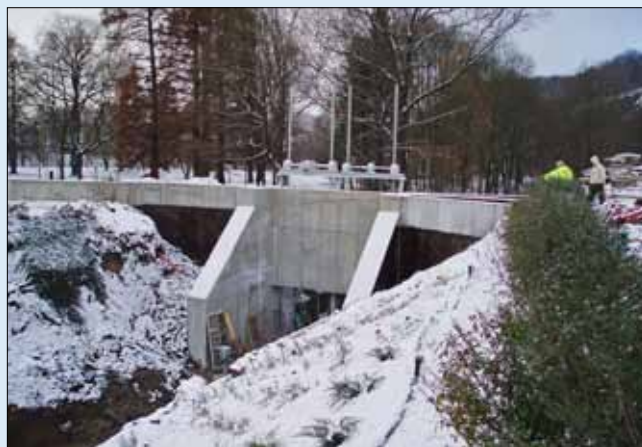
Uzavírka náhonu těsně před dokončením
