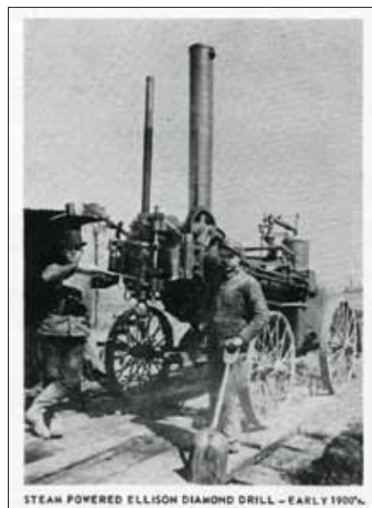
Obr. 2: Parou poháněná jádrová vrtačka, nasazená na průzkumné vrty v dole na olověnou rudu v Missouri v roce 1900, propagovaná později firmou Ellison.
