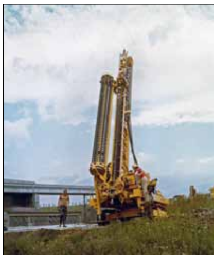
Obr. 14: Vrtání velkou zásobníkovou soupravou Hausherr HBM 150 s dlouhým průběžným šnekovým vrtákem o průměru 140 mm do hloubky 120 m v jálech hnědouhelného revíru pro sanaci dolu na přelozce trati ČSD Ústí nad Labem–Teplice v roce 1979 (o. z. SZS Vodní stavby o. p.)
