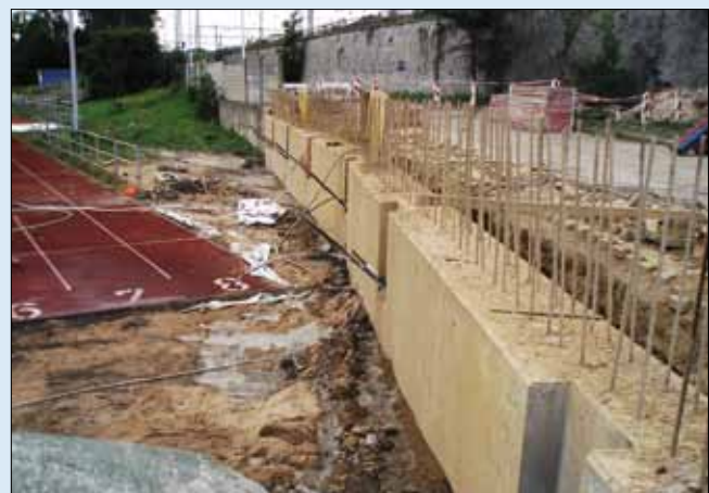
Trvalé kotvy ze strany stadionu v opěrné stěně, která je součástí PPO
