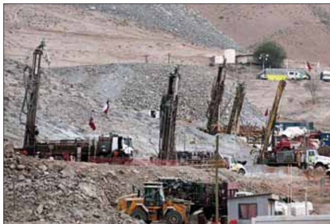
Obr. 8: Vrtání komunikačních vrtů pro záchranu zavalených horníků v Chile v roce 2010. Pro vrtání v granitu do hloubky 700 m byly nasazeny všechny dostupné vrtné soupravy a ponorná kladiva s reverzní cirkulací.
