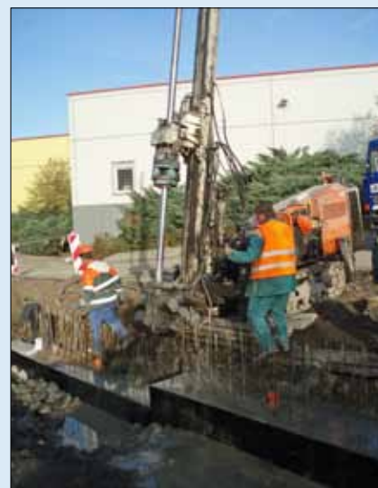
Dotěsnění pilot usměrněnou TI
