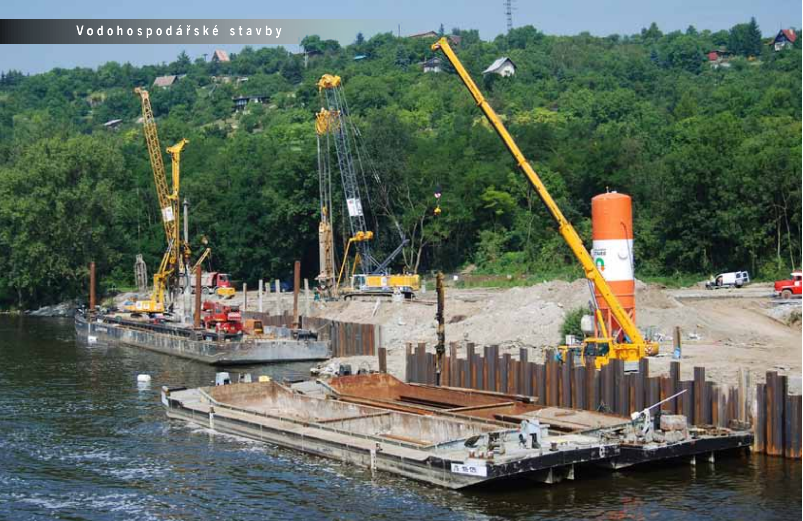
Pohled na stavbu jámy v podjezí se souběhem několika technologií: v pozadí těžba podzemních stěn drapákem Stein a hydrofrézou Bauer BC 32, vlevo provádění předvrtů soupravou Bauer BG 18 pro osazení štětové stěny z loď JTC 1000 t Jantar, v popředí beranění jednoduché štětové stěny jámy.
