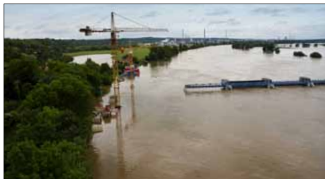
Letecký pohled na stavbu elektrárny v květnu 2013 a o měsíc později při červnové povodni, kdy byla stavební jáma řízeně zaplavena
