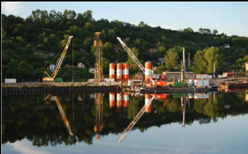
Současné provádění podzemních stěn, pilot a beranění s výrobou pažicí směsí
