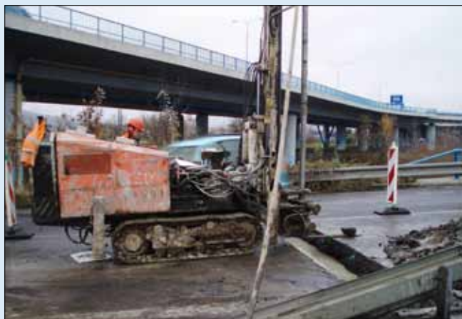
Provádění TI, přechod nájezdu na silniční most
