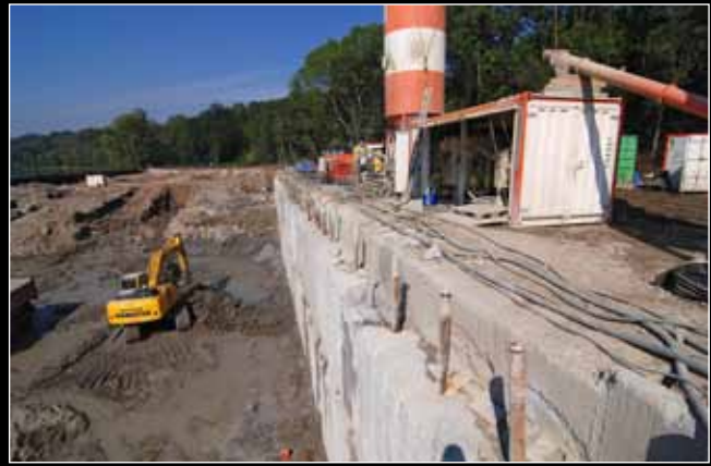
Podzemní stěna s osazenými manžetovými trubkami pro provedení obvodové těsnící injektáže
