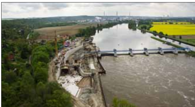
Letecký pohled na stavbu elektrárny v květnu 2013 a o měsíc později při červnové povodni, kdy byla stavební jáma řízeně zaplavena
