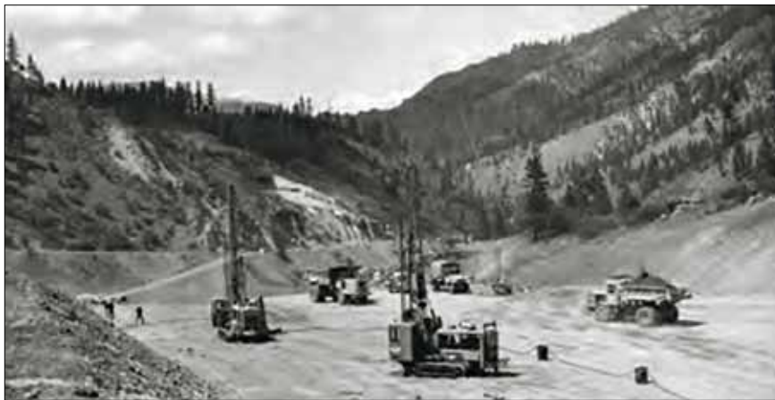
Obr. 10: První samohybné vrtací lomařské soupravy Quarrymaster firmy Ingersoll-Rand z roku 1948 v USA
