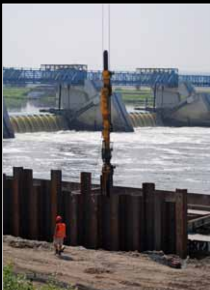
Doberanění jednoduché štětové stěny v podjezí rázovým beranidlem Berminghammer
