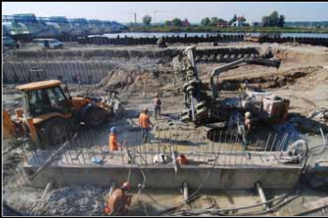
Kotvení hlavního trámu podzemní stěny v podjezí vrtnou soupravou Klemm KR806
