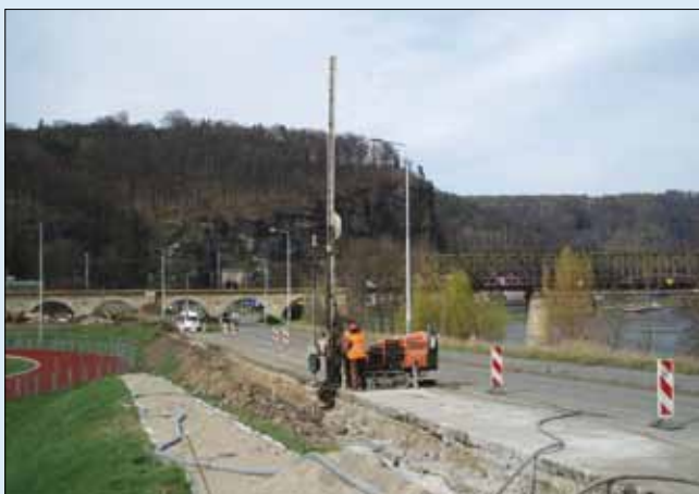
Zhotovení spodní stavby PPO pomocí TI, ulice Předmostí
