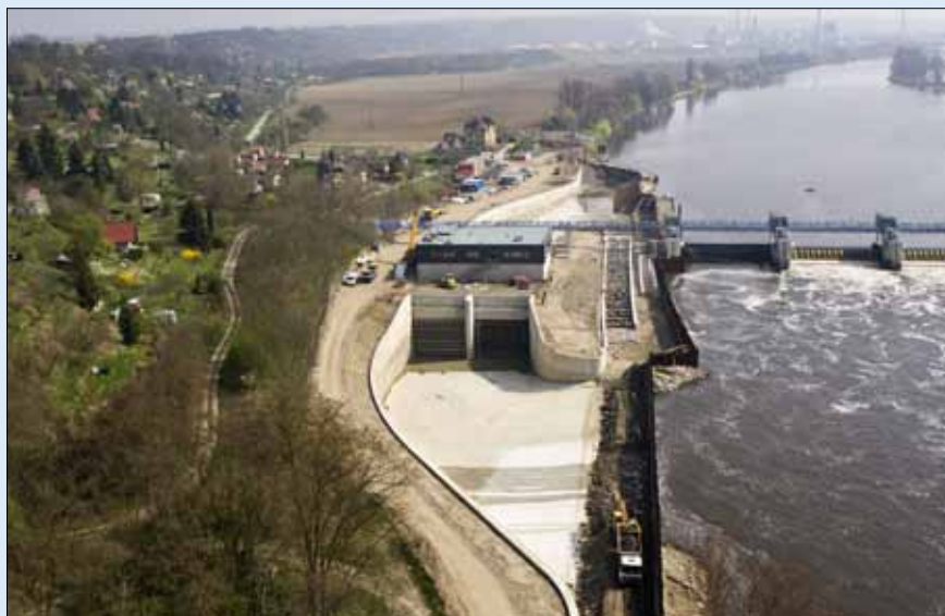
Letecký pohled na výtokovou část elektrárny před prvním zatopením, duben 2014
