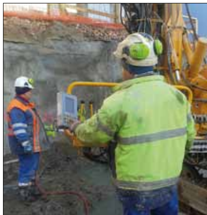
Obr. 13: Počítačová kontrola procesu vrtání zařízením firmy PARTNER na stavbě speciálního zakládání při vrtání kotev v roce 2013
