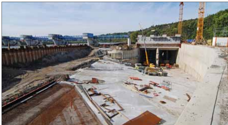
Betonáž dna nátoky a pokračující stavba strojovny
