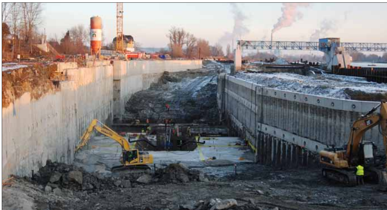
Betonáž základové desky strojovny MVE v nejhlubším místě stavební jámy
