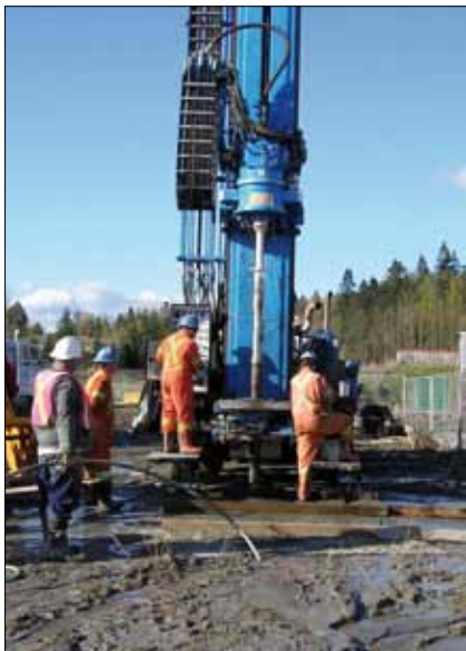
Obr. 9: Moderní souprava pro vrtání metodou Sonic-drilling s obzvláště robustní lafetou a s vrtnou hlavou pro vysokofrekvenční vibraci v roce 2010
