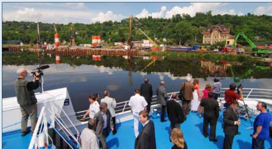
Příjezd lodí s hosty při příležitosti pozhánání základního kamene stavby MVE Štětí 12. 6. 2012
