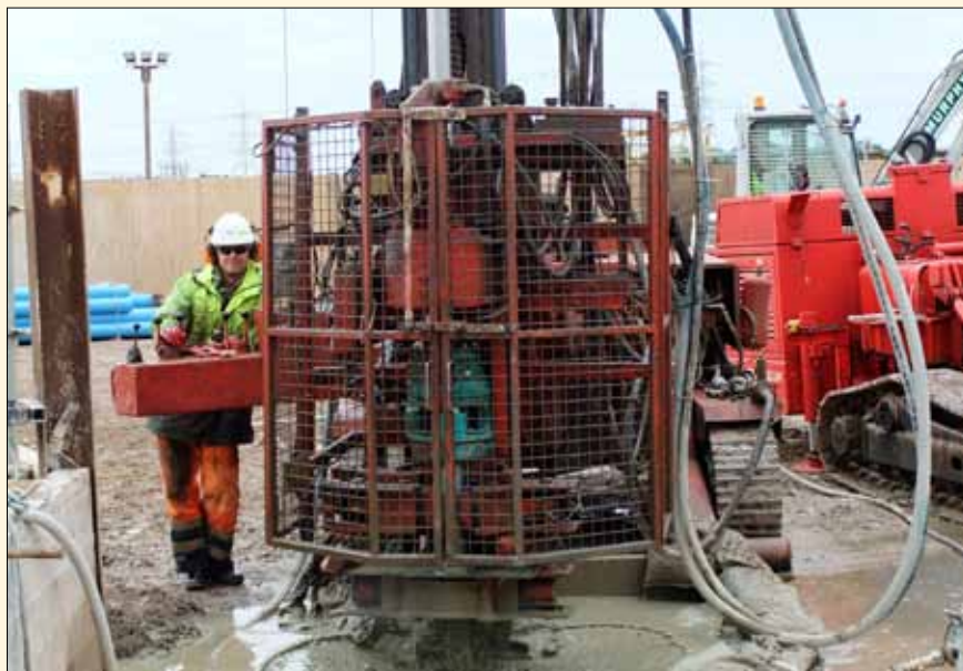
Vystrojení vrtné soupravy pro tryskovou injektáž ochrannými kryty a ochrannými bezpečnostními systémy podle nové normy na stavbě ve Velké Británii
