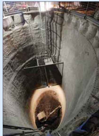
Pohled do šachty elipsovitého tvaru, ostění z převrtávaných pilot je opatřeno stříkaným betonem
