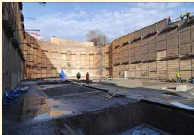
Pohled do stavební jámy s dokončenými podkladními betony
