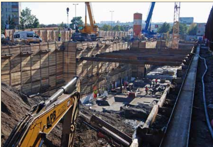
Pohled do stavební jámy během těžby a kotvení v její západní části
