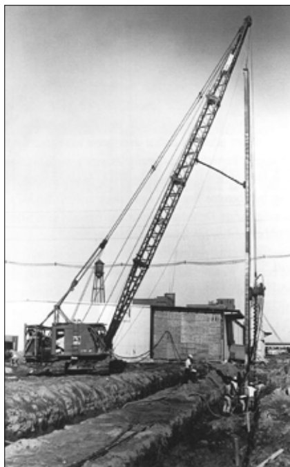
Obr. 6: Jedno z prvních provádění pilot ACIP (Augered Cast-in-Place) v USA, rok 1950 (firma Intrusion Prepack)
