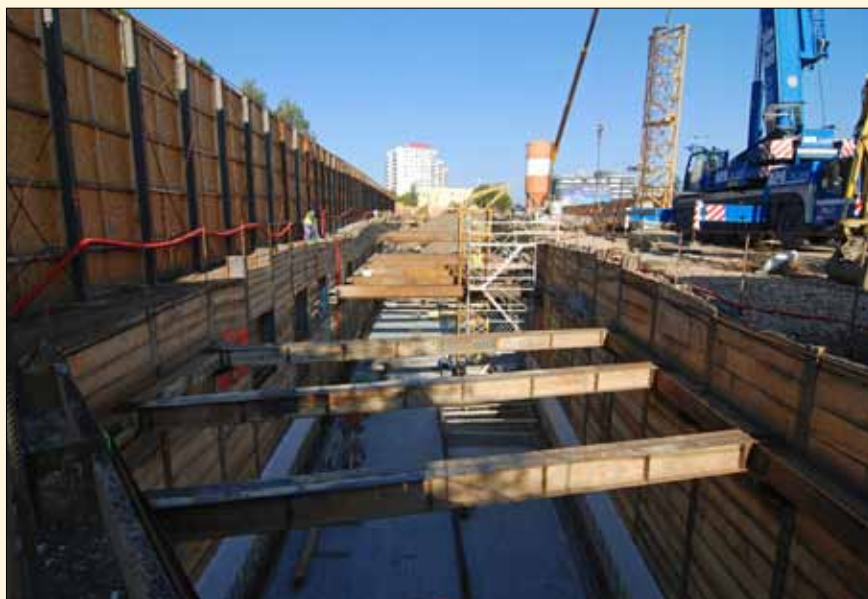
Pohled na nejužší část stavební jámy od východu
