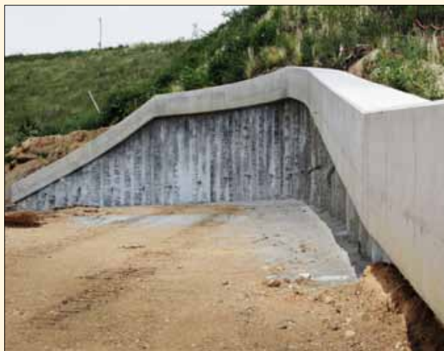
Pohled na opěrnou stěnu OZ3, úsek s největším výkopem
