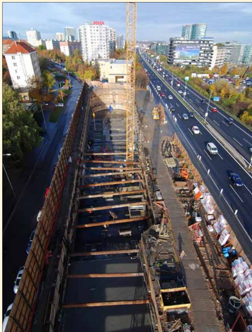
Vytěžená stavební jáma mezi ulicemi Jihlavská a 5. května
