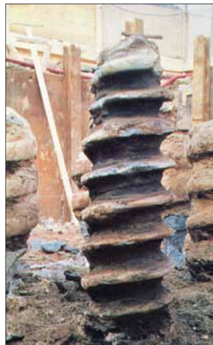
Obr. 8: Tvar obnaženého šroubovitého dřívku piloty typu Atlas o průměru 46/56 cm, Německo, rok 1987 (firma Atlas Palen)
