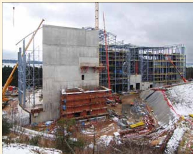
Budovy spalovny odpadů, pohled ze severovýchodu
