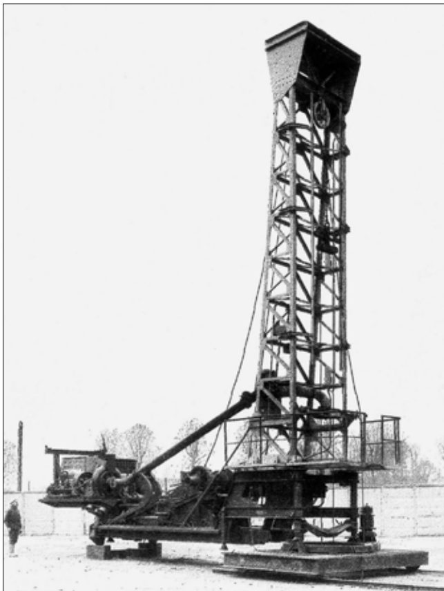
Obr. 3: Vrtací souprava Rodio-Marconi CIS 61 pro nárazové vrtání s reverzní cirkulací výplachu výkonným odstředivým čerpadlem na elektrický pohon z roku 1950 (firma Soletanche):
