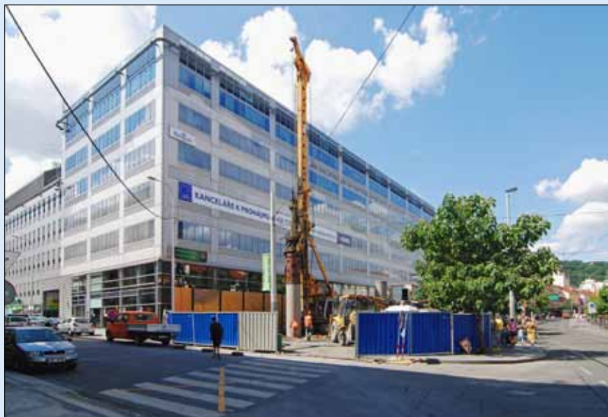
Provádění pilot v záboru staveniště na Nádražní ulici v blízkosti křižovatky Anděl
