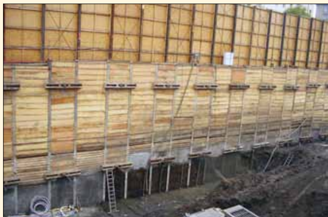
Úprava záporového pažení pod 2. kú při ul. Jihlavské v západní části jámy pomocí stříkaného betonu a zesílení podkladních betonů
