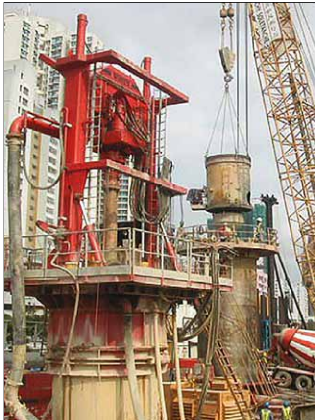
Obr. 4: Vrtání velkopřůměrových pilot soupravou Wirth s reverzní cirkulací výplachu na stavbě metra v Hongkongu v roce 1996 (firma Soletanche)
