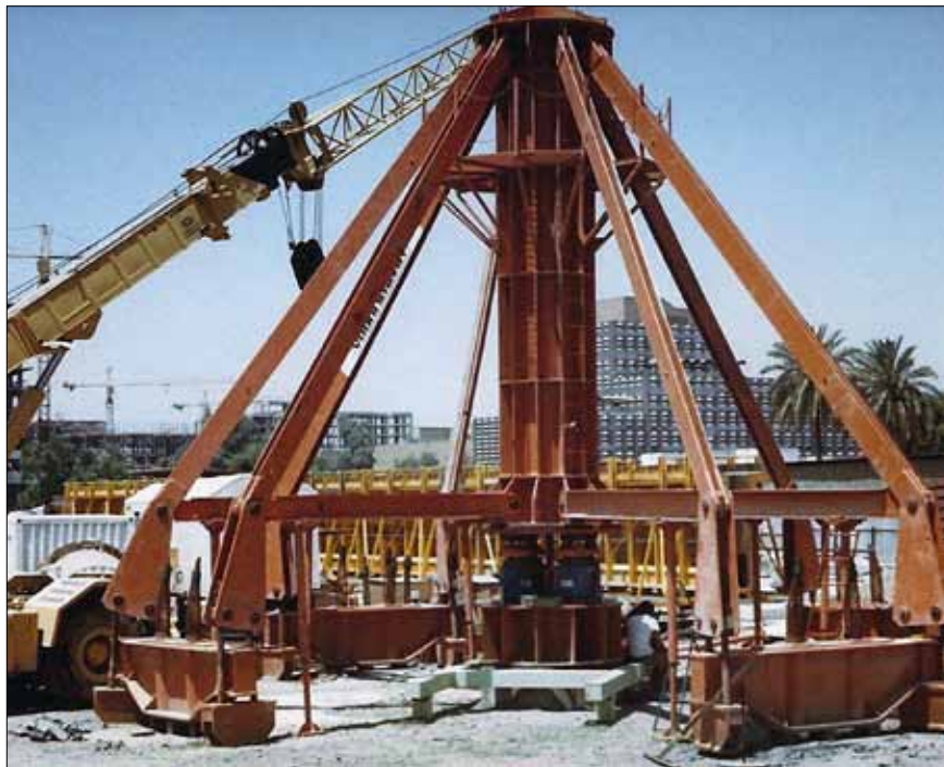
Obr. 10: Zařízení pro zatěžovací zkoušku piloty o kapacitě 25 000 kN na stavbě Sinak Bridge, Bagdá, Irák, rok 1983 (SZS Vodní stavby)
