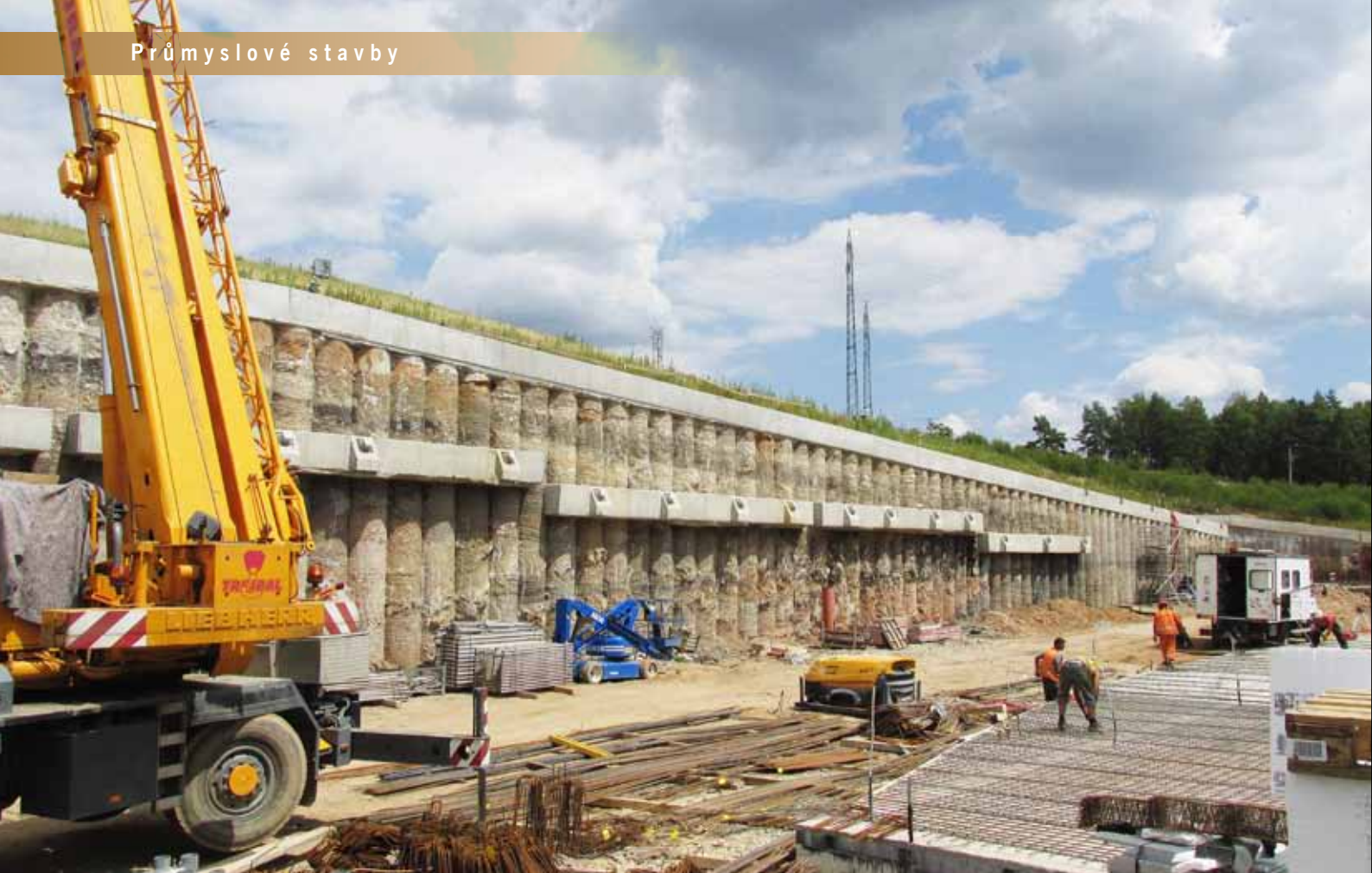
Pohled na opěrnou stěnu OZ1
