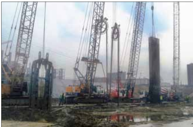
Intenzivní výroba podzemních stěn na stanici: těžba rýhy drapákem a hydrofrézou, osazování armokoše a betonáž lamely.
