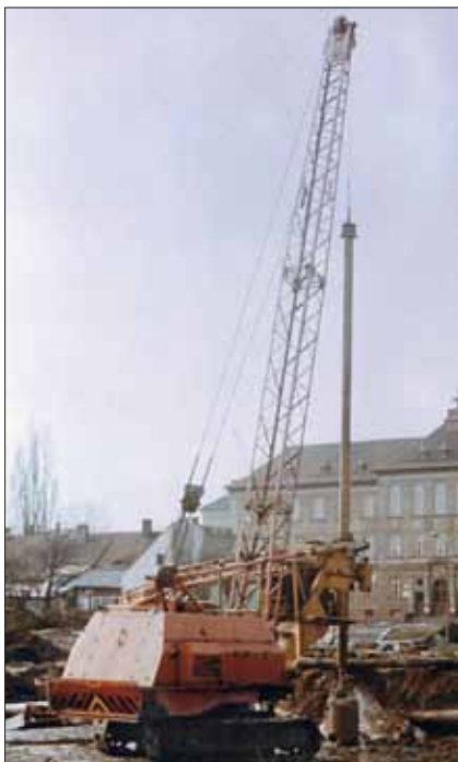
Obr. 10: Vrtání pilot s pažicí bentonitovou suspenzí soupravou Terradrill 1000 na nosiči DH 141, stavba sídliště Česká Lípa v roce 1978 (SZS Vodní stavby)
