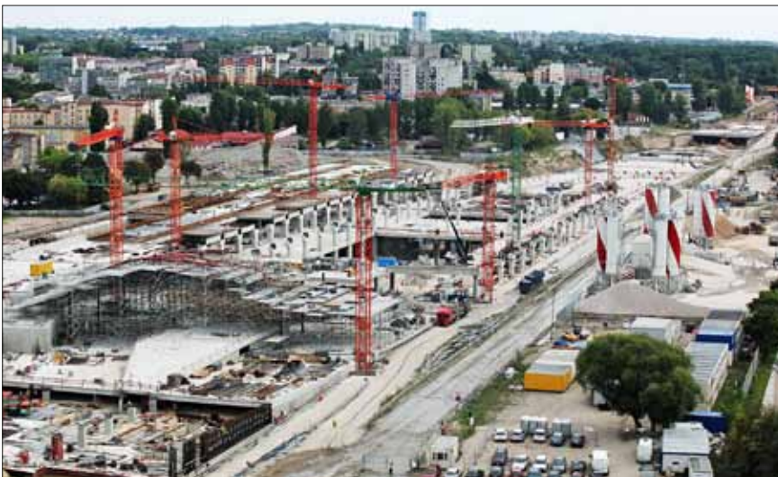
Letecký pohled na stavenišťe stanice s probíhající výstavbou nad stropní deskou
