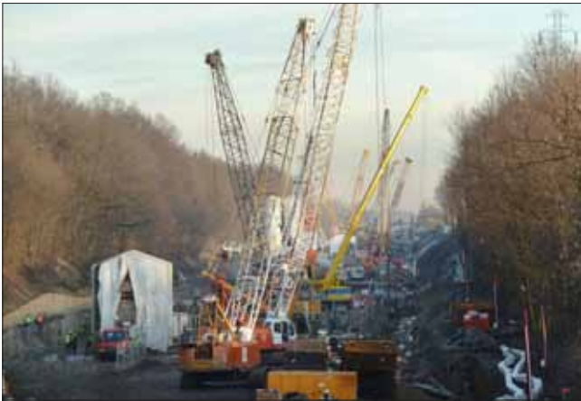
Hloubený tunel, II. Etapa, nasazení 4 bagrů a 4 plazových jeřábů
