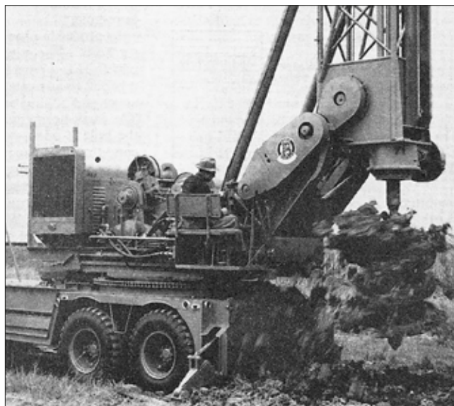
Obr. 9: Vrtná souprava americké firmy McKinley Drilling na automobilovém podvozku v roce 1960
