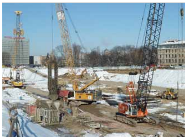
Výroba podzemních stěn pro objekt stanice (zima 2012/2013)
