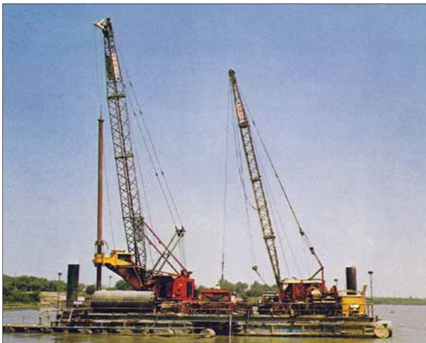
Obr. 11: Vrtání pilot kombinací technologie drapákové těžby s pažnicí a rotační bentonitové technologie v řece Tigris pro založení mostu Jadiriah bridge v Bagdádu v Iráku v roce 1982 (firma Rodio)
