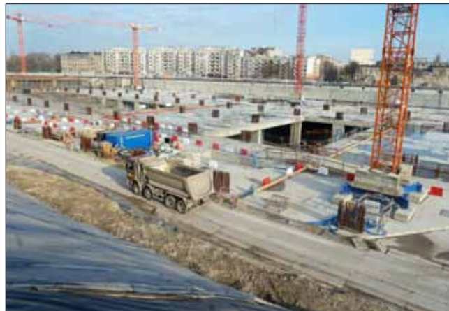
Stanice s dokončenou stropní deskou, pod níž probíhá odtěžování
