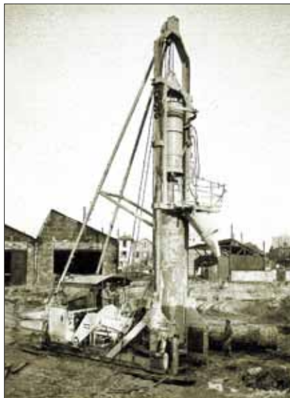
Obr. 5: Nárazová drapáková souprava Benoto EDF s hydraulicky zatlačovanými pažnicemi, Francie, rok 1940 (firma Soletanche)
