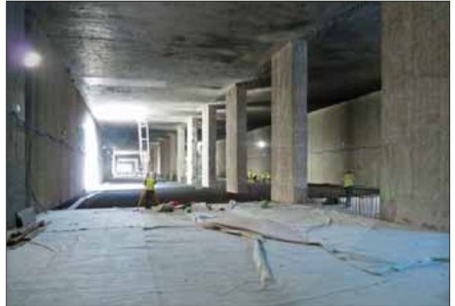
Pohled do hloubeného tunelu se střední řadou baretů
