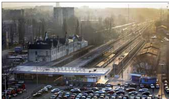
Nádraží Łódź-Fabryczna nedlouho před demolicí
