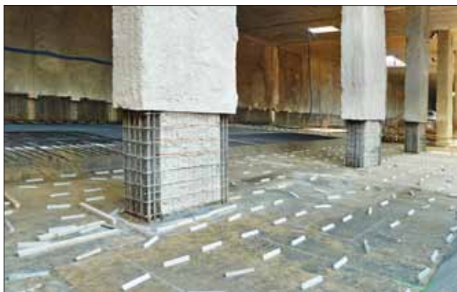
Baretů ve stanici připravené pro propojení se základovou deskou
