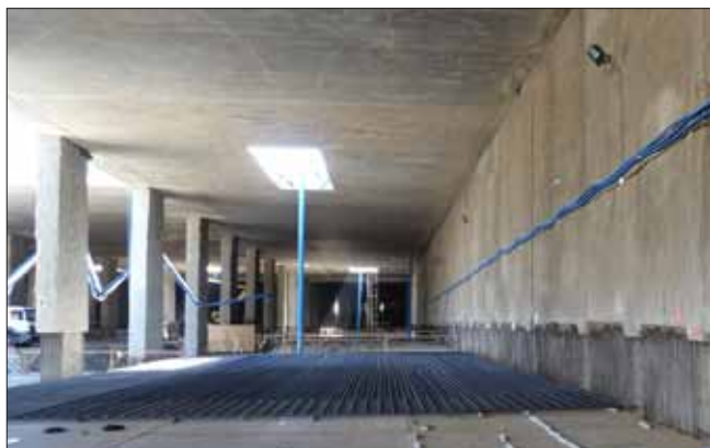
Zahájení montáže základové desky ve stanici, vpravo PS s připravenou drážkou
