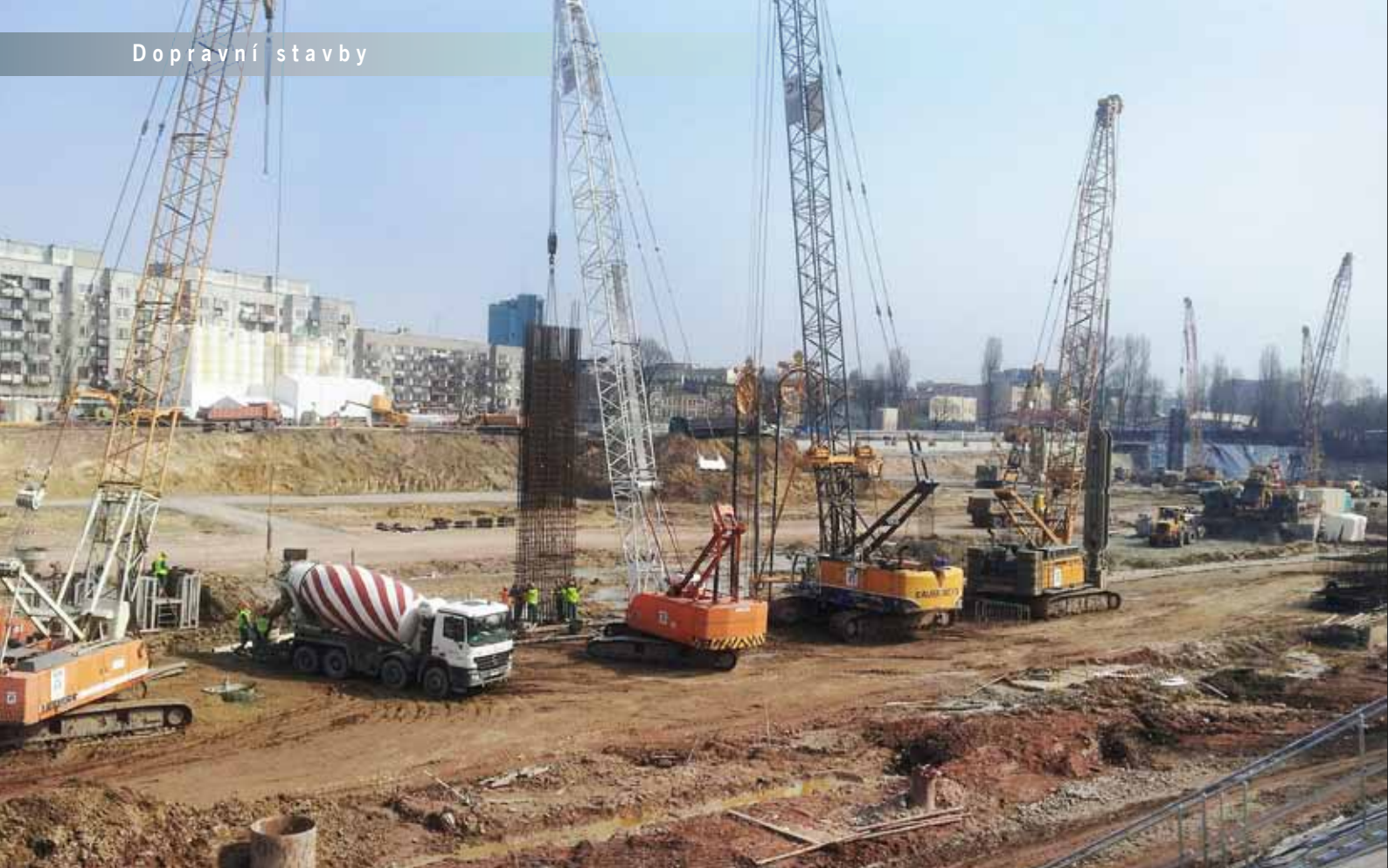
Provádění baretů v objektu stanice – hloubka 53,0 m
