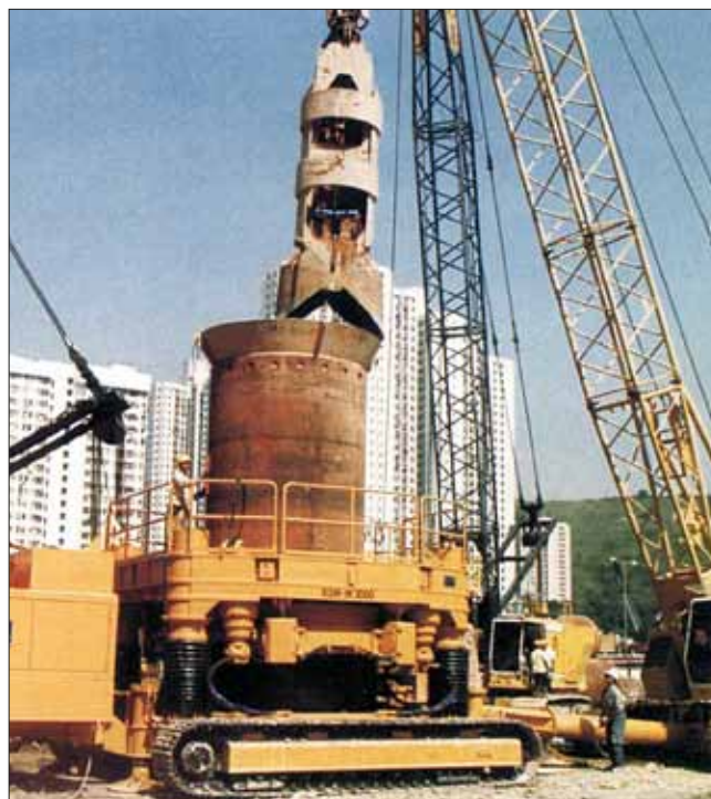
Obr. 7: Zapažovací rotátor RDM-M 3000 pro pažnice o průměru 3 m do hloubek 85 m a pro nejtěžší podmínky (firma Leffer)
