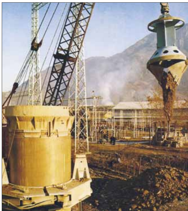
Obr. 6: Drapáková souprava s pažnicemi zatlačovanými hydraulickým oscilátorem při práci v hrubých štěrčích v roce 1979 (firma Rodio)
