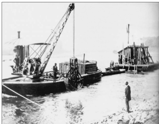
Obr. 5: Dvouřetězový Priestmanův drapák č. 1 firmy Lanna spolu s kesonovou lodí na stavbě jezu v Troji v roce 1899 (Stavební stoje firmy Lanna, Z. Bauer)
