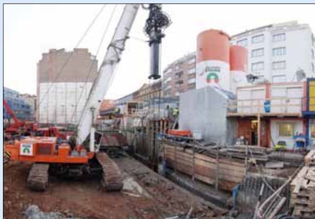
Hloubení rýhy pro konstrukční podzemní stěnu podél Thámovy ulice
