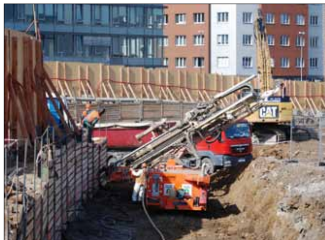
Vrtání kotev 1. KÚ a souběžná těžba stavební jámy
