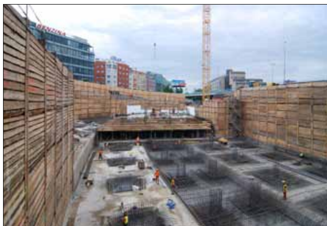
Pohled do vytěžené jámy s probíhající betonáží monolitických konstrukcí
