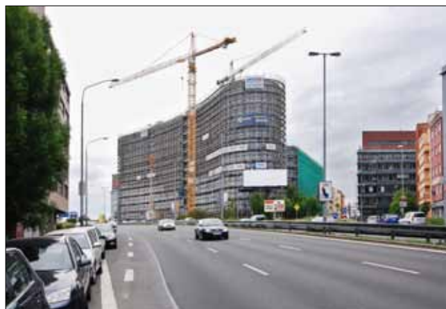
Pohled na budovu Enterprise v průběhu výstavby z ulice 5. května (květen 2015)
