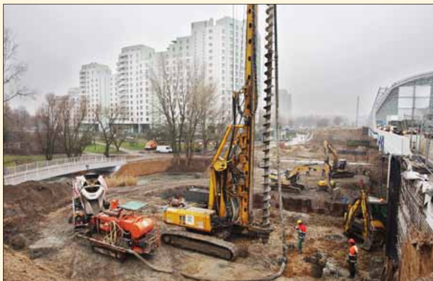
Rozšíření jednoho pilíře nájezdové rampy mostu gen. Roweckiego CFA pilotami
