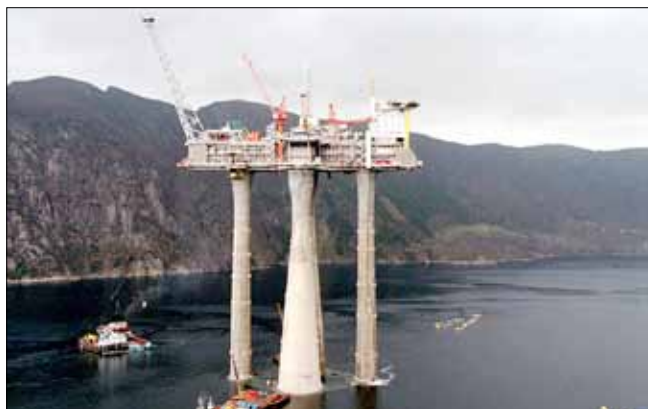
Obr. 9: Tažení vrtné plošiny Troll A, tvořené soustavou uzavřených železobetonových kesonů o celkové výšce 469 m zhotovených v doku, na pozici těžby v Norsku, rok 1996 (zdroj internet)
