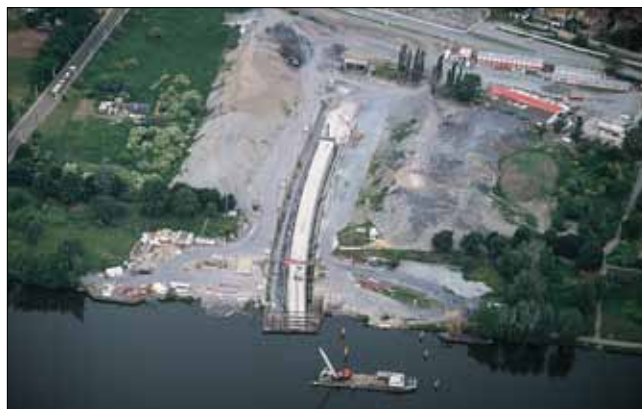
Obr. 10: Unikátní směrově zakřivený a v jednom kuse zatahovaným splavený tubus pro přechod metra pod Vltavou, instalovaný s pomocí celé řady metod speciálního zakládání v roce 2002 (firmy Metrostav a Zakládání staveb)
