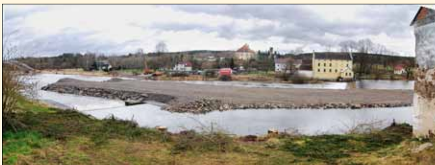
Stavba plavební komory byla zahájena zemními pracemi v řečišti, duben 2015
