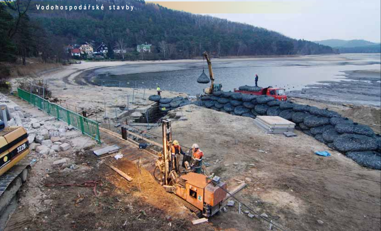
Hloubení injekčních vrtů v levé přípojovací části injekční clony ze dna vypuštěného Máchova jezera
