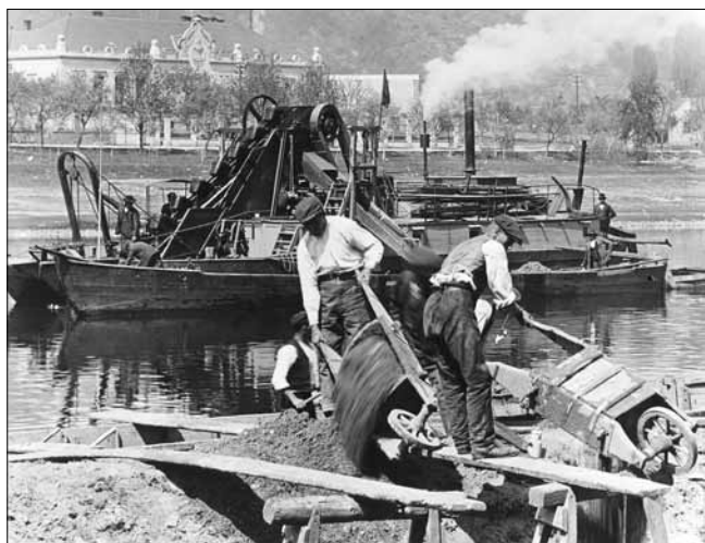
Obr. 4: Korečkový bagr č. 6 firmy Lanna, stavba jezu v Troji v roce 1899. V té době byla ještě pro vykládku nejběžnější ruční práce s pomocí koleček. (Stavební stoje firmy Lanna, Z. Bauer)
