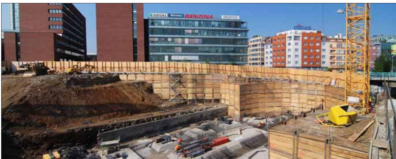
Panoramatický pohled na stavební jámu se současně prováděnou betonáží základové desky a těžbou
