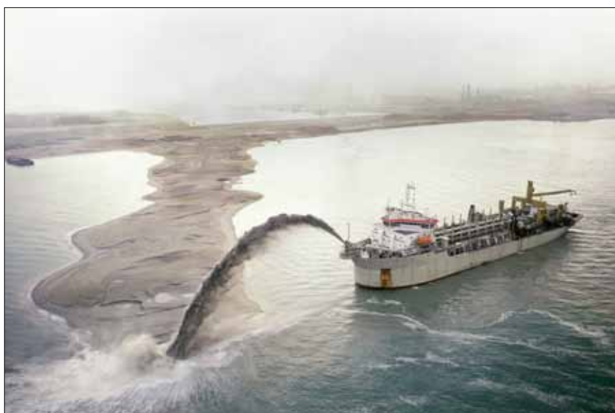
Obr. 6: Příklad velkokapacitního námořního sacího bagru z konce 20. století s velkým zásobním prostorem, z kterého se z jinde odtěženého materiálu naplavuje při vykládce umělé pobřeží (zdroj internet)
