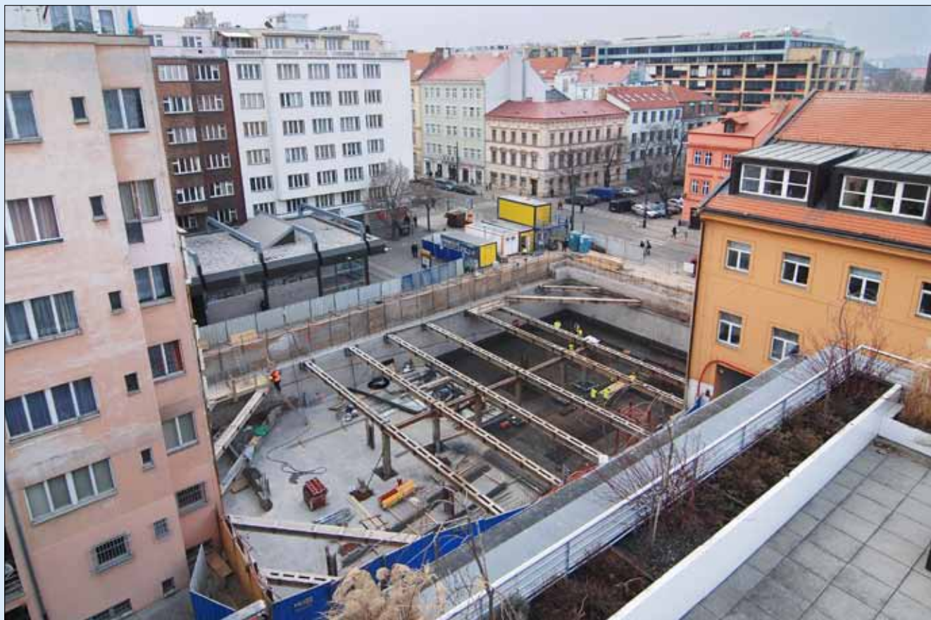
Pohled do stavební jámy ze střechy Meteoru B
