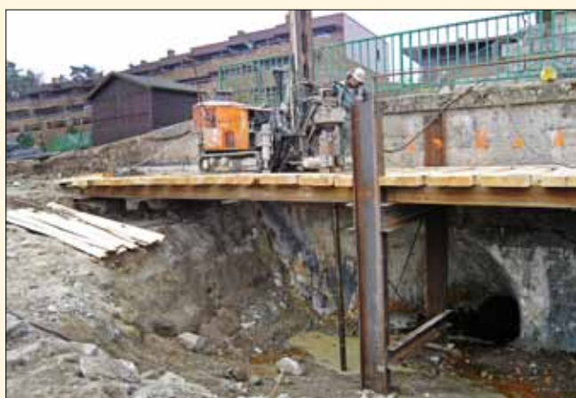
Hloubení injekčních vrtů z pracovní plošiny v místě částečně ubouraného kašnového přelivu
