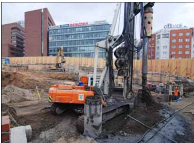
Vrtání velkoprofilových pilot pro věžový jeřáb
