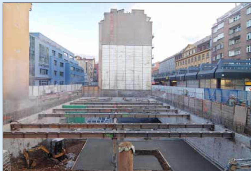
Pohled na zapaženou a rozepřenou stavební jámu od Sokolovské ulice
