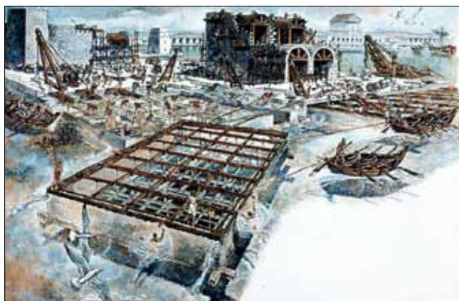
Obr. 7: Znárodnění výstavby středomořského přístavu Ceaserea u Judei v roce 20 př. n. l. s naplavaním skříňového základu na určené místo (zdroj internet)
