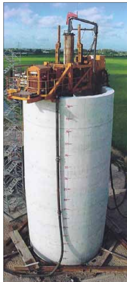
Obr. 3: Spouštění otevřeného železobetonového kesonu o průměru 3,5 m a hloubce 80 m pro podzemní multireaktor ČOV s pomocí vrtání na reverzní cirkulaci, Nizozemsko, rok 1985
