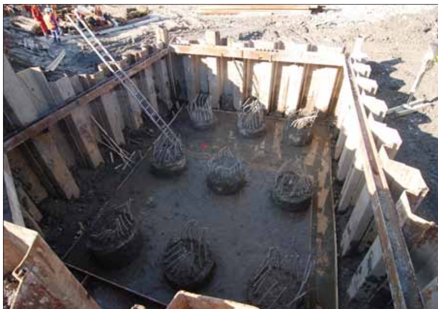
Štětová jímka pro ochranu pilotového založení podpěr na úseku TC2
