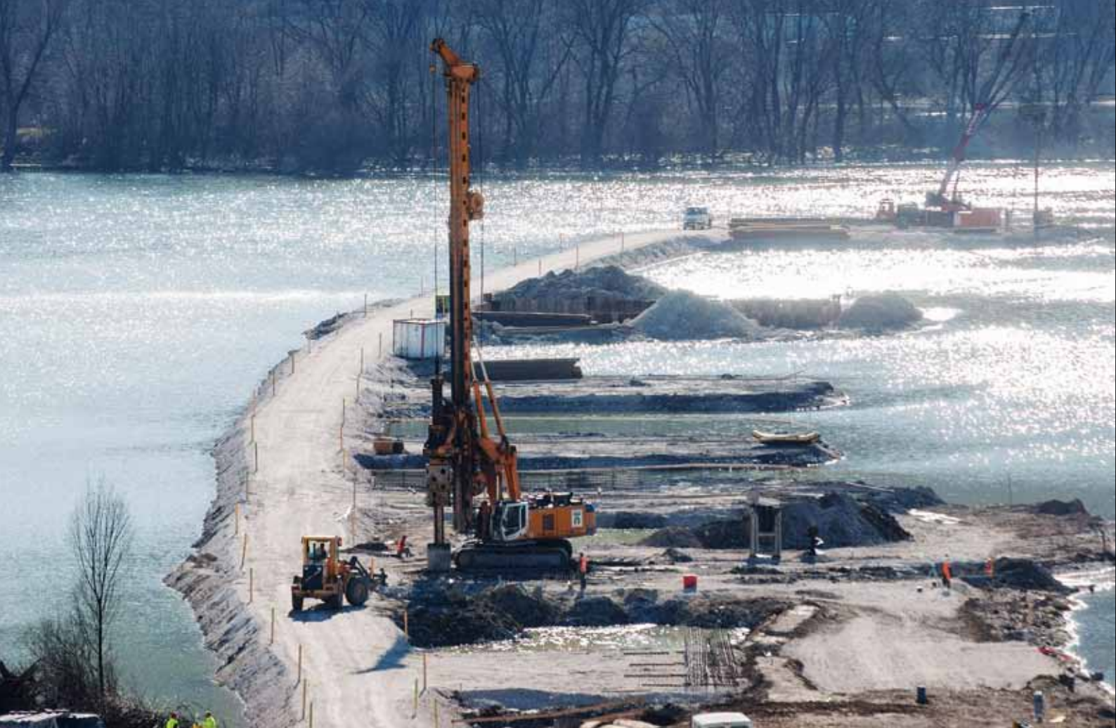
Realizace pilotového založení podpěr na hlavním technologickém úseku TC3, pohled od portálu tunelu Považský Chlmec
