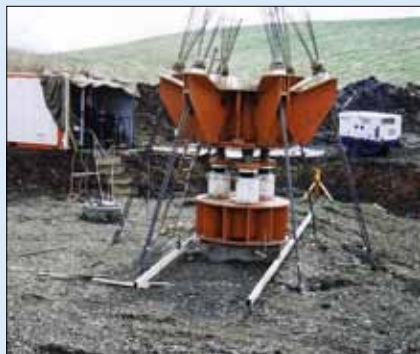
Obr. 5: Ilustrační foto z provádění zatěžovací zkoušky
