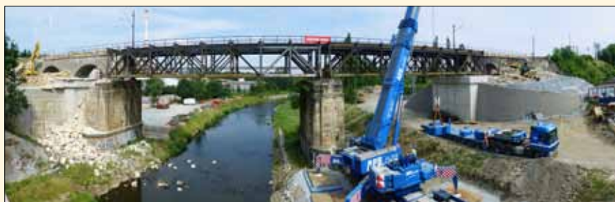
Most s novými opěrami ještě se starou nosnou konstrukcí z roku 1925 (červenec 2015)
