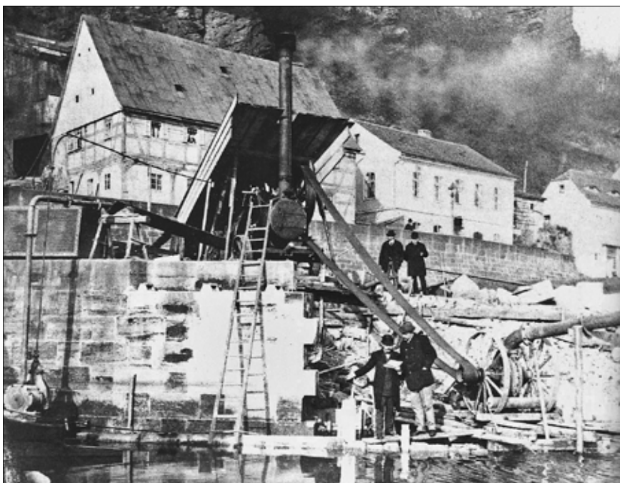
Obr. 4: Obvyklé uspořádání čerpání z jímky pro nábrežní zeď na stavbě zimního přístavu u děčínských Podmokel v roce 1857 prováděné firmou Lanna. Vpravo je odstředivé čerpadlo poháněné parní lokomobílou a vlevo přímočinné parní čerpadlo pro napájení lokomobily (Z. Bauer: Stavební stroje firmy Lanna, str. 278).
