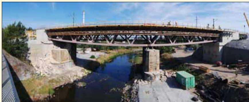
Most s novými opěrami již s novou nosnou konstrukcí (srpen 2015)
