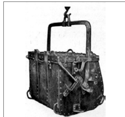
Obr. 12: „Kyklopský“ betonážní ponorný uzavřený koš z oceli používaný pro betonáž pod vodou v USA na začátku 20. století (internet)
