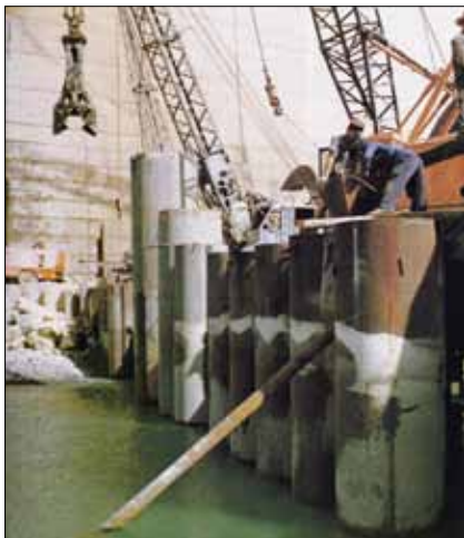
Obr. 11: Návodní jímka s pažením z ocelových výpažnic o průměru 1118 mm zavrtaných do 22 m při hloubce vody 8 m pro přístavbu vodní elektrárny ke stávající přehradě Derbendikan v Iráku v roce 1982 (Zakládání staveb, a. s.)
