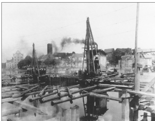
Obr. 9: Budování jezových jímek v Kolíně v roce 1915 firmou Kapsa-Müller. V popředí je parní beranidlo od americké firmy Ingersoll při ražení štětovic typu Ransome, v pozadí je ruční beranidlo pro ražení dřevěných štětovic (Z. Bauer: Stroje na stavbách, str. 173).
