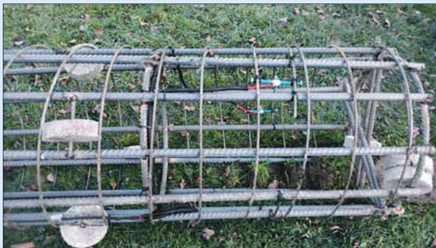
Obr. 4: Instalované strunové tenzometry na armokoši piloty
