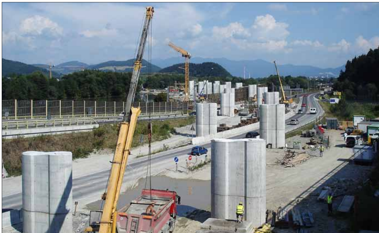
Vznikající estakáda nad vodní nádrží Hričov (srpen 2015), pohled při příjezdu do Žiliny od jihu
