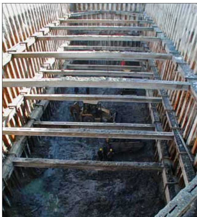
Obr. 10: Rozpíraná štětová jímka na Dunaji těsněna ve dně tryskovou injektáží, založení pilíře mostu Apollo v Bratislavě v hloubce cca 8 m pod dnem, 2005 (foto: archiv Zakládání staveb, a. s.)
