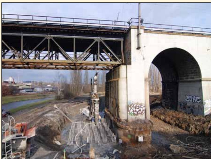
Zakládání opěry OP1 (směrem na Prahu) v omezených podmínkách pod starým provozovaným mostem
