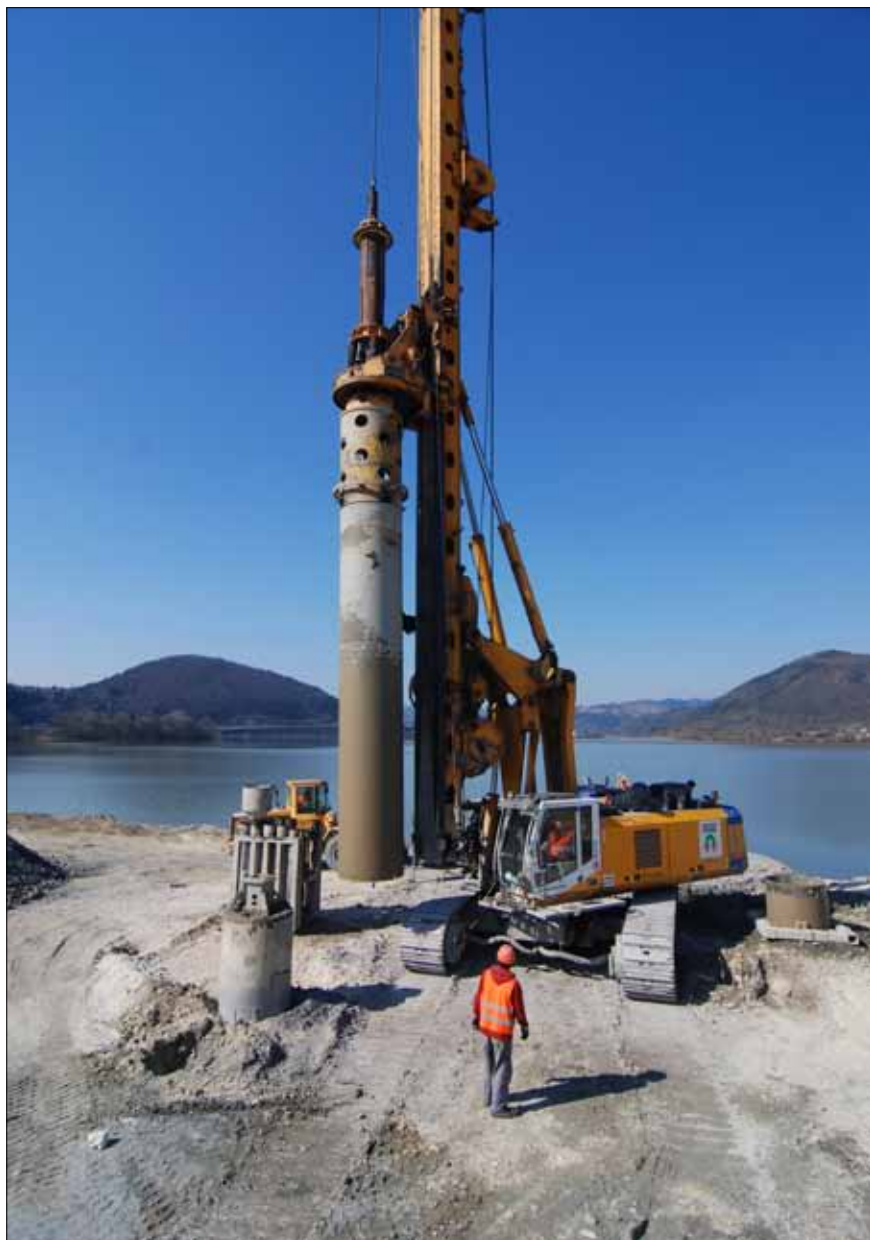
Realizace pilot na hlavním technologickém úseku TC3
