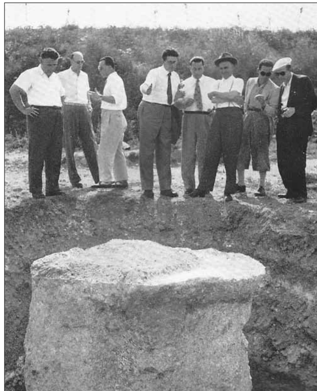
Obr. 8: Obnažený průkazní element první podzemní betonové stěny předvedený firmou I.C.O.S. v únoru 1950 u řeky Isonča v severovýchodní Itálii pro získání prvních kontraktů (firma I.C.O.S.)
