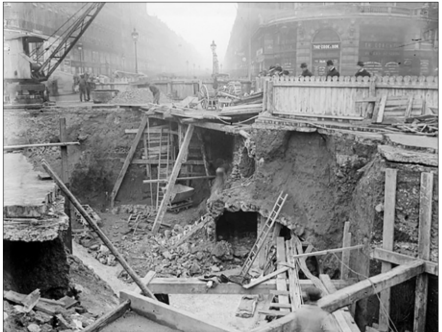
Obr. 1: Částečně roubená a pažená jáma, hloubená v poměrně stabilní zemině pro stanici pařížského metra v roce 1899 s obsluhou parního jeřábu (internet)
