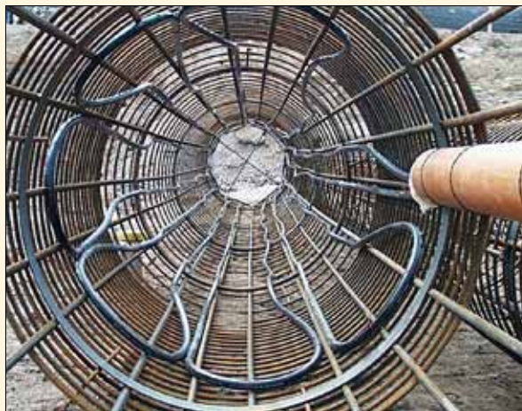
Armokoš pro energopilotu s tepelným výměníkem ze smyček HDPE hadic
