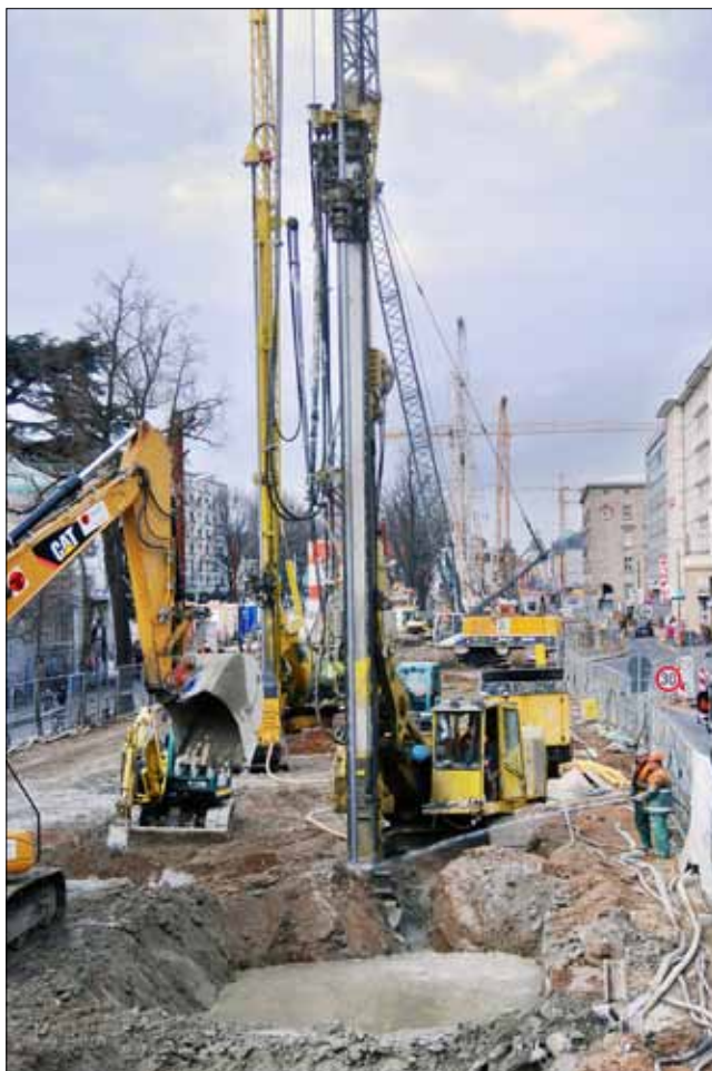
Těsnění dna stavební jámy hloubeného tunelu pomocí TI – hloubený tunel Ettliger Strasse
