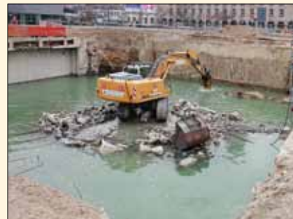
Demolice stávající betonové desky na křížení tunelů v Ettlínger Strasse a Kriegstrasse prováděná vzhledem k úrovni podzemní vody „na slepo“ pod vodní hladinou.
