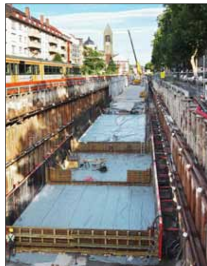
Vytěžená a přikotvená stavební jáma na Durlacher Rampe
