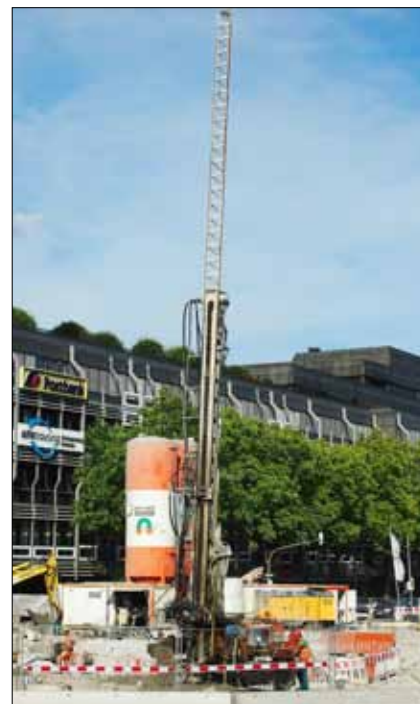
Provádění TI v křížení silničního a tramvajového tunelu mezi zastávkami na Ettlinger Tor
