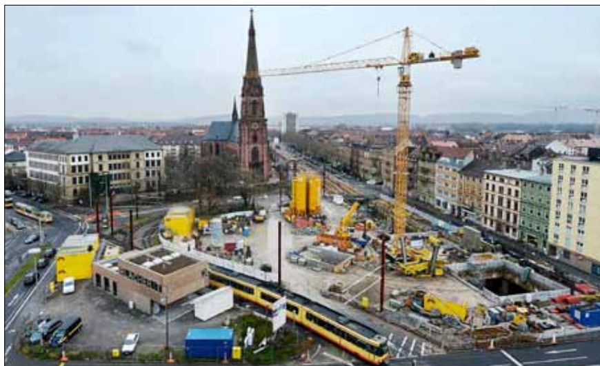
Zastávka/startovací šachta TBM – Durlacher Tor
