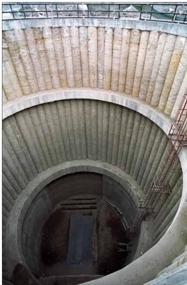
Obr. 6: Pilotová oválná stěna ze 70 převrtávaných pilot průměru 1,18 m, délky 40,0 m na stavbě železničního tunelu Březno v roce 2005. Jáma byla budována observační metodou.
