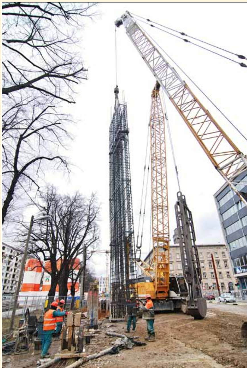
Osazování armokoše PS, Ettlinger Strasse
