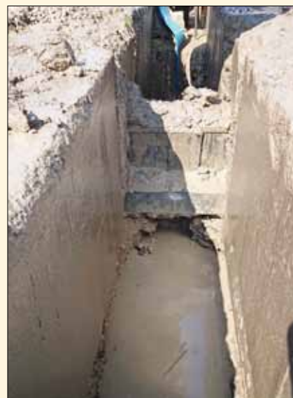
Podtěžení kabelovodu v rýze PS
