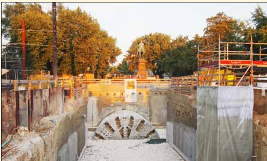
Razicí štít po průchodu do cílové šachty na Mühlburger Tor
