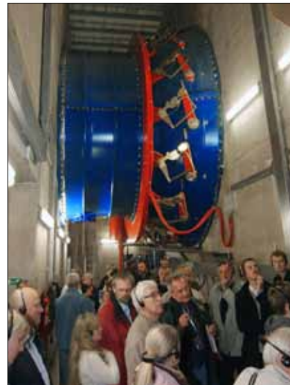
Odborný výklad v technických prostorách pod turbínami elektrárny
