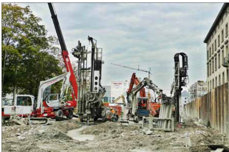
Provádění tahových GEWI tyčí na hloubeném úseku Ettlinger Straße
