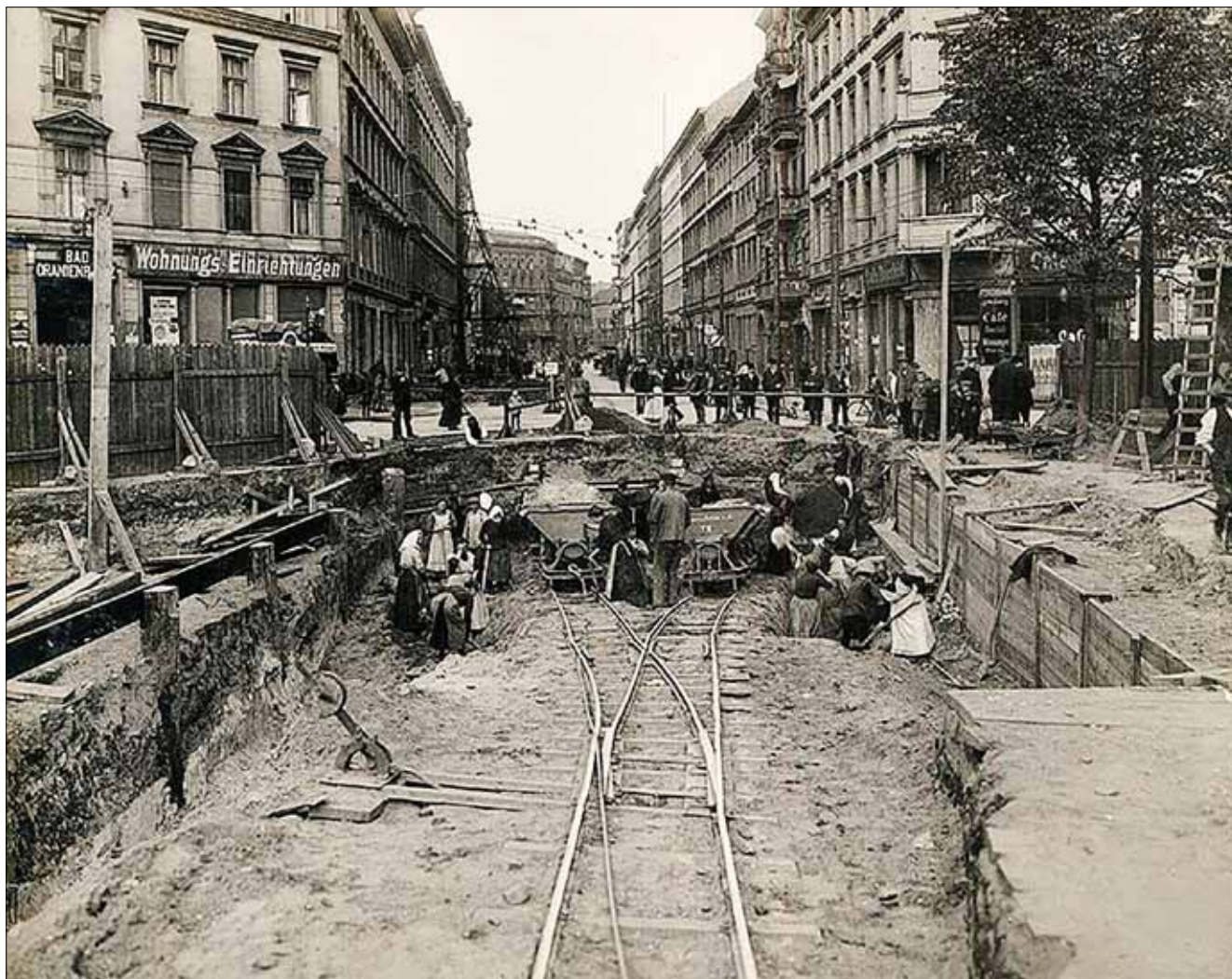
Obr. 3: Výkop jámy zajištěné raženým záporovým pažením pro hloubený tunel berlínské U-bahn na Dresdener Strasse v roce 1907 (internet)
