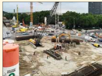
Realizace podzemních, Ettlínger Strasse
