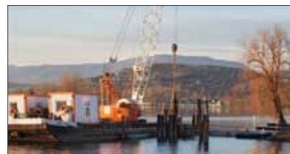
Těžba vrtů pro osazení dvojice svařených štětovnic Larsen IIIa a následné zhotovení dalby, Nučnice
