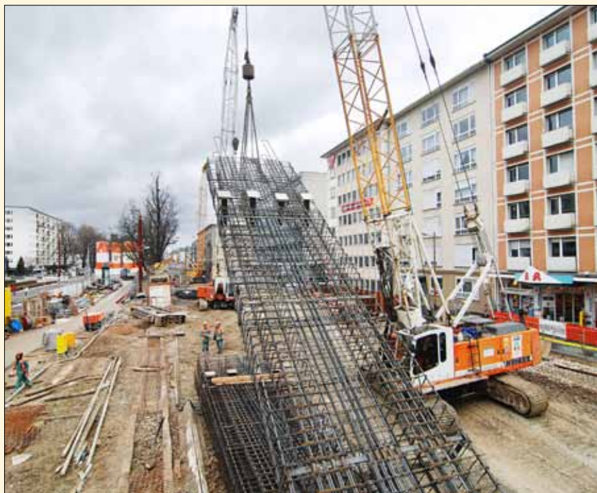
Realizace podzemních stěn, Ettlínger Strasse
