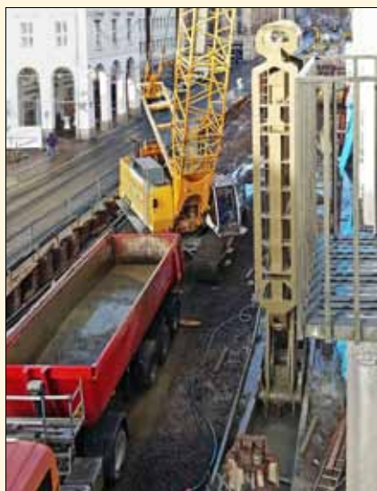
Těžba PS v těsné blízkosti fasád okolních budov, Marktplatz
