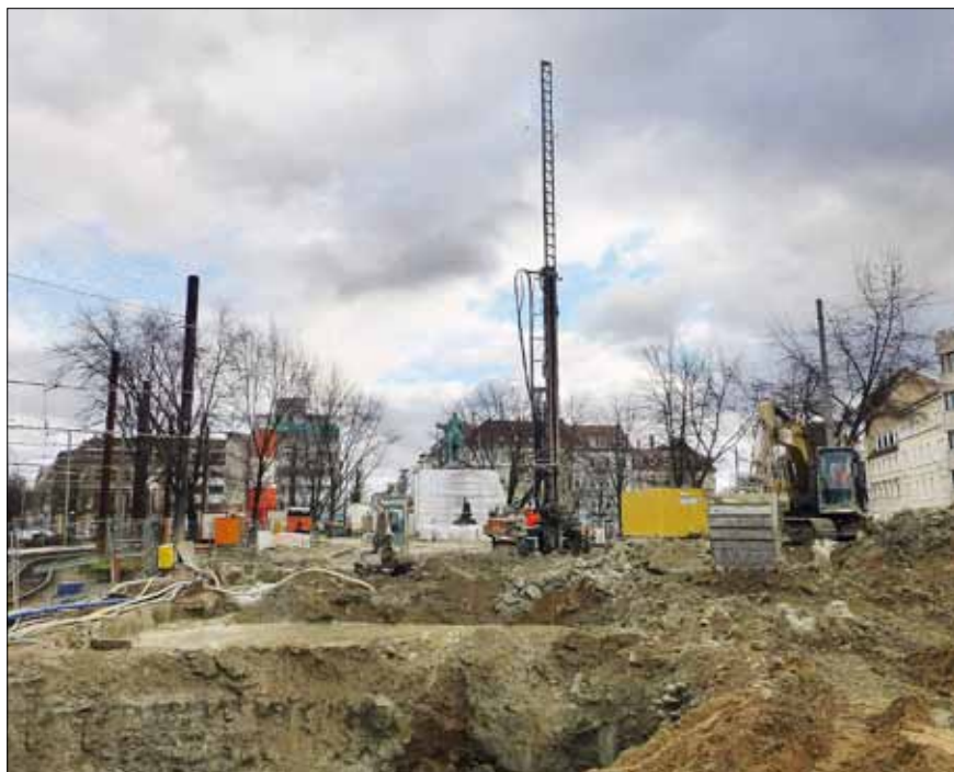
Zhotovení monobloku z TI za cílovou šachtou TBM – Mühlburger Tor
