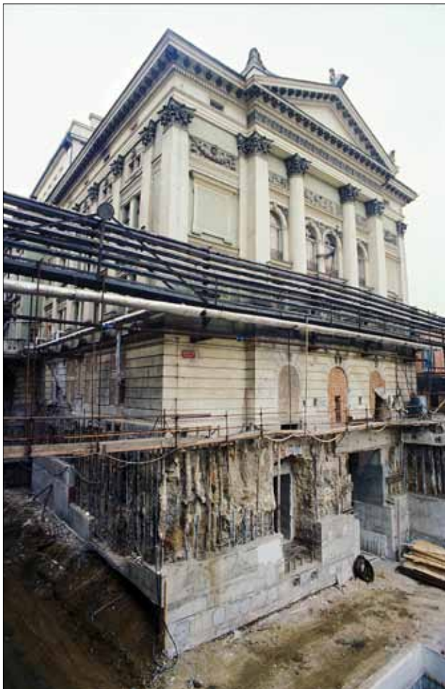
Obr. 7: Mikropilotové stěny použité pro zajištění budovy Stavovského divadla v Praze při prohlubování suterénů v roce 1986 (Zakládání staveb, a. s.)
