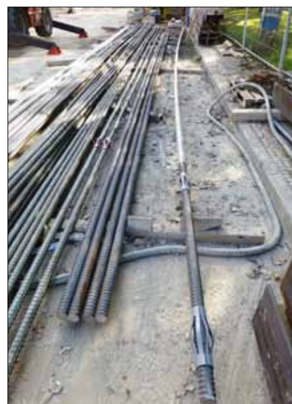
GEWI tyče Ø 50–63 mm, délky 17–24 m před osazením
