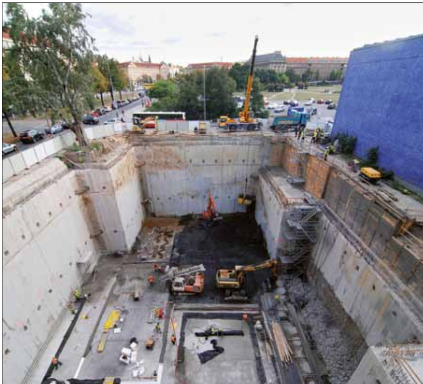
Stavební jáma zajištěná konstrukčními podzemními stěnami během dokončování základové desky
