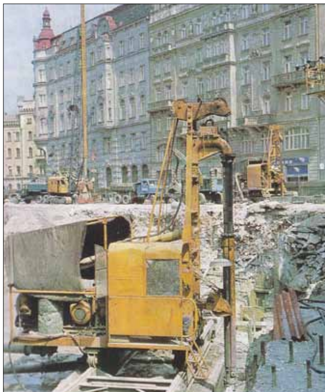
Obr. 8: Nárazové soupravy Rodio RF-6 s reverzní cirkulací na stavbě pražského obchodního domu Kotva v roce 1972. V pozadí je též vidět jedna z nově zavedených souprav Rodio s vedeným kelly drapákem na bagrjeřábu UB 160 z NDR (Zakládání staveb, a. s.)
