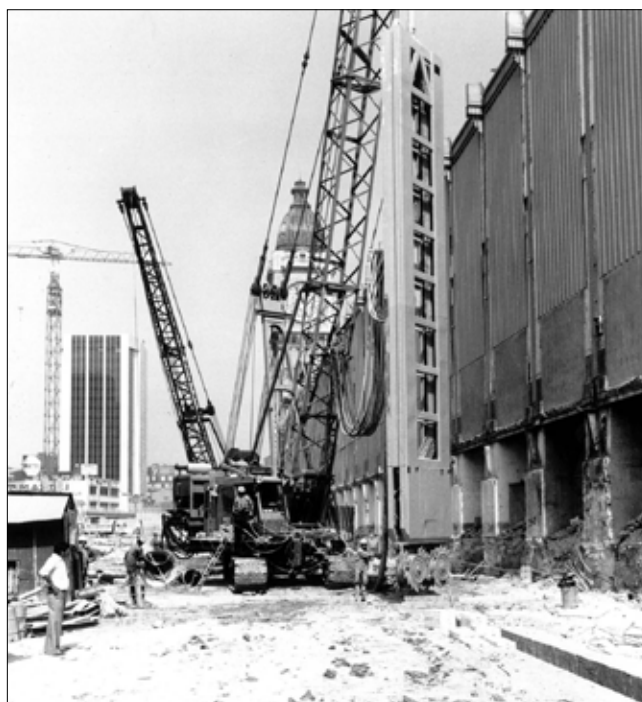
Obr. 11: První hydrofréza s těžkým bagrjeřábem na stavbě nádraží Garé de Lyon v Paříži v roce 1974 (Soletanche)
