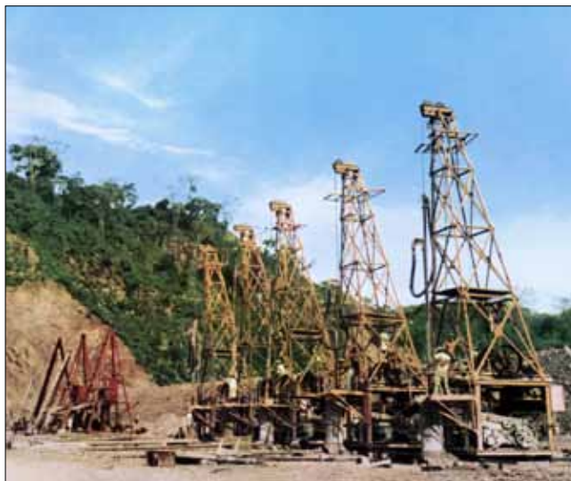
Obr. 4: Soupravy firmy I.C.O.S. na stavbě podzemní clony o maximální hloubce 89 m pro mexickou přehradu Villita v roce 1965. V popředí původní technologie nárazově vrtných „milánských stěn“ pro hluboké úseky, v pozadí trójnožkové soupravy s lehkými drapáky pro mělčí úseky (firma I.C.O.S.).
