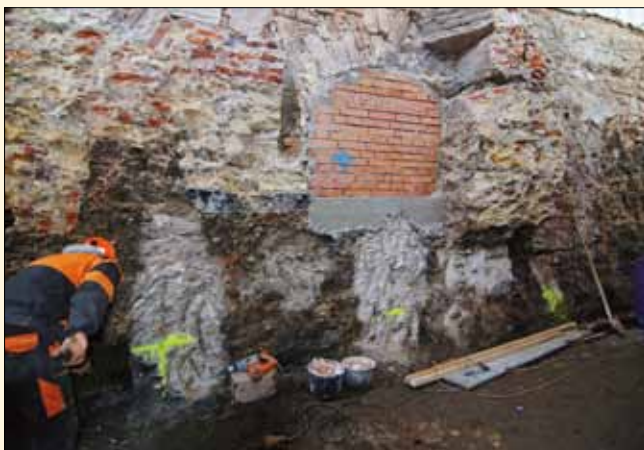
Základové konstrukce v suterénu posílené dobře viditelnými sloupy tryskové injektáže
