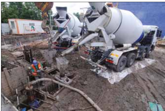
Betonáž podzemních stěn rohové lamely
