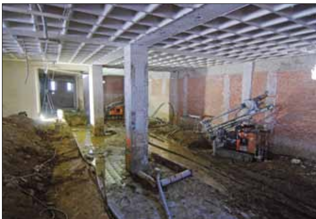
Podchytávání patek skeletu stávající budovy B sloupy tryskové injektáže
