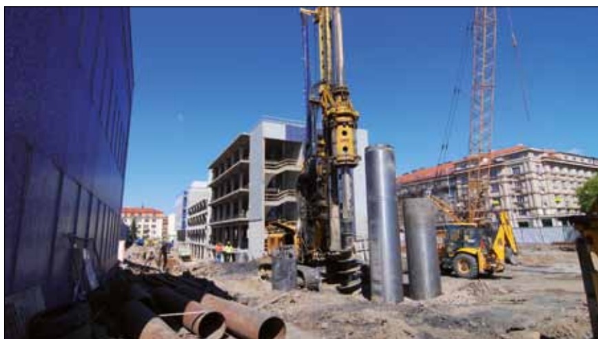
Realizace pilot, objekt A
