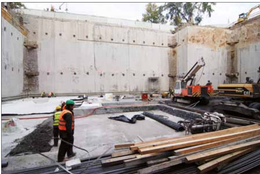
Provádění základové desky v již dotěžené stavební jámě
