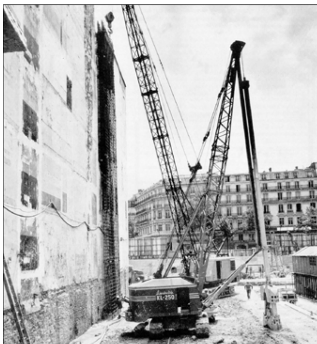
Obr. 10: Lanový drapák s vodící kelly tyčí z pilotovací vrtačky na stavbě na bulváru Haussman v Paříži v roce 1966 (Soletanche)
