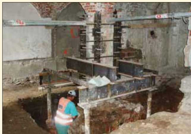
Sloup SL2 podchyčený pomocí MP báře
