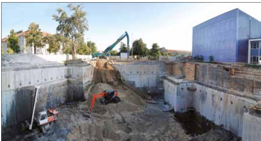
Těžba zapažené stavební jámy a úpravy povrchu podzemních stěn strojní frézou
