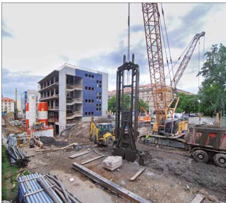
Těžba rýhy pro podzemní stěny lanovým drapákem, objekt A
