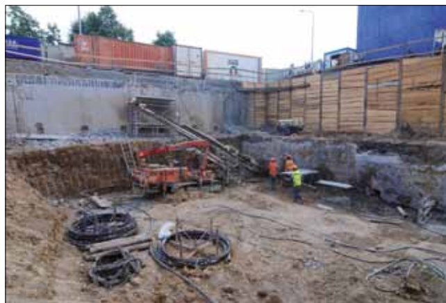
Kotvení PS dočasnými pramencovými kotvami vrtnou soupravou HBM 120 SB
