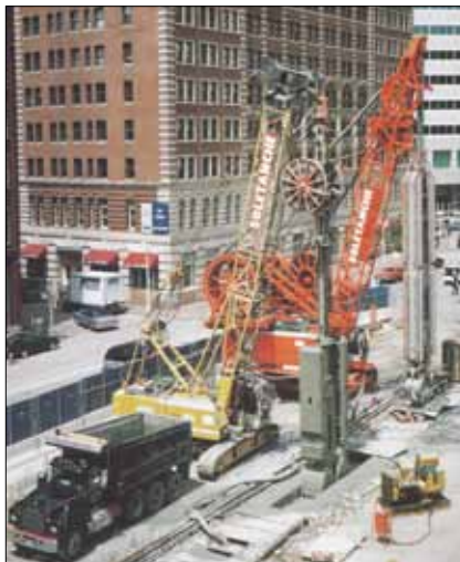
Obr. 13: Typická sestava souprav hydraulického drapaků a hydrofrézy, tentokrát ze stavby hloubených tunelů bostonské centrální automobilové tepny v USA v roce 1996 (Soletanche)
