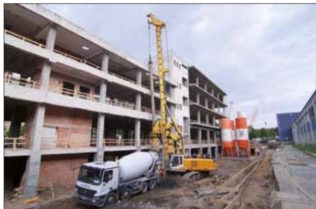
Provádění základových pilot pro nově dostavovaný trakt budovy B vrtnou soupravou BG 28
