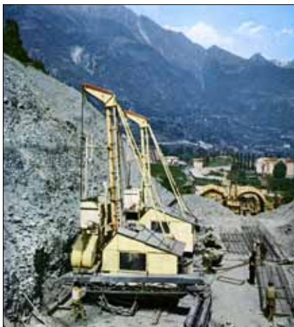
Obr. 6: Ukázka sestavy lehkých drapákových strojů pro podzemní stěny tl. 80 cm firmy I.C.O.S. na stavbě tunelu dálnice A5 u Chatillon v severní Itálii v roce 1967 – zřetelné je složité řešení vyprazdňování drapáku do násypkových skříní a na pásový dopravník (firma I.C.O.S.)
