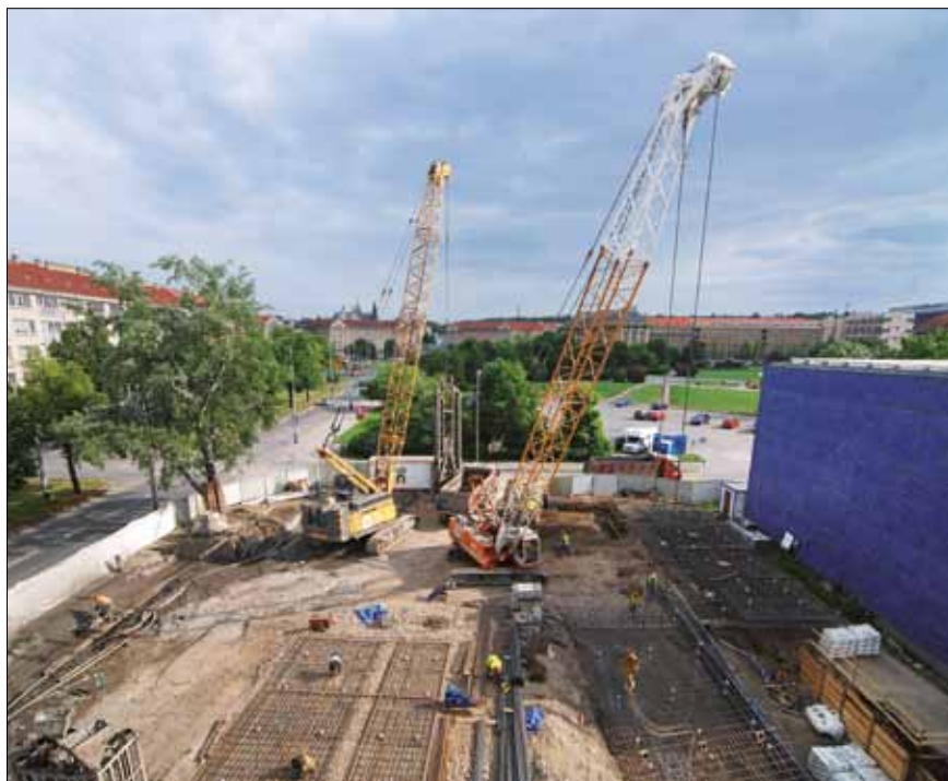
Těžba podzemních stěn a výroba armokošů, objekt A
