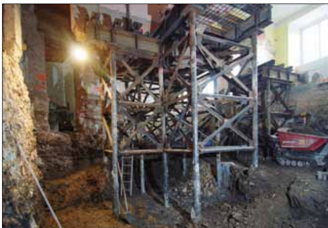
Mikropilotové bárky v místě plánovaného pilíře č. 1
