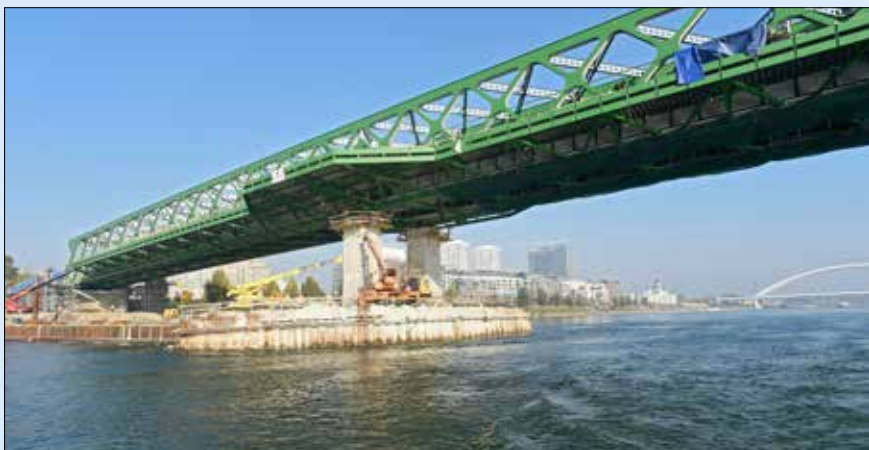
Nová vysunutá mostní konstrukce již opřená o pilíř 34 a pilíř 2 na levém břehu (11/2015)
