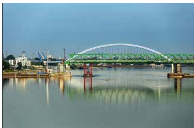
Výsuv nové mostní konstrukce na pilíř 34 za pomoci montážního podepření plovoucí podpěrou
