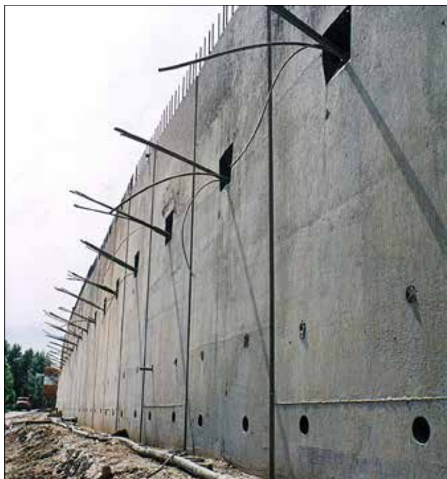
Obr. 9: Osazování prefabrikovaných panelů podzemní stěny na Strakonické ulici v Praze, rok 2001 (Zakládání staveb, a. s.)
