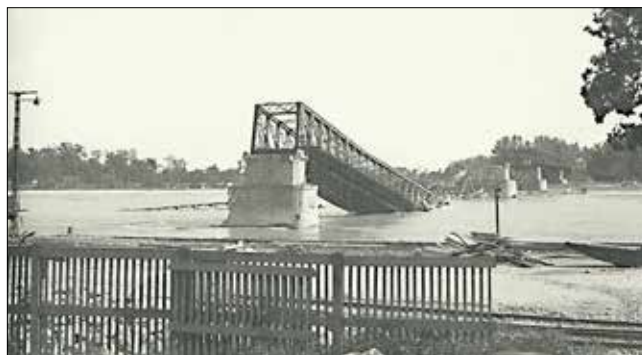
Zničený most po odstřelu německou armádou při ústupu v roce 1945.
