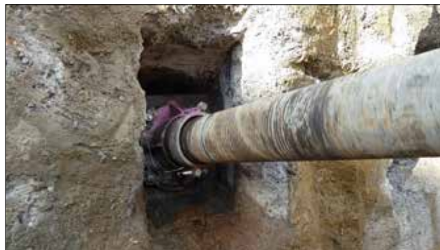
Upravený původní pružinový preventr, který byl již plně funkční. Návrtný bod je cca 6 m pod hladinou podzemní vody.
