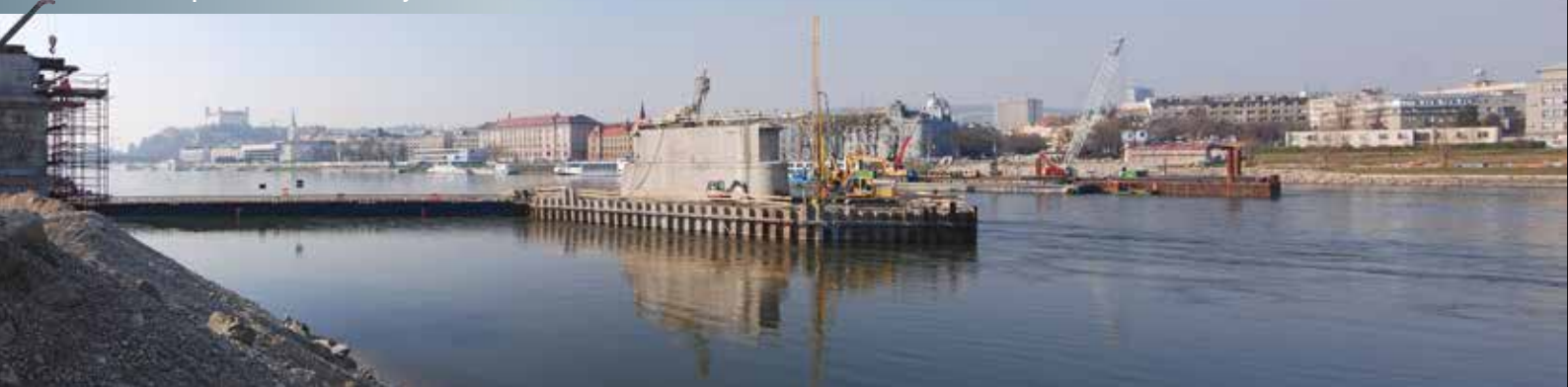
Práce na posílení základů pilíře 5 tryskovou injektáží a budování dvojité jímky pro nový pilíř 34 (3/2015)
