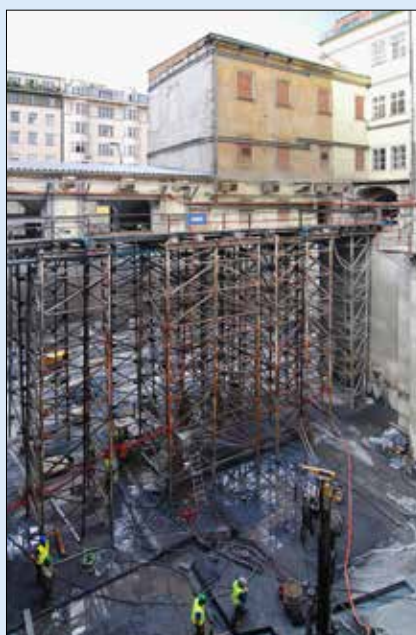
Před zahájením vestavby byla stavební jáma zajištěna po obvodu technologií tryskové injektáže a dvorní křídla památkově chráněných částí původní stavby byla vynesena na mikropilotových bárkách
