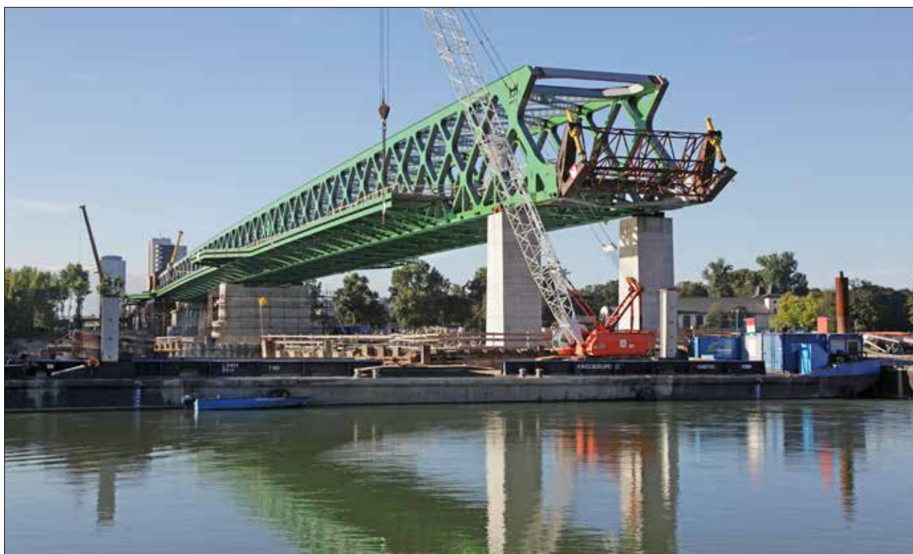
Výstavba pilíře spodní rozšířené části pilíře 34
