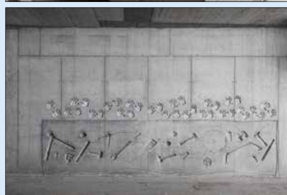
Finální povrch schodišťových stupňů a otisky rukou a nářadí v 1. PP v podzemních garážích
