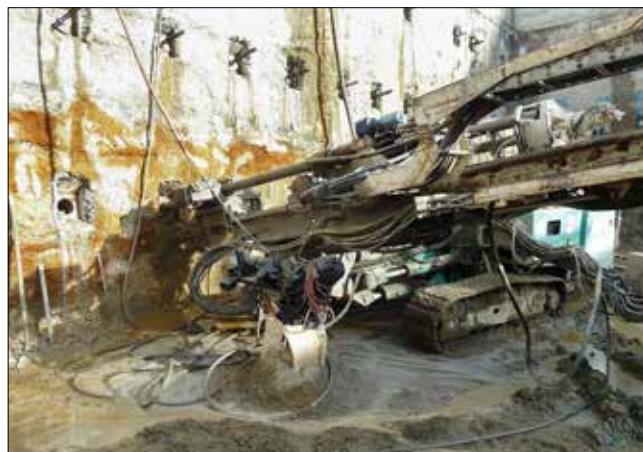
Chorvatská společnost Grasa při realizaci kotev
