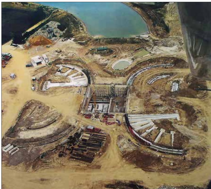
Letecký pohled na čerpací stanici od řeky Sávy během probíhající vestavby stanice
