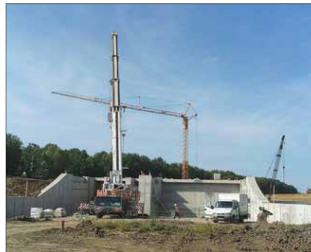
Instalace vnitřního vybavení stanice, říjen 2015
