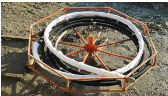
Kotva s nasazeným jutovým vakem v kořenové části
