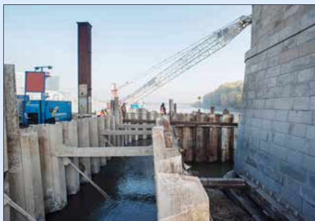
Zaplavená jímka pilíře 5 během demontáže (11/2015)
