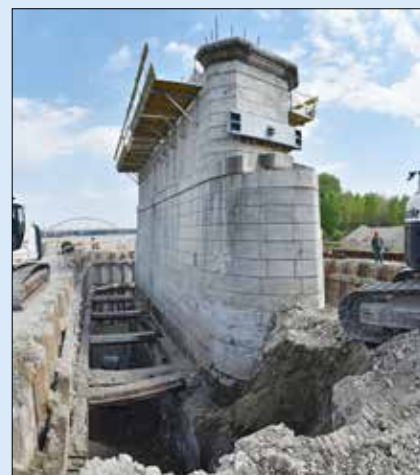
Pilíř 5 po posílení základů tryskovou injektáží a před rozšířením základu (4/2015)
