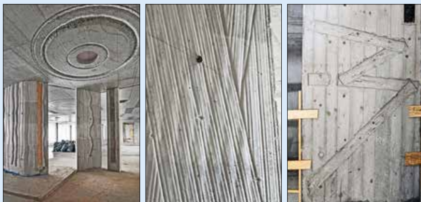
Definitivní povrch betonových pohledových konstrukcí byl vytvářen nejrůznějšími prostředky
