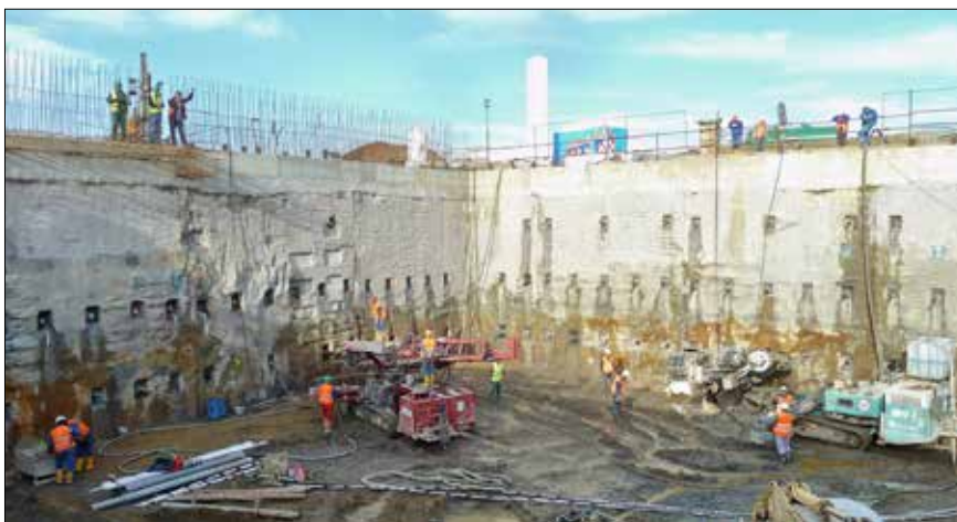
Stavební jáma čerpací stanice, kotvení 3. úrovně pramencovými kotvami
