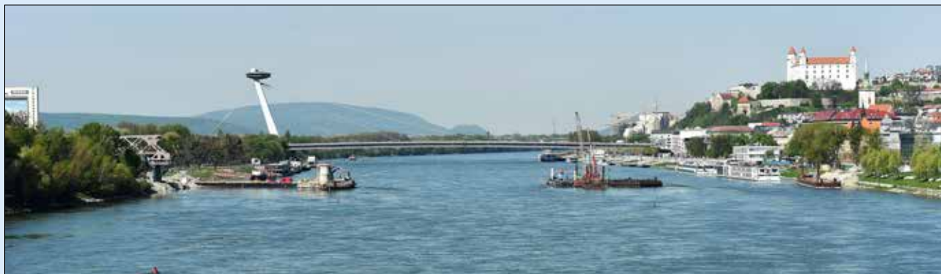
Jímky pro výstavbu pilířů od východu (4/2015)
