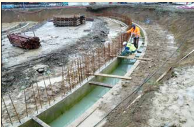
Příprava výztuže pro nadbetonování vodicích zídek, patrná je vysoká hladina podzemní vody ve stávajících zídkách
