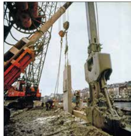
Obr. 8: Provádění prefabrikované podzemní stěny Panosol pro nábřeží v normandském letovisku Deauville-Trouville ve Francii v roce 1977 (Soletanche)
