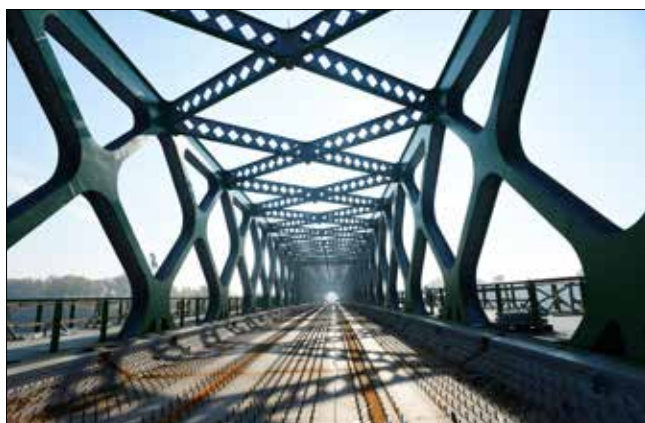
Konstrukce mostu, příprava zapuštěného kolejového systému souvislého podepření koleje
