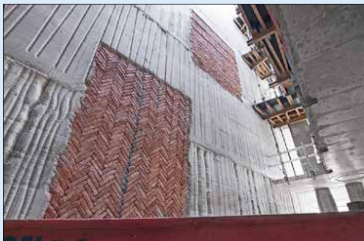
Pohledová betonová stěna s vložením cihel z původní stavby
