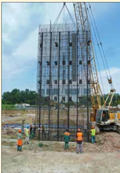
Spojování 2 kusů armokošů nad rýhou
