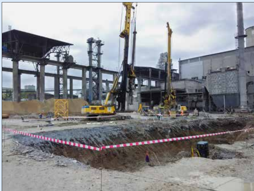
Realizácia pilótového založenia kruhového sila, v popredí technologický kanál
