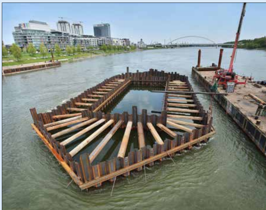
Jímka pilíře 34 před zasypaním a následujícím prováděním tryskové injektáže pro nový základ pilíře (4/2015)
