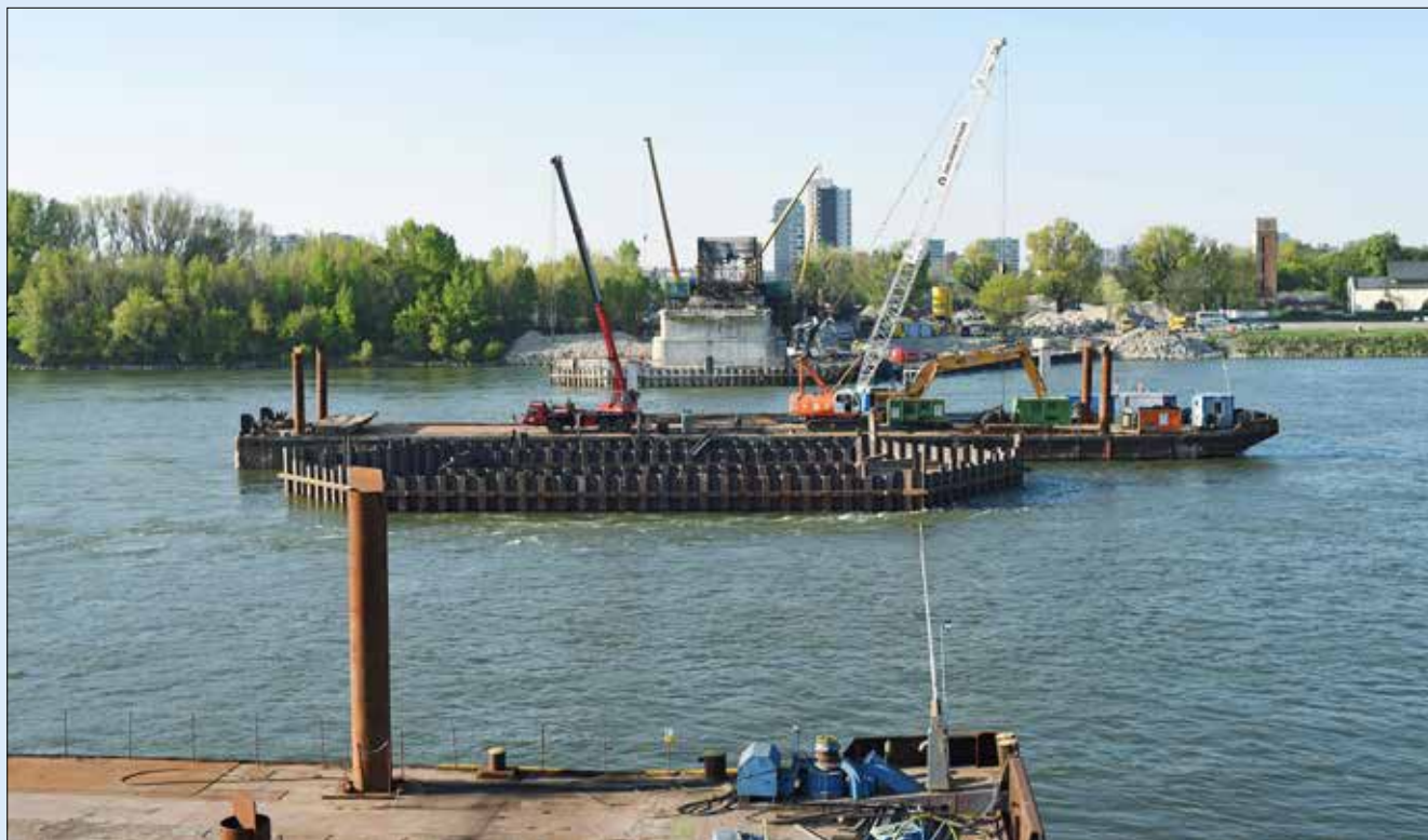
Výstavba jímky pro pilíř 34, na protějším pravém břehu probíhá montáž nové mostní konstrukce (4/2015)
