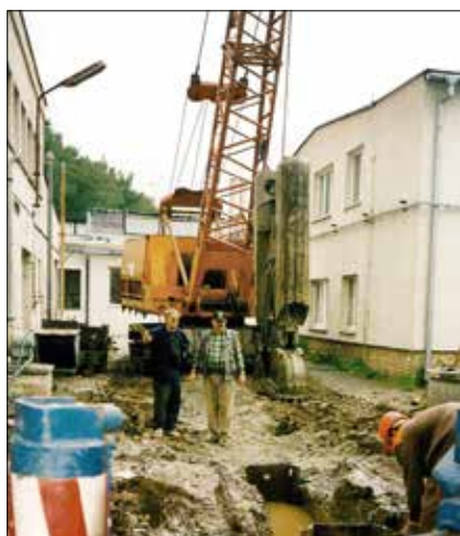
Obr. 11: Zřizování drenážní podzemní stěny lehkým lanovým drapákem při neobvyklém uspořádání „obkročmo“ nad rýhou ve stísněných poměrech provozu továrny. Sanace znečištění v podniku Pílana Hulín v roce 2009 (Soletanche ČR).
