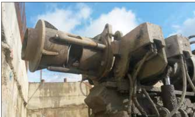
Vrtný pružinový preventr použitý při zahájení vrtání na druhé kotevní úrovni
