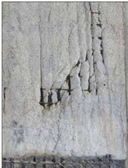
Obr. 7: Příklad poruchy podzemní stěny v důsledku špatné zpracovatelnosti betonové směsi (autor)
