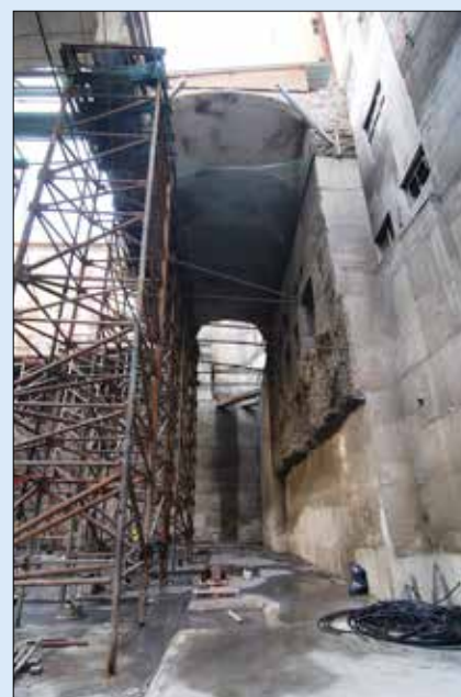
Před zahájením vestavby byla stavební jáma zajištěna po obvodu technologií tryskové injektáže a dvorní křídla památkově chráněných částí původní stavby byla vynesena na mikropilotových bárkách
