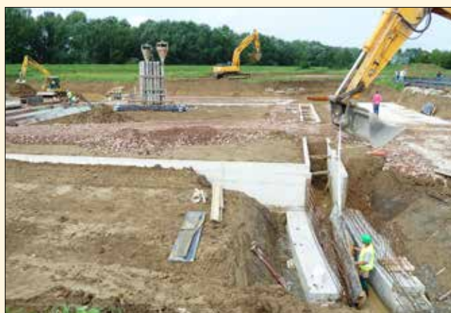
Výroba vodicích zídek
