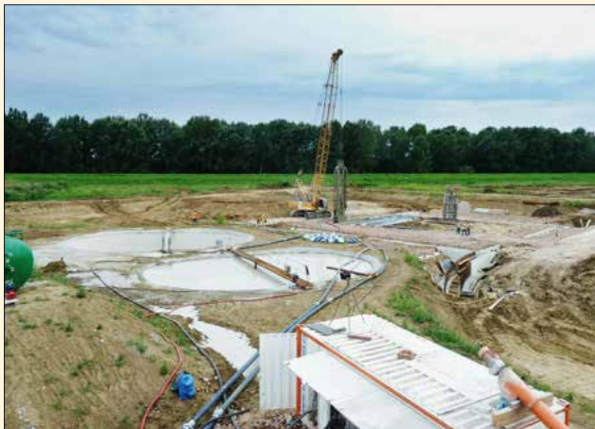
Staveniště těsně před zahájením výroby podzemních stěn
