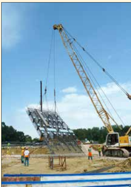
Zvedání armokoše do svislé polohy
