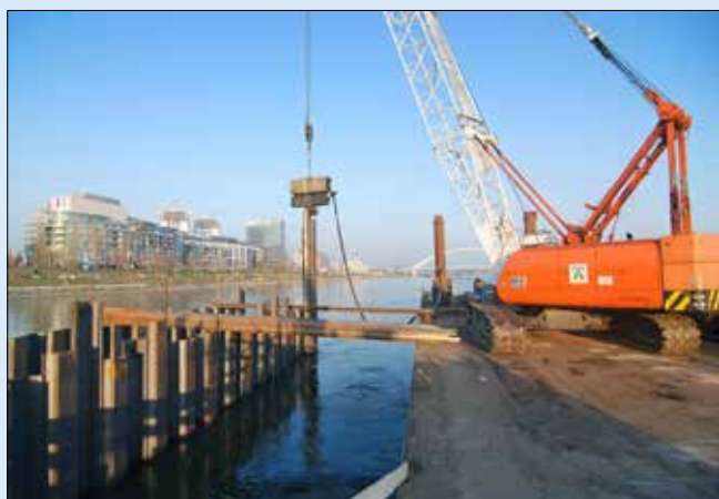
Beranění štětovnic VL604 na jímce pro pilíř 34 (3/2015)
