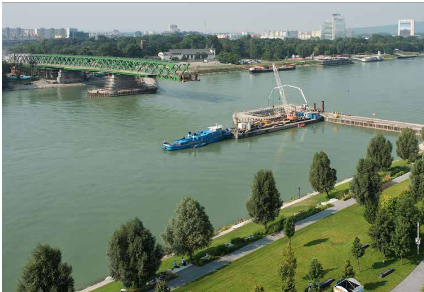
Výsuv mostní konstrukce mezi pilíři 5 a 34. Pod ochranou dvojitě jímkou probíhá výstavba základů a pilíře 34. (8/2015)
