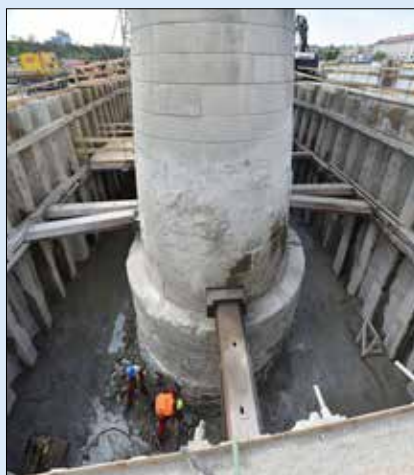
Pilíř 5 po posílení základů tryskovou injektáží a před rozšířením základu (4/2015)
