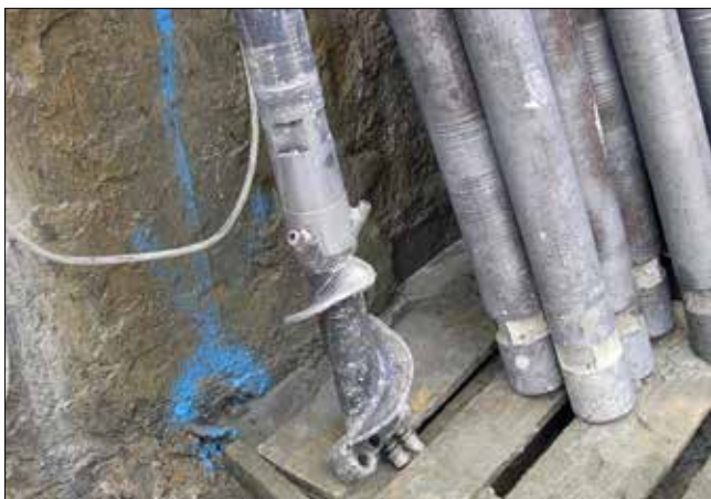
Vnitřní tyčová korunka v kombinaci se spirálem používaná při klasickém duplexovém způsobu vrtání na první kotevní úrovni
