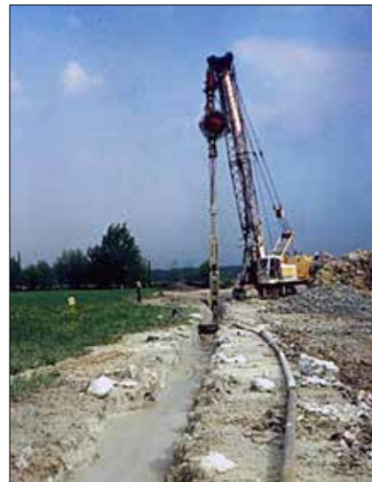
Obr. 10: Zřizování těsnicí stěny tloušťky 60 cm ze speciální samotvrdnoucí suspenze drapákovou technologií v rámci zhotovení úplného geokontejntmentu skládky toxických odpadů Kema Skalná v roce 1997 (Soletanche ČR)
