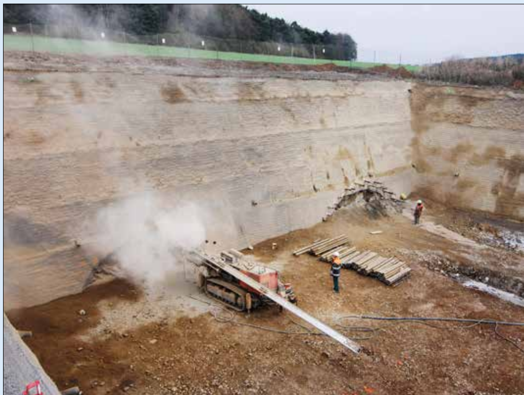
Provádění vrtů pro mikropilotové deštníky nad vrchlíky obou tunelů
