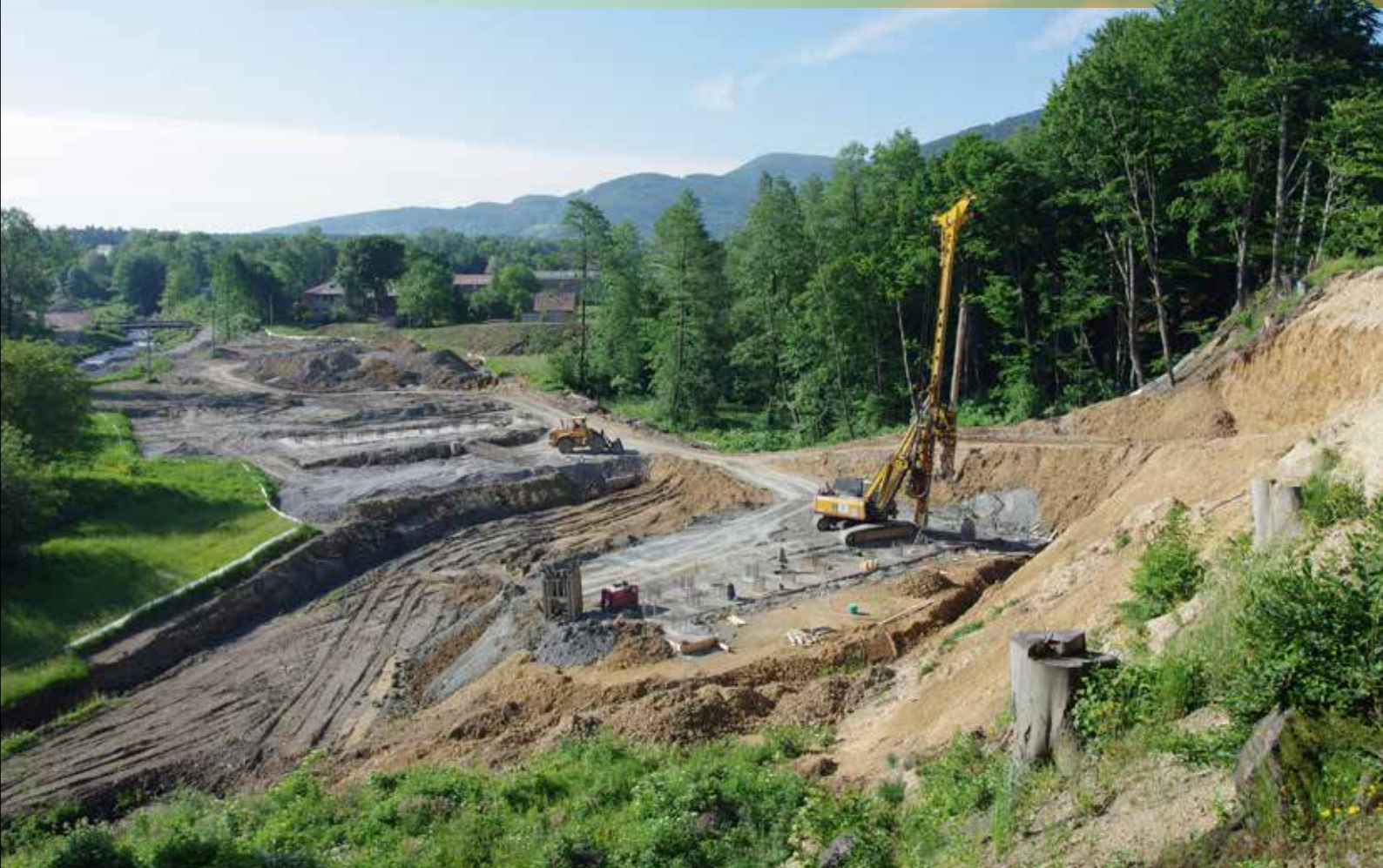
Provádění základových pilot pod mostem SO 210 přes vodoteč v km 9,324
