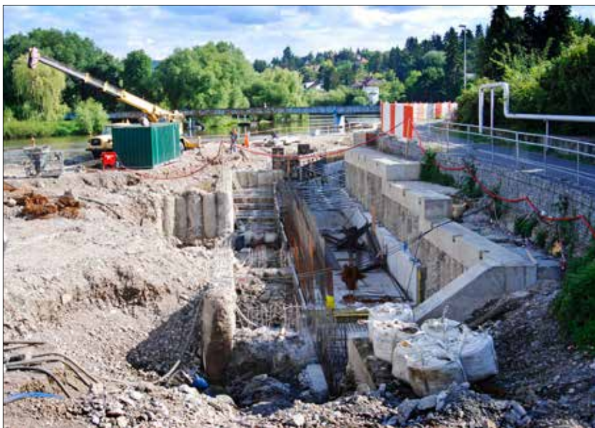
Stavební jáma lodní propusti a rybího přechodu, prováděny jsou již oblaky lomovým kamenem na nábrežní stěně.
