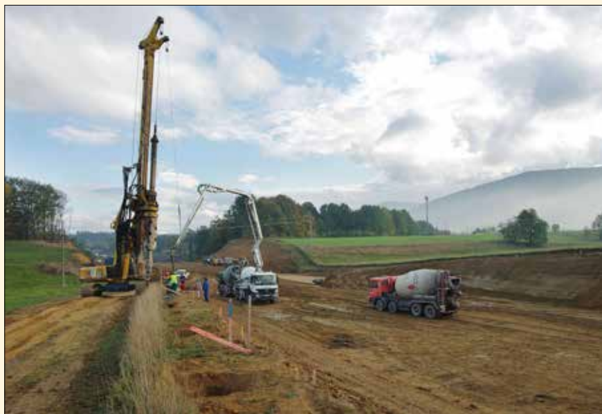
Pilotové založení protihlukových stěn
