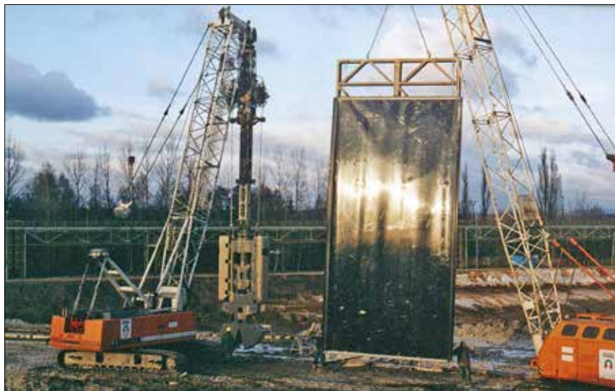
Obr. 12: Osazování panelu geomembrány z PEHD tl. 2 mm do hloubky 10 m v těsnicí podzemní stěně při nové úpravě skládky zelené skalice v Precheze Přerov v roce 2001 (Zakládání staveb, a. s.)
