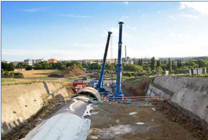
Stavební jáma portálu Chlum, pohled směrem k Plzni
