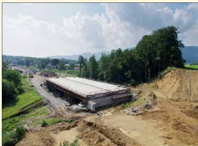
Tentýž objekt jako na horním obrázku po dokončení mostovky
