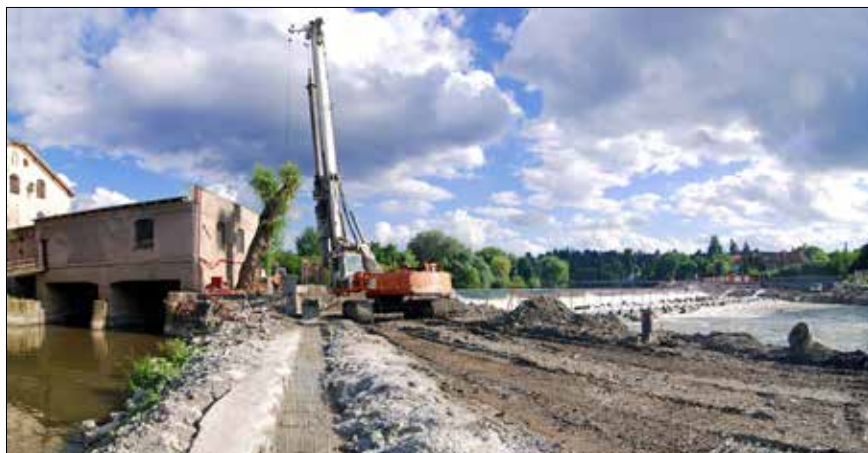
Zakládání pravobřežní dělící zdi u MVE
