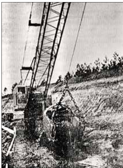
Obr. 2: Provádění clony pro přehradu West Point ve Virginii v USA v roce 1962. Vlečný koreček zřizuje bentonitovou stěnu o tloušťce 1,5 m do hloubky 18 m (internet)
