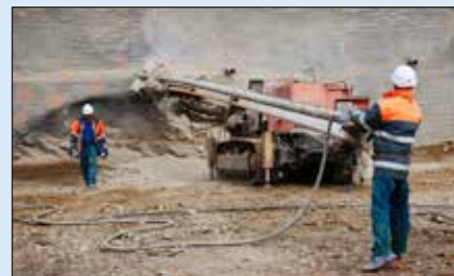
Ustanovení lafety vrtného stroje do přesné polohy při vrtání mikropilotových deštníků
