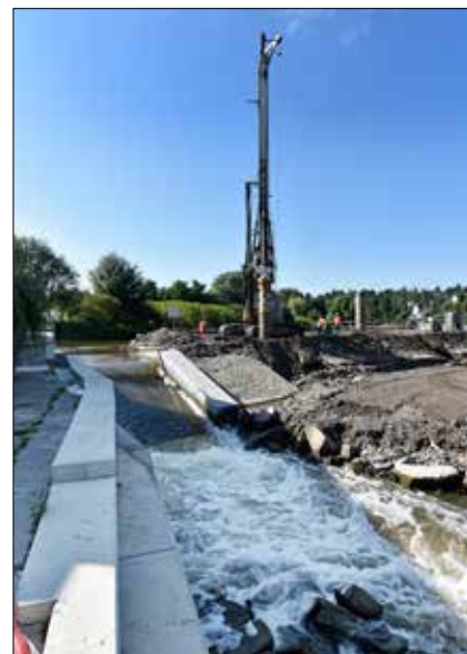
Pohled z pravobřežní dělicí zdi na štěrkovou propust a záhozovou pravobřežní část jezu, na němž probíhá vrtání pilot návodní jezové stěny.
