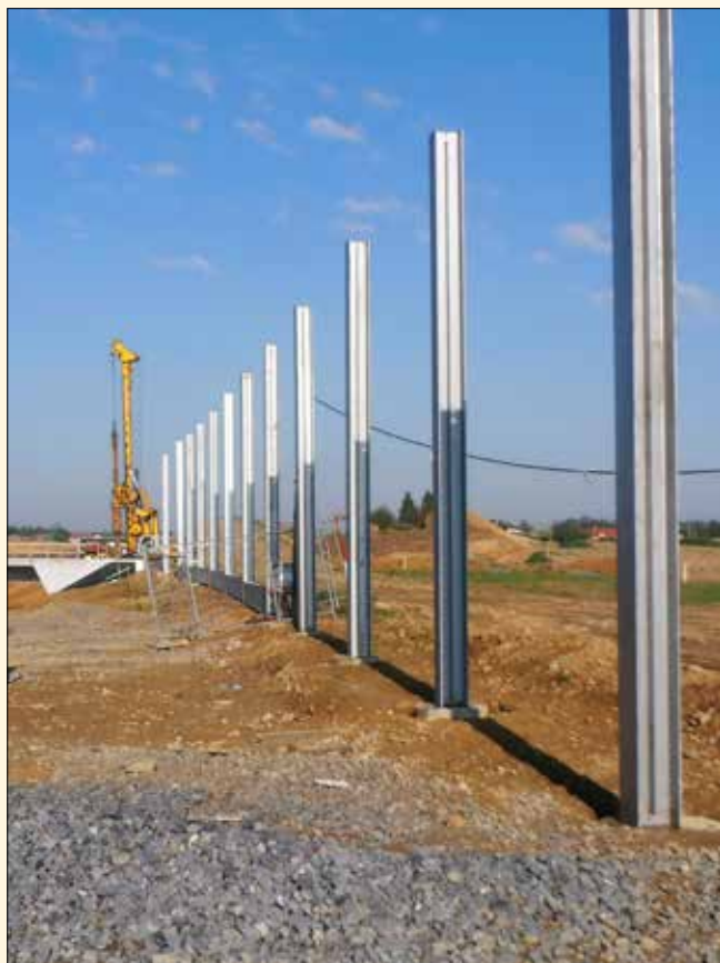
Protihlukové stěny po osazení svislých stojek
