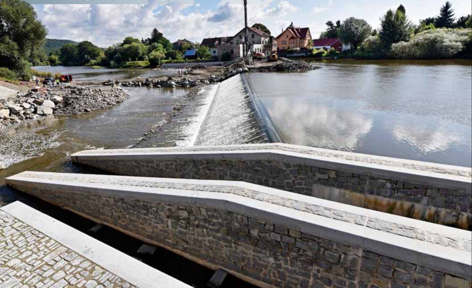
Pohled na dokončenou část jezu, v popředí dolní část rybního přechodu a lodní propust. Na zájmkované straně je v poslední etapě prací prováděna převrtávaná pilotová stěna návodní strany jezu.
