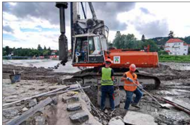
Detailní pohled na hloubení pilot pravobřežní dělící zdi
