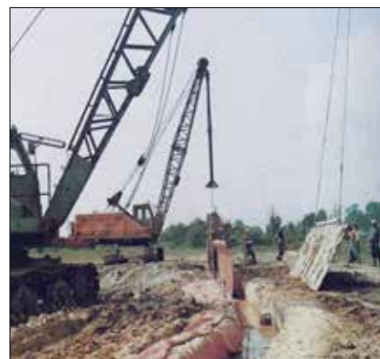
Obr. 11: Budování těsnicí clony s geomembránou kolem skládky agresivní zelené skalice v chemičce Přešov v roce 1981. Fólie Isofol z měkčeného PVC byla instalována tzv. „ze svitku“ do hloubky 7 až 9 m (SZZS, o. p., Vodní stavby)
