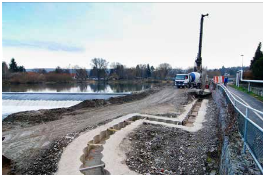
Levobřežní pracovní plošina s připravenými šablonami pro převrtávanou pilotovou stěnu břehové části rybího přechodu.
