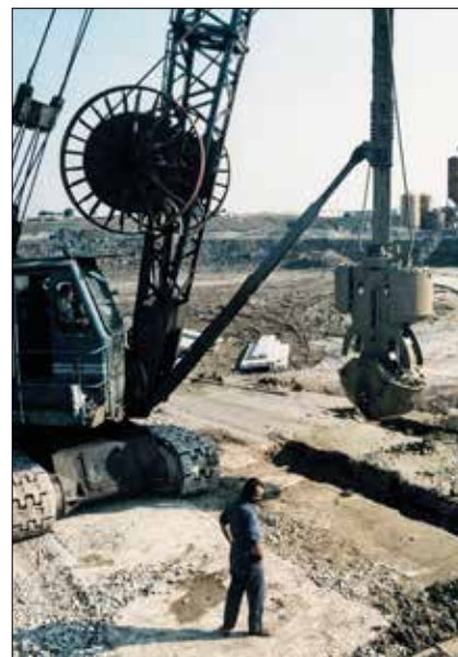
Obr. 5: Těsnicí podzemní stěna ze samotvrdnoucí suspenze pro úložiště popílkových kalů v Počeradech, těžená vedeným kelly drapákem (archiv Zakládání staveb, a. s./Vodní stavby)
