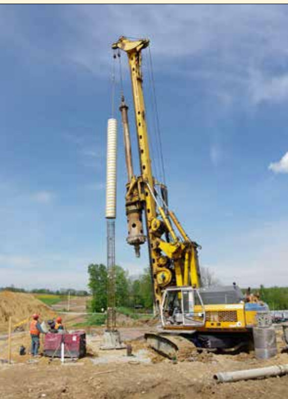
Provádění tzv. kyvných pilot
