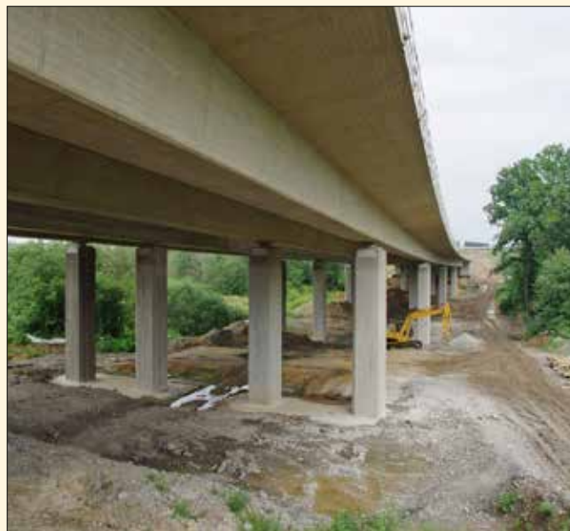
Mostní objekt SO 205 přes Bystrý potok a místní komunikaci v km 7,182
