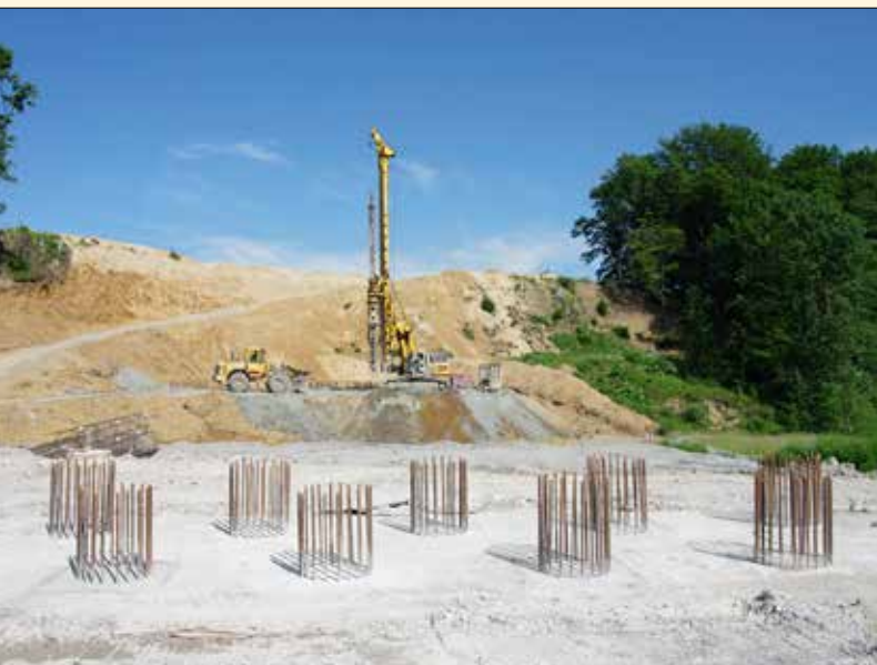
Pilotové zakládání mostu SO 210
