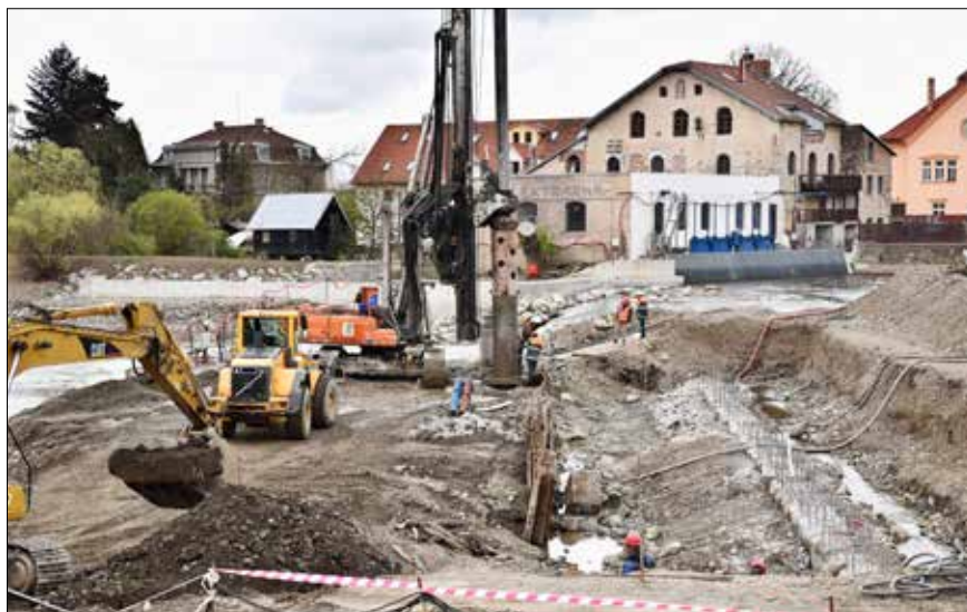
Dokončování hloubení povodní pilotové stěny, příprava základové spáry jezu, piloty návodní stěny jsou již ubourány tak, aby na ně bylo možno napojit betony vlastní přelivné plochy jezu.
