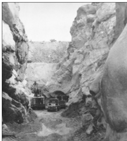
Obr. 4: Konvenční hloubení základů pilířové klenbové přehrady Daniel Johnson (Manic 5) na řece Manicouagan v Kanadě ve štěrkových sedimentech s balvanů pod ochranou dočasné protivodní hráze s hloubkou clony 78 m z pilotových elementů prvotní metody I.C.O.S., v roce 1964
