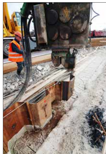
Štětová stěna osazená do rýhy vyplněné samotuhnoucí suspenzí (SO 04)
