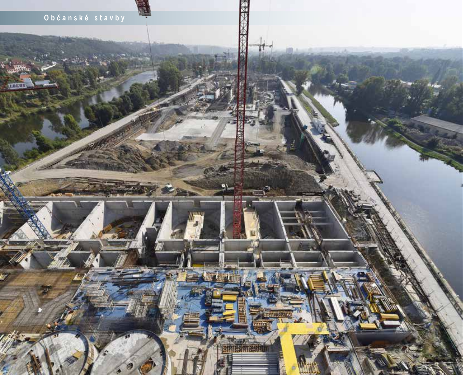
Výstavba Nové vodní linky na Císařském ostrově v Praze, pohled na východ
