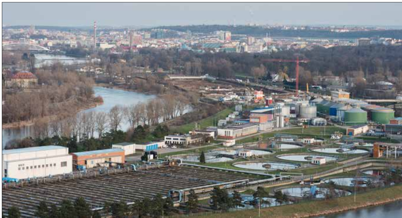
Čišařský ostrov během výstavby Nové vodní linky, v popředí stávající ÚČOV
