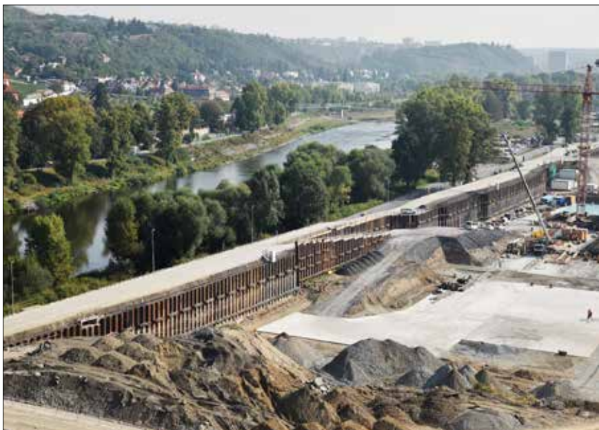
Severní strana zapažené stavební jámy s nově zřízenou obvodovou komunikací
