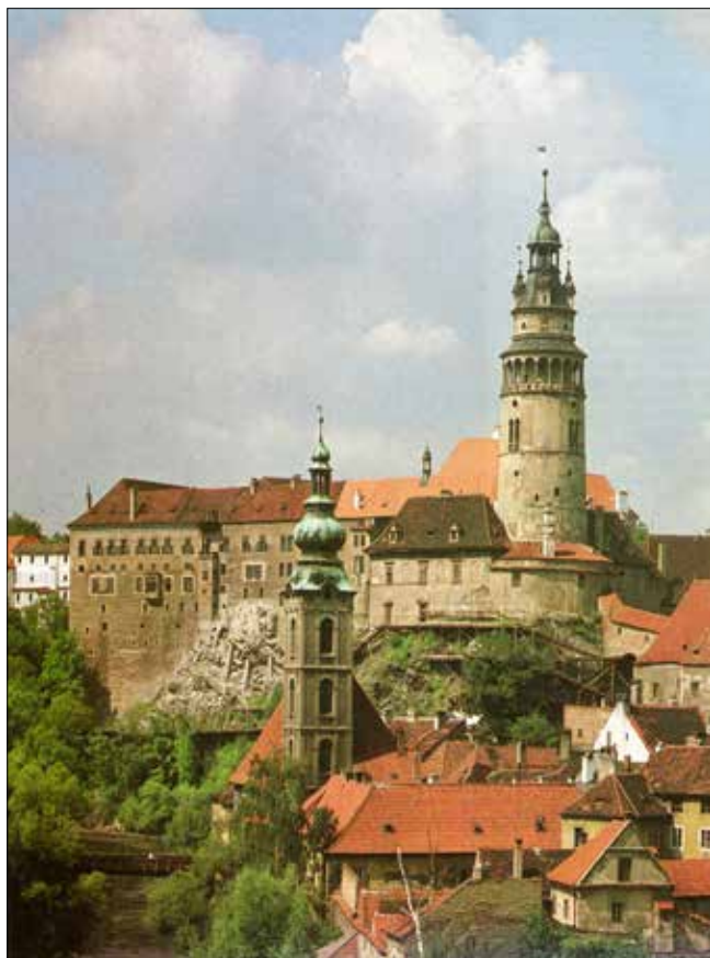
Obr. 8: Zajištění skalního svahu pod zámek Český Krumlov cementovou injektáží (Vodní stavby)
