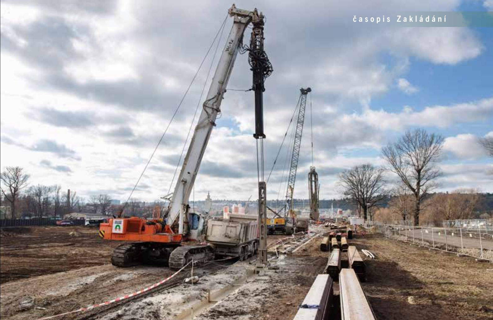
Těžba těsnicí podzemní stěny na severní straně stavební jámy
