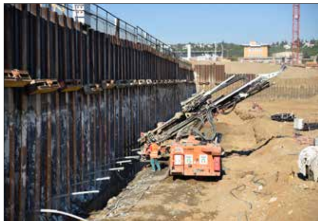
Kotvení štětové stěny na jižní strany stavební jámy
