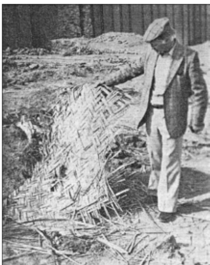
Obr. 1: Rákosové rohože nalezené poblíž starověké stavby zikkuratu v Iráku, kde byly vkládány do písčových mezivrstev a plnily funkci vyztužení i odvodnění (internet)
