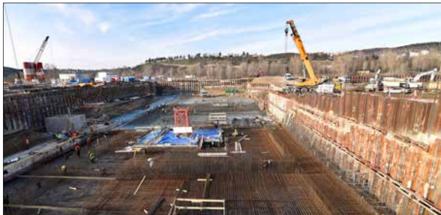
Stavební jáma objektu mechanického čištění (SO 04) zajištěná kotvenou štětovou stěnou, pohled k severu
