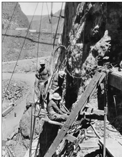
Obr. 6: Injektáž bočního skalního svahu pro přehradu Hoover na řece Colorado v USA v roce 1933. Cementová směs se injektovála do vrtů hlubokých 17 m (internet).
