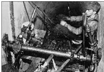
Obr. 7: Opravná injektáž ze štol přehradu Hoover v letech 1938–47 (internet)
