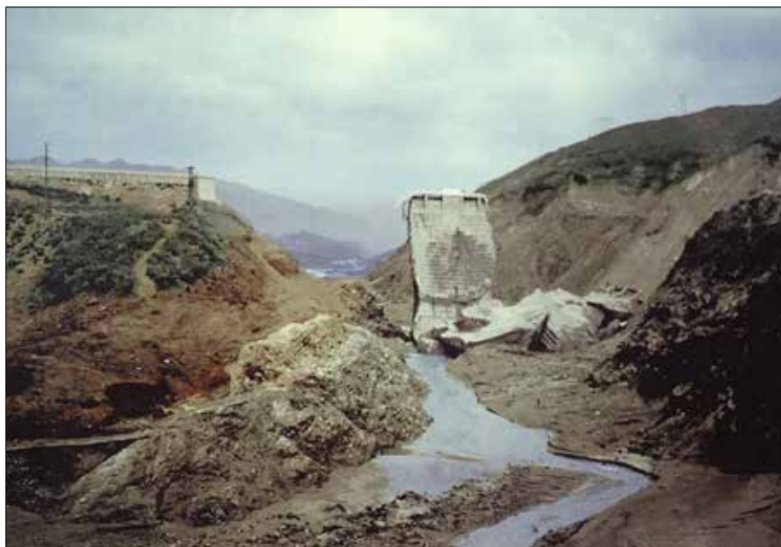
Obr. 5: Trosky zachycené den po katastrofální poruše 62 m vysoké přehrady St. Francis v Kalifornii 1928, která si vyžádala životy 425 lidí (kolorované foto, internet).
