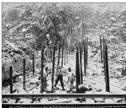
Obr. 4: Cementová injektáž skalního podzákladí a závlivka kotevních kolejnic pro dno stavby skříňe suchého doku v terminálu Balboa stavby Panamského průplavu v roce 1915
