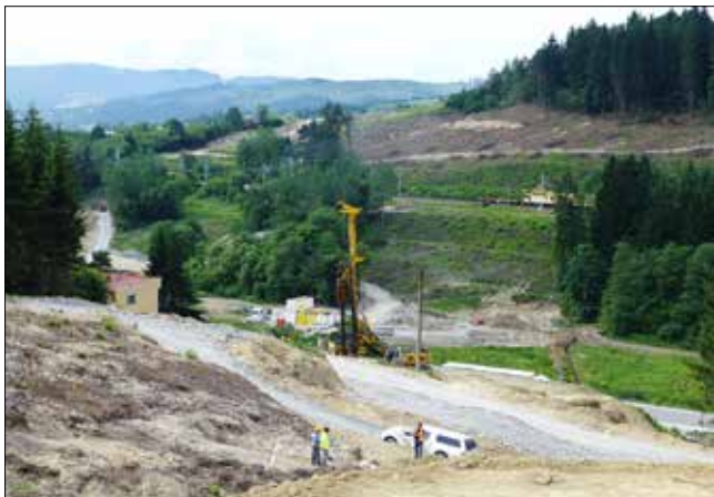
Zakládání mostních pilířů na hlavním objektu 237-10 vrtnou soupravou BG 24H
