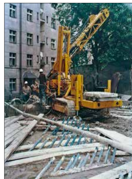
Obr. 9: Chemická injektáž na stanici metra Dejvická, prováděná Závodem 07, Vodní stavby o. p., v roce 1974. Je dobře patrné typické rozmístění vrtů s manžetovými trubkami do vějířů.
