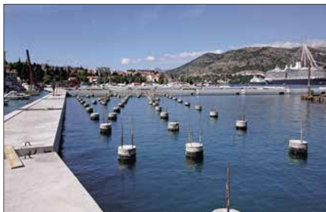
Řady hotových pilot, vlevo jsou již na piloty osazeny prefabrikáty mola.
