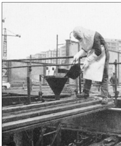
Obr. 10: Gravitační injektáž 160 °C horkým bitumenem pro utěsnění spáry konstrukce přechodu řeky Olona nad tunelem milánského metra v roce 1962 (I.C.O.S.)
