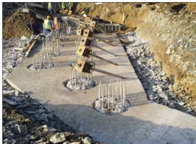
Opěra P14 na objektu 237-20, odbourané piloty, navažené hlavy na mikropilotách
