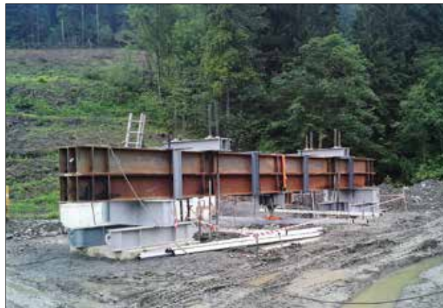
Zatěžovací zkoušky na SO 237-10, pilíř P6P
