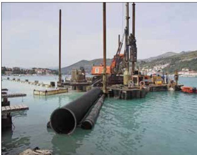
Vrtná souprava na pontonu s připravenou pažnicí
