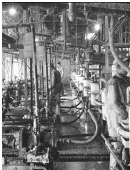
Obr. 12: Injekční stanice na stavbě pařížského metra na počátku 70. let 20. stol. (Soletanche)
