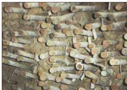
Obr. 5: Příklad velmi účinného hustého rozmístění injekčních vrtů pro vějíře při injektáží z podzemí na stavbě linky U3 vídeňského metra v roce 1986 (Soletanche)
