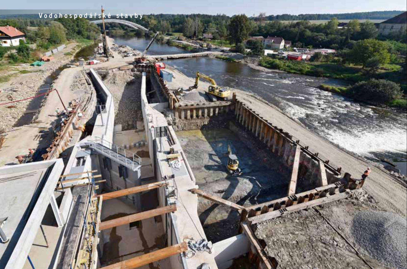
Zajištěná a vytěžená jímka jezového pole s dokončovanou plavební komorou
