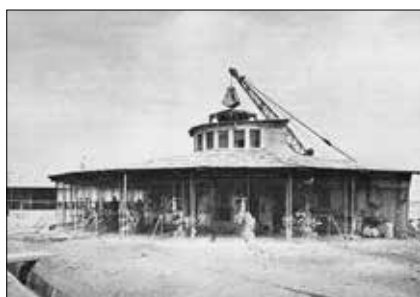
Obr. 11: Velká výrobní směsí a injekční stanice na počátku 60. let 20. stol. na stavbě injekční clony pro přehradu (Grouting and drilling muds)
