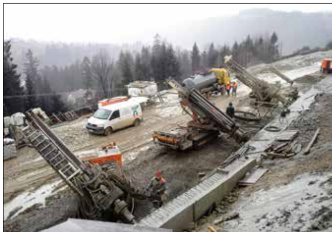
Provádění horninových kotev na SO 281-47 soupravami JANO 6165, HBM 12CB, JANO 7178
