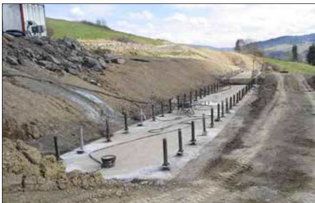
Objekt SO 281-48 s osazenými mikropilotami
