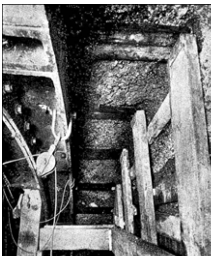
Obr. 7: Zvodnělé a kypré temžské štěrkopisky byly spolehlivě zainjektovány i ve stropě metodou Joosten I při ražbě tunelu londýnského metra u stanice Bank Monument v roce 1933 (Soil Mechanics Ltd.)
