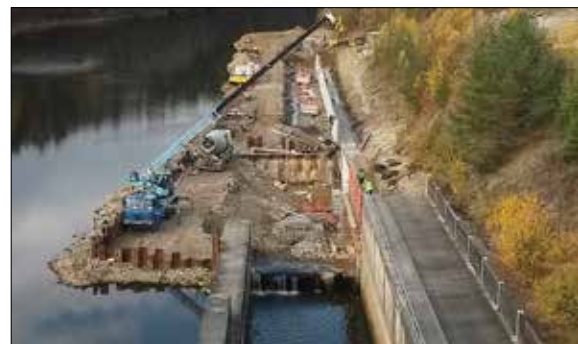
Výstavba nábrežní zdi v dolní rejdě VD Hněvkovice
