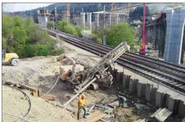
Provádění mikropilot na SO 237-20, pilíř P9, v pozadí pilíře SO 237-10
