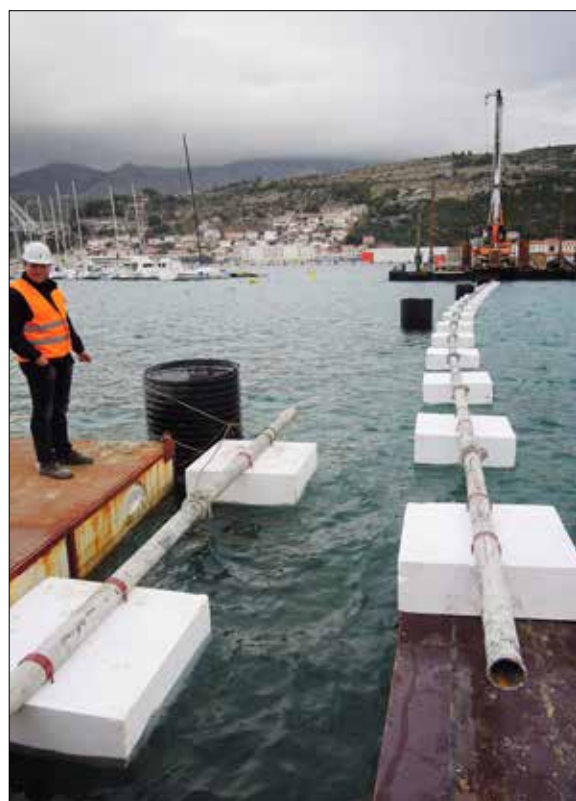
Plovoucí betonářské potrubí
