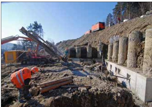
SO 237-10, pilíř P3P, provádění trvalých kotev na ochranné pilotové stěně vrtnou soupravou JANO 6165
