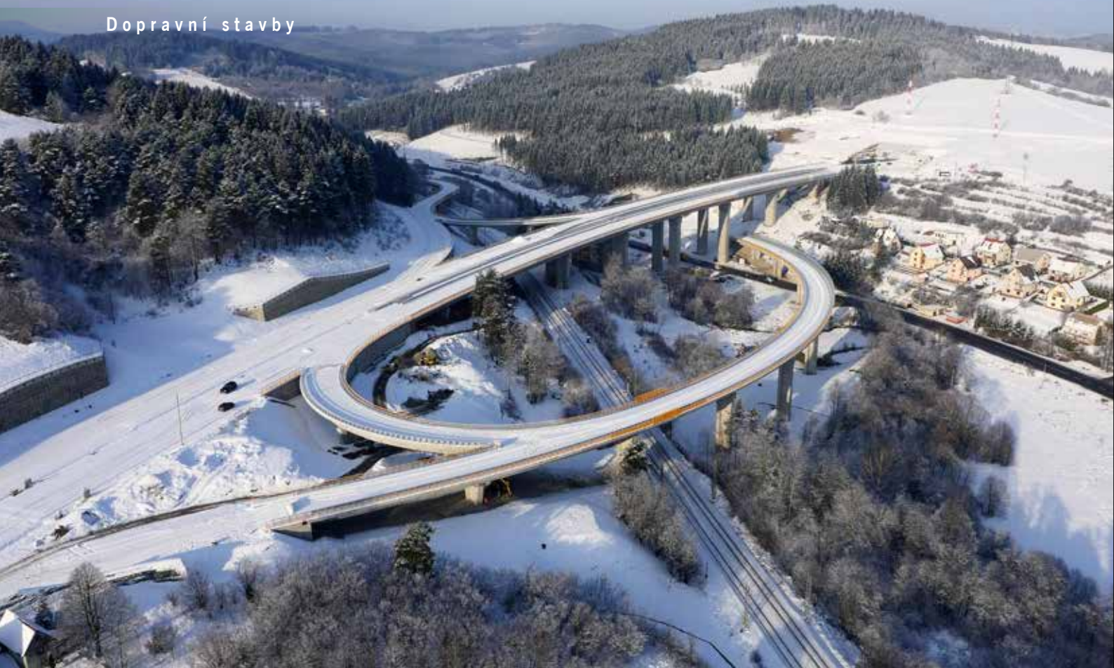
Křižovatka Svrčinovec, pohled k severozápadu, (prosinec 2016)
