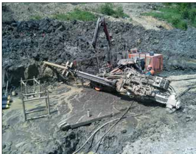
Realizace horizontálních odvodňovacích vrtů soupravou JANO HVS 7178
