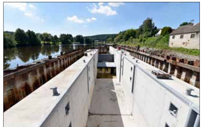
Pohled na hotovou konstrukci PK s osazenou klapkou v zajištěné jámě v horní vodě
