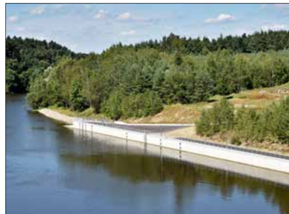
Dokončená nová nábrežní zeď v dolní rejdě VD Hněvkovice
