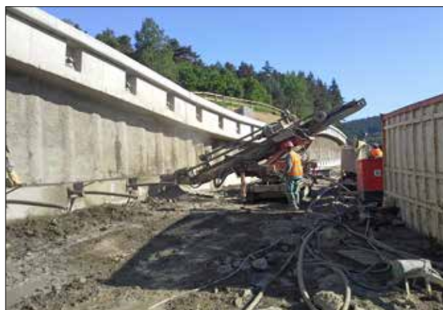
Provádění 2. KÚ trvalých kotev na SO 281-44 vrtnou soupravou HBM 12 CB
