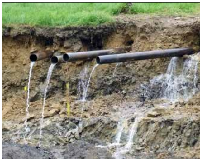
Horizontální odvodňovací vrti po odvrtání
