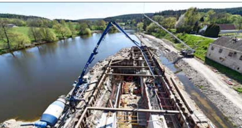
Betonáž plavební komory v horní vodě v zajištěné jámě
