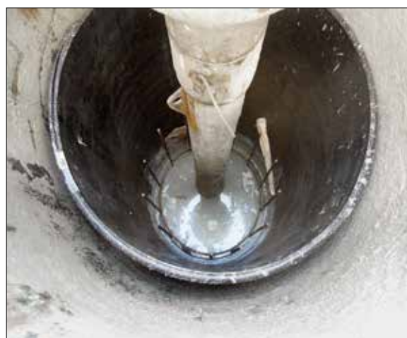
Detail piloty v průběhu betonáže
