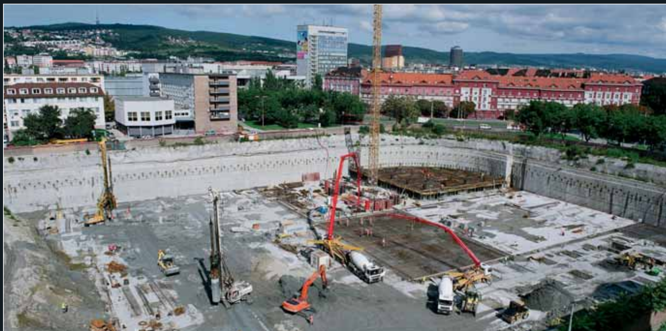
V rozsáhlé stavební jámě probíhá současně několik činností: provádění pilot, betonáž základové desky, budování nejnižší úrovně podzemních garáží
