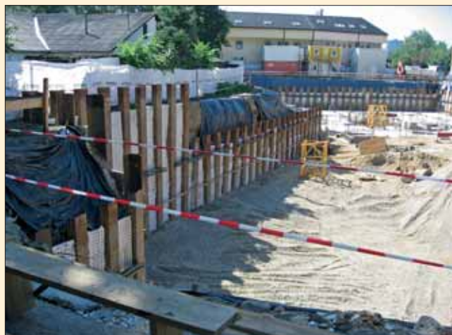
Pohled na jižní část stavební jámy
