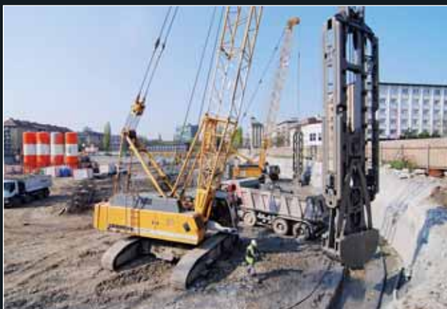
Těžba rýhy pro podzemní stěny drapáky Stein na nosičích Liebherr
