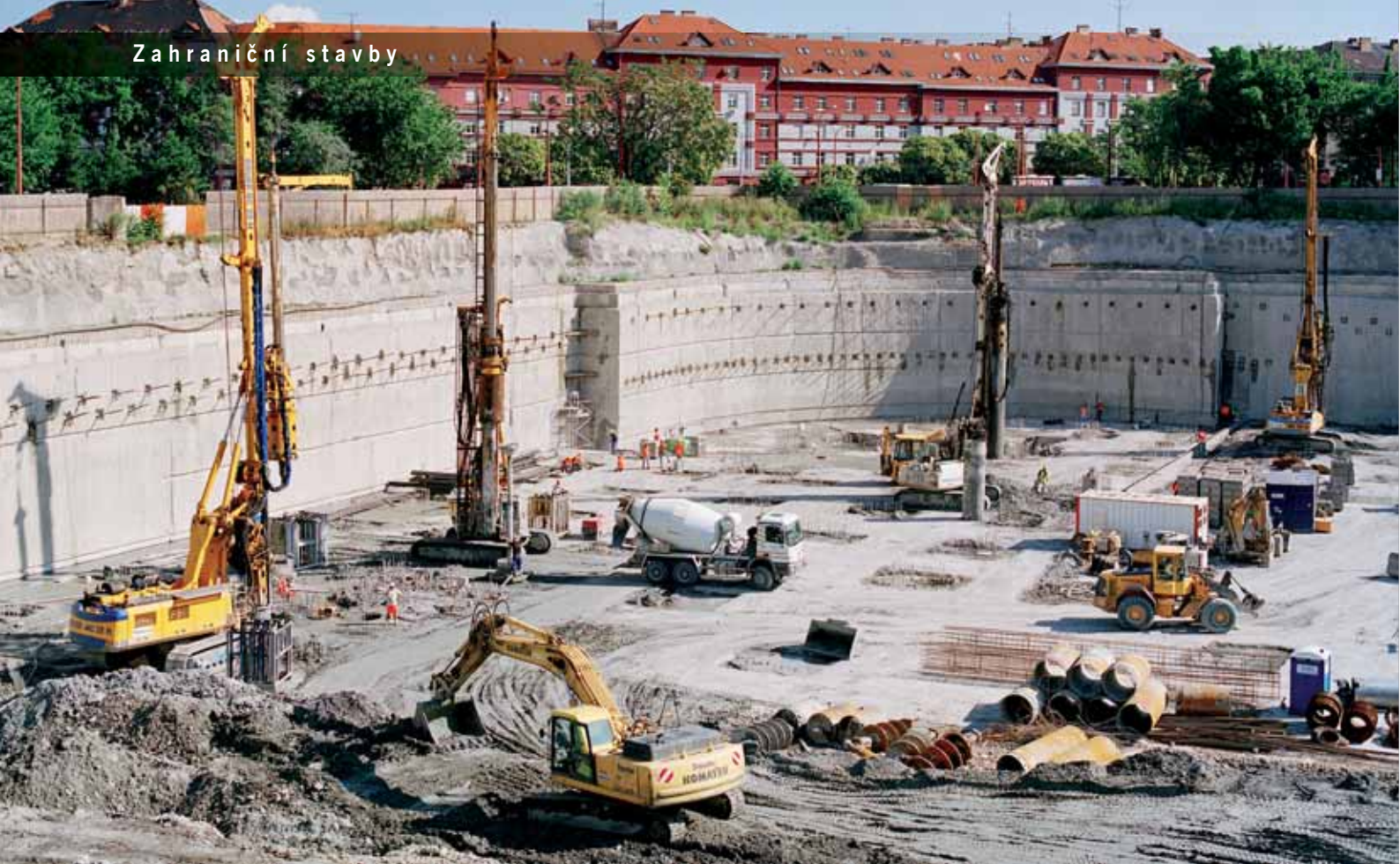
Provádění vrtaných pilot ze dna stavební jámy pažené konstrukčními podzemními stěnami
