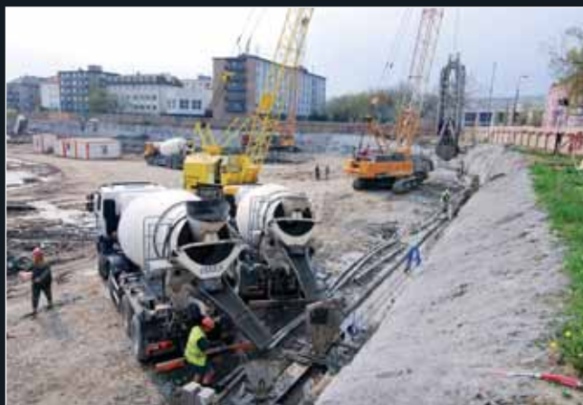
Betonáž lamely podzemní stěny přes dvě kolony systémových rour
