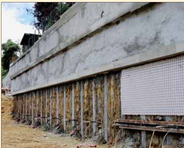
Kombinovaná pilotová a záporová stěna na východní straně stavební jámy
