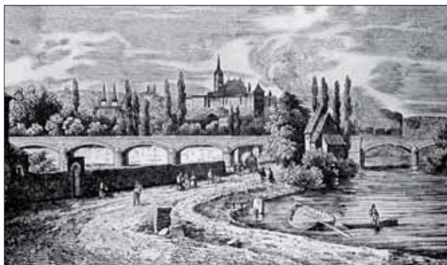
Část Negrelliho viaduktu, jak ji tehdejší kreslíř viděl z karlínského nábreží zhruba v místech pozdějšího nádraží Severozápadní dráhy na Tešnově
