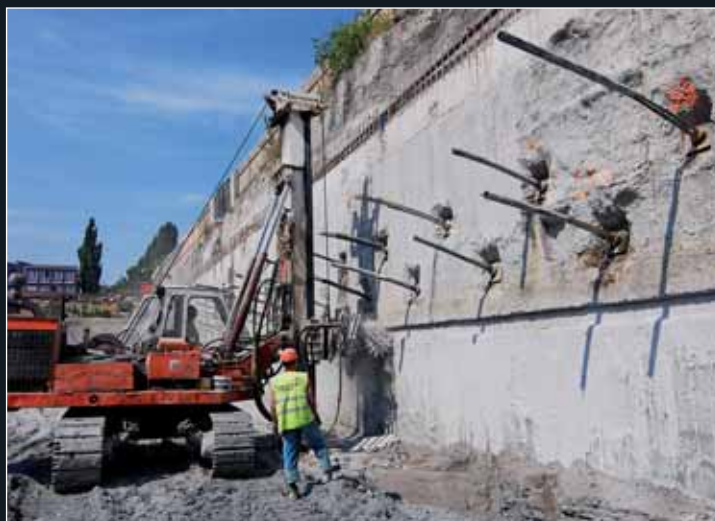
Frézování povrchu kotvených podzemních stěn
