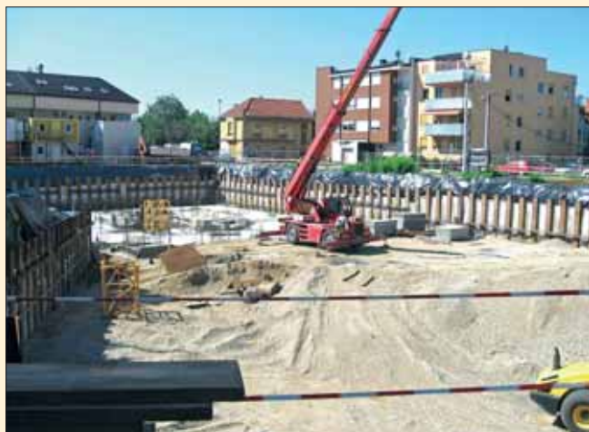
Celkový pohled na stavební jámu zajištěnou jednotlivě beraněnými štětovicemi
