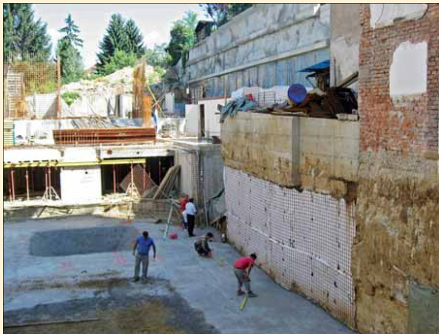
Východní strana stavební jámy zajištěná kombinovanou pilotovou a záporovou stěnou
