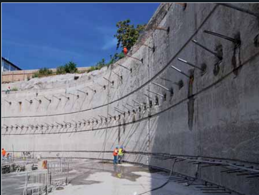
Osazování kotevní výztuže do drážek podzemních stěn v místě napojení základové desky
