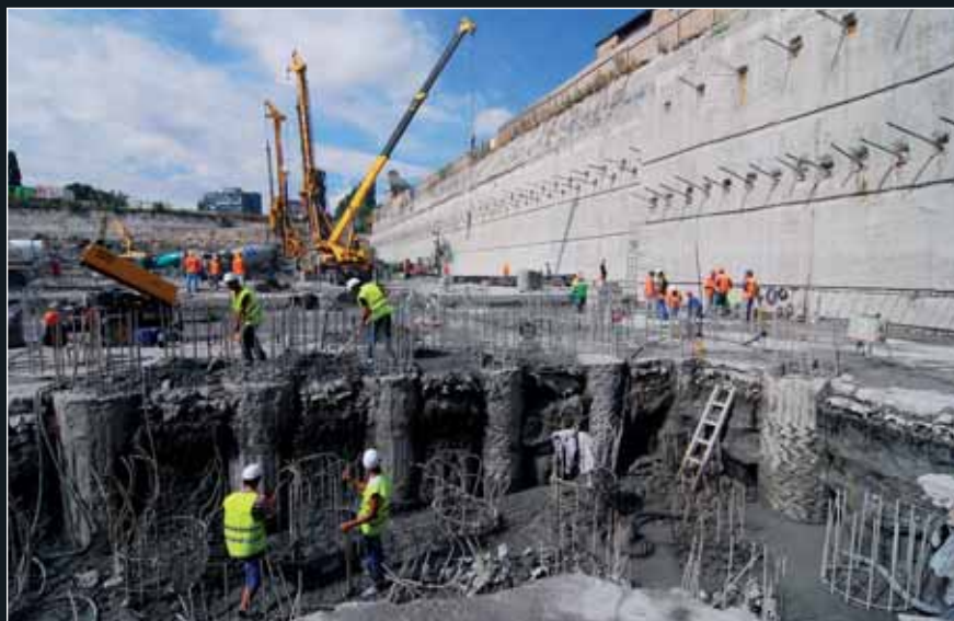
Čištění hlav pilot pod budoucím výškovým objektem (SO 03)
