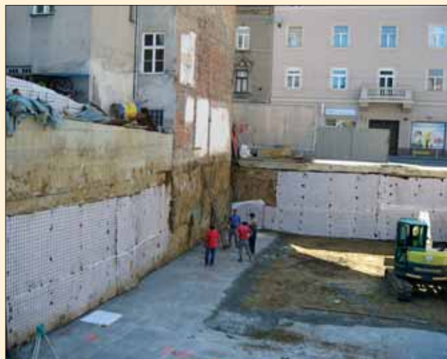
Zajištění jižní strany stavební jámy podél ulice Ilica pomocí nekotvené záporové stěny z vrtných zápor
