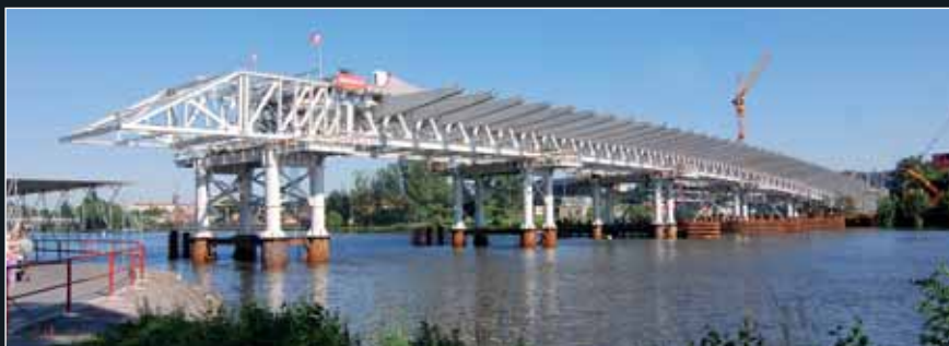
Vysouvaná konstrukce před trojským břehem
