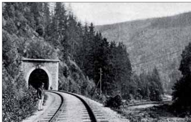
Tunelový portál na právě dokončené trati Sokolov–Kraslice, kterou stavěla v letech 1875–1876 firma Schön-Wessely.
