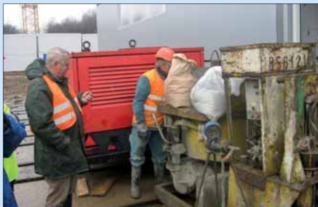
Obr. 1: Míchání komponenty A na stavbě metra V.A, Praha-Vypich
