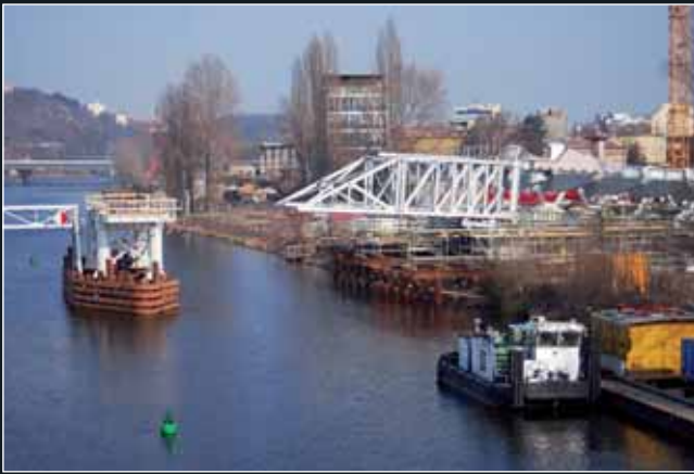
Zahájení výsunu nosné konstrukce z holešovického břehu
