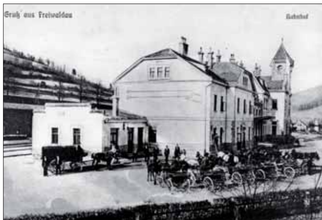
Že se nádražní budovy v 19. století nestavěly jen podle univerzálních „normálí“, dokazuje nádraží v Jeseníku na trati z Hanušovic do pruského Ziegenhalsu (dnes Glucholazy), budované firmou Schön a Wessely.
