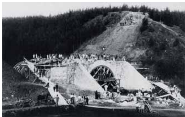
Jak náročné bylo bez jakékoliv techniky budování tratě Modřany–Dobříš firmou Životský-Hrabě, ukazuje snímek zestavěného klenutého nadjezdu v náspu dráhy u Voznice.
