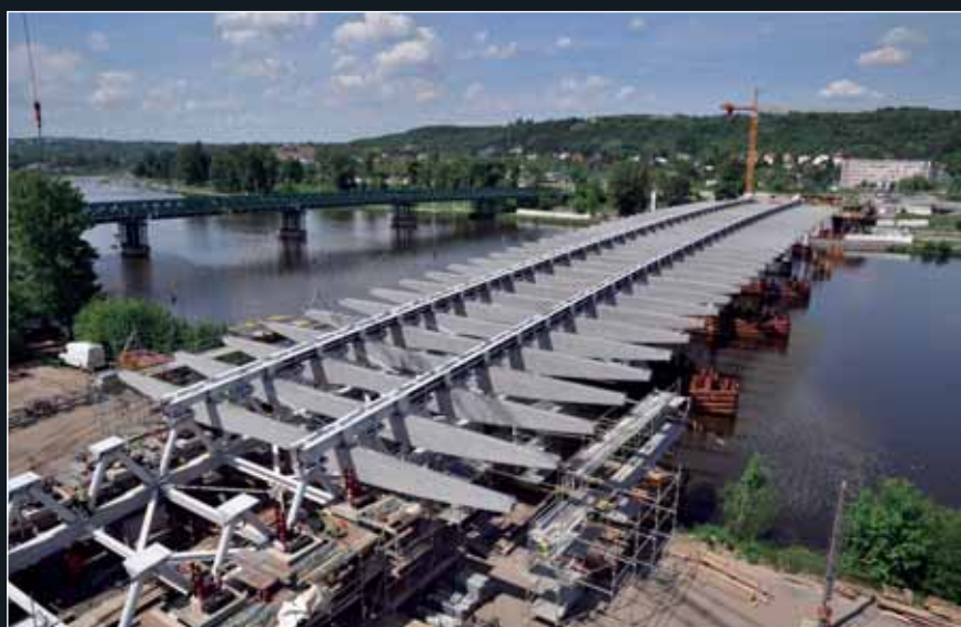
Pohled na vysouvanou konstrukci mostu
