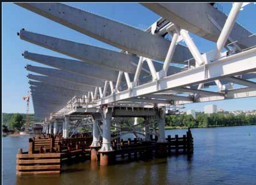
Pomocná ocelová konstrukce vysunutá přes soustavu podpěr v řečišti
