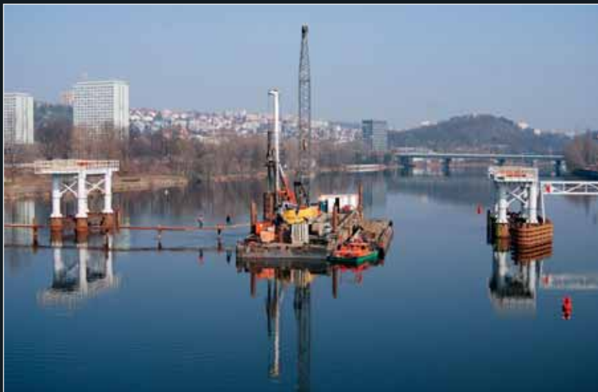
Hloubení vrtů pro piloty podpěry PO4 z lodi Jantar
