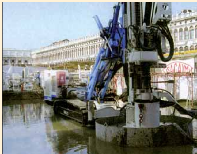
Vrtání pilířů technologií WSM
