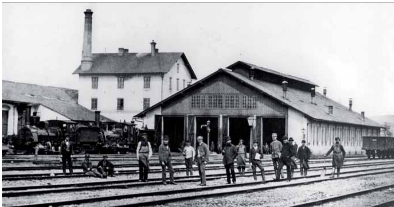
Vybudovat bylo třeba i zázemí pro uložení a údržbu lokomotiv a vozů. Na snímku je výtopna v Krnově těsně po otevření dráhy do Olomouce.
