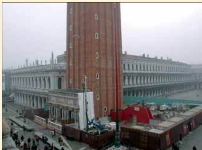
Práce probíhaly na minimálním prostoru
