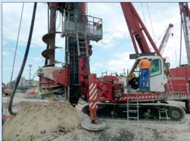
Vrtná souprava Starsol při dokončování vrtu metodou CFA
