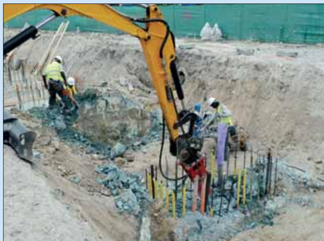
Odbourávání přebetonovaných hlav jednozáběrových lamel podzemních stěn
