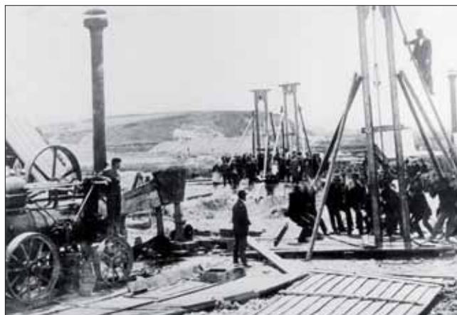
Dráhu ze Strakonice do Březnice a Rožmitálu stavěla v roce 1898 firma Životský-Hrabě. Při stavbě mostu přes Otavu u Strakonice se takhle namáhavě ručně za strojního čerpání vody zřizovaly základové jámyky. (foto F. Brož)
