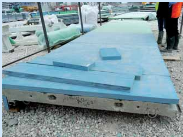
Železobetonový prefabrikát s izolační pěnovou pryží
