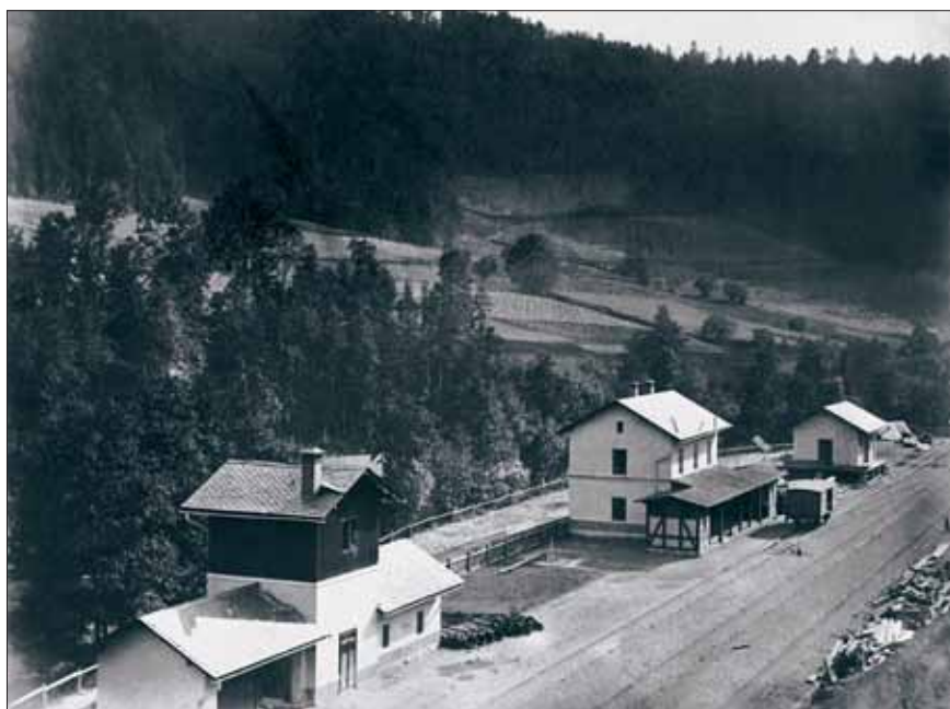
Ke každé dráze patří i řada potřebných pozemních staveb, především staničních budov, skladů, vodáren, staveb a strážních domků. Nádraží v Hrubé Vodě těsně před otevřením dráhy Olomouc–Krnov roku 1875 je toho důkazem.
