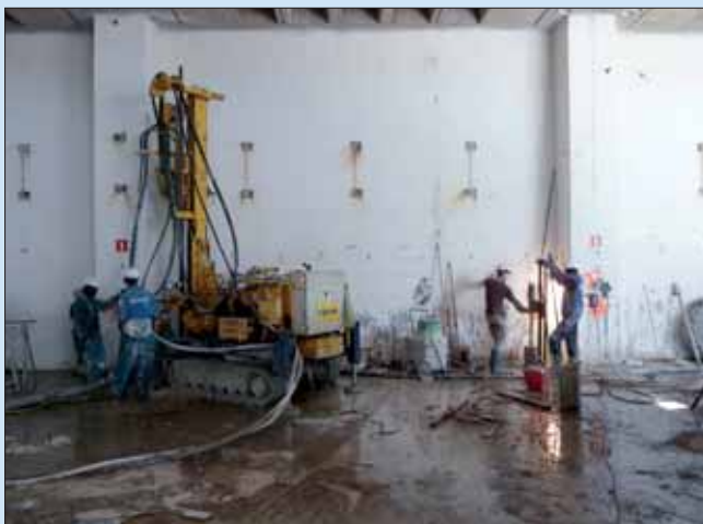
Vpravo vrtání jádrového vrtu, vlevo provádění sloupu tryskové injektáže
