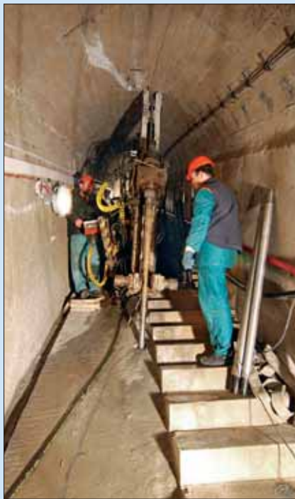
VD Žlutice, provádění injekčních prací vrtnou soupravou MSV 741/20
