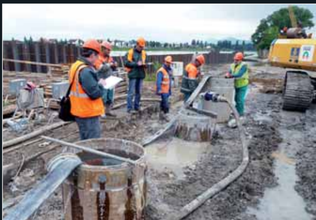
Testování účinnosti odlehčovacích vrtů pro piloty v artéské zvodni (čerpací zkouška)
