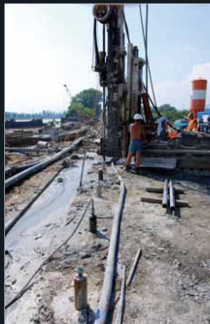
Hloubení vrtu pro horninovou injektáž za rubem vodicích zídčů pro podzemní stěny
