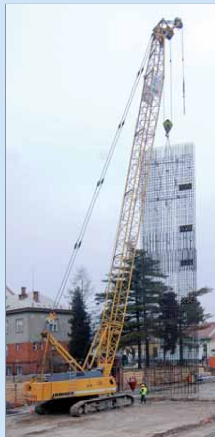
Obr. 1b: Čelní pohled na armokoš před jeho osazením
