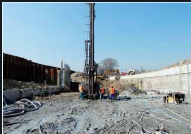
Provádění injektážních prací
