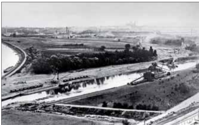
Stavba zdymadla v Praze-Troji znamenala rozsáhlé úpravy řeky nad i pod jezem a vybudování plavebního kanálu s komorami. Na obrázku je dolní část stavby v srpnu 1900.
