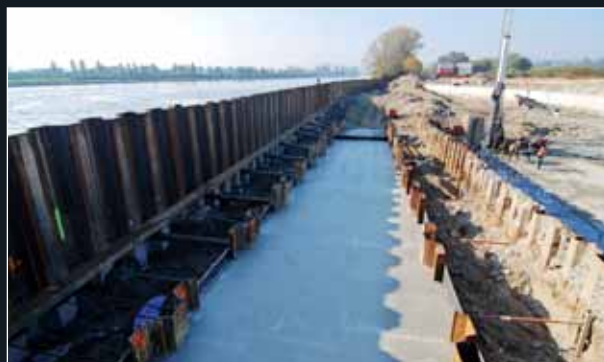
Štětová stěna podél budoucího objektu MVE s budovaným rybochodem
