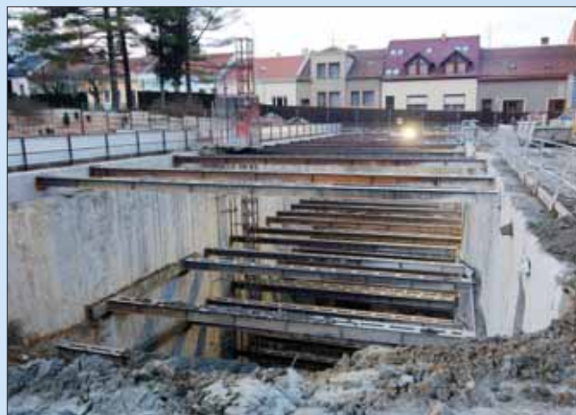
Stavební jáma technologického centra Královopolských tunelů v Brně hluboká až 29,9 m pažená podzemními stěnami
