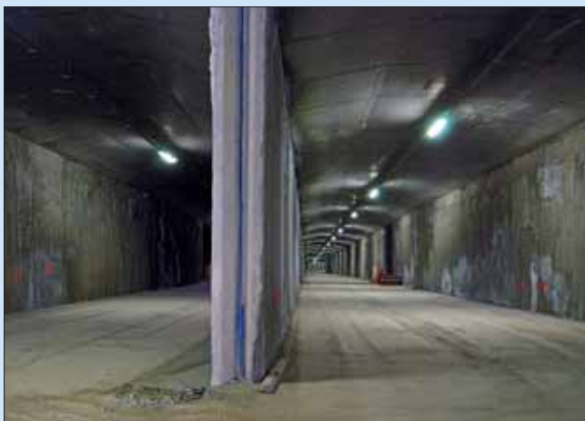
Tubusy tunelu Blanka zhotovené technologií podzemních stěn tzv. systémem „cut-and-cover“
