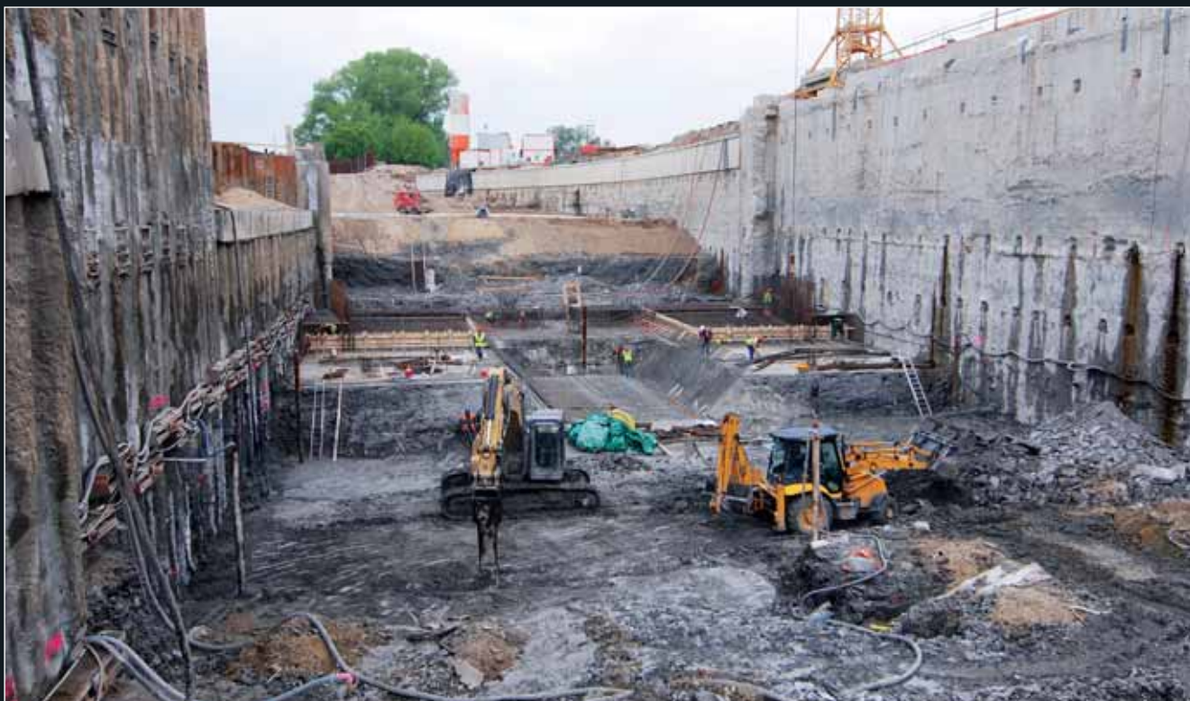
Dokladem účinnosti provedené injektáže pode dnem stavební jámy byla stabilní a suchá základová spára i v nejhlubším místě jámy na úrovni 130,5 m n. m.
