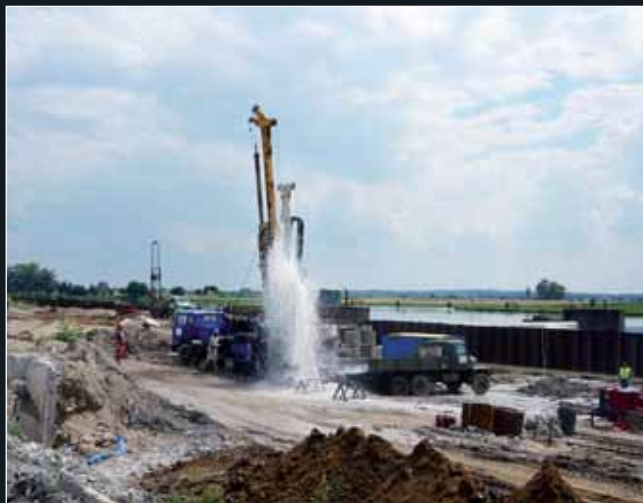
Vrtání pozorovacího hydrovrtu č. 8 v červenci 2010
