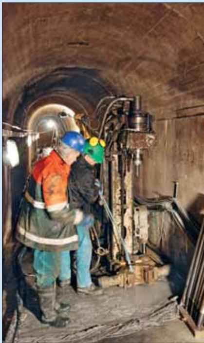
VD Žlutice, provádění VTZ sestupným způsobem před zahájením injektáže
