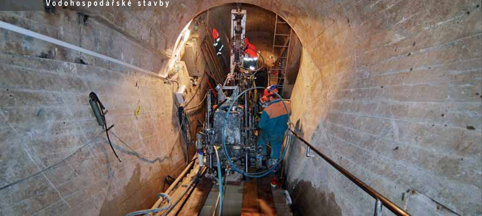
VD Křímov, vrtné práce byly prováděny z injekční štolý vrtnou soupravou MSV 741/20
