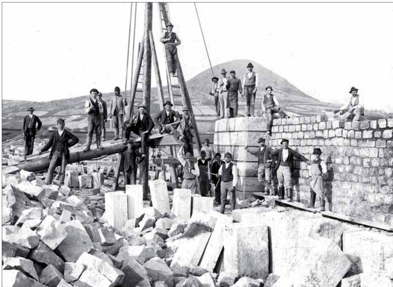
Na pozadí kopce Radobýlu sestavují z kamenných kvádrů dělníci firmy Schön a synové opěru viaduktu na trati z Lovosic do Teplíc, otevřené v roce 1898
