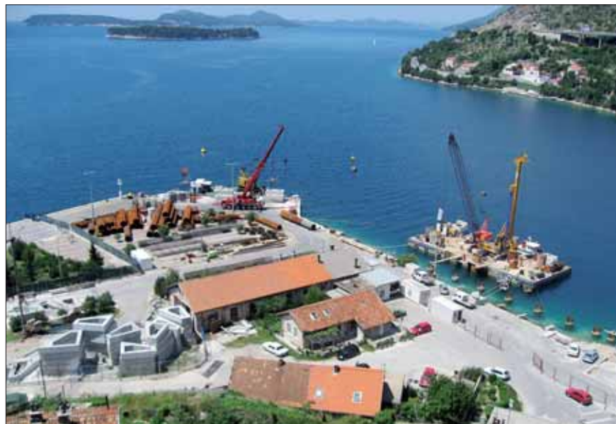
Pohled na staveniště od mostu Fr. Tuđmana
