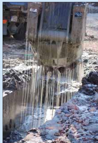
Těžba rýhy pro PS pod ochranou polymerové suspenze
