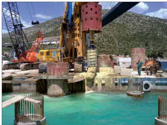
Vrtání dolomitu jádrovákem menšího průměru
