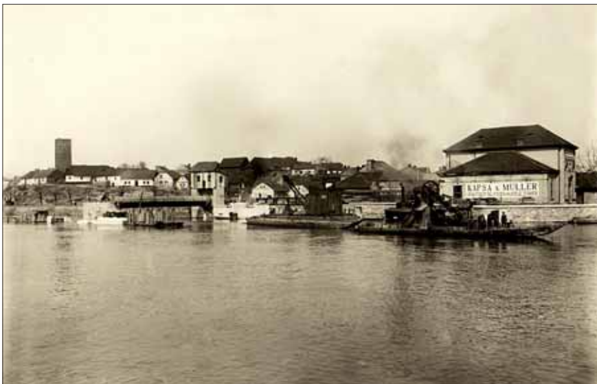
Stavba nového jezu v Kolíně asi na jaře 1915 firmou Kapsa & Müller
