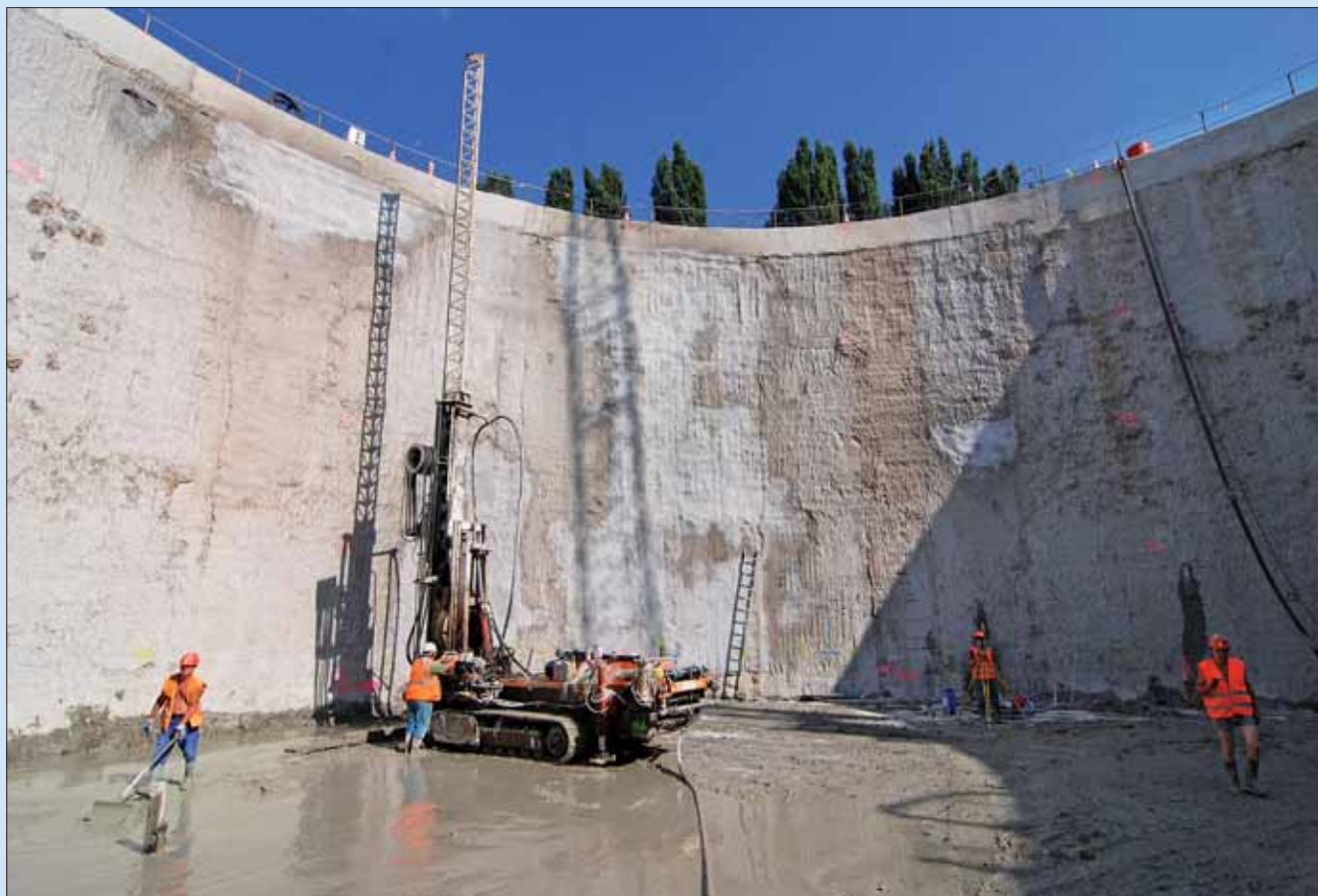
Provádění TI z pracovní úrovně 13,6 m pod horní hranou pažení
