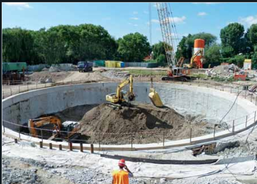
Symetrické hloubení výkopu pro retenční nádrž
