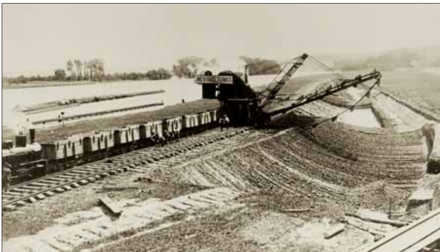
Vodní elektrárnu na vltavském jezu v Miřejovicích stavěla firma Faigl ze Zlonic až v první polovině 20. let s pomocí velké techniky používané na důlních skrývkách
