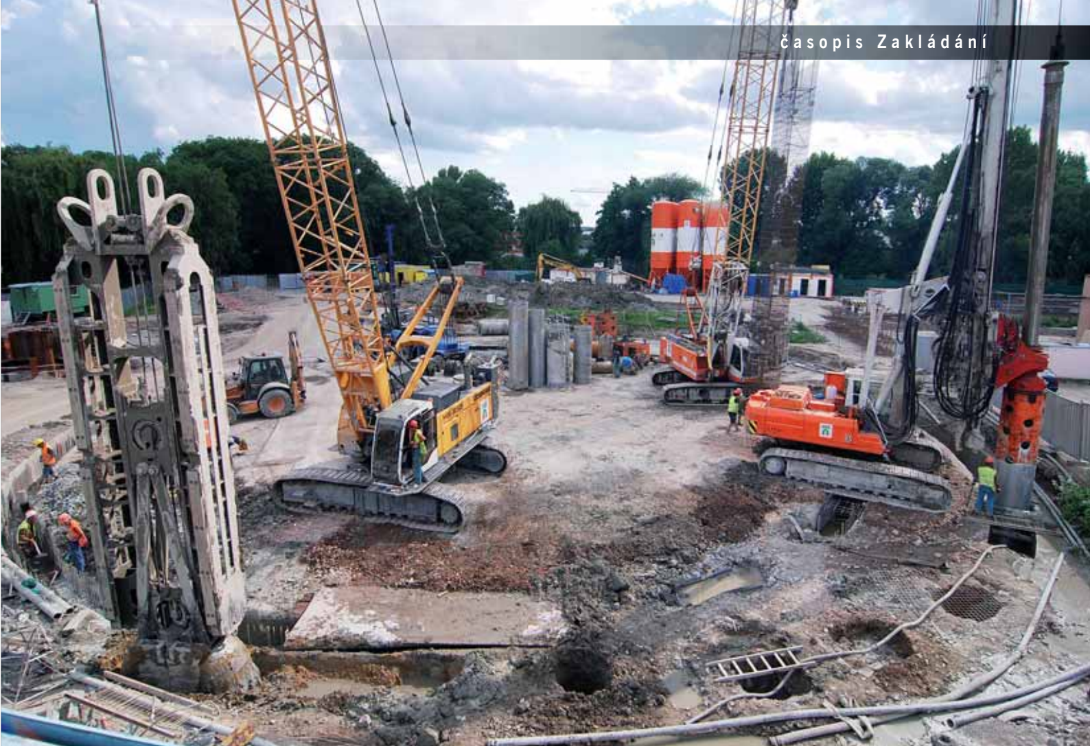
Nasazení kompletní mechanizace pro výrobu podzemních stěn
