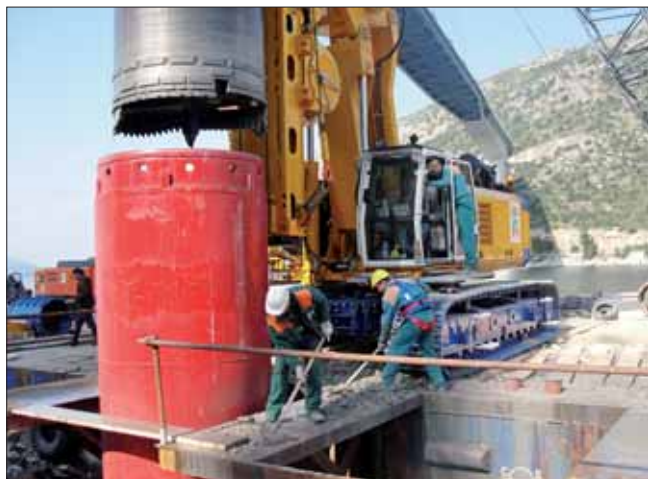
Vrtání skalním hrcem 1800 mm v pažnici 2000 mm
