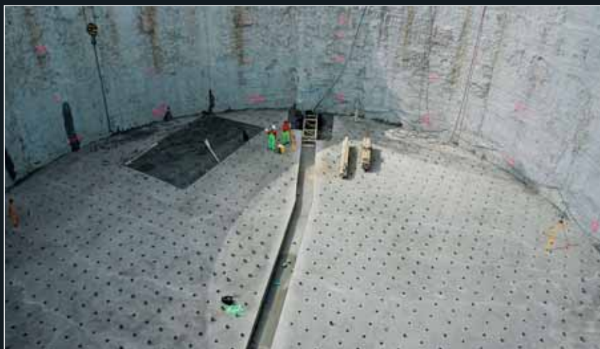
Pracovní plocha pro tryskovou injektáž s průchodkami a jímacím žlabem
