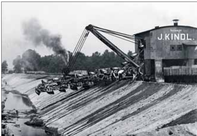
Bagrování průkopu Labe v Obříství firmou Kindl v srpnu 1908
