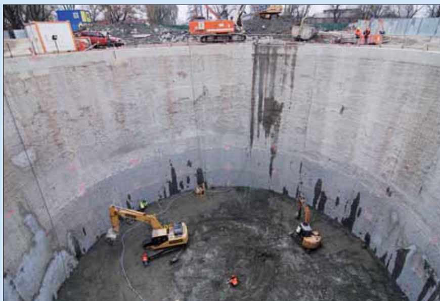
Stavební jáma je dotěžena na základovou spáru v úrovni 177,27 m n. m., tedy 20,83 m pod horní hranu pažení.
