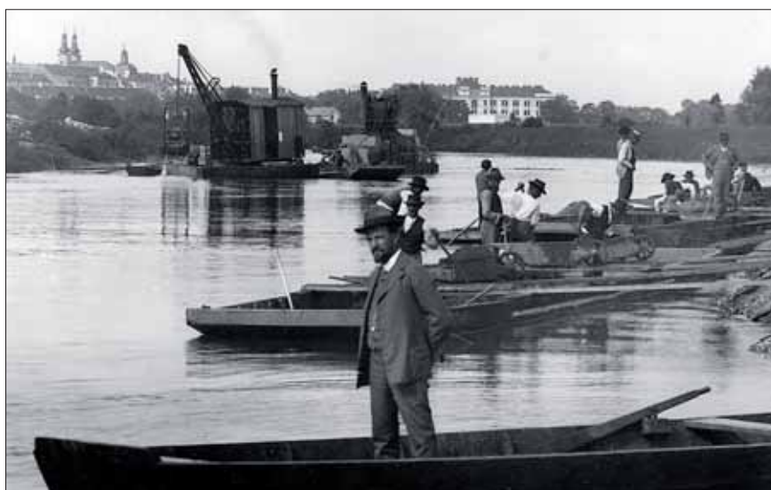
Vodní stroje firmy Kress & Bernard byly počátkem června 1908 v Hradci Králové v plné práci, stejně jako dělníci, vyvážející materiál v kolečkách na břeh
