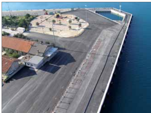
Nové molo po dokončení
