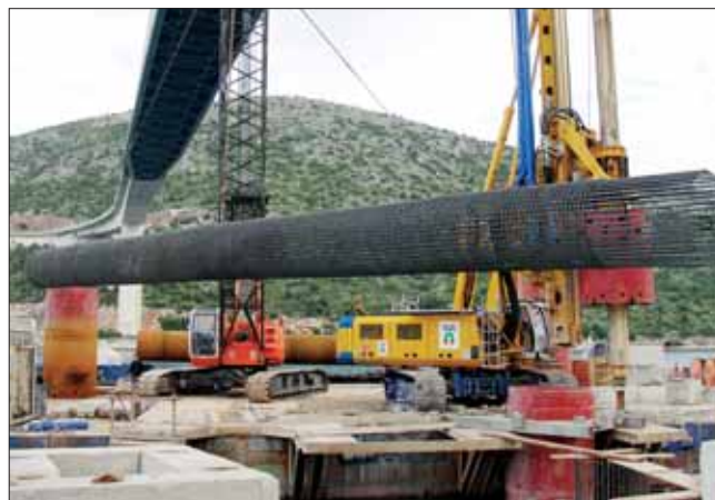
Přemisťování armokoše k ústí vrtu
