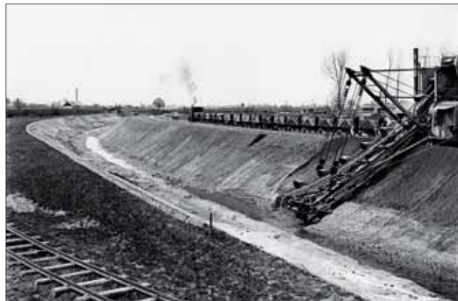
Tak vznikalo v květnu 1911 nové řečiště Labe u Lohenic, bagrované rypadlem firmy Kruliš
