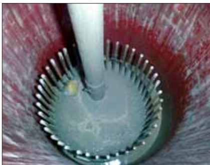
Betonáž piloty sypákovými rourami
