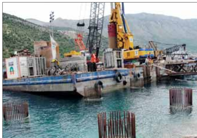
Výrazný náklon pontonu při některých pracovních operacích
