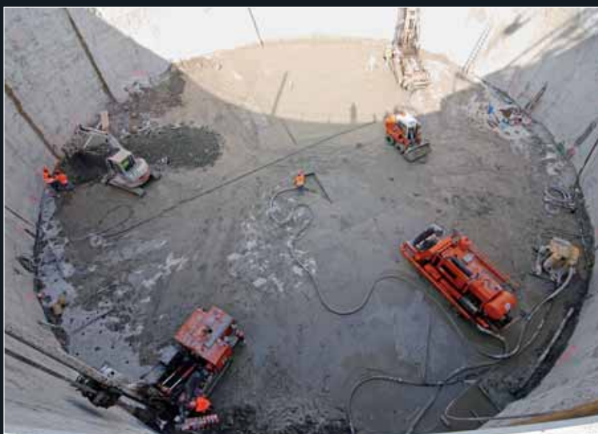
Pohled do stavební jámy v průběhu provádění tryskové injektáže
