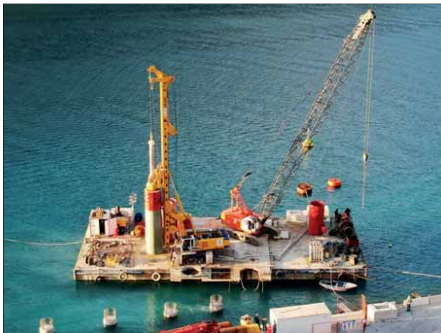
Ponton se strojní sestavou Bauer BG 36H a Kobelco EM700
