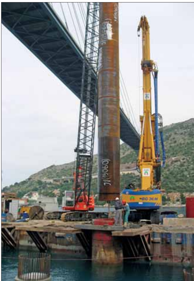
Osazování trvalé výpažnice prům. 1500 mm
