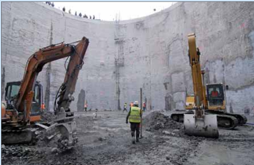
Dočištění dna retenční nádrže na horní úroveň sloupů T1 probíhalo s pomocí rotační frézy
