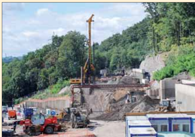
Hloubení vrtů pro osazení zápor jižní stěny pažení hloubeného úseku obrátových kolejí
