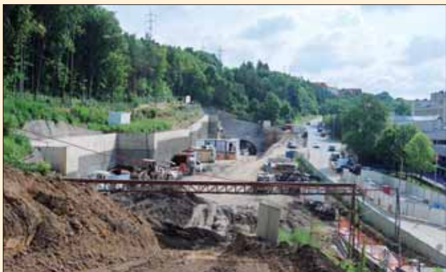
Celkový pohled na trvale kotvenou podzemní stěnu za budoucí stanicí Motol z prostoru navazujícího úseku hloubené části obrátových kolejí
