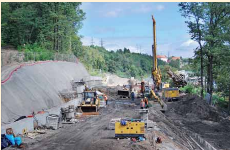
Komplikované staveniště hloubené části obratových kolejí
