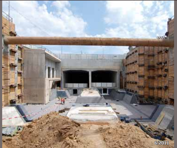
Portálová stavební jáma Prašný most (ražený tunel Prašný most–Myslbekova, stavba č. 9515), přechod z ražené části do otevřené stavební jámy pro technologické centrum a podzemní garáže. Dále navazuje již úsek tunelu hloubený metodou MMM, (Prašný most–Špejchar, stavba č. 0080)
