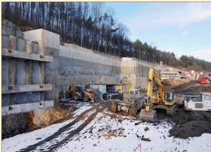
Hloubení vlastní stavební jámy Motol před severním svahem zajištěným podzemní stěnou
