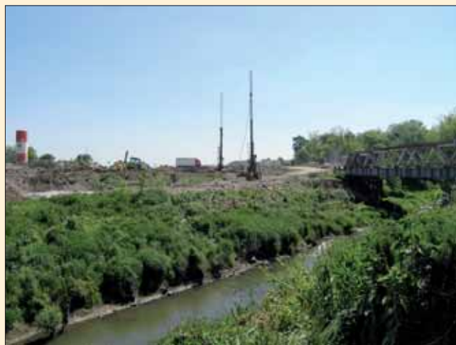
Provádění systémových sloupů tryskové injektáže při založení dálničního mostu WA-3
