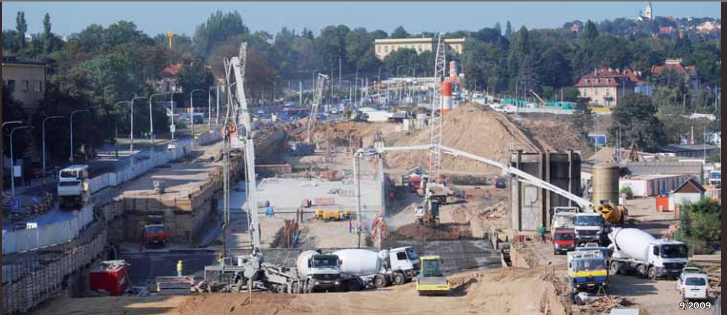
Ulice Milady Horákové (Prašný most–Špejchar, stavba č. 0080), pokračování hloubeného tunelu metodou MMM
