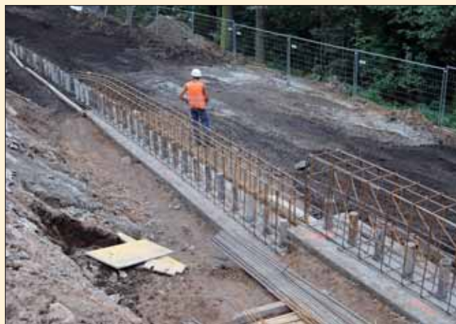
Příprava betonáže žlb. věnce v hlavách pažicích mikropilot
