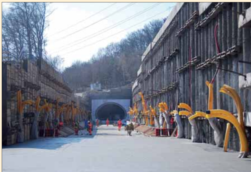
Pohled na pažení stěny hloubeného úseku obrátových kolejí s vertikálním a semihorizontálním systémem odvodnění prostoru za pažením
