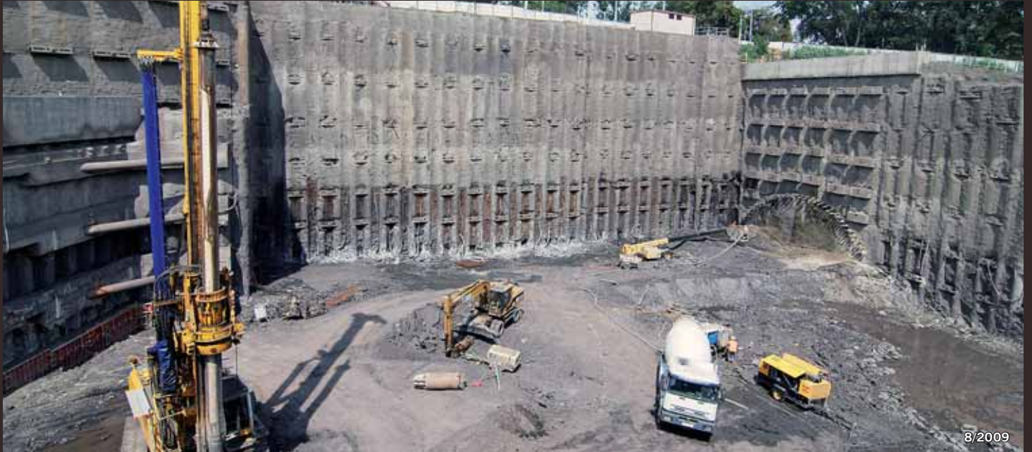
Portálová stavební jáma Myslbekova (ražený tunel Myslbekova–Prašný most, stavba č. 9515), betonáž kleneb severní a jižní tunelové trouby (SAT 2.B)
