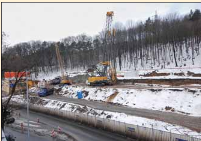
Těžba rýhy pro podzemní stěnu pomocí hydrofrézy v příkrém svahu nad ulicí Kukulovou
