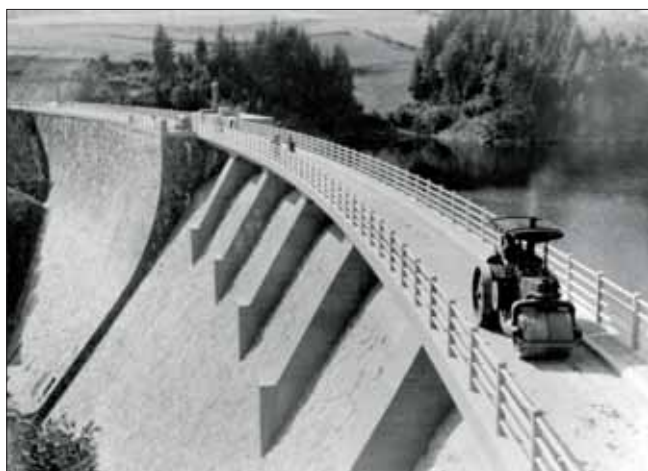
Betonová hráz přehrady Pastviny na Divoké Orlici, kterou stavěl ing. Pažout, při dokončování vozovky v roce 1938
