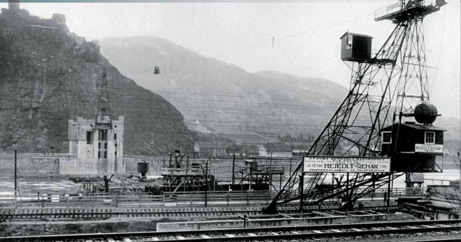
Stavba jezových polí pod Střekovem firmou Nejedlý, Řehák a spol. v roce 1931
