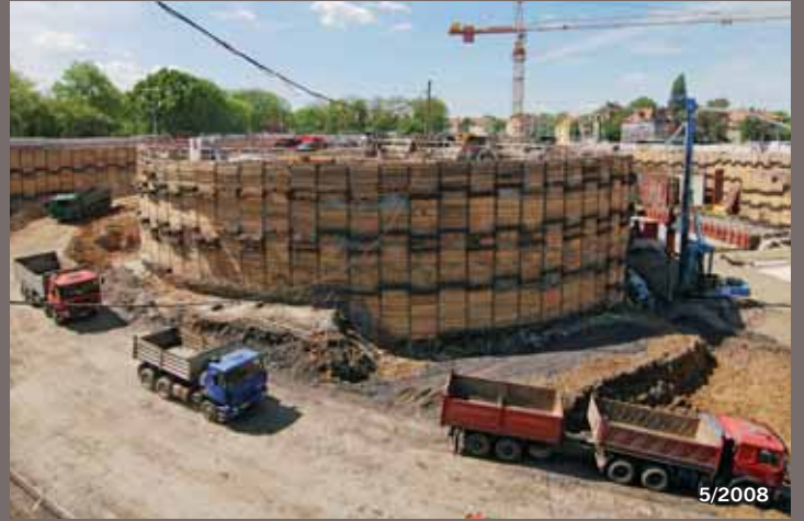
Portálová stavební jáma Letná (ražený tunel Letná–Troja, stavba č. 0079 Špejchar–Pelc-Tyrolka), stavební jáma slouží zároveň pro výstavbu podzemních garáží.
