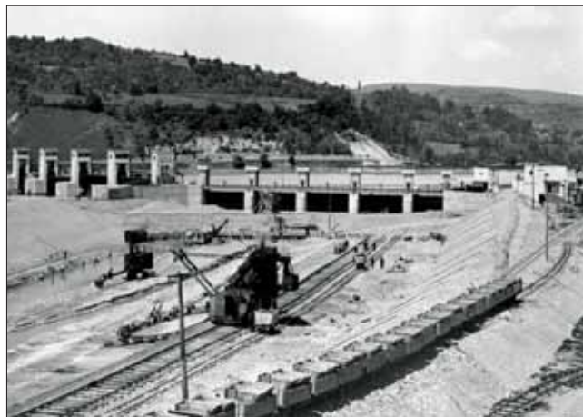
Jez v Dolních Kočkovcích na Váhu je hotov, pod ním v přírodním kanálu k elektrárně v roce 1935 trojice rypadel konsorcia Kruliš-Jáchymek-Redlichové bagrovala usazovací nádrž
