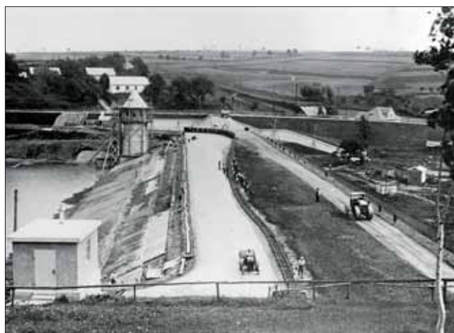
Dokončování sypané hráze ve Fryštáku v povodí Moravy, postavené v režii zemské správy
