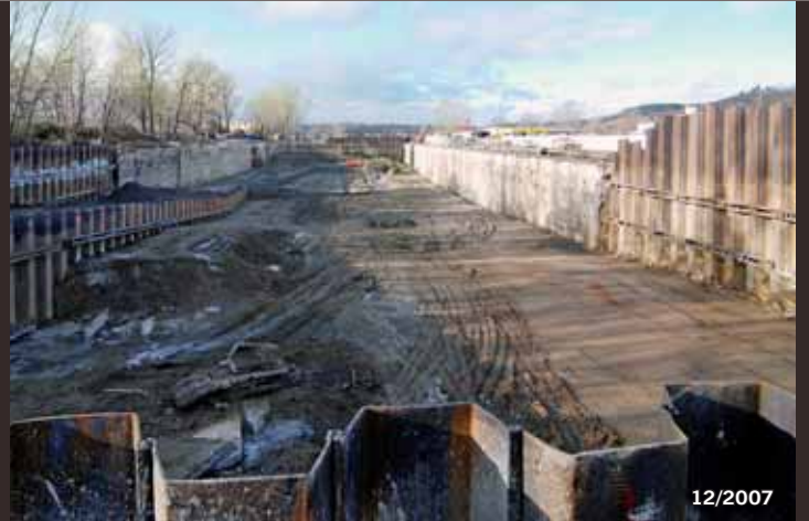
Portálová stavební jáma a navazující úsek hloubených tunelů Troja (ražený tunel Troja–Letná, stavba č. 0079 Špejchar–Pelc-Tyrolka)
