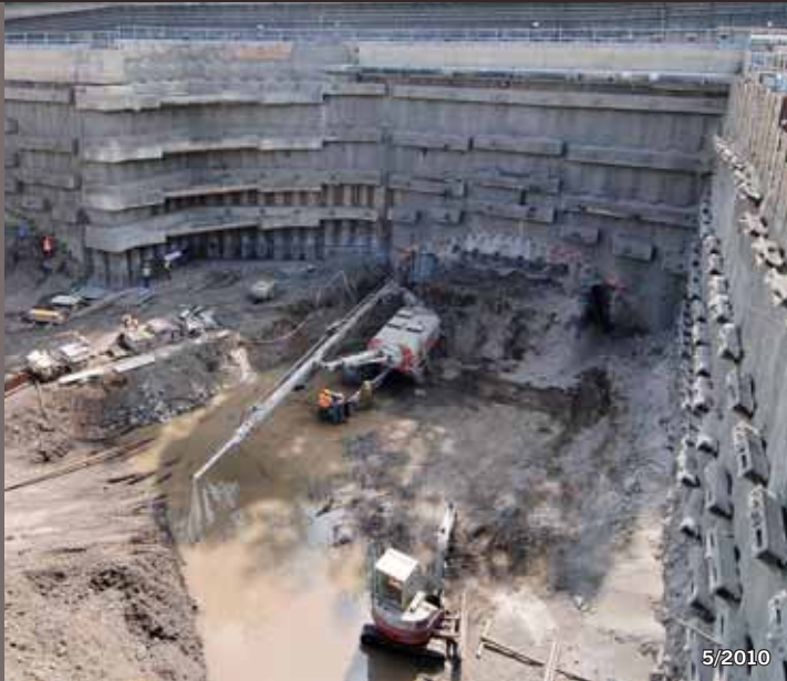
Portálová stavební jáma Prašný most (ražený tunel Prašný most–Myslbekova, stavba č. 9515), přechod z ražené části do otevřené stavební jámy pro technologické centrum a podzemní garáže. Dále navazuje již úsek tunelu hloubený metodou MMM, (Prašný most–Špejchar, stavba č. 0080)
