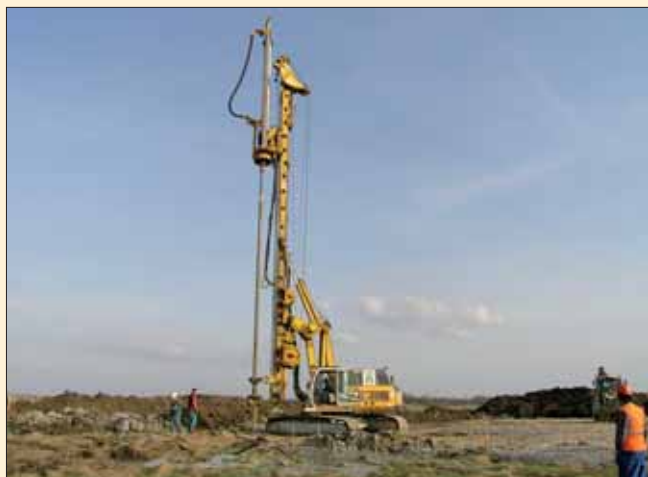
Provádění sloupů DSM vrtnou soupravou BG 18 pomocí prodlužovacího nástavce
