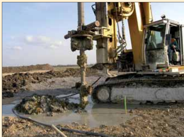
Míchací nástroj Delmag používaný při provádění jednoho ze sloupů DSM
