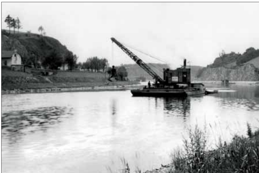
V červenci 1929 firma Secký napřimovala tok Labe u Týnce a při tom odstraňovala části pobřežních skal, jak je vidět v pozadí vpravo
