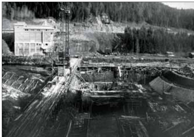
Staveniště základů budoucí betonové hráze přehrady Březová na Teplé u Karlových Varů. Přehradu stavěla firma Lanna v majetku podnikatelů Nejedlého a Řeháka.
