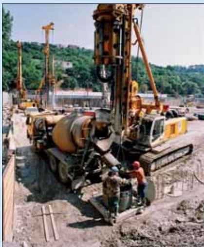
Betonáž velkopřůměrové vrtané piloty
