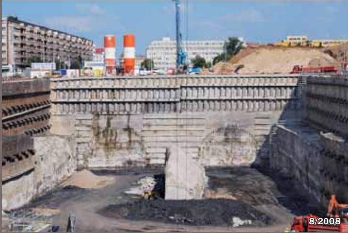
Portálová stavební jáma Letná (ražený tunel Letná–Troja, stavba č. 0079 Špejchar–Pelc-Tyrolka), stavební jáma slouží zároveň pro výstavbu podzemních garáží.
