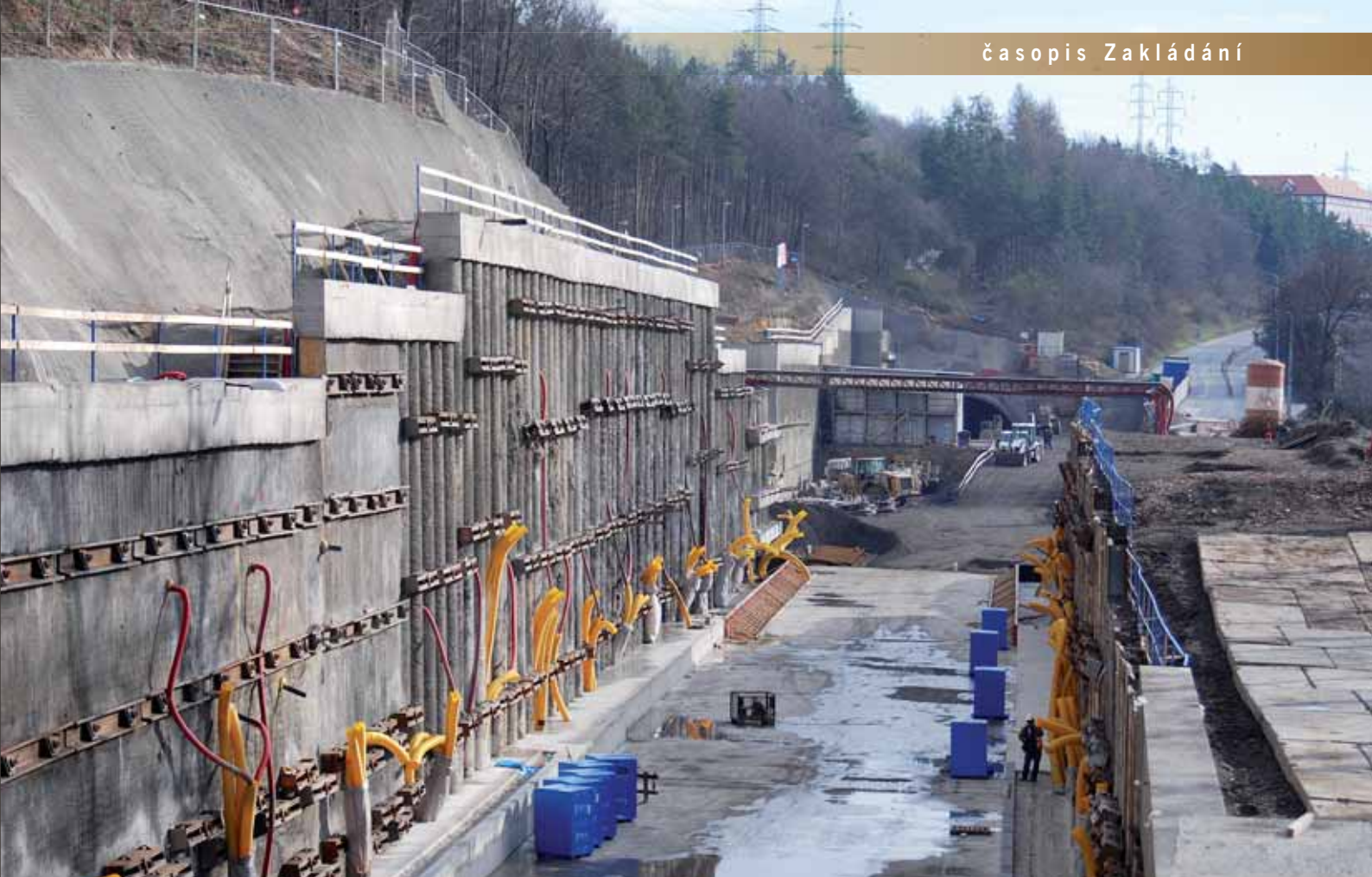
Zajištění stavební jámy hloubené části obrátových kolejí (SO 09-18/50), pohled na severní kotvenou pažící pilotovou a mikropilotovou stěnu
