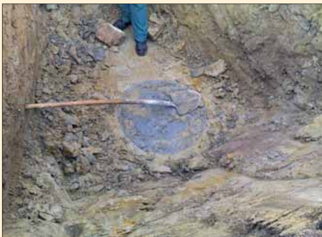
Obnažená hlava nesystémového sloupu DSM na zkušebním poli v Polsku
