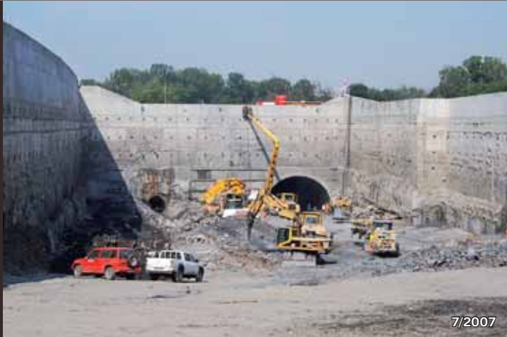
Portálová stavební jáma a navazující úsek hloubených tunelů Troja (ražený tunel Troja–Letná, stavba č. 0079 Špejchar–Pelc-Tyrolka)
