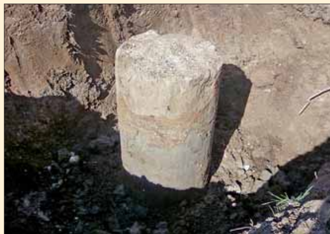
Obnažený systémový sloup DSM po odkopání, před odbouráním na projektovanou úroveň
