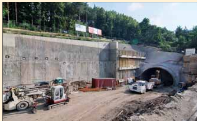
Detailní pohled na podzemní stěnu s portálem tunelu raženého metodou TBM-EPB směrem ke stanici Petřiny
