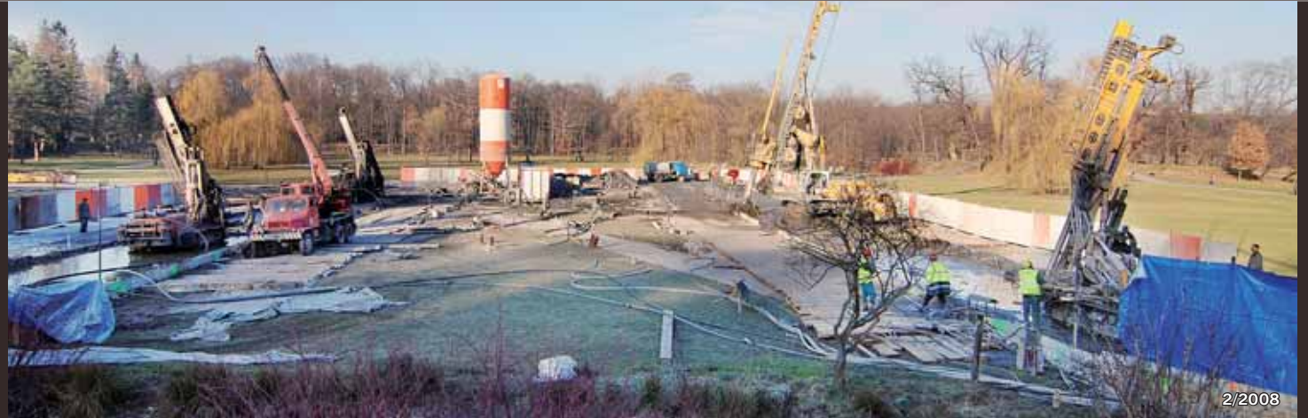
Královská obora (stavba č. 0079 Špejchar–Pelc-Tyrolka), realizace ochranné horninové desky v nadloží ražených tunelů pomocí klasické a tryskové injektáže
