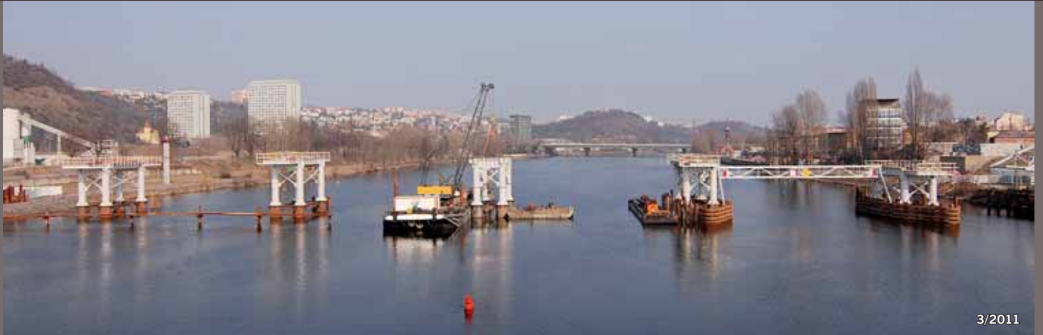
Nový Trojský most (stavba č. 0079 Špejchar–Pelc-Tyrolka), budování dočasných montážních podpor v řečišti
