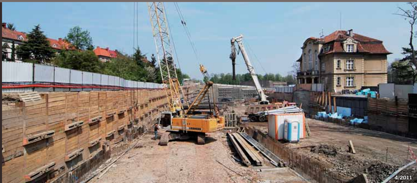
Patočkova ulice, hloubený tunel metodou MMM (modifikované milánské stěny), (SAT 2.B)
