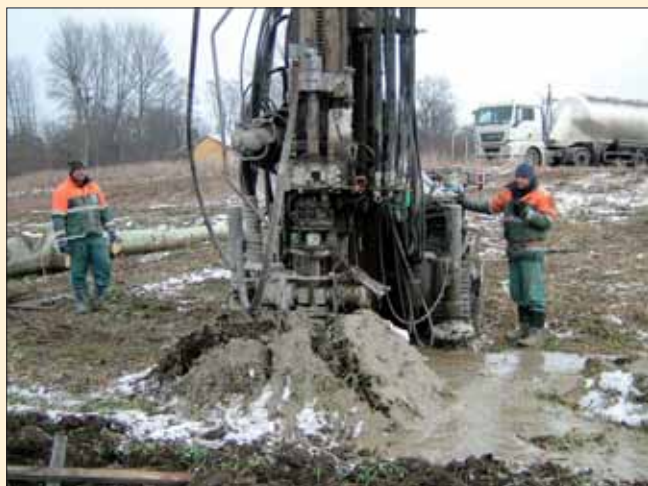
Provádění sloupů tryskové injektáže na zkušebním poli v blízkosti budoucího pilíře dálničního mostu
