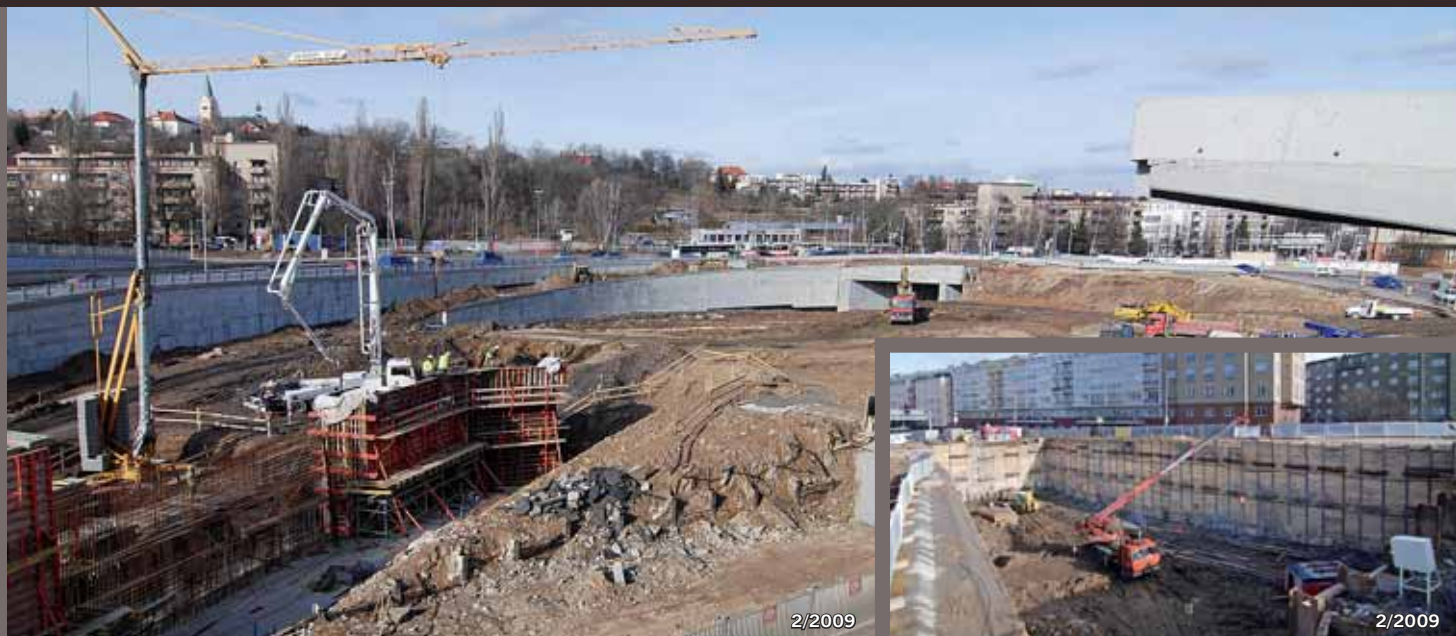
Mimoúrovňové křížení (MÚK) Malovanka (SAT 2.A), napojení Strahovského tunelu na „tunelový komplex Blanka“
