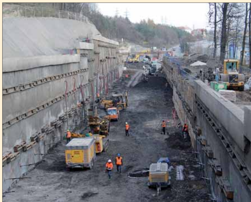
Dokončená stavební jáma obrátových kolejí zajištěná po obou stranách vícenásobně kotveným mikropilotovým pažením v místě vedení VN
